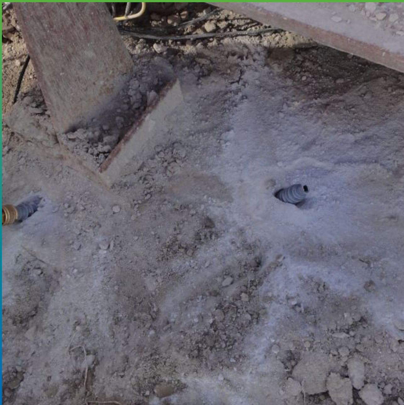
Процесс инъектирования Максгрут Инжешн в полость между металлической пластиной и железобетоном
