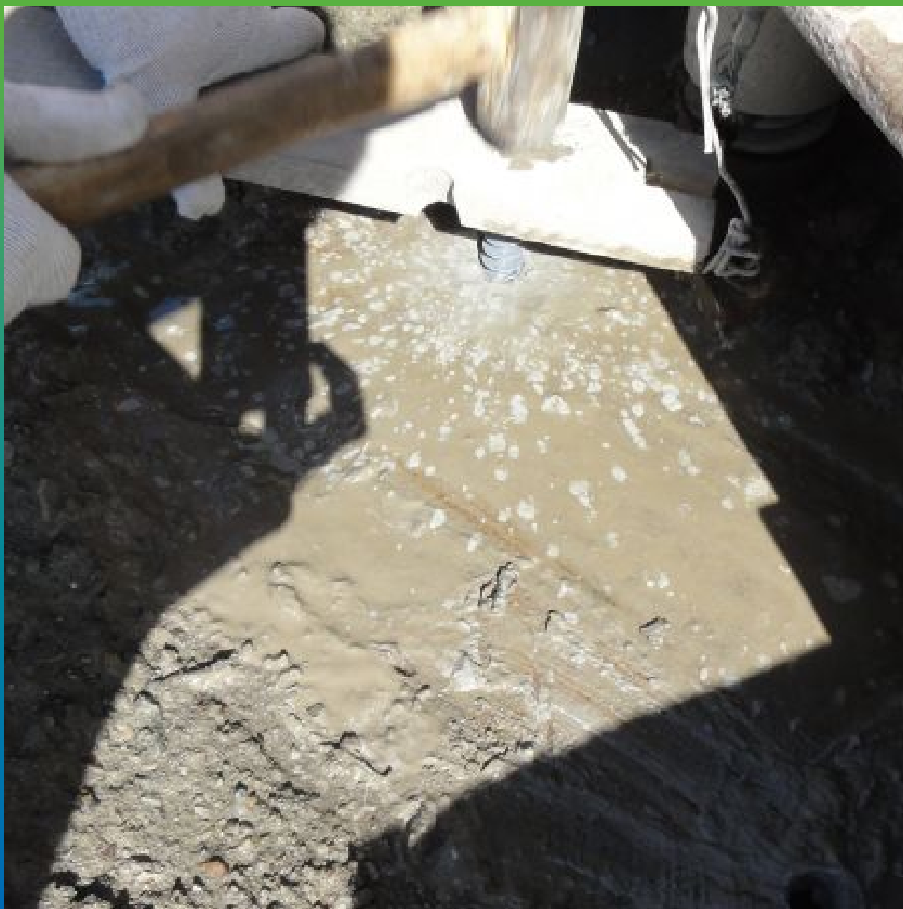
Установка пакеров БМ 2830
