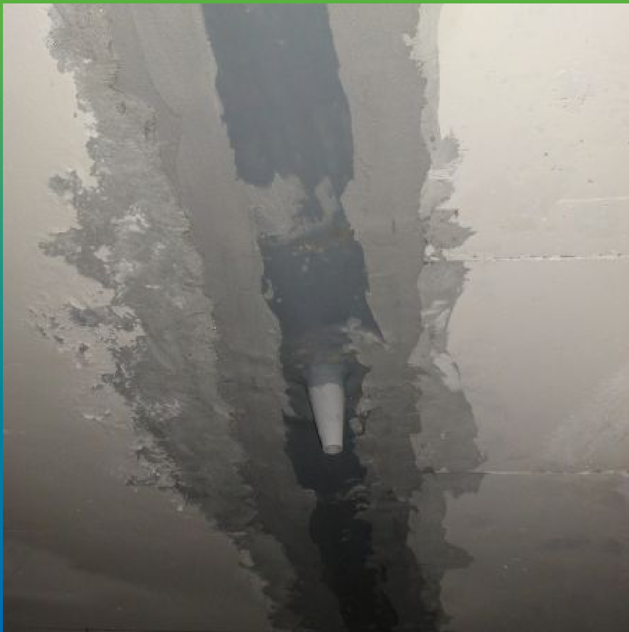
Устройство водосброса
