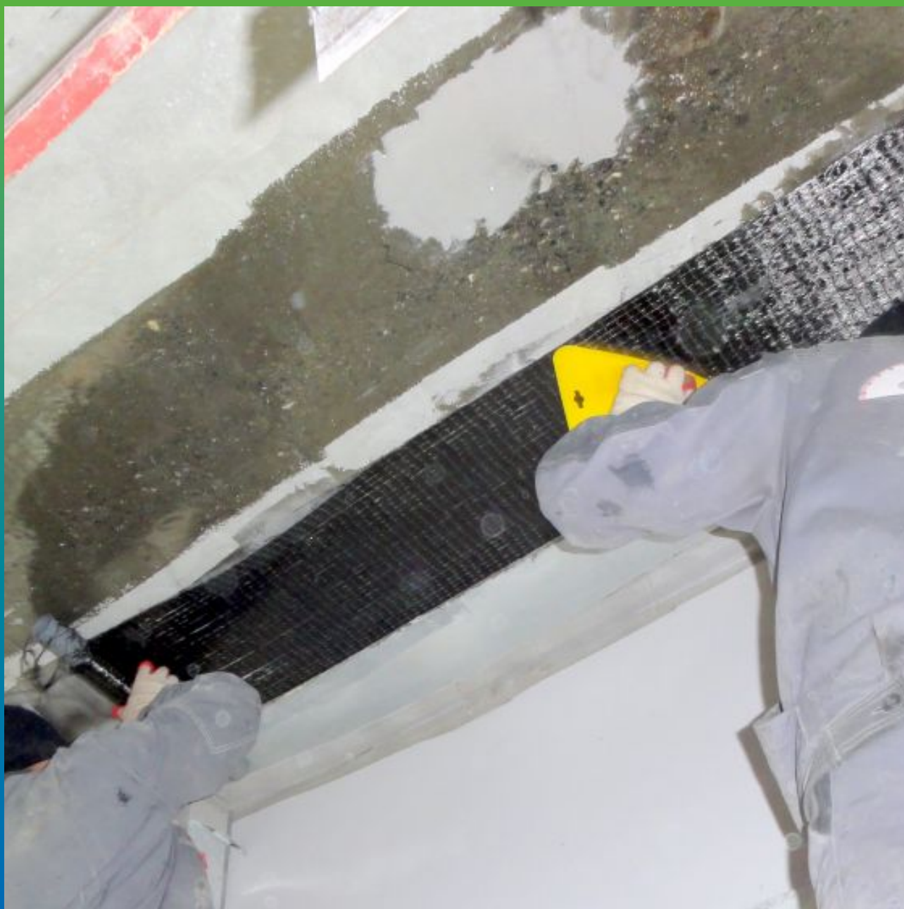
Монтаж углеродной ткани Армошел КВ 900 + удаление воздуха и разглаживание ткани.
