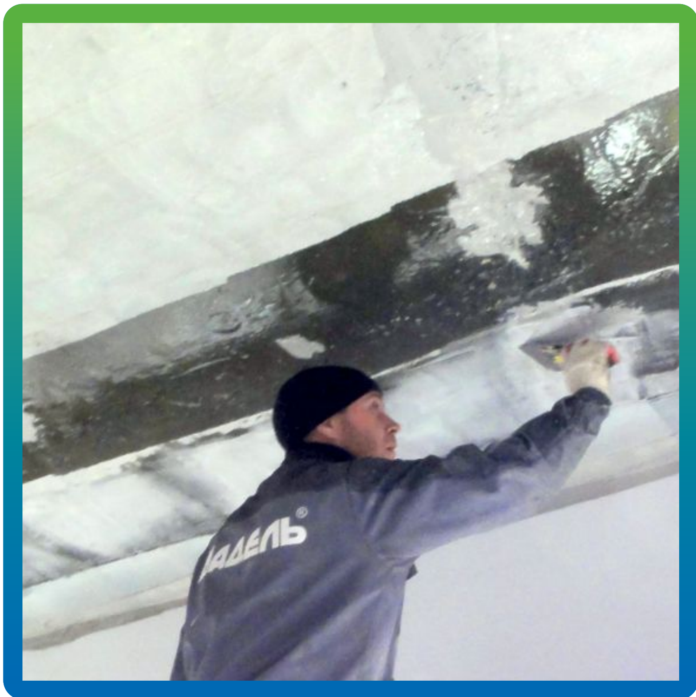
Нанесение загущенного клея Манопокс 372 + Манопокс Тикс.
