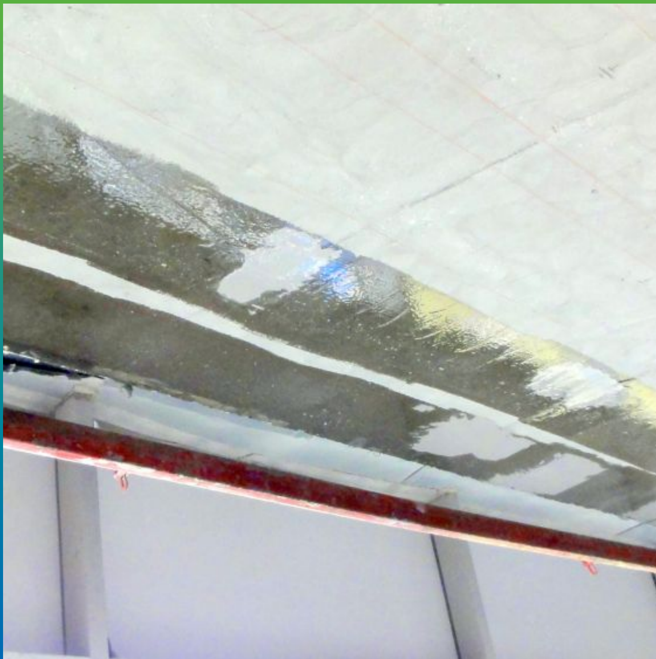
Пропитка основания грунтовочным слоем Манопокс 372.
