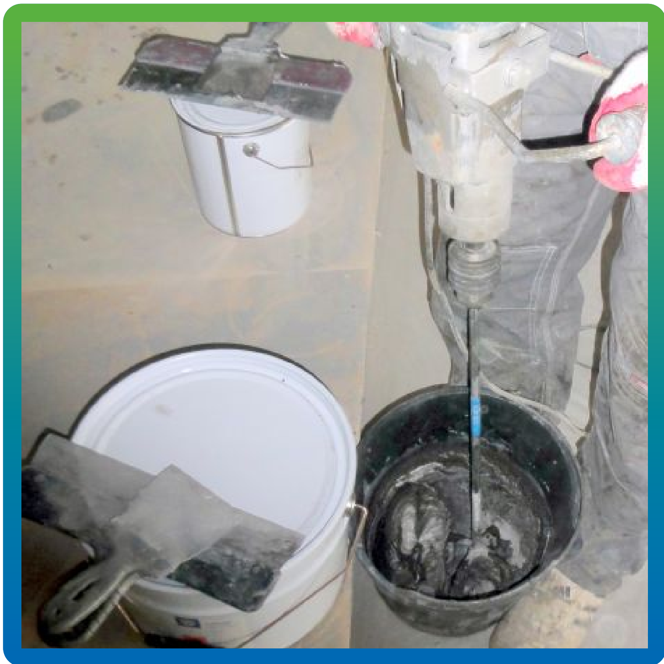
Замешивание 2К сверхскоростного ремонтного состава на эпоксидной основе Манопокс 331.
