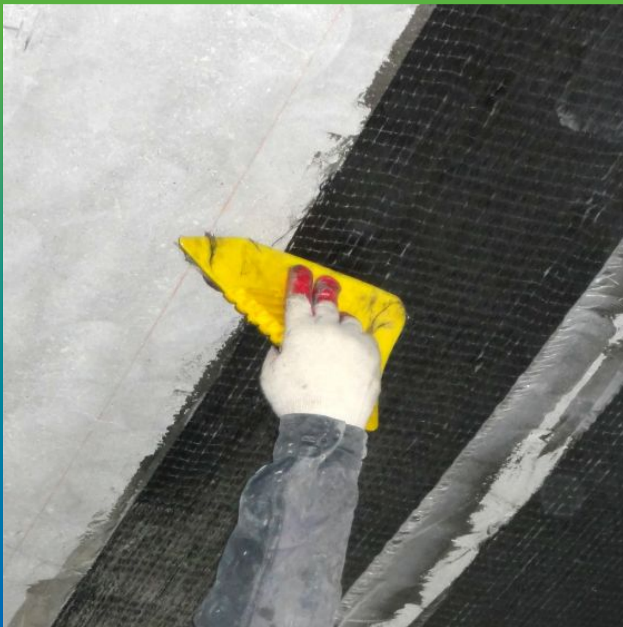
Детализация монтажа углеродного волокна + удаление воздуха и разглаживание.
