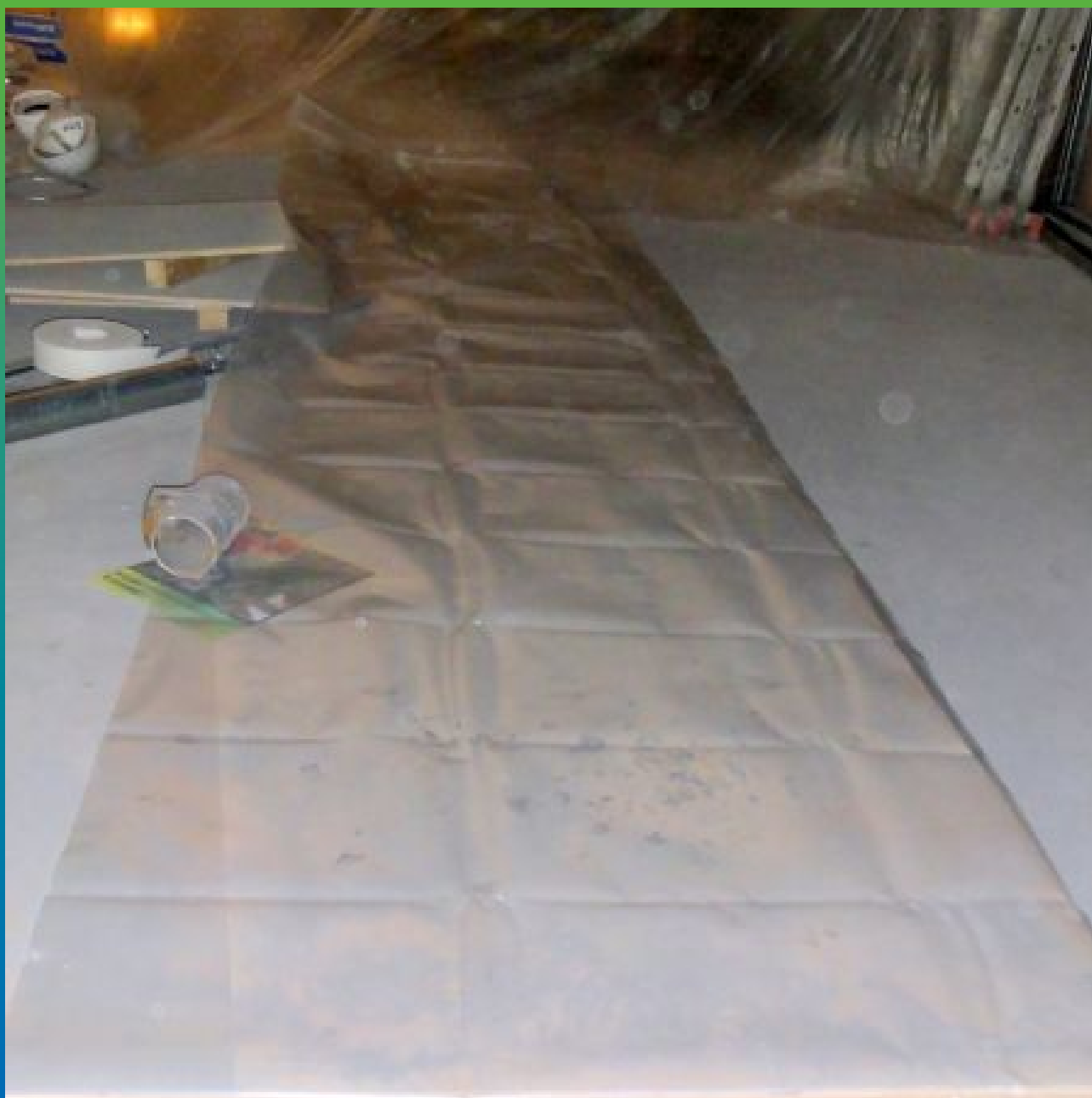
Подготовка рабочего стола для пропитки ткани.
