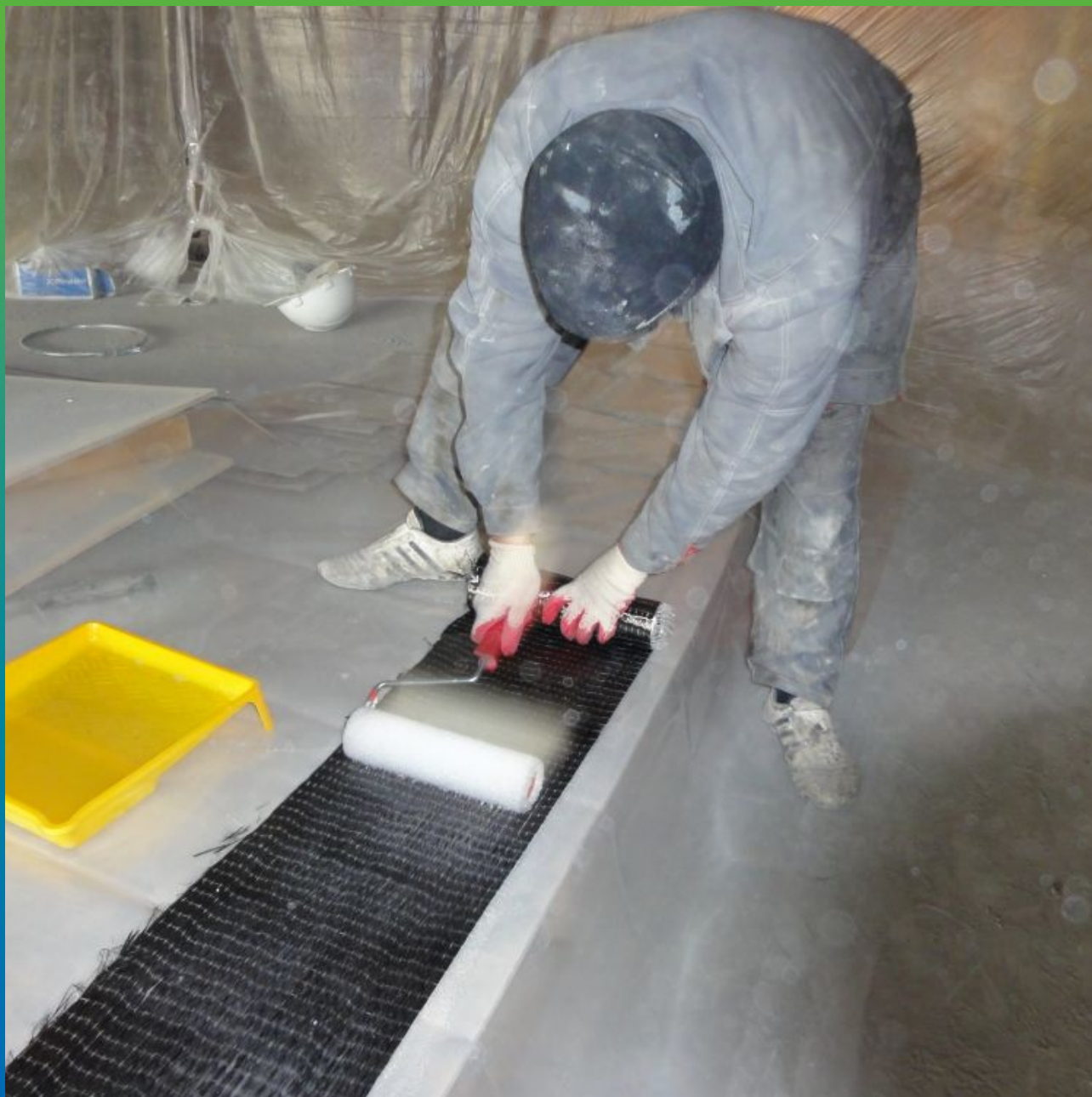
Пропитка ткани Армошел KB 900 клеем Манопокс 372.
