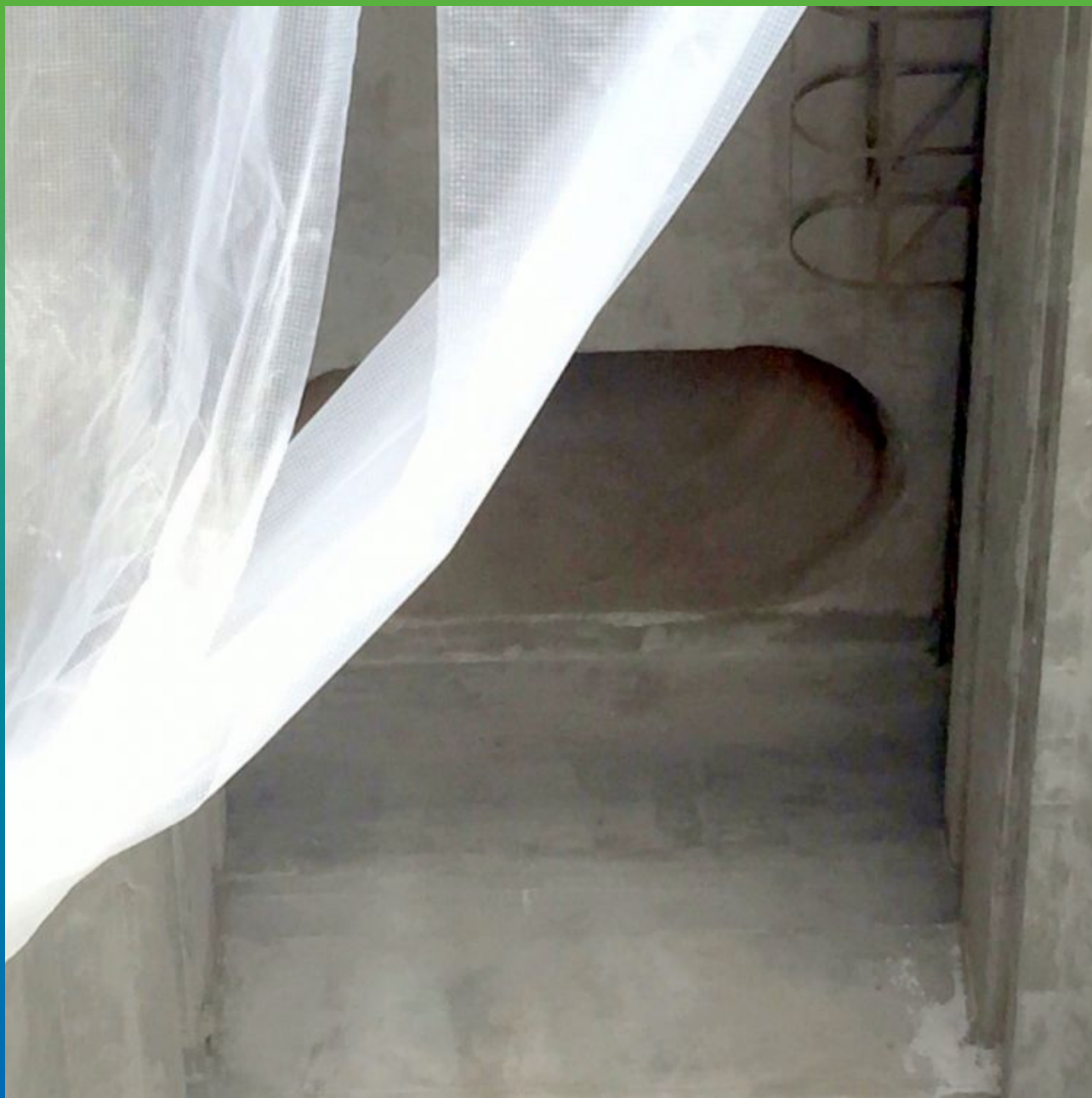
Готовое покрытие. Общий вид.
