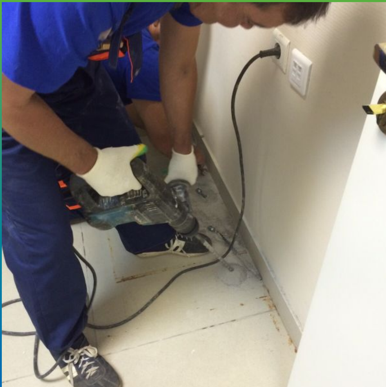
Подготовка перед инъекционными работами.
