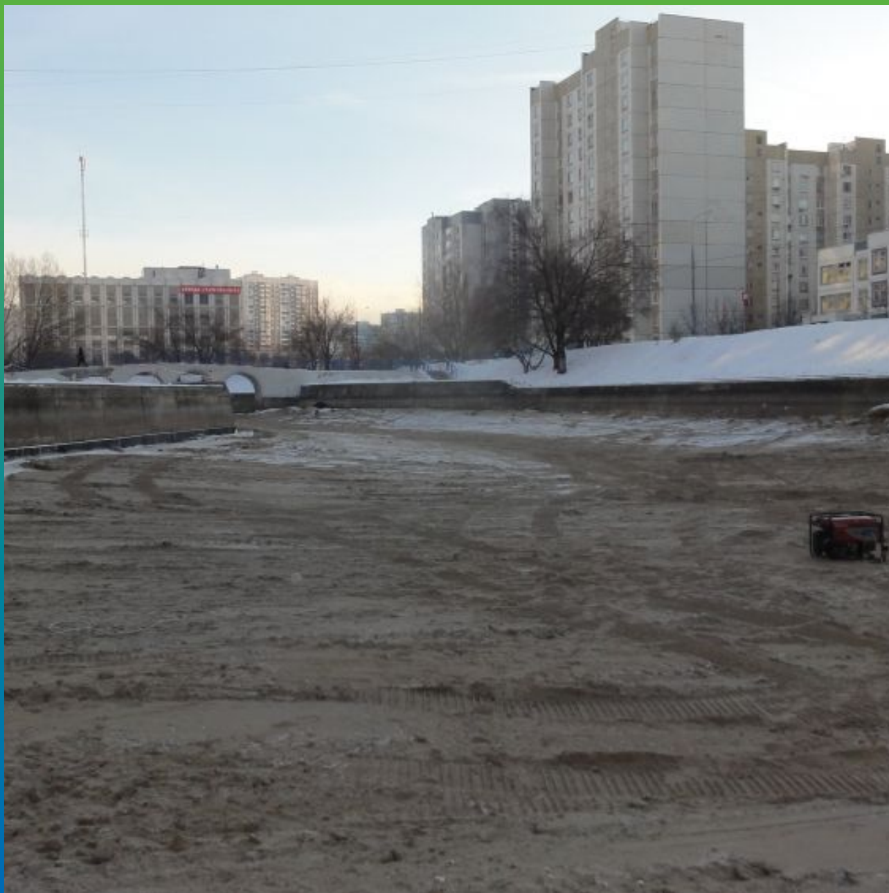
Общий вид завершеного объекта
