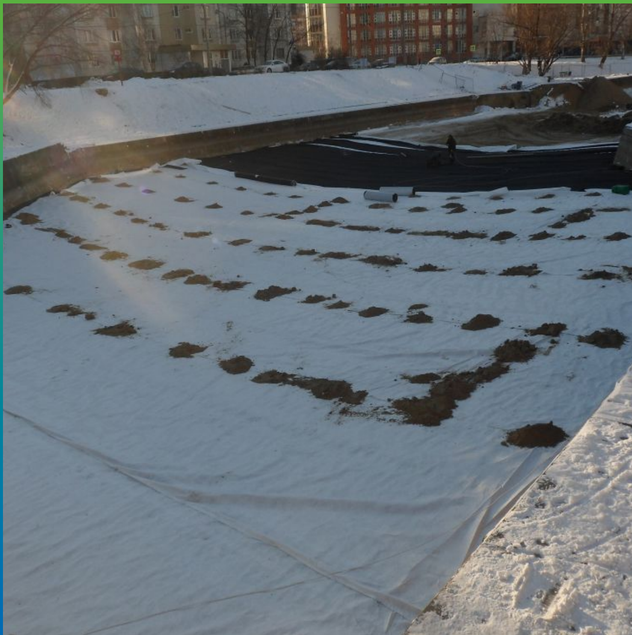
Устройство защитного слоя из Геотекстиля (Дорнит М-500)
