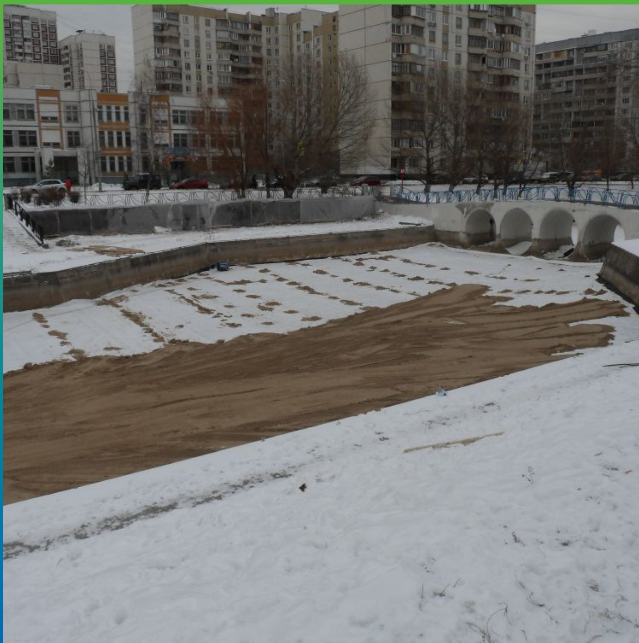
Устройство пригрузочного слоя (песок с мелким щебнем)
