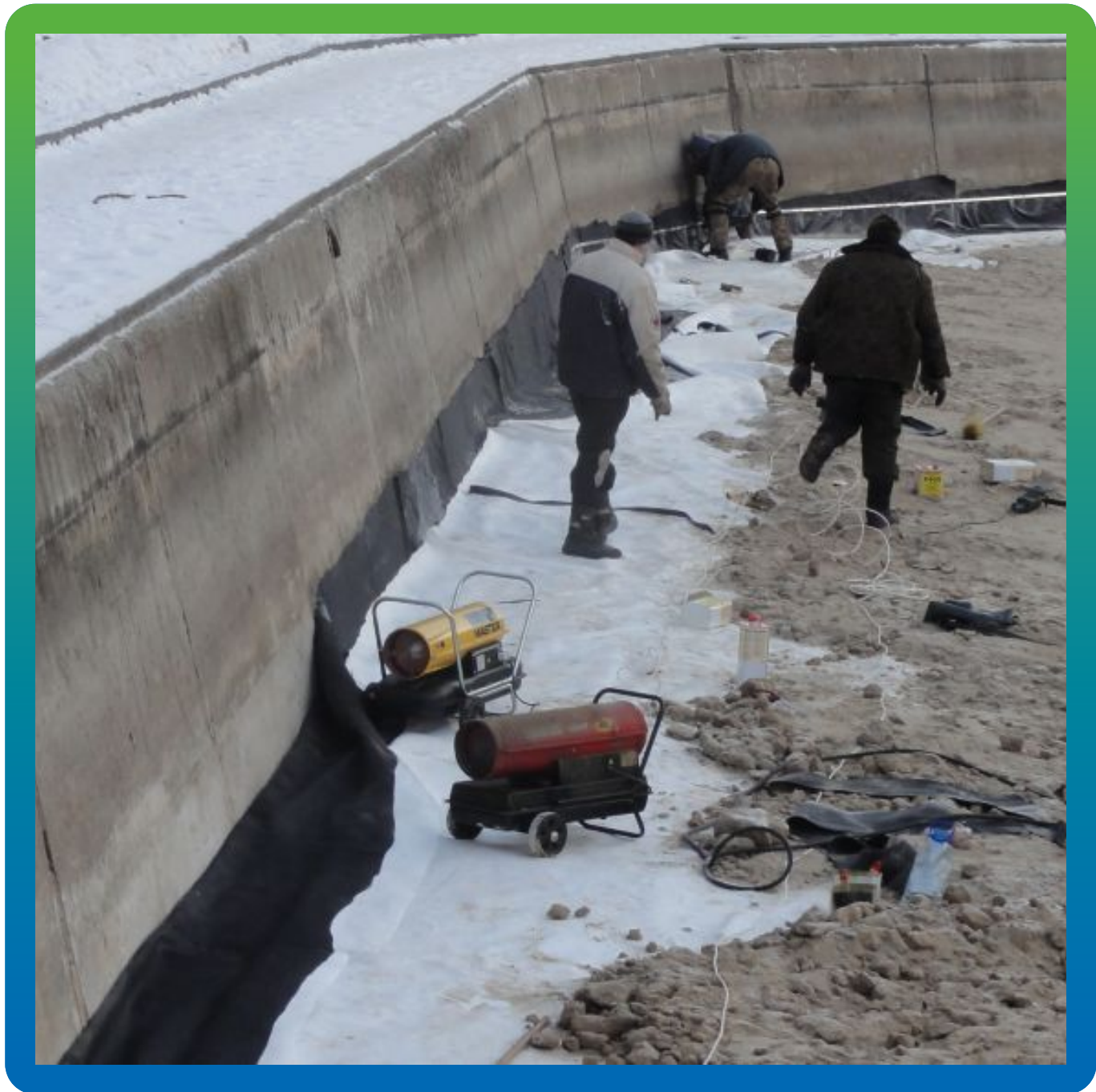
Устройство береговой зоны (обогрев с помощью тепловых пушек)
