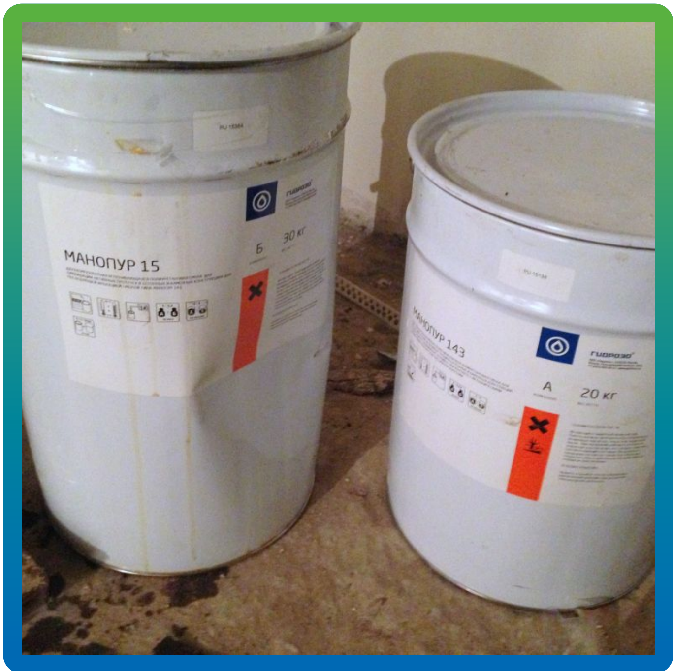
Подготовка инъекционных материалов Манопур 15, Манопур 143.
