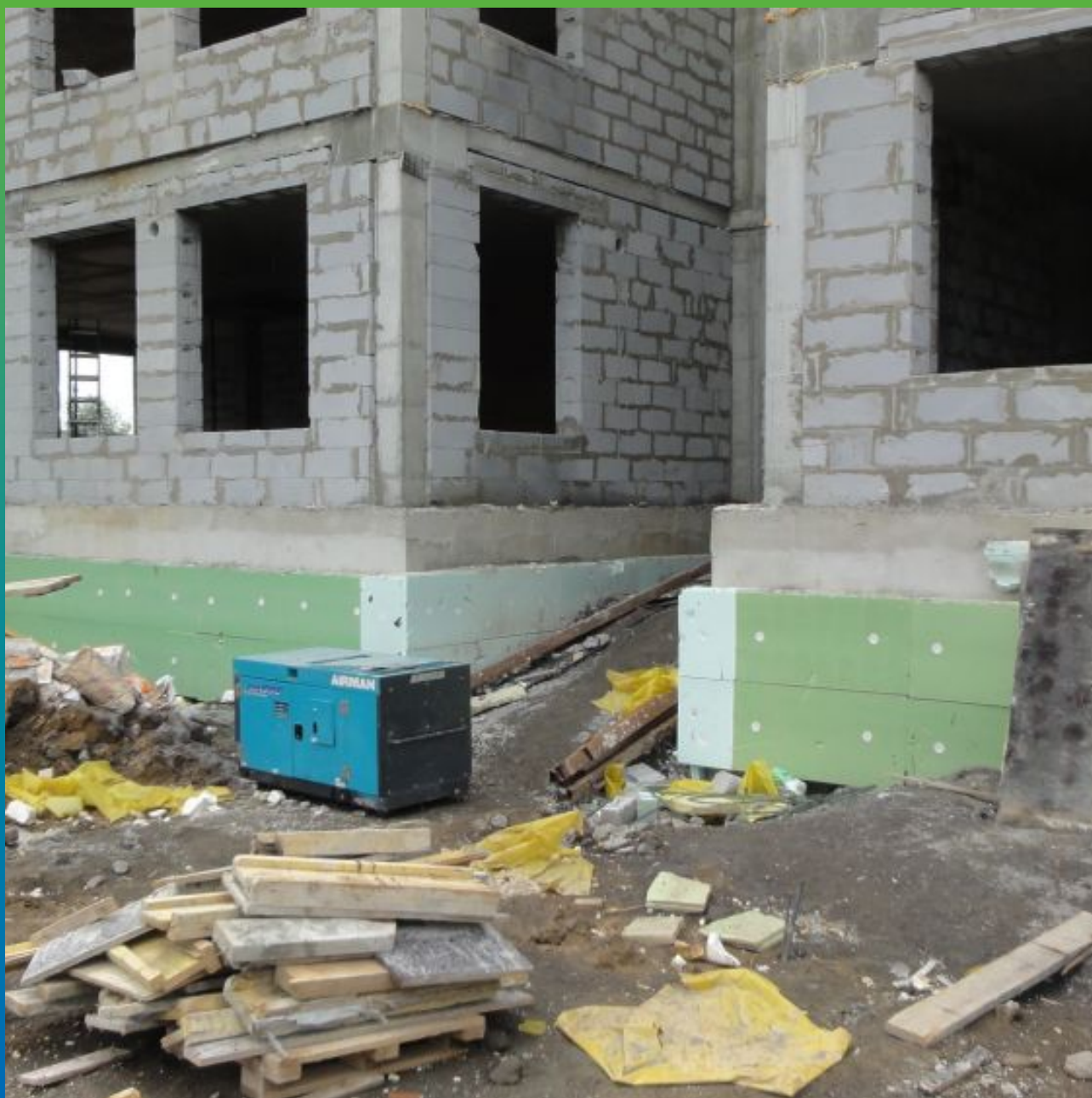
Финальный вид фундамента
