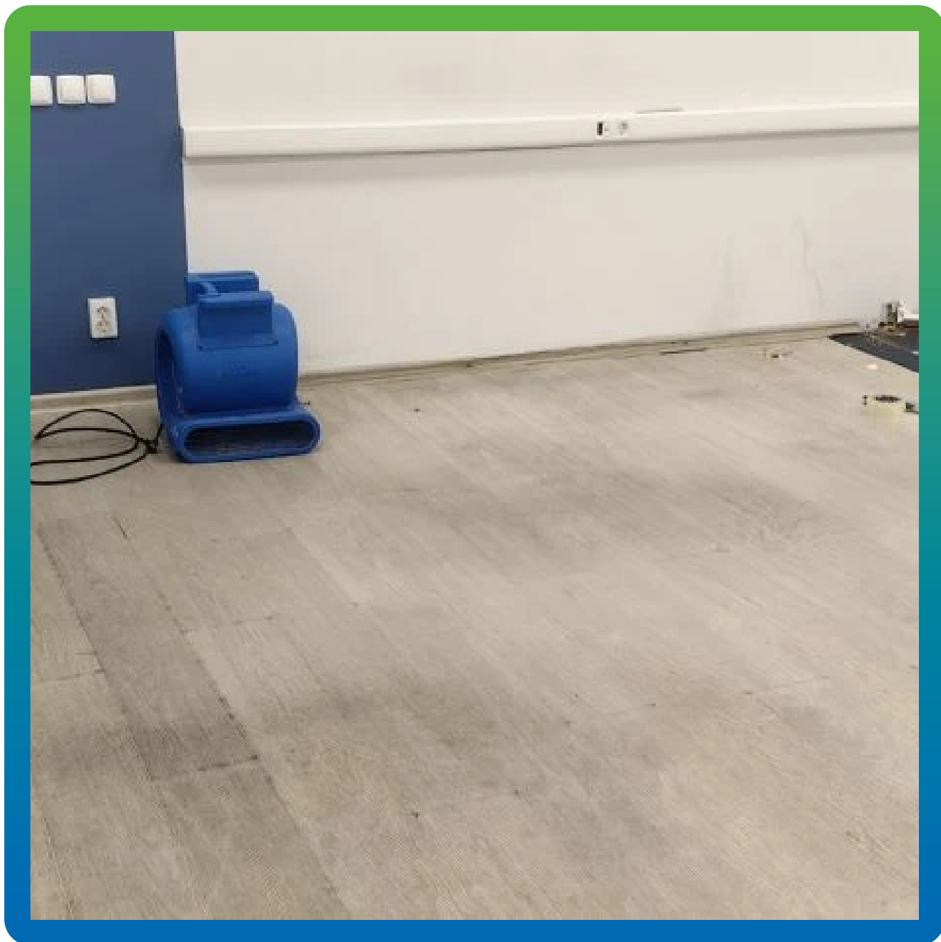
Основание до начала работ
