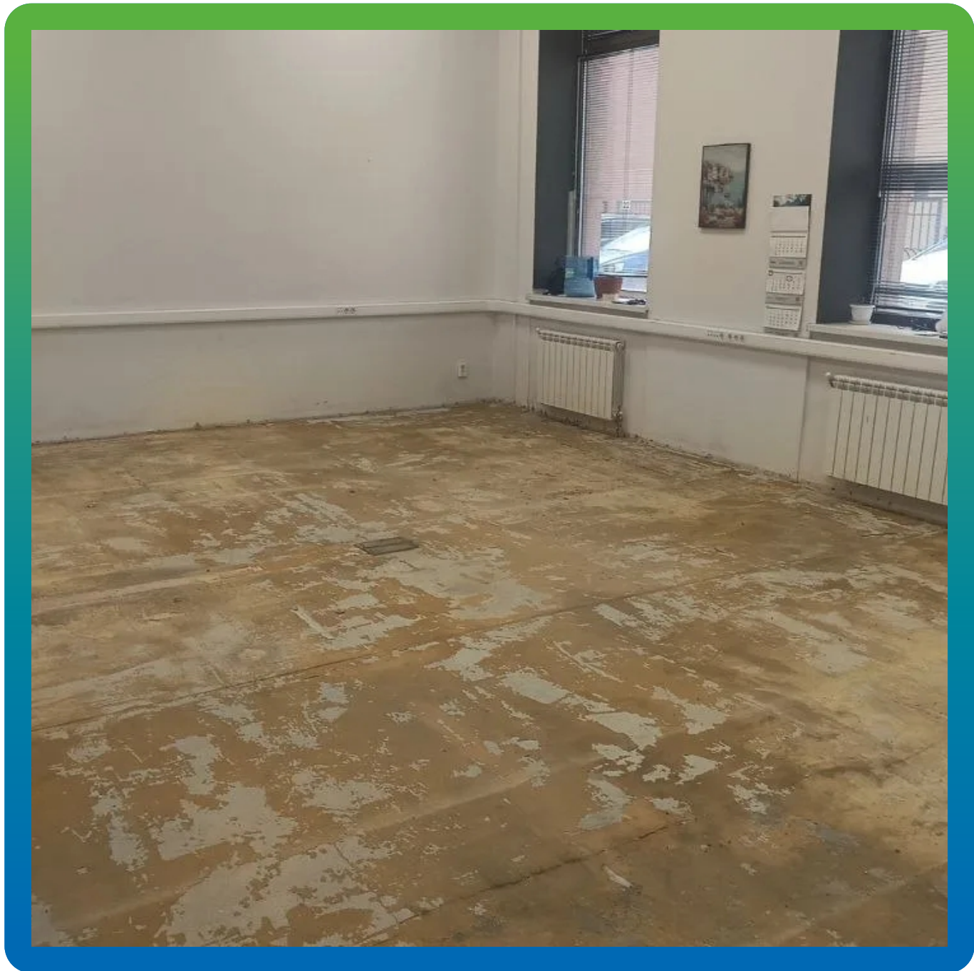
Основание после демонтажа второго покрытия
