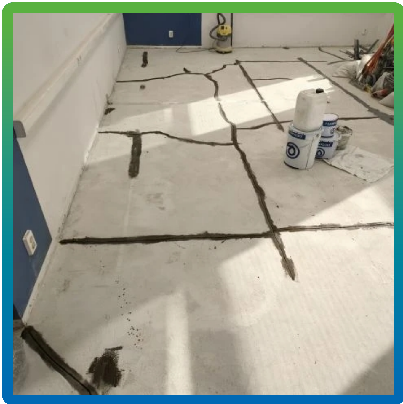
Устранение дефектов составом Манопокс 331 и грунтовкой ДенсТоп ЭП 106
