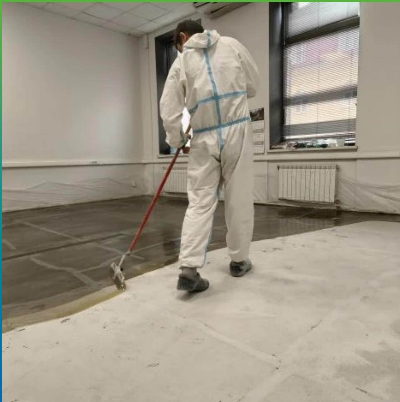
Нанесение грунтовочного состава ДенсТоп ЭП 106
