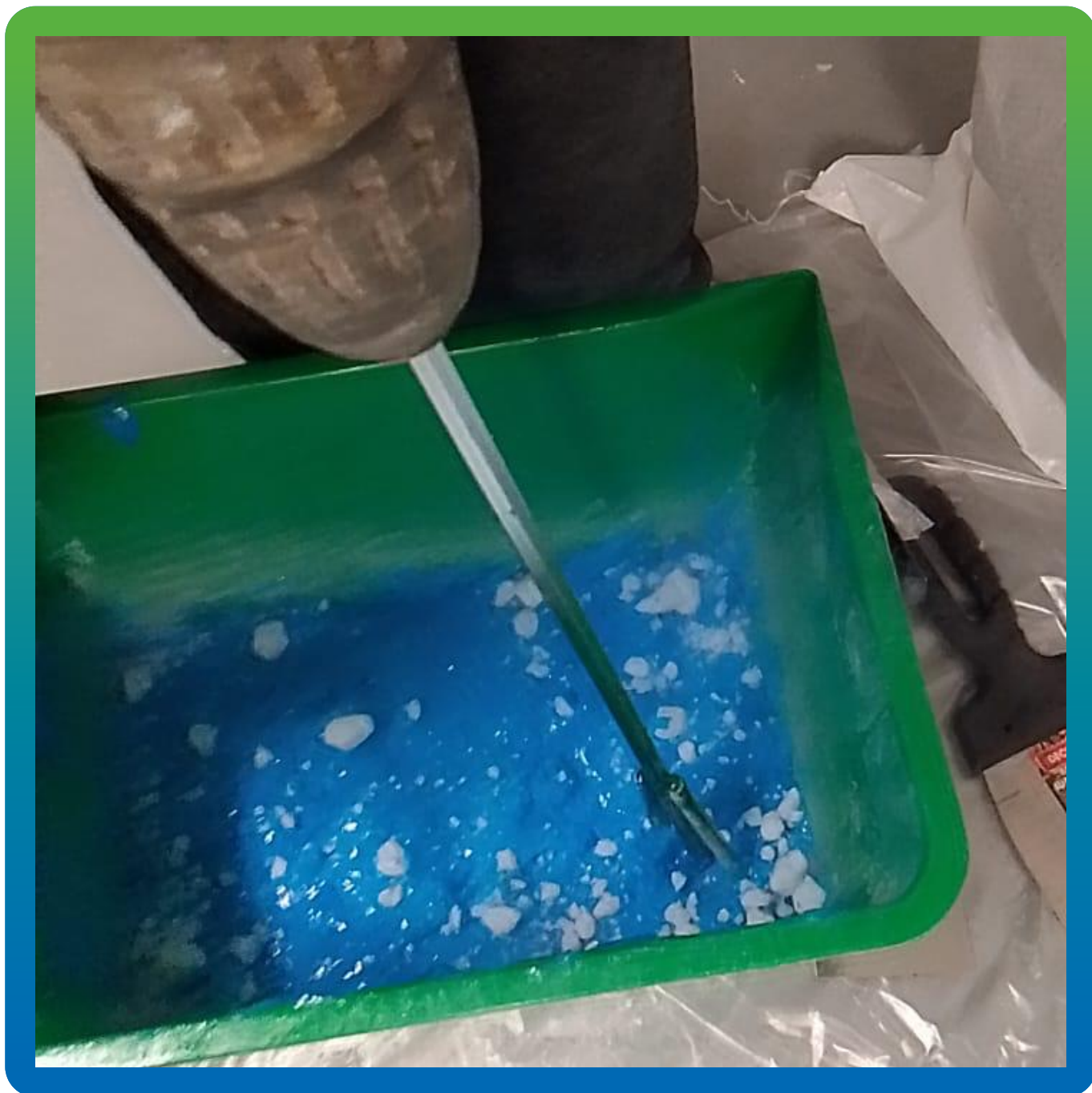
Загущение клея Манопокс 372 специальным составом Манопокс Тикс
