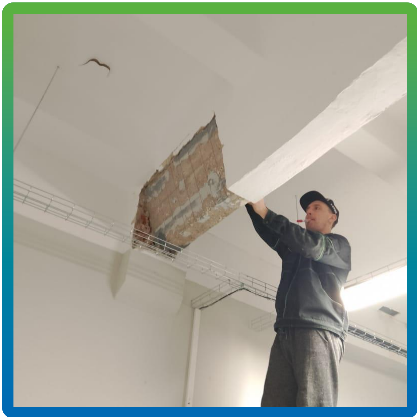
Разметка зоны монтажа системы усиления КСУ
