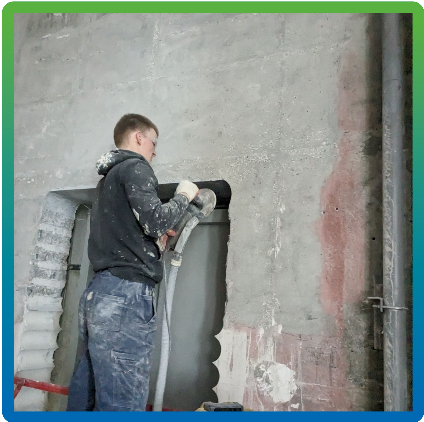
Подготовка основания к монтажу системы усиления КСУ
