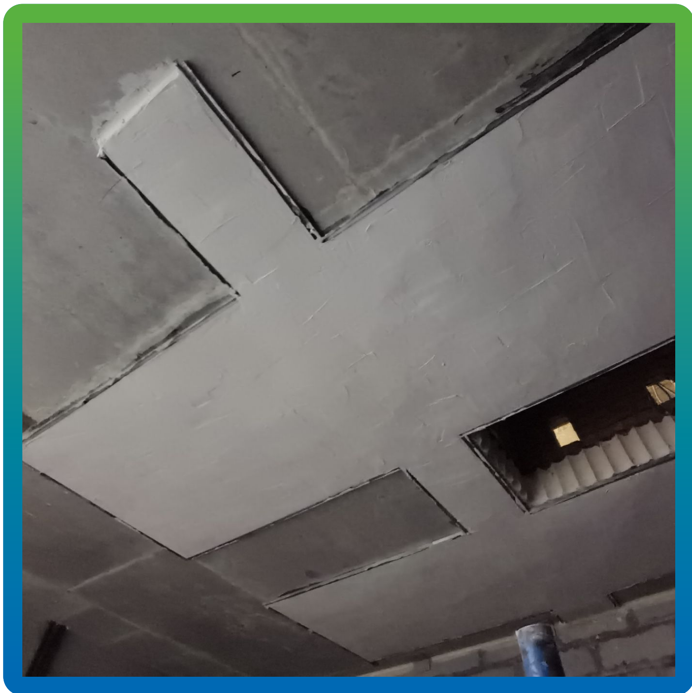
Вид смонтированной огнезащиты
