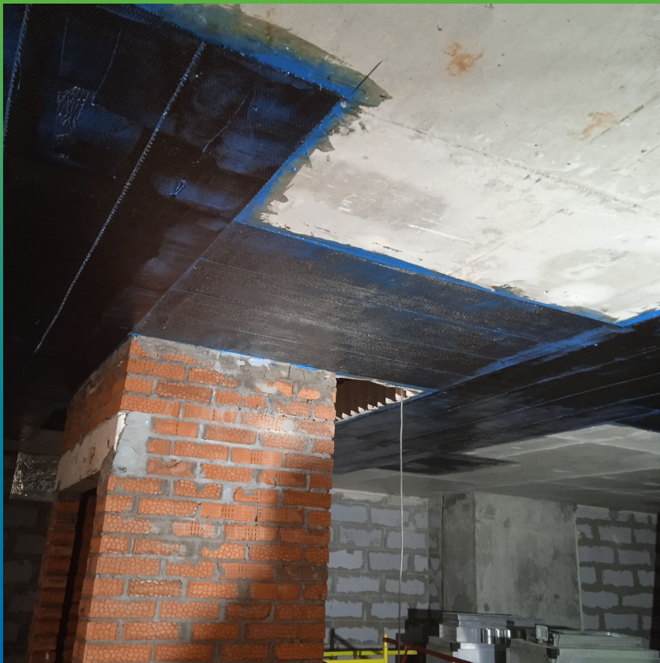
Усиление проёмов в перекрытиях плит
