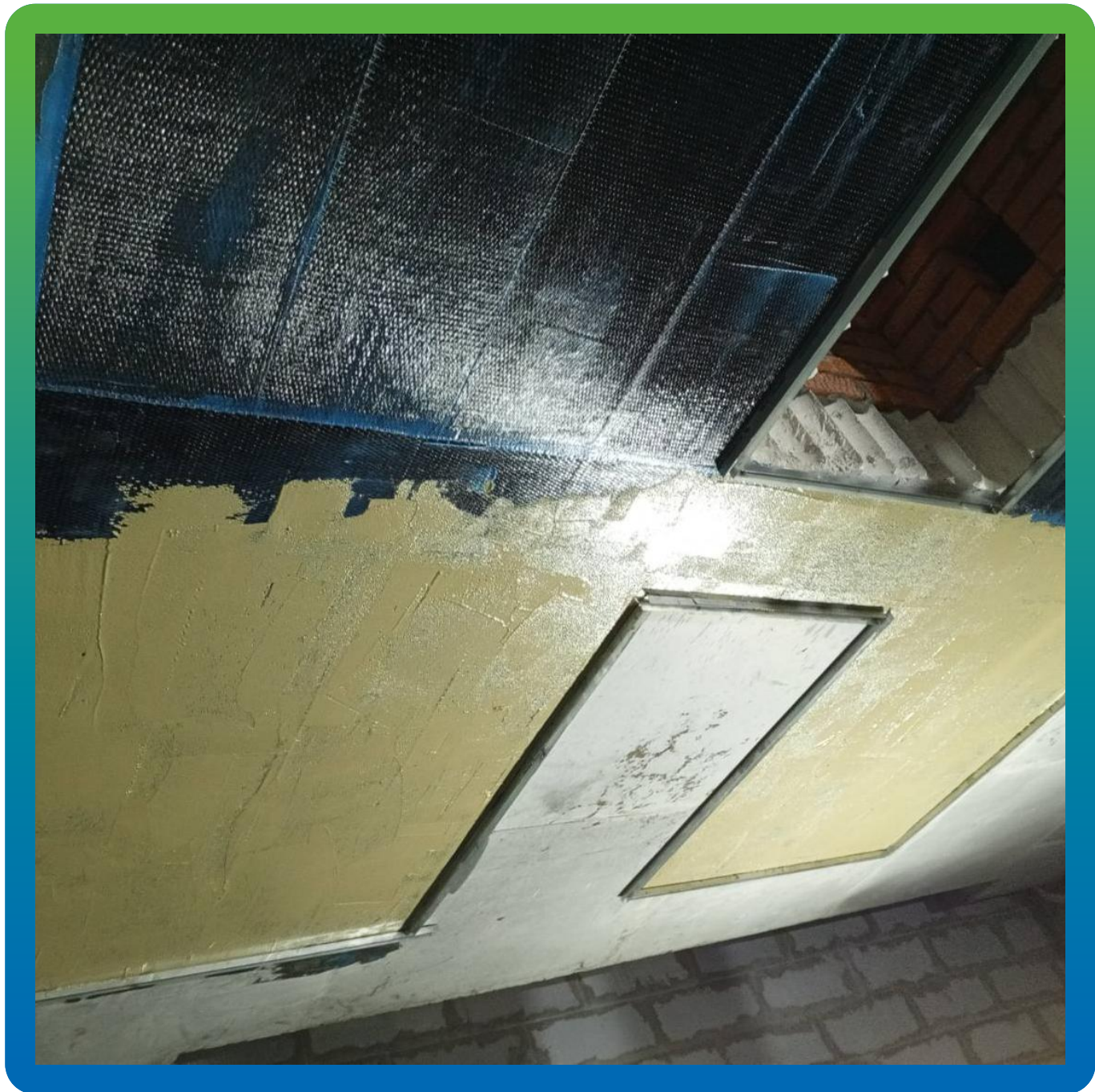
Нанесение грунтовки Пирошел Бонд на смонтированную систему усиления
