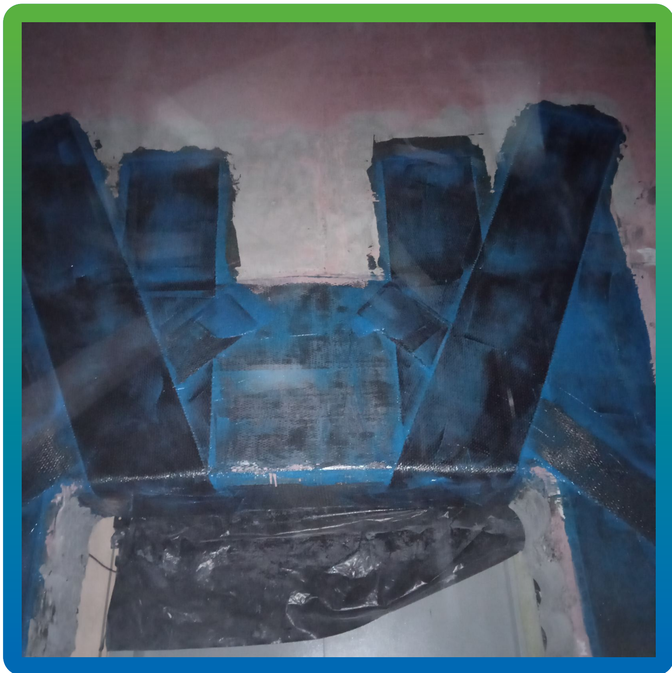
Монтаж системы КСУ над проёмами
