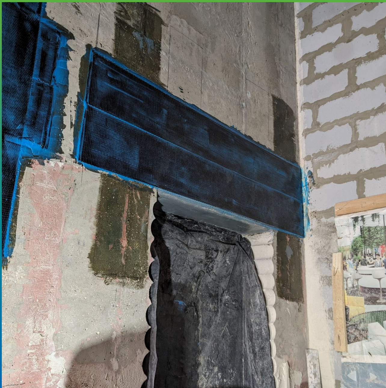
Усиление лифтовых проемов
