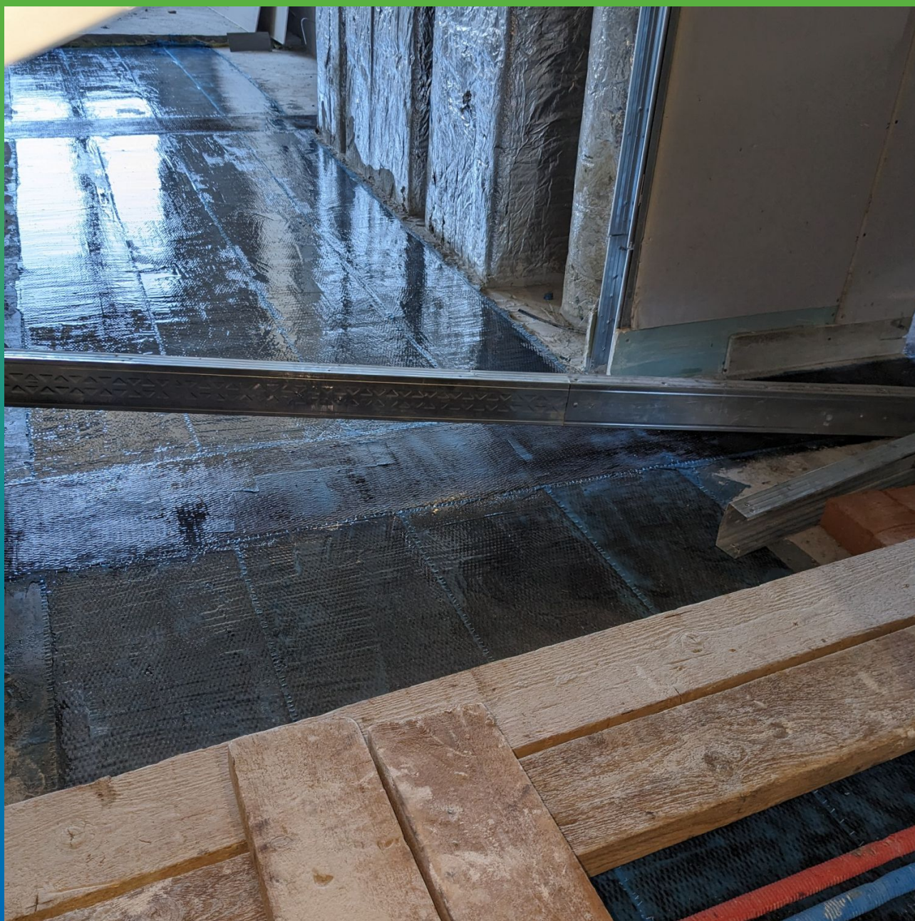
Монтаж системы усиления на этаж выше
