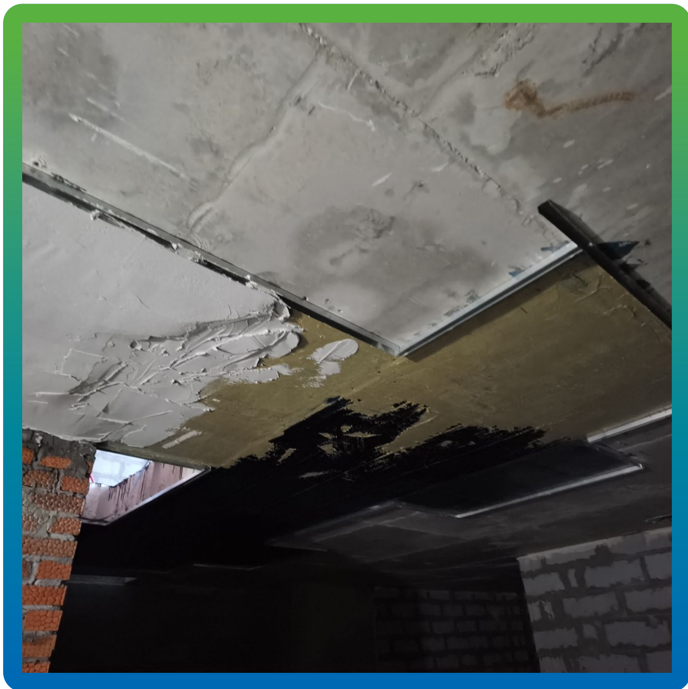
Нанесение Пирошел Цем по мокрой грунтовке Пирошел Бонд
