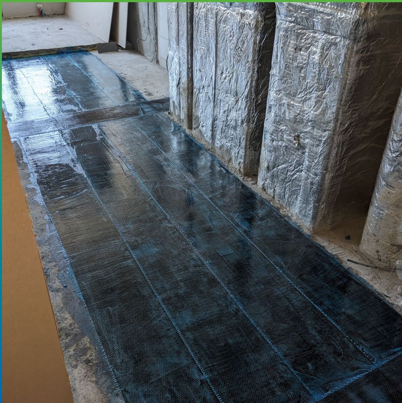
Монтаж системы КСУ на 2 этаже
