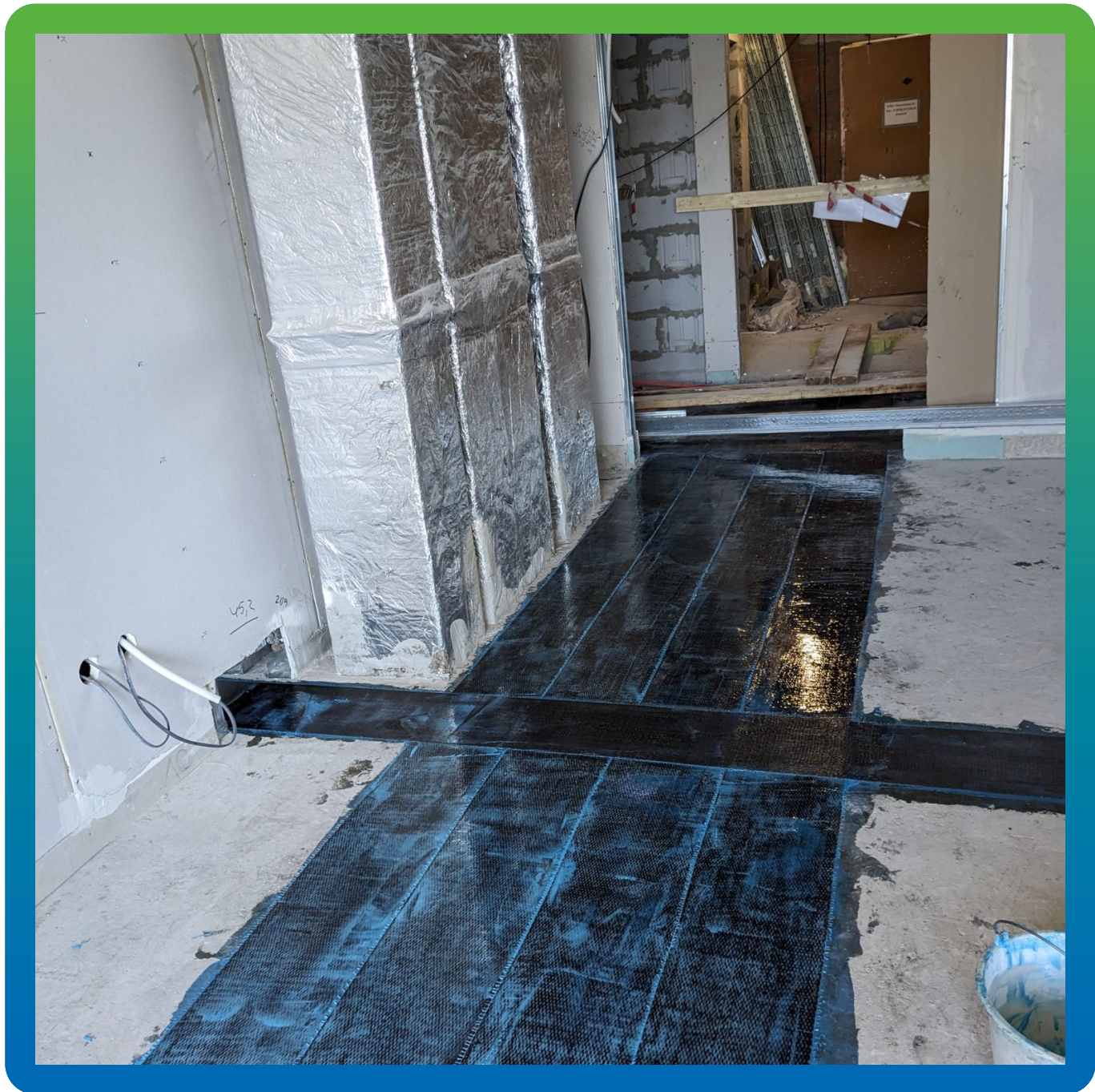
Монтаж системы КСУ на перекрытиях
