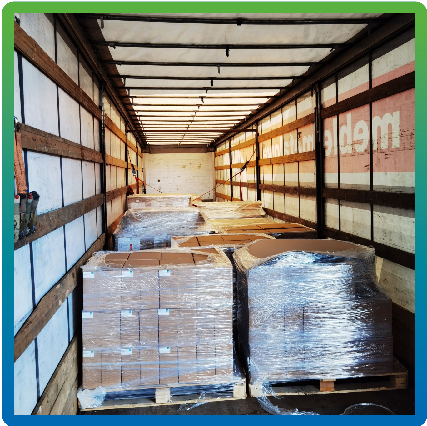
Доставка на объект материалов производства "Гидрозо"
