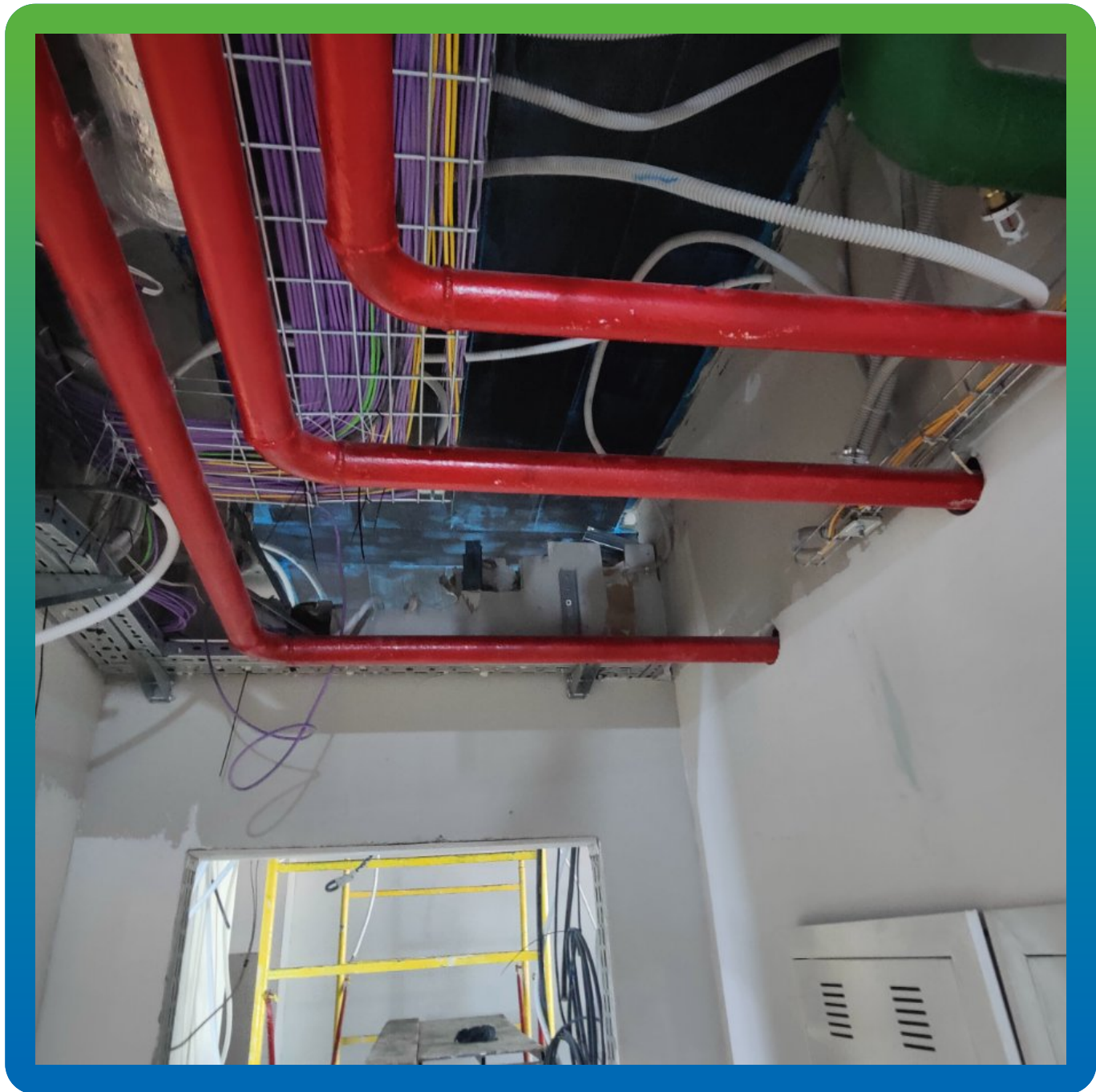
Монтаж системы КСУ в стеснённых условиях
