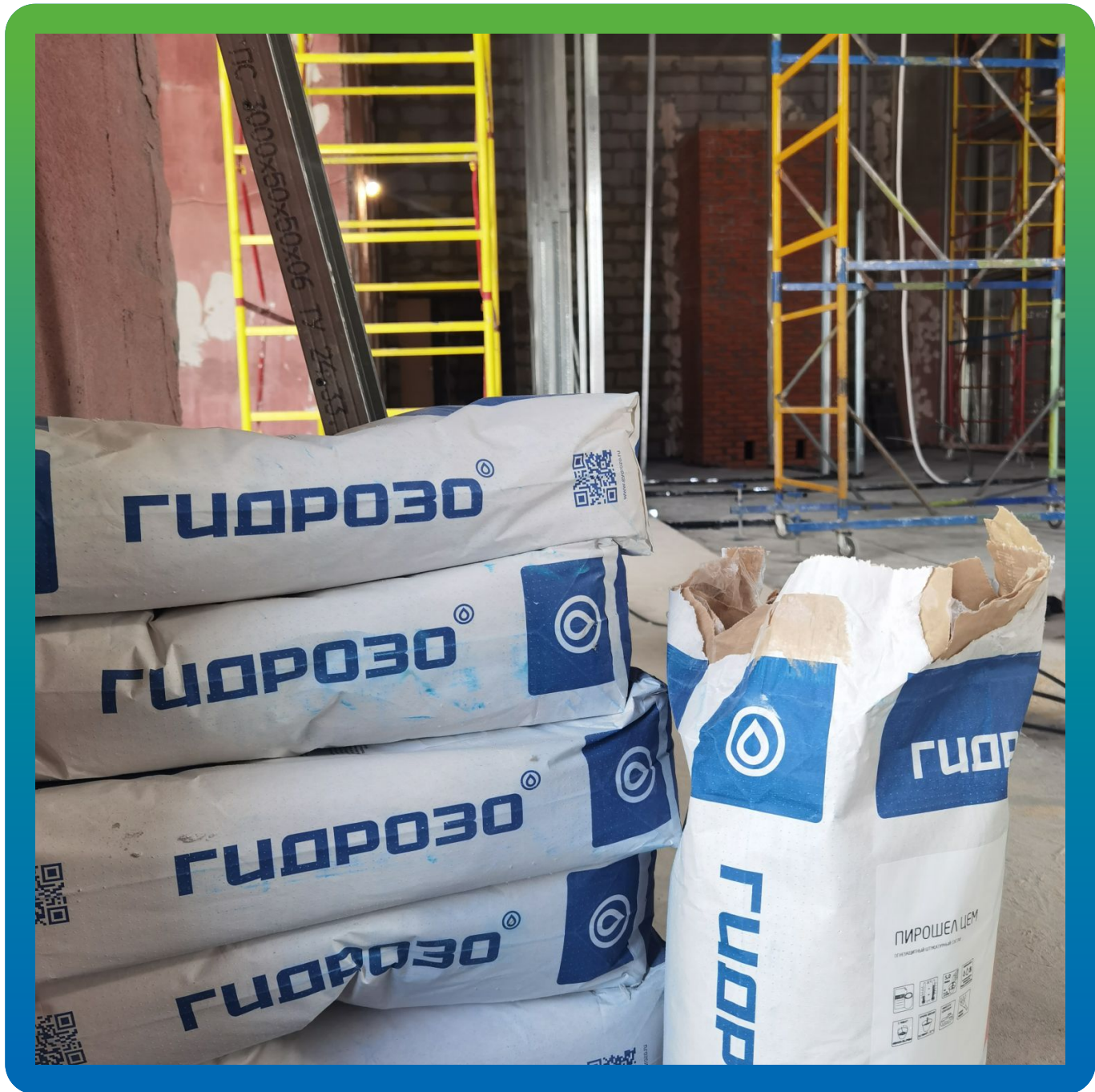
Подготовительные работы к монтажу системы огнезащиты Пирошел Цем
