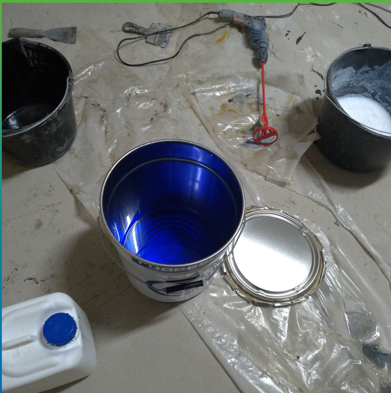
Подготовка клея Манопокс 372 нанесению в качестве грунта для основания и пропитки холстов Армошел КВ 900
