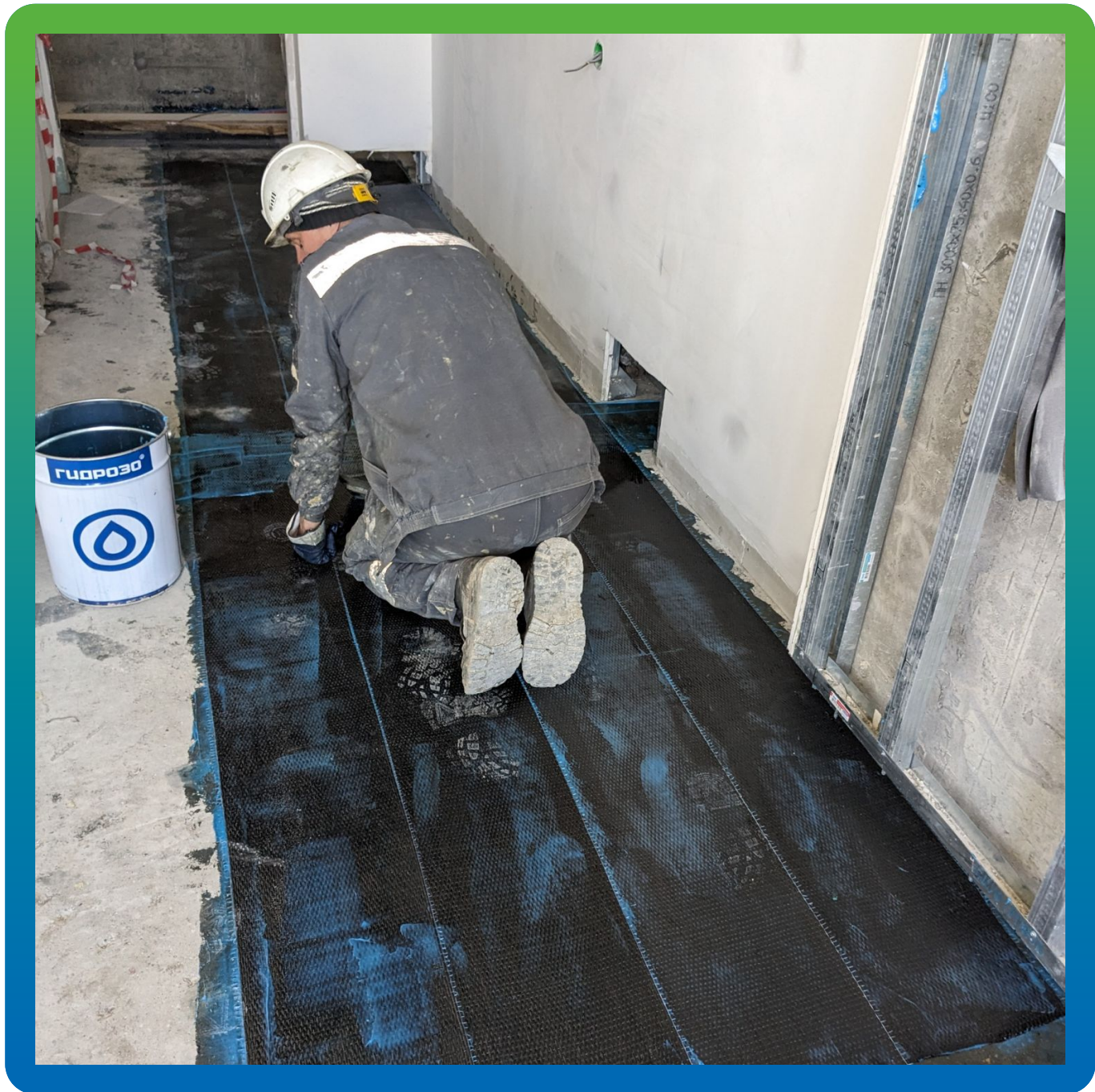
Запечатка загущенным клеем Манопокс 372 в смеси с загустителем Манопокс Тикс
