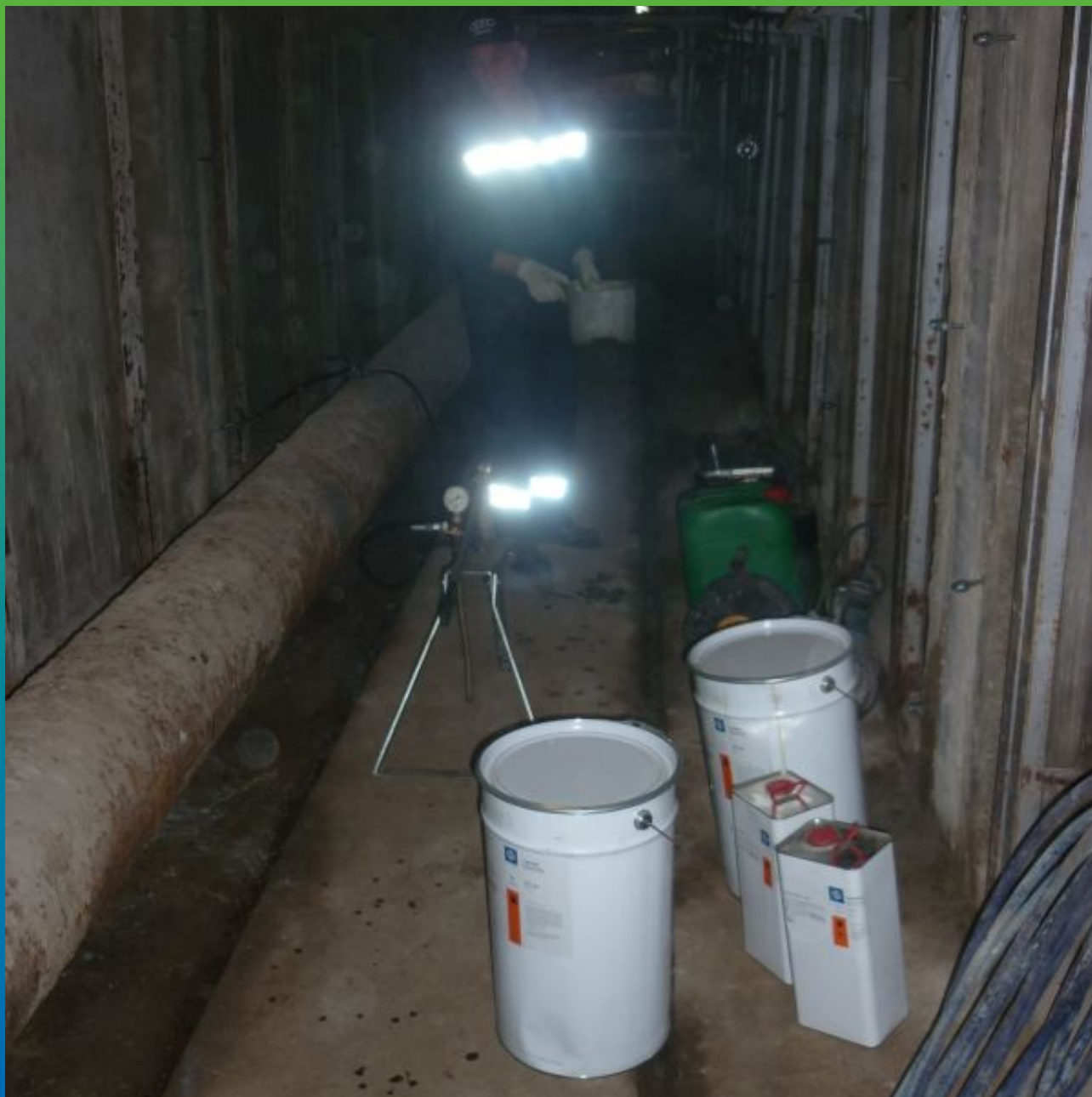
Вид объекта перед началом работ
