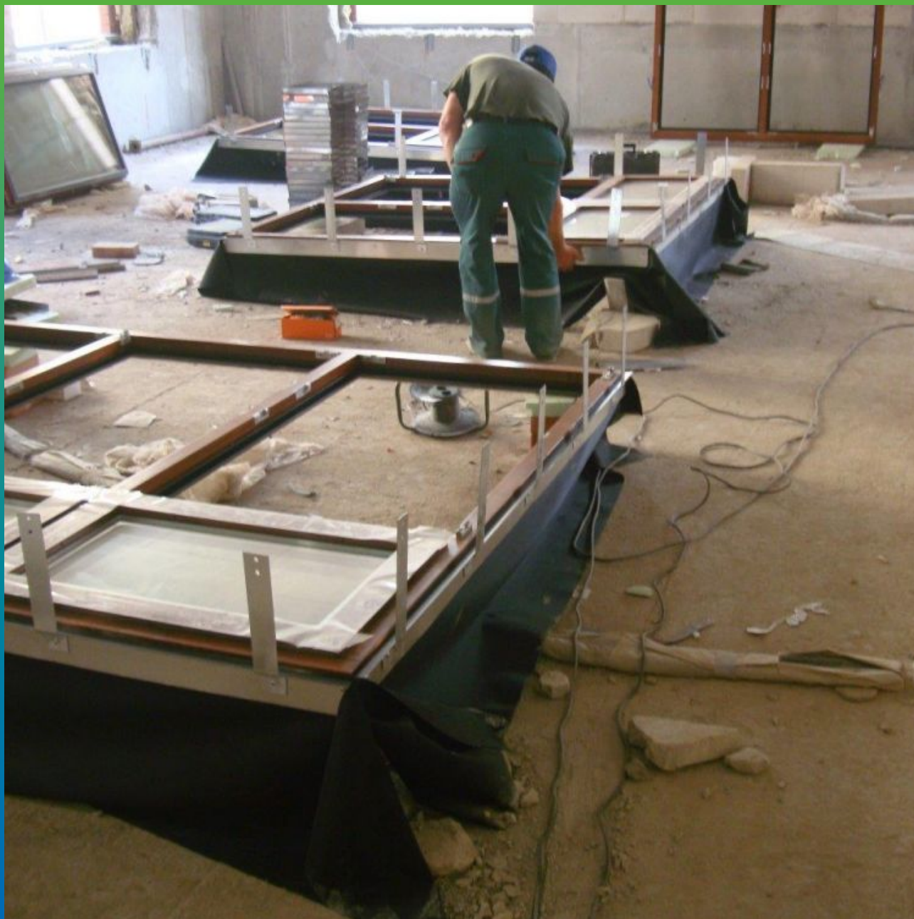
Монтаж ЭПДМ мембраны Эластосил к оконной конструкции
