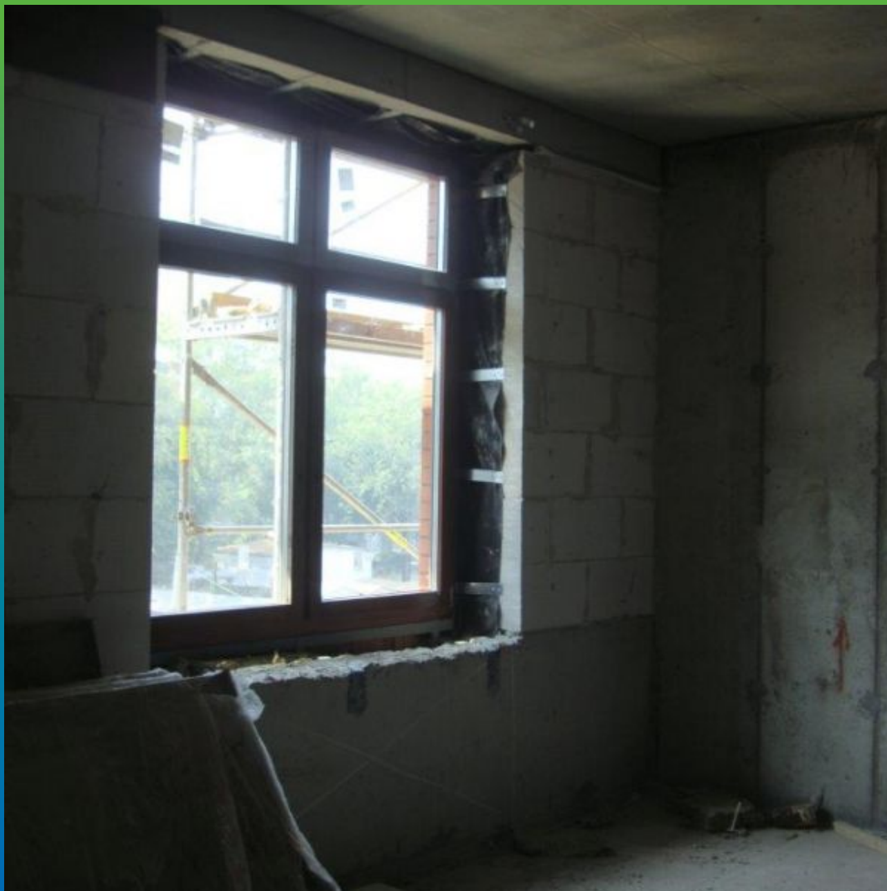
Финальный вид гидроизоляции оконного проема ЭПДМ мембраной Эластосил
