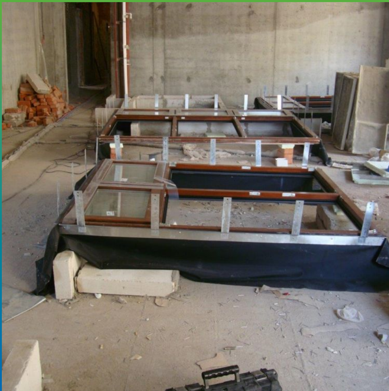
Монтаж ЭПДМ мембраны Эластосил к оконной конструкции
