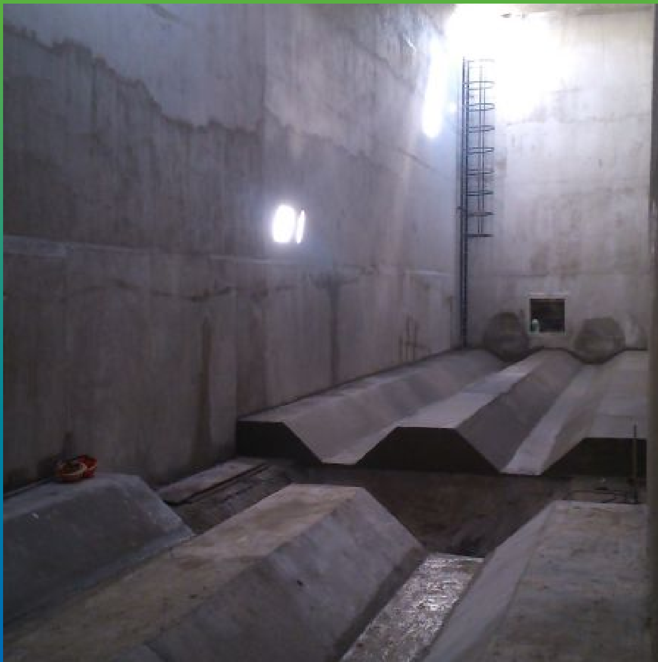
Вид объекта перед нанесением материала Максил Супер
