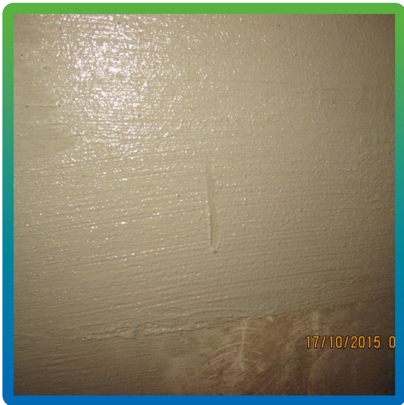
Максил супер после нанесения
