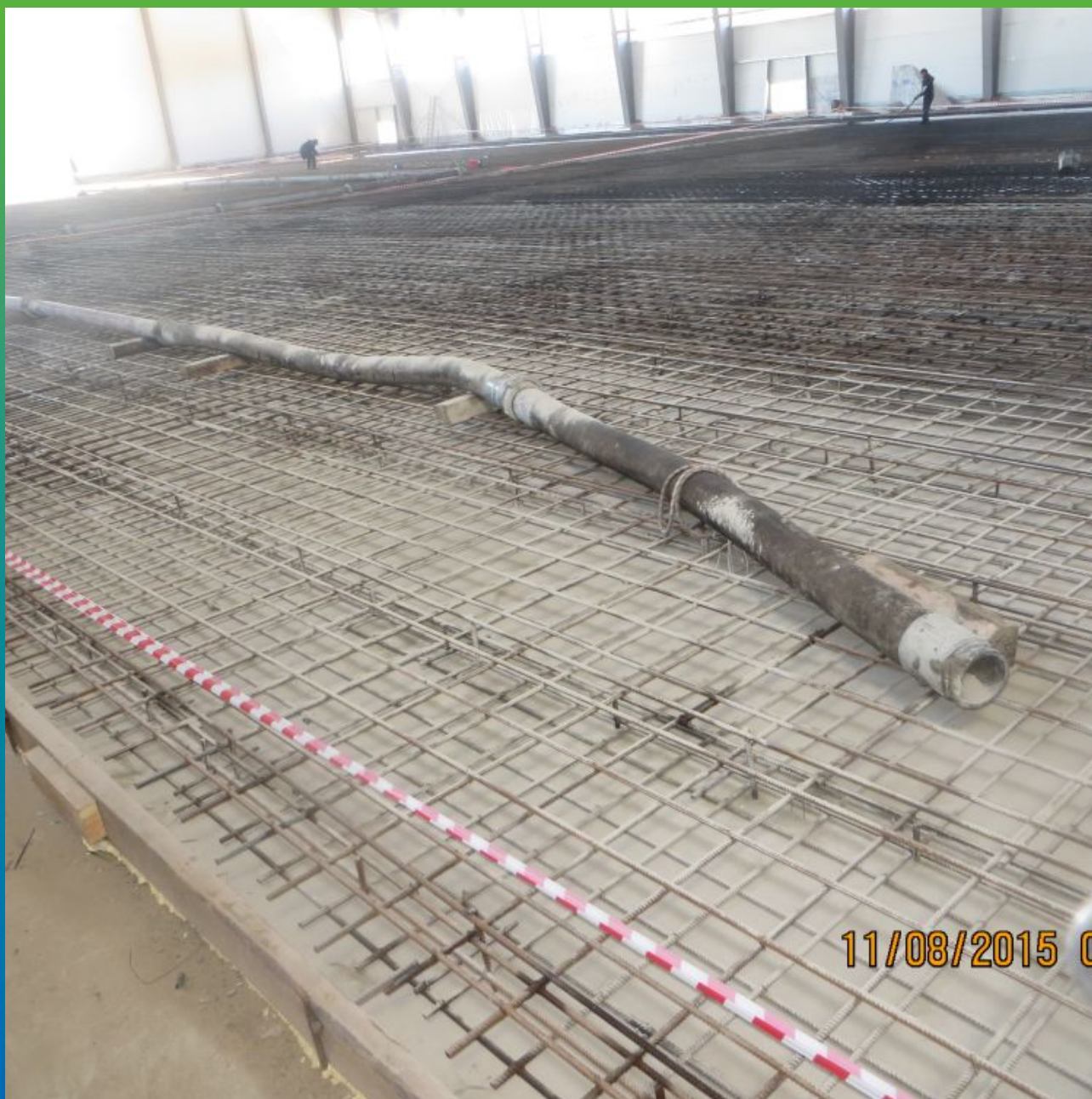
Вид просыпанной гидроизоляции Макссил Супер по бетонной подготовке перед отливкой фундаментной плиты
