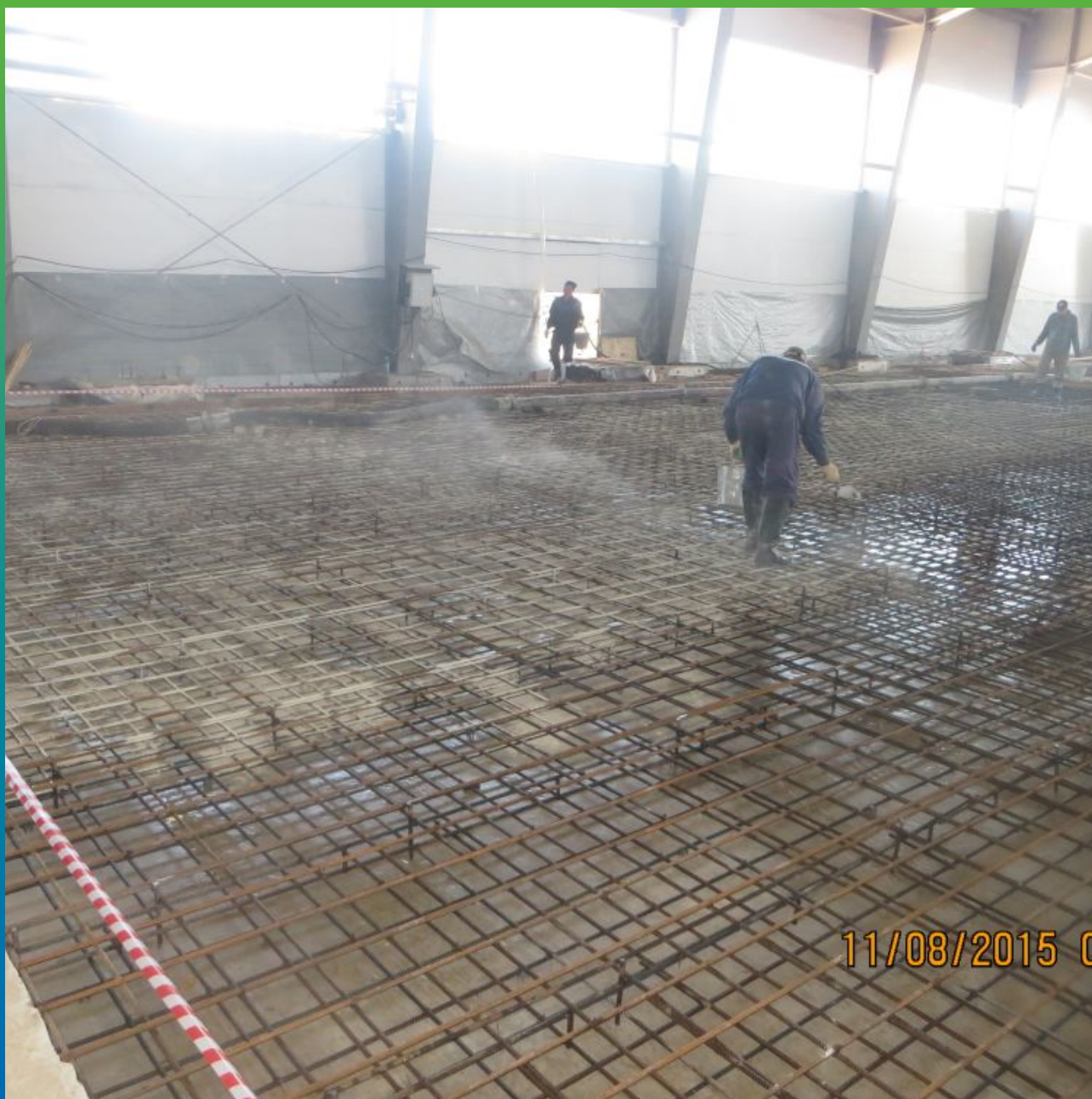
Просыпка материала осмотического действия Макссил Супер, устройство гидроизоляции фундаментной плиты
