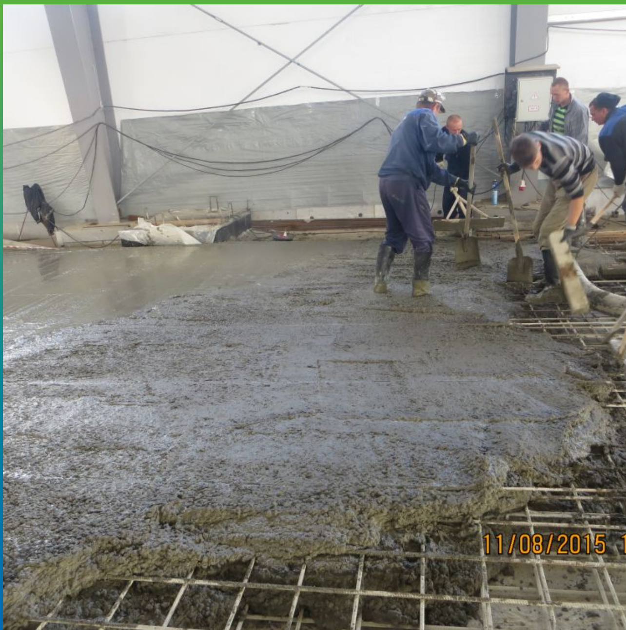
Устройство фундаментной плиты, по гидроизоляционному слою из Макссил Супер
