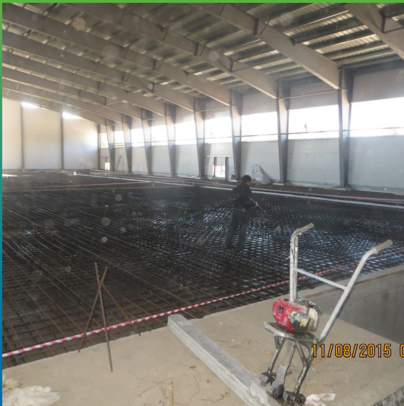
Увлажнение бетонной подготовки перед просыпкой Макссил Супер
