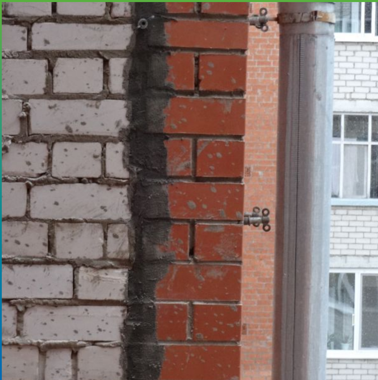
Чеканка швов и трещин быстрым, высокопрочным составом Стармекс РМЗ
