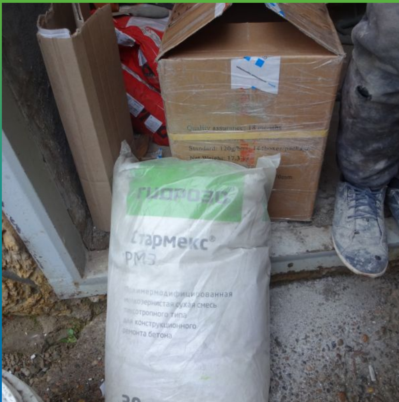
Материалы "Гидрозо" на объекте
