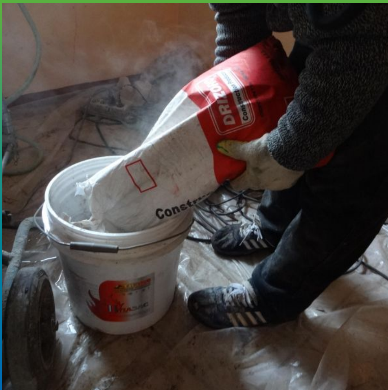
Затворение с водой инъекционного, высокотекучего, высокопрочного состава Максгруот Инжекшн
