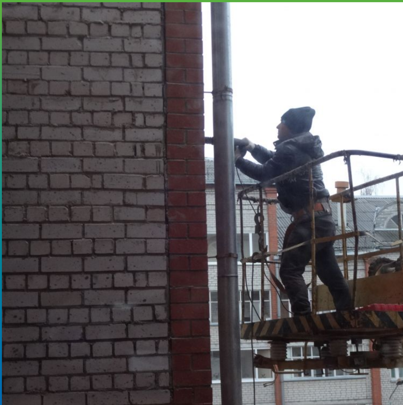
Установка в шпury пакеров БМ 2830
