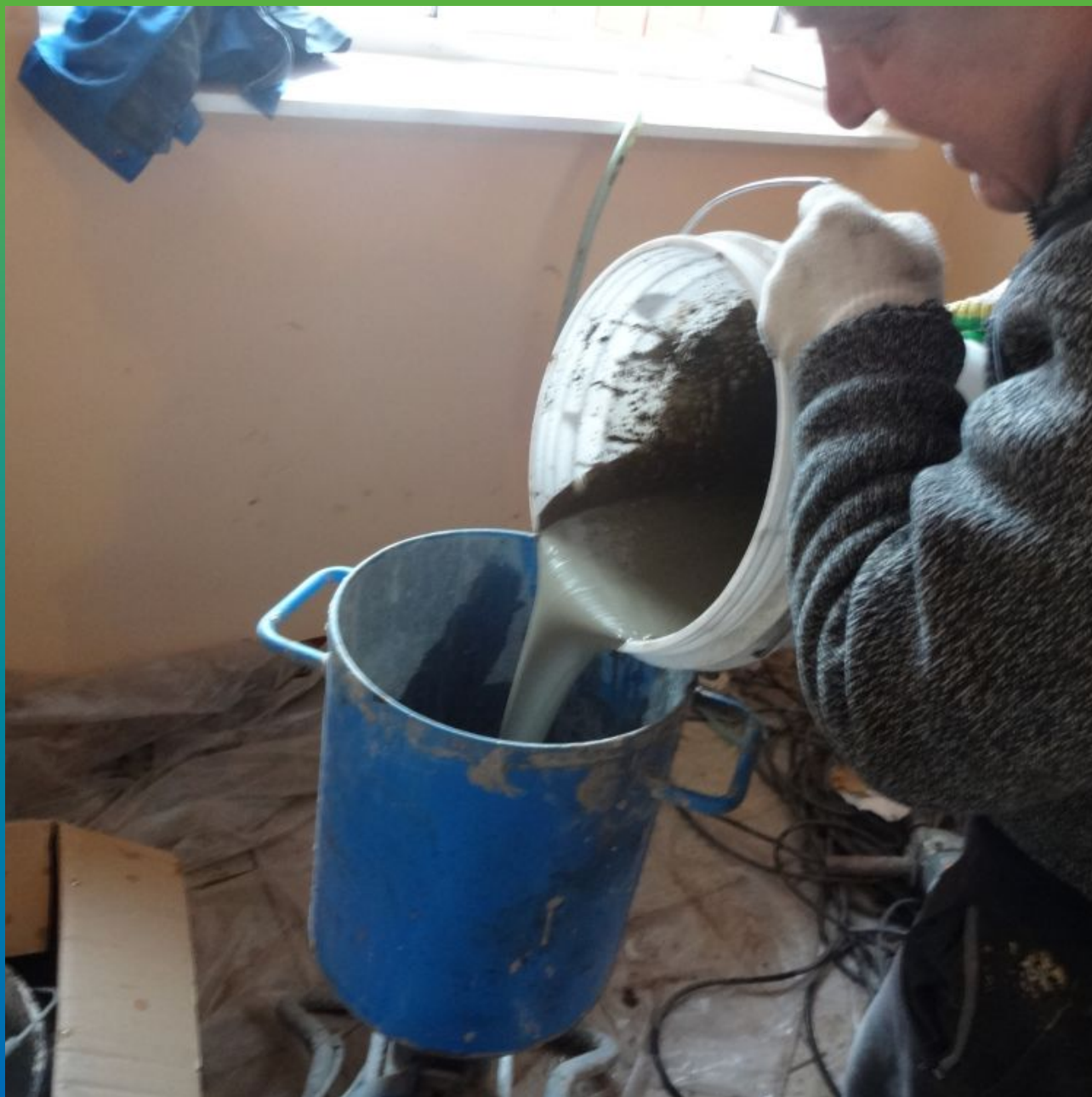
Заливка в бункер шнекового насоса инъекционного раствора Максгрут Инжекшн
