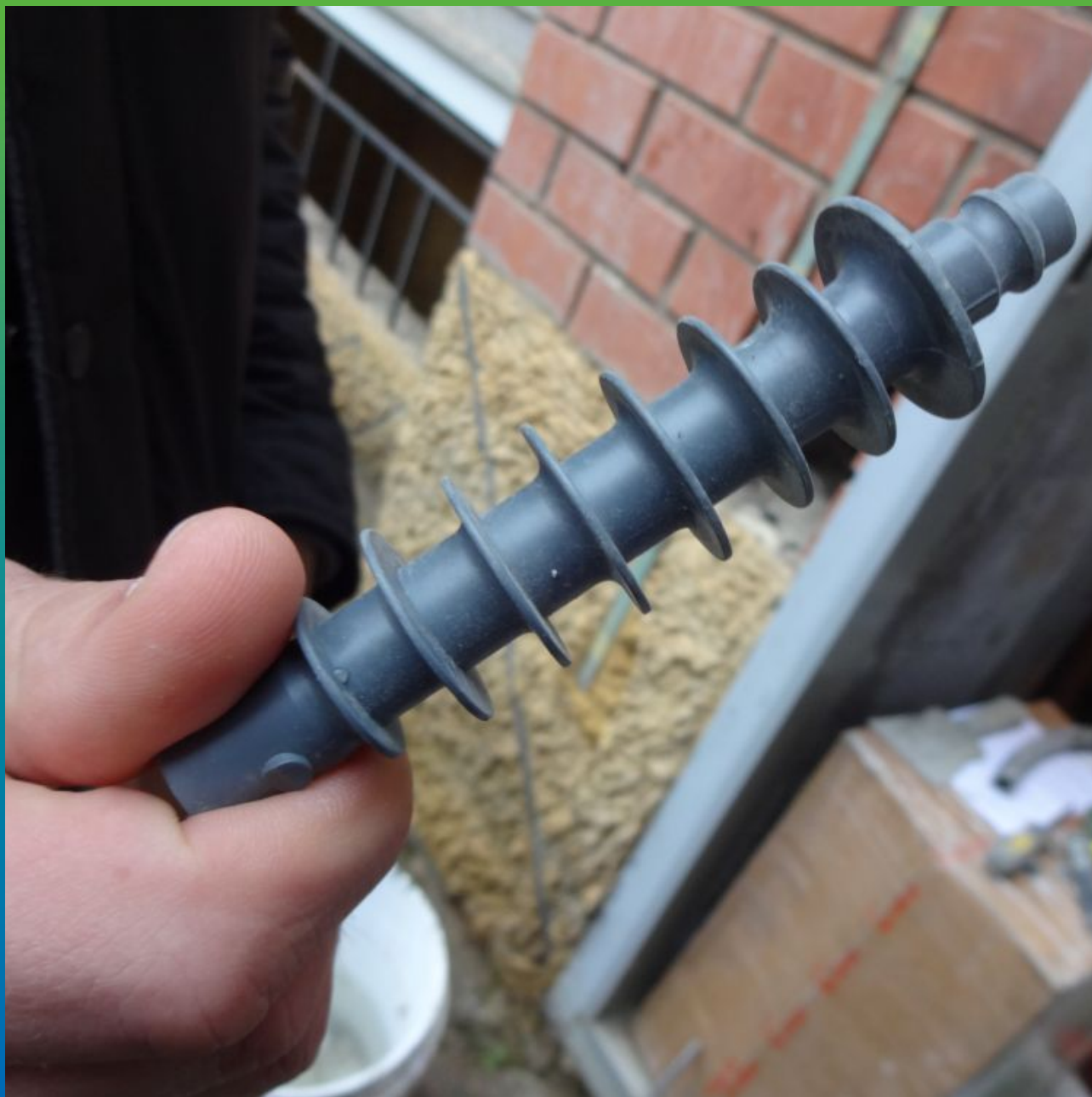
Установка в шуры пакеров БМ 2830
