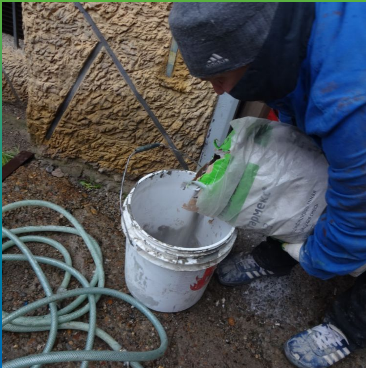
Затворение с водой Стармекс РМЗ быстрого, безусадочного раствора
