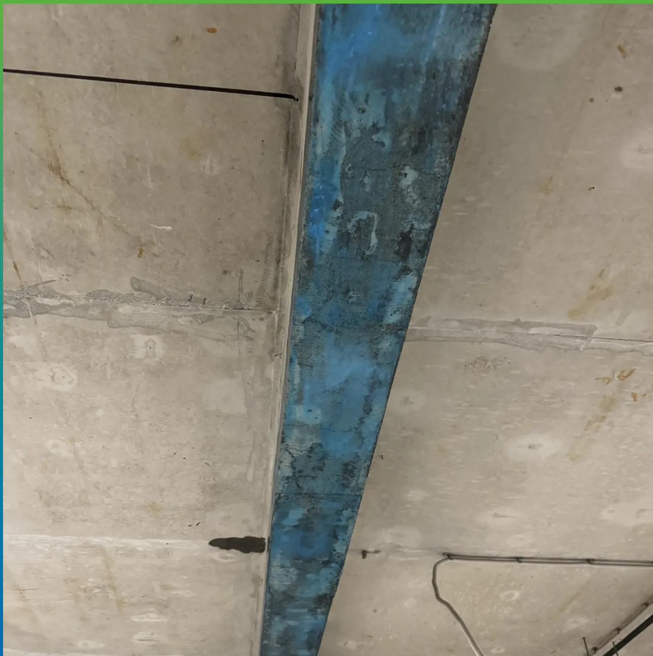
Огрунтованная поверхность
