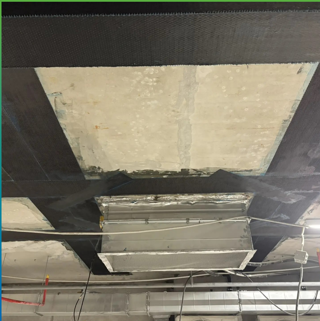
Участок выполненного КСУ материалом Армошел KB 900
