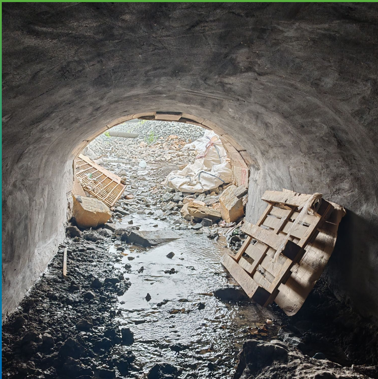
Общий вид после проведения работ со стороны ул. Локомотивная
