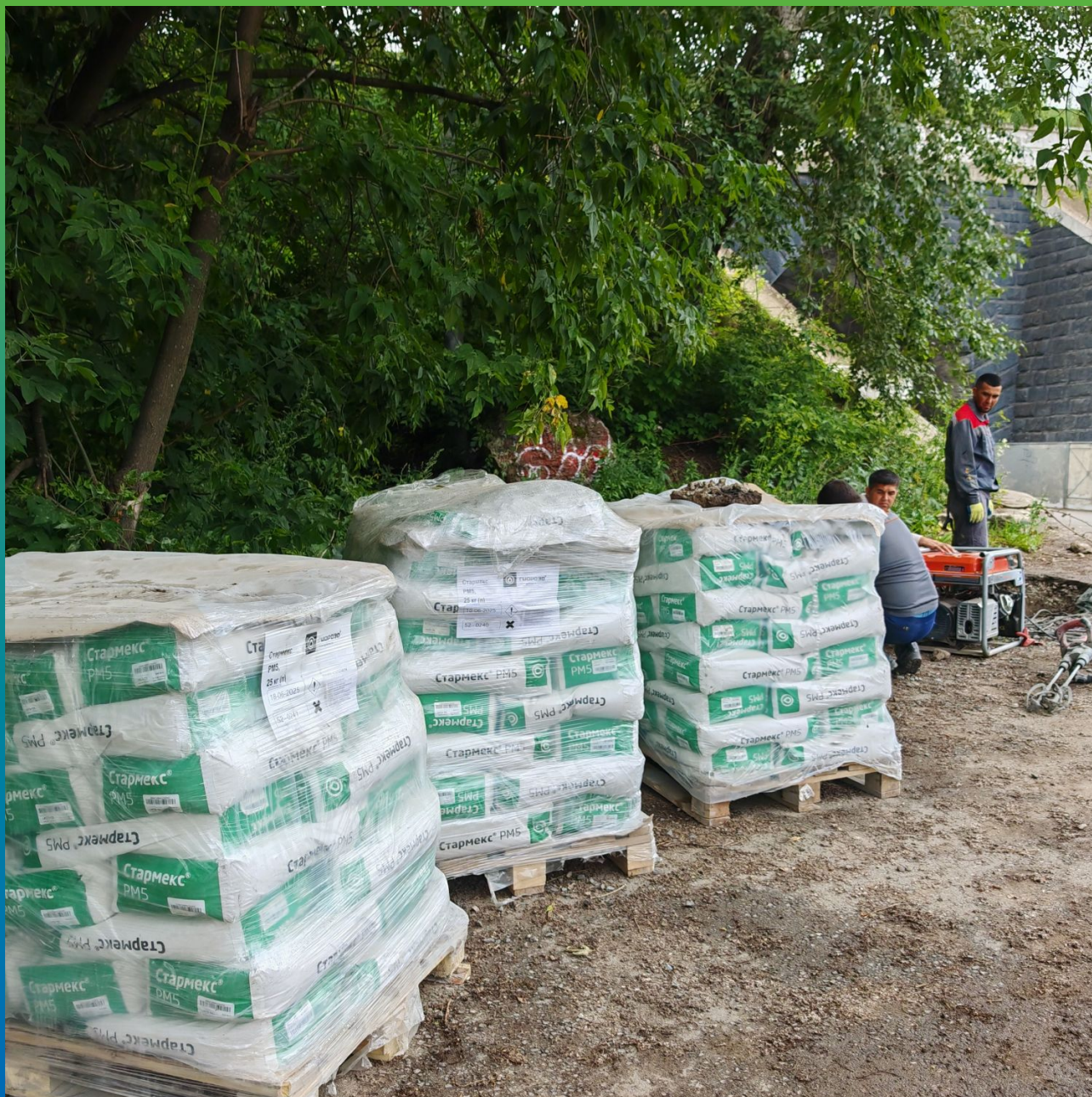
Материалы производства "Гидрозо" на объекте
