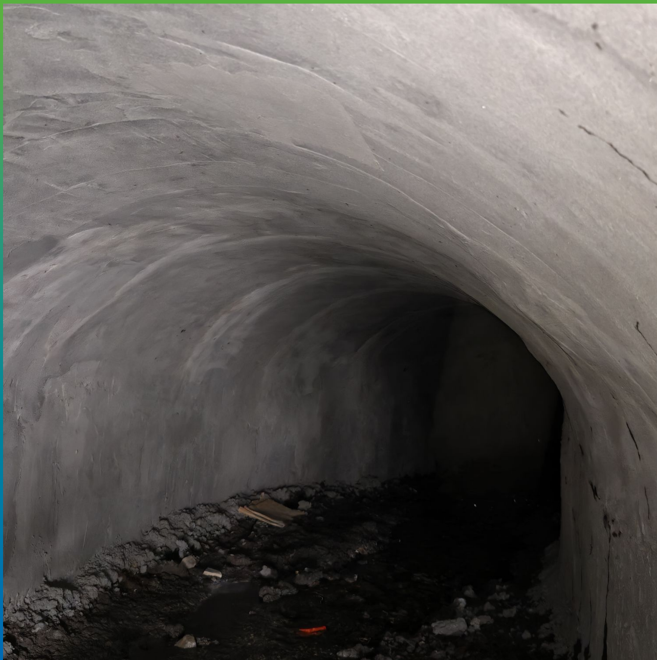
Общий вид объекта со стороны п. Гайдара
