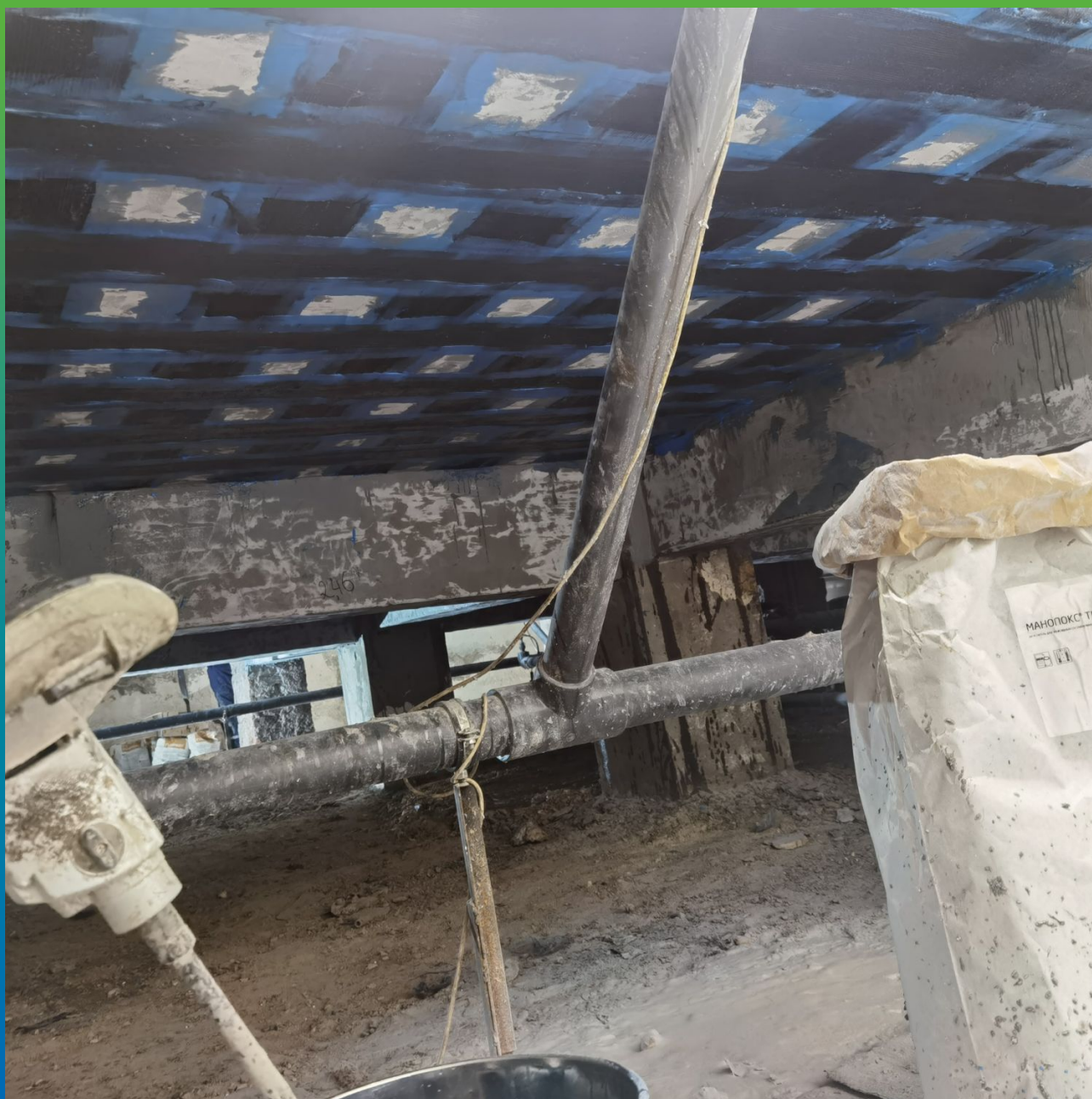
Общий вид после проведения работ по монтажу КСУ
