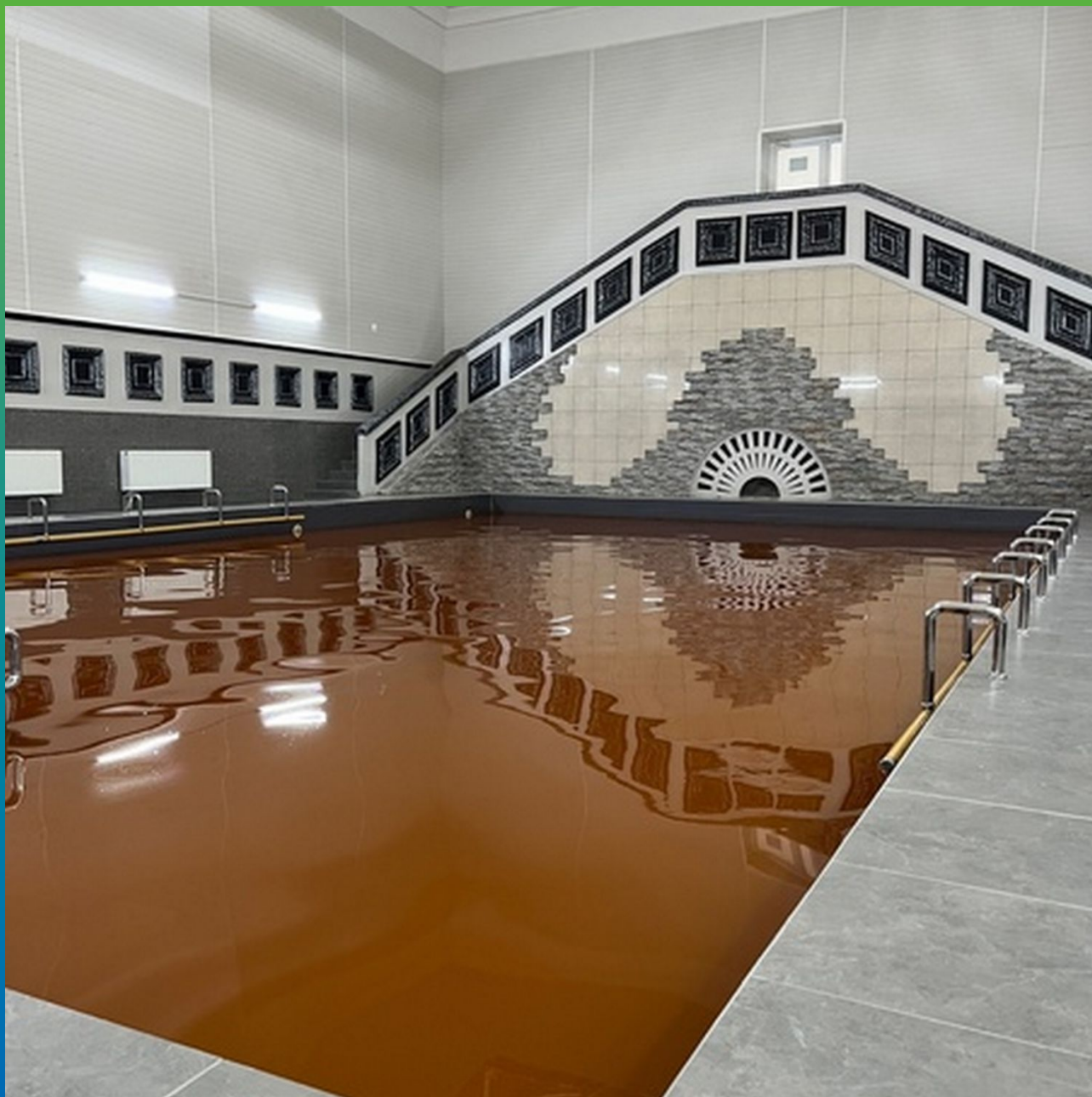
Общий вид чаши бассейна бальнеолечебницы после ремонта
