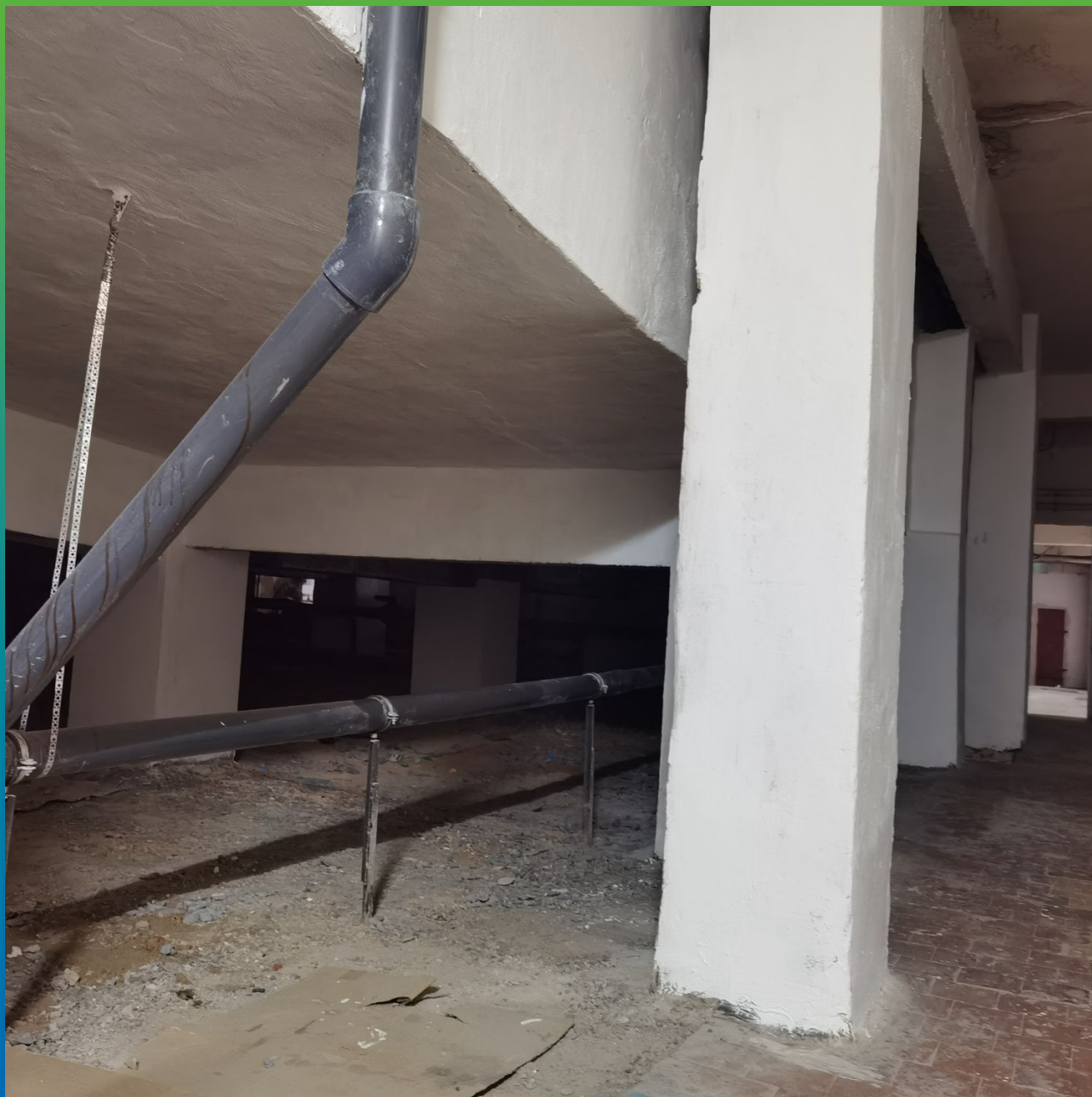
Общий вид объекта после проведения всех работ на объекте, техническое помещение
