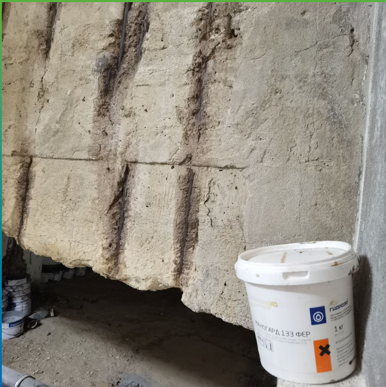
Обработка арматуры пассиватором коррозии Маногард 133 Фер
