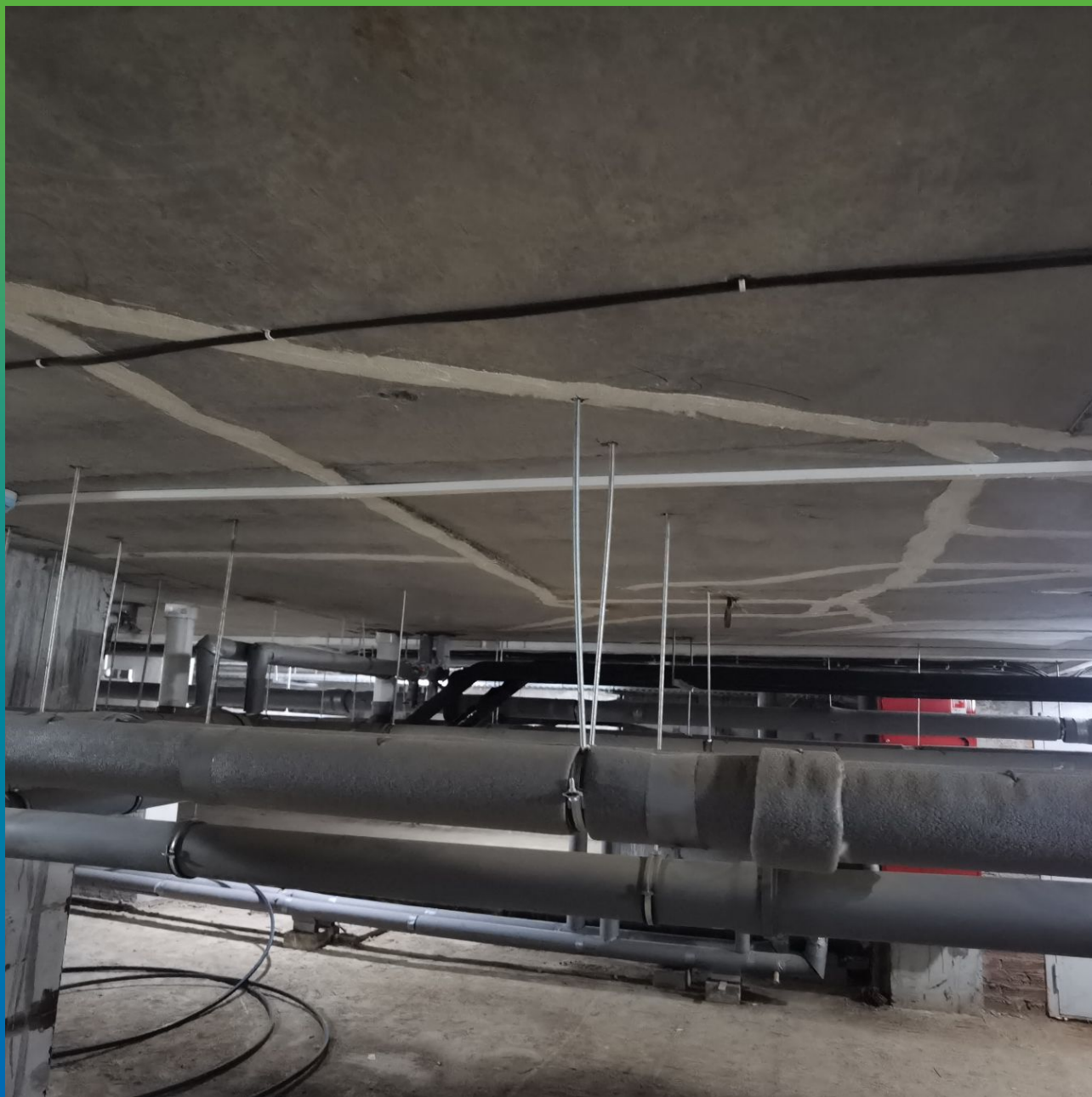
Ремонт трещин составом Манопокс 331
