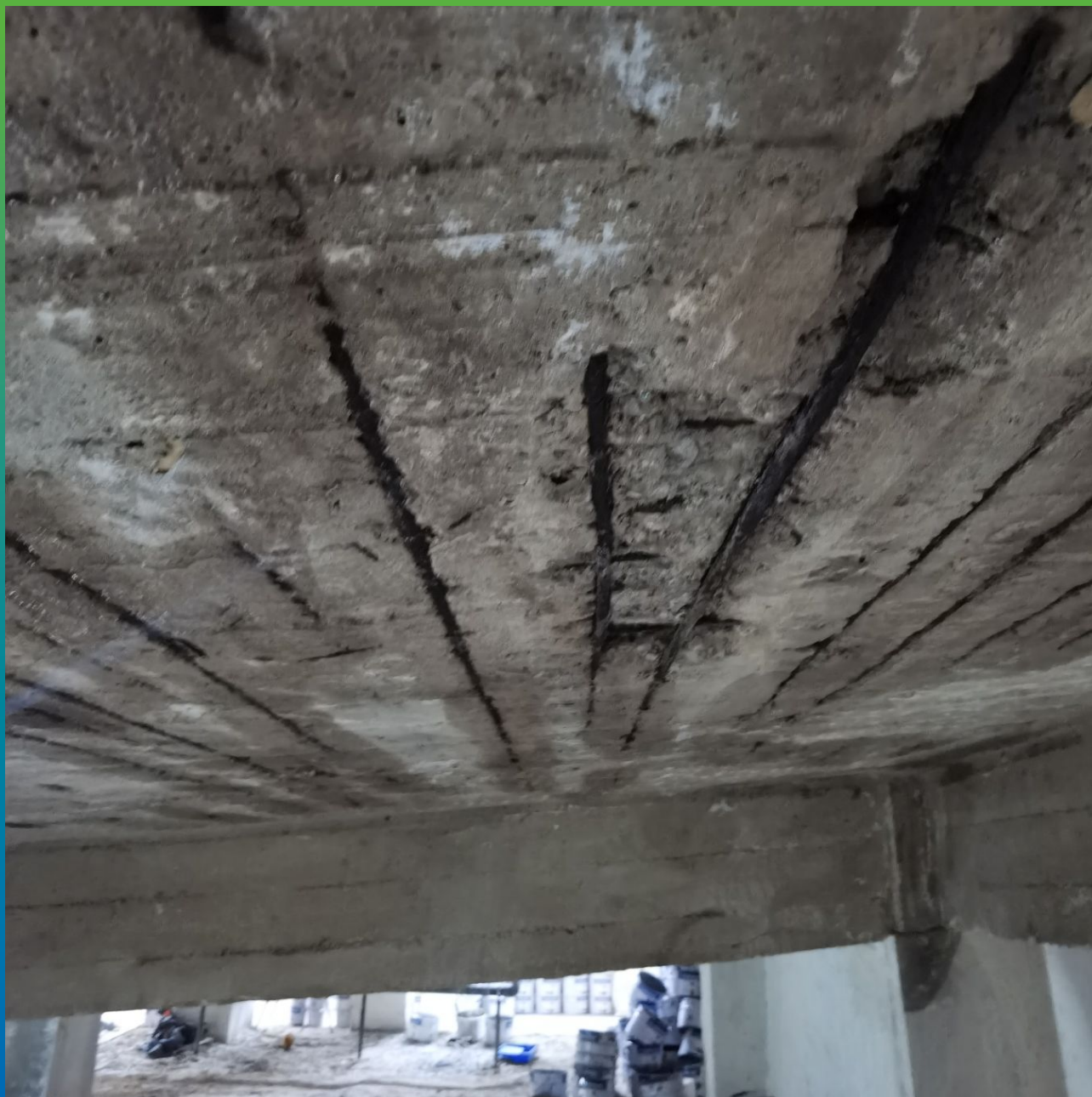
Подготовка поверхности к работам по усилению, отбивка рыхлого бетона
