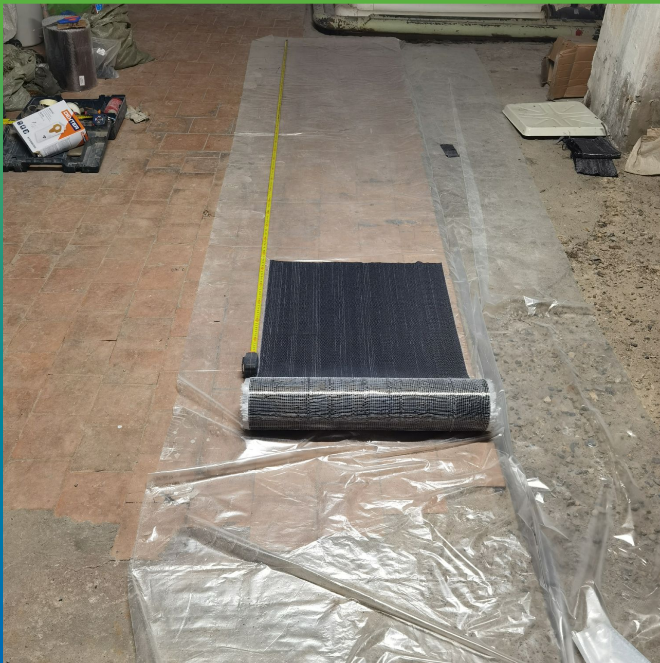
Раскрой Армошел KB 500 согласно проекту усиления
