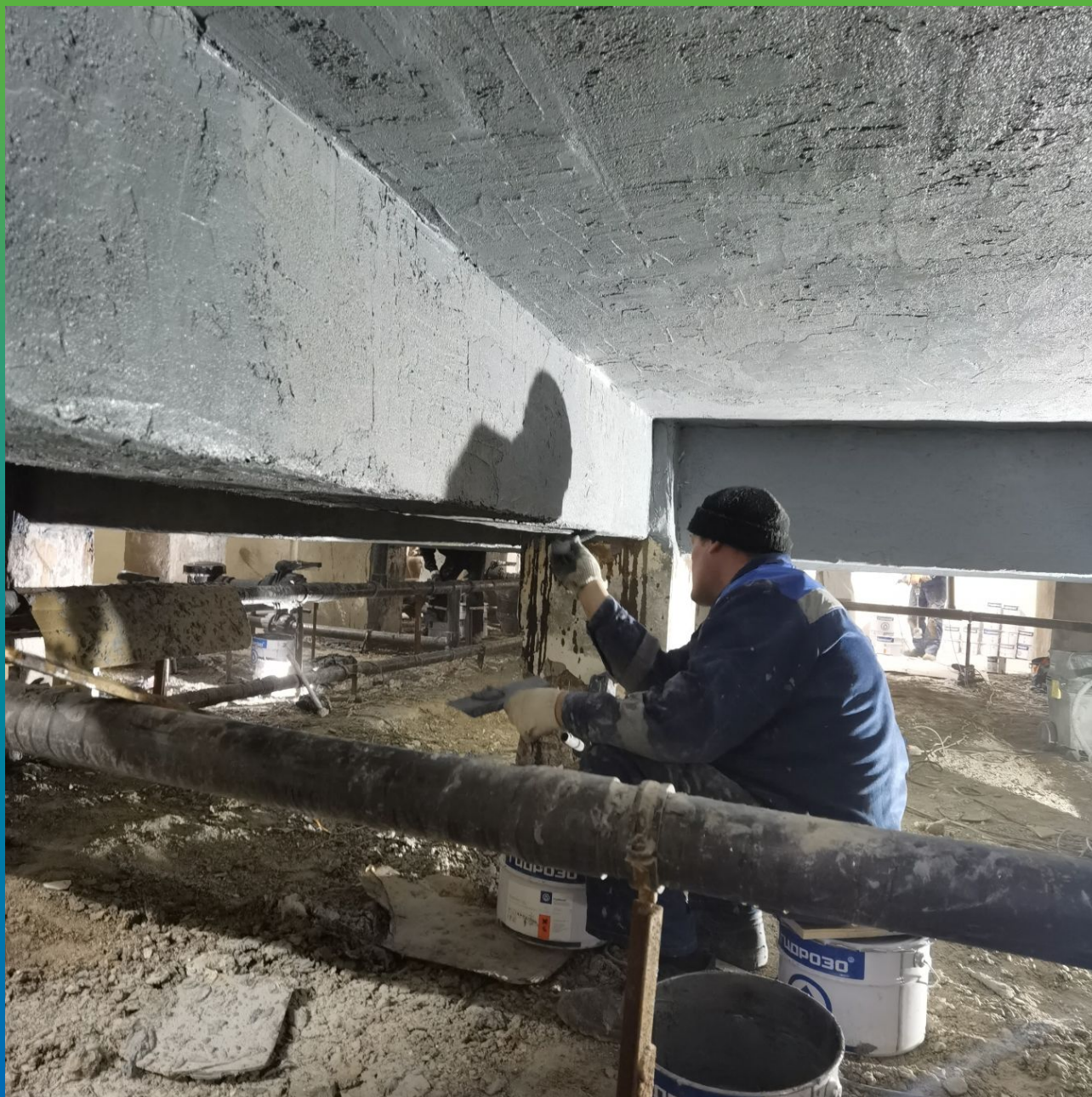
Ремонт балок эпоксидным составом Манопокс 331
