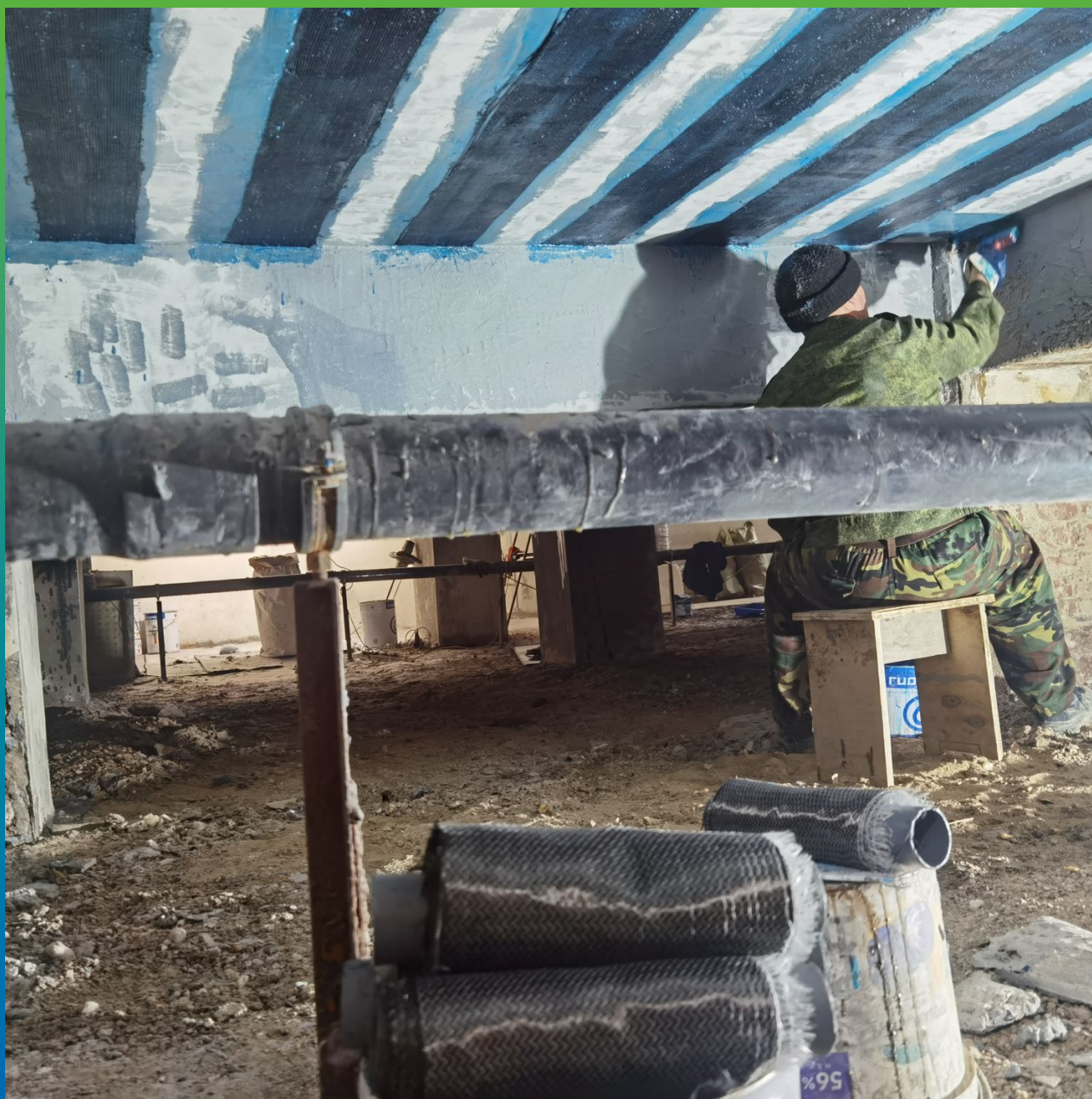
Монтаж системы усиления на конструкцию
