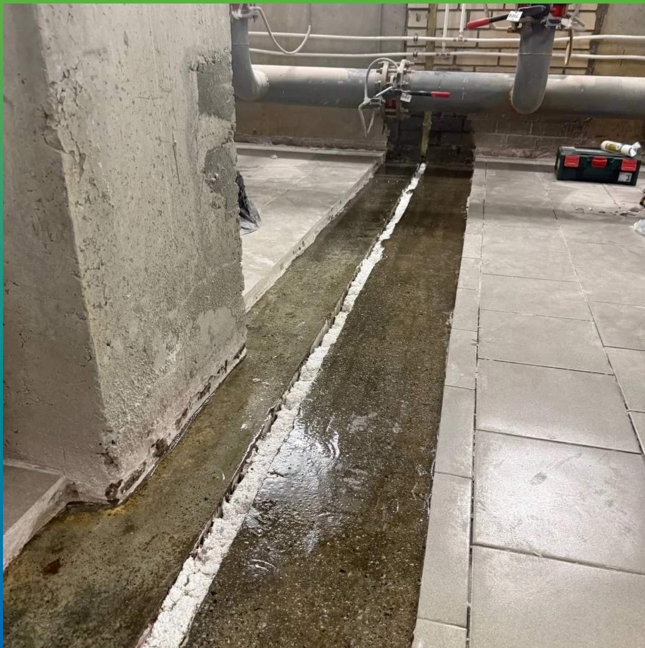
Вид загрунтованного деформационного шва с помощью ДенсТоп ЭП 106
