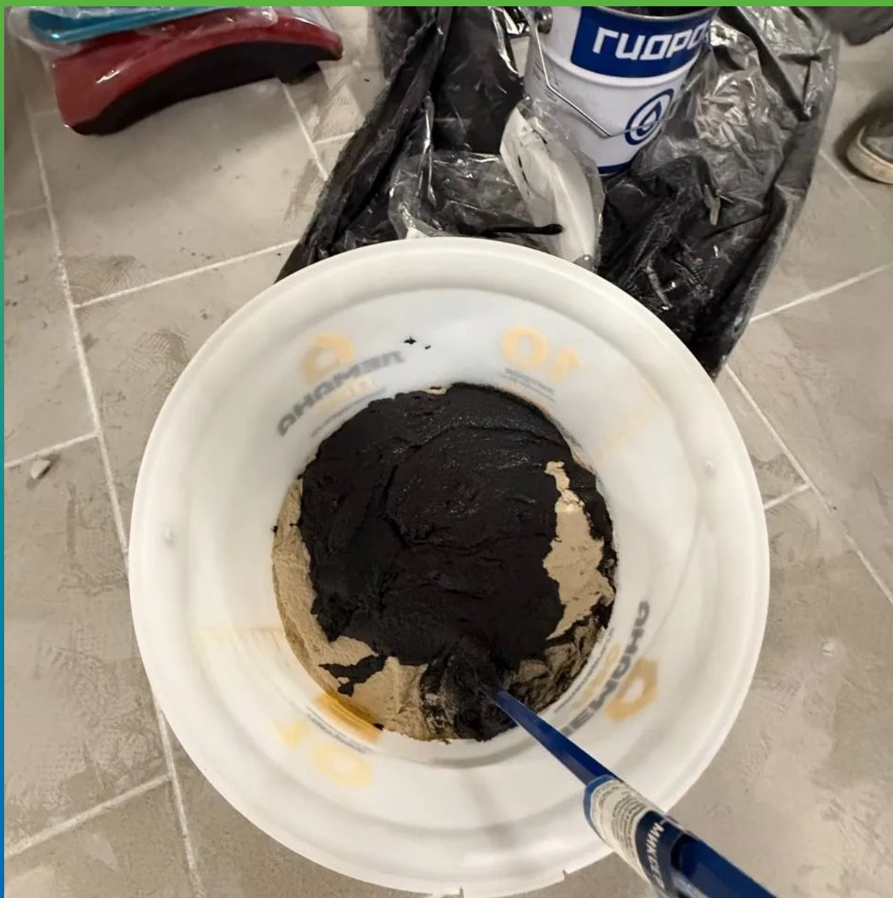
Затворение эпоксидного клея Манопокс 331
