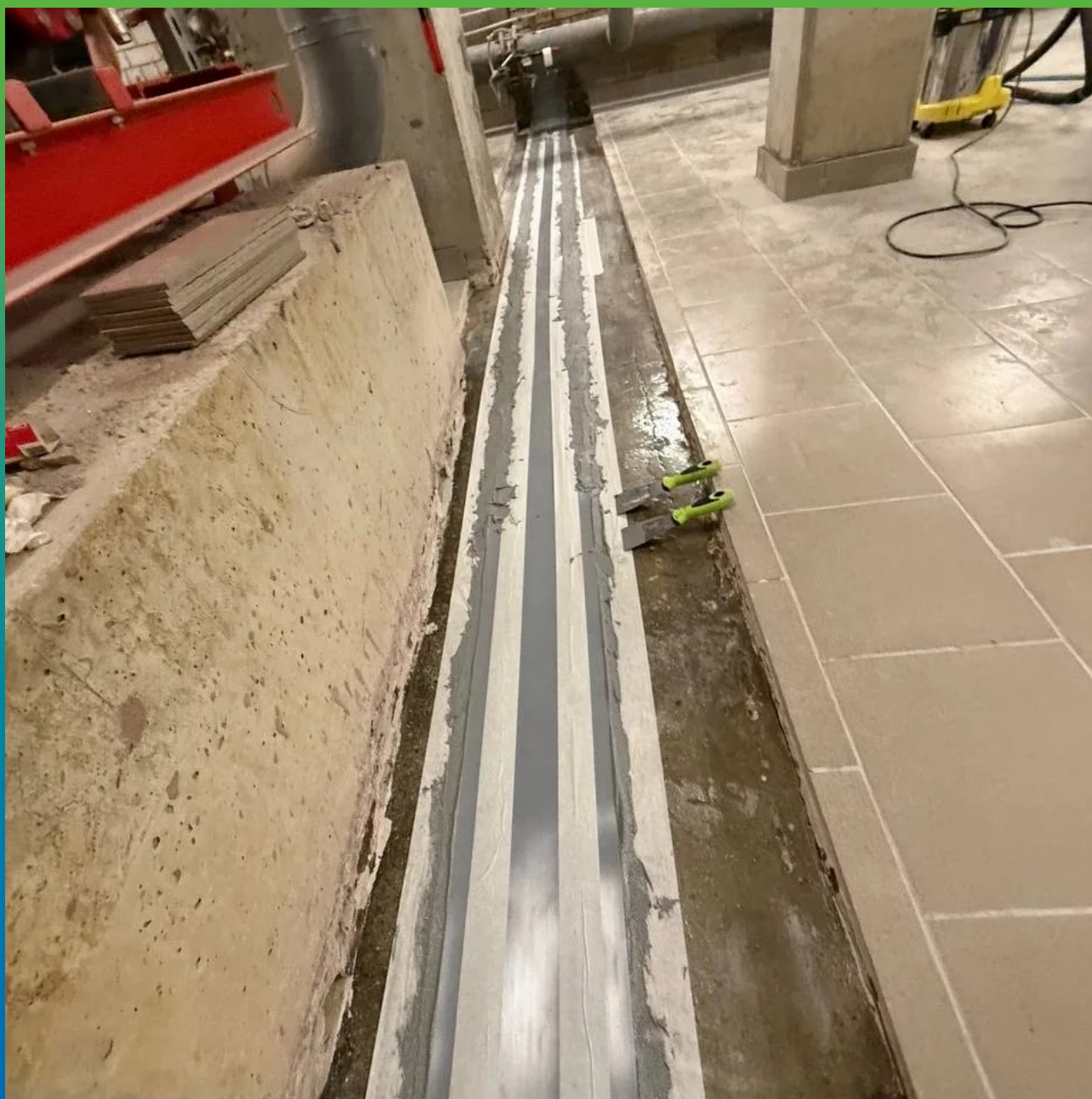
Монтаж ленты Манодил Про на эпоксидный клей Манопокс 331
