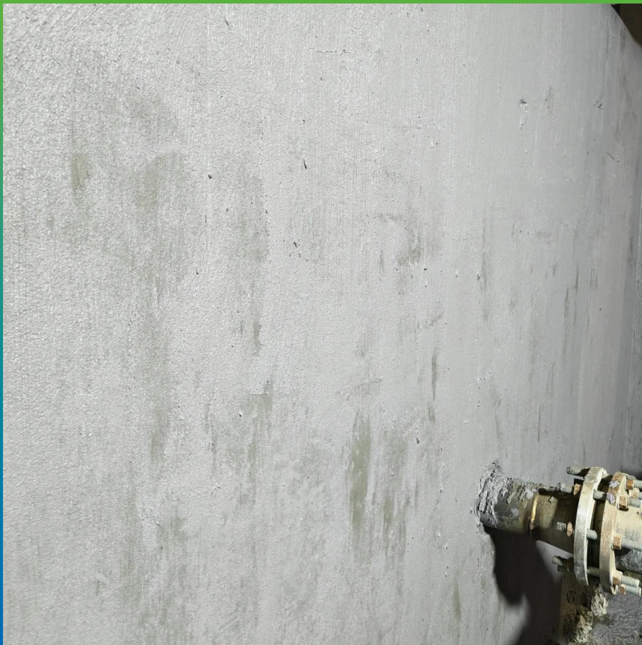
Нанесенный 1 слой эластичной гидроизоляции Стармекс Сил Флекс
