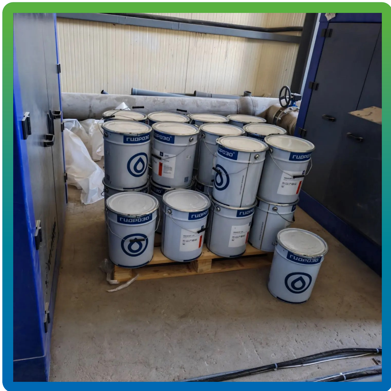
Материалы ООО "Гидрозо" на объекте
