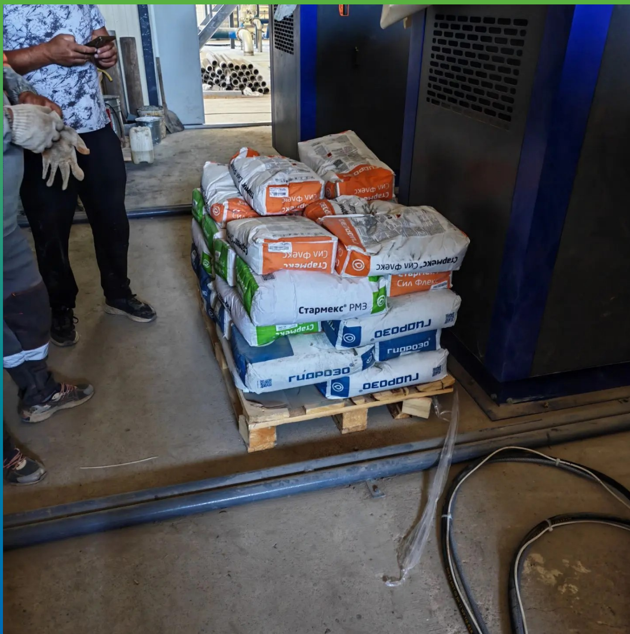
Материалы ООО "Гидрозо" на объекте
