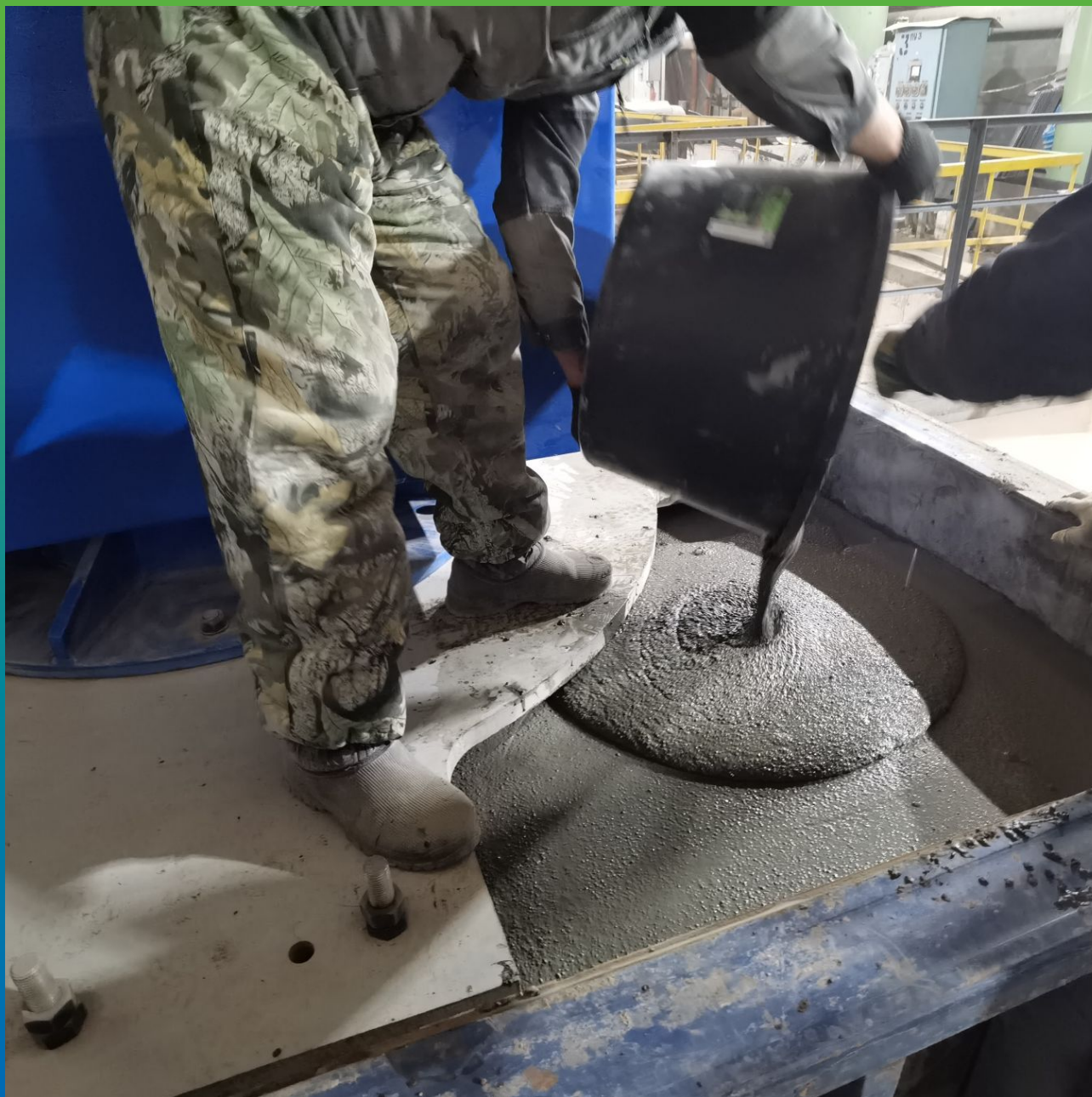
Заливка Стармекс ФМ7 в смеси с наполнителем
