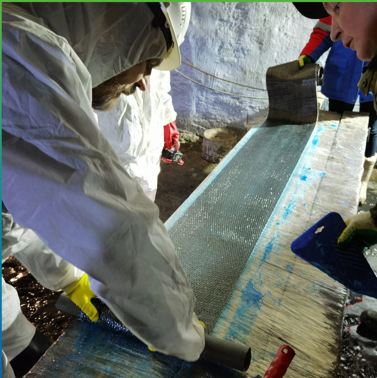
Раскрой холста Армошел KB900 и его пропитка эпоксидным составом Манопокс 372
