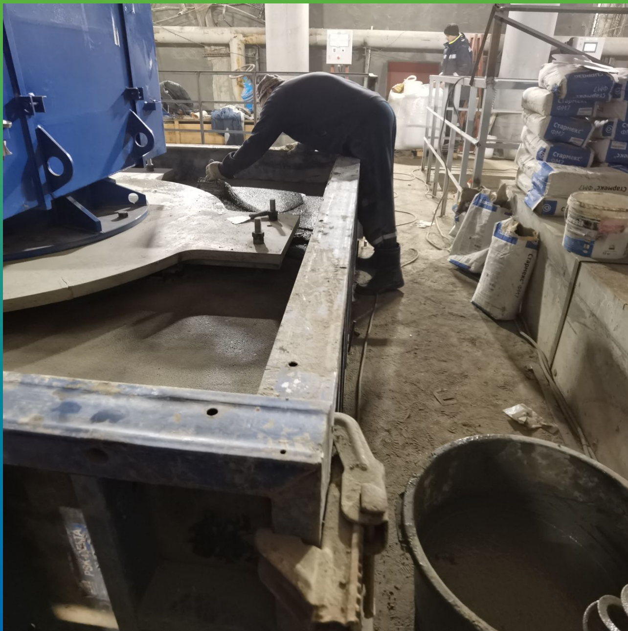
Распределение смеси Стармекс ФМ7 равномерным слоем
