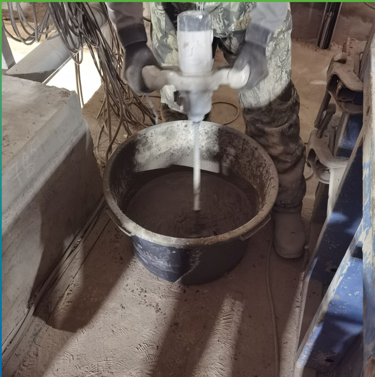
Этап № 6. Подготовка к заливке фундаментов насосов состава Стармекс ФМ7 в смеси с песком
