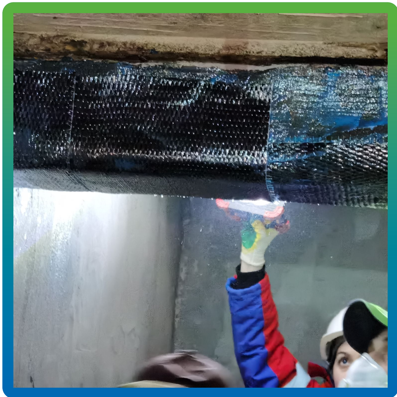
Контроль качества нанесения системы ФАП на строительной площадке
