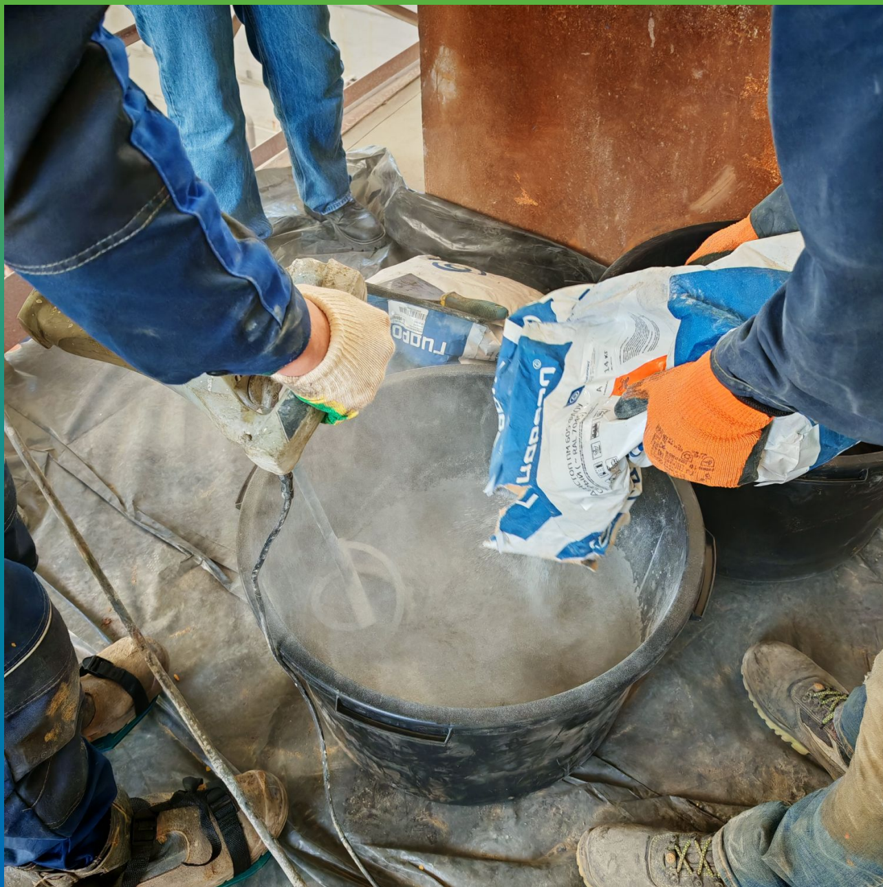
Перемешивание 3-х компонентов ДенсТоп ПМ 605 Флоу
