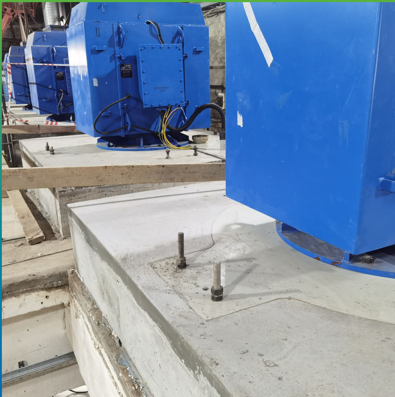
Вид фундаментов после набора прочности, подготовка к нанесению защитного состава ДенсТоп ПУ 302
