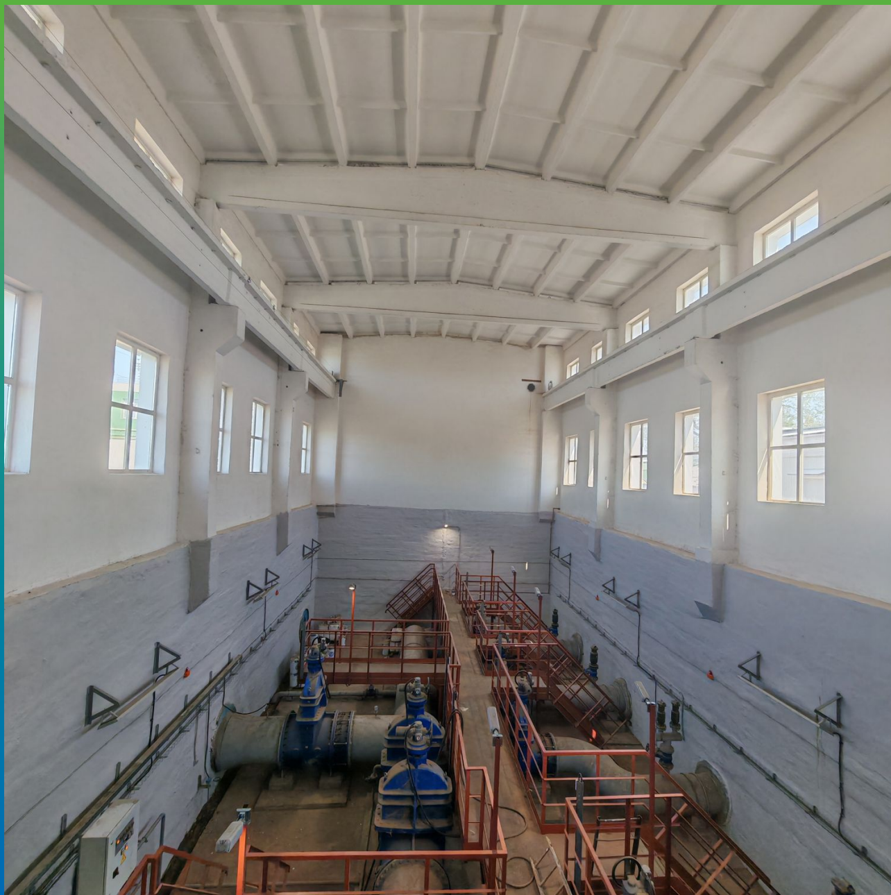
Общий вид после проведения работ по декоративной окраске
