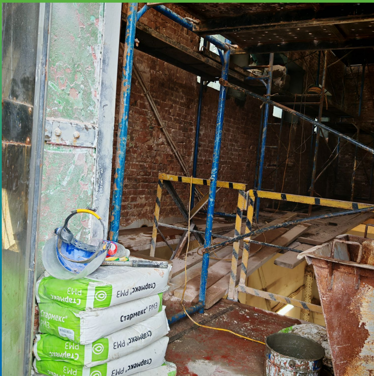
Этап № 2 Ремонт внутренних стен ремонтным составом Стармекс PM3
