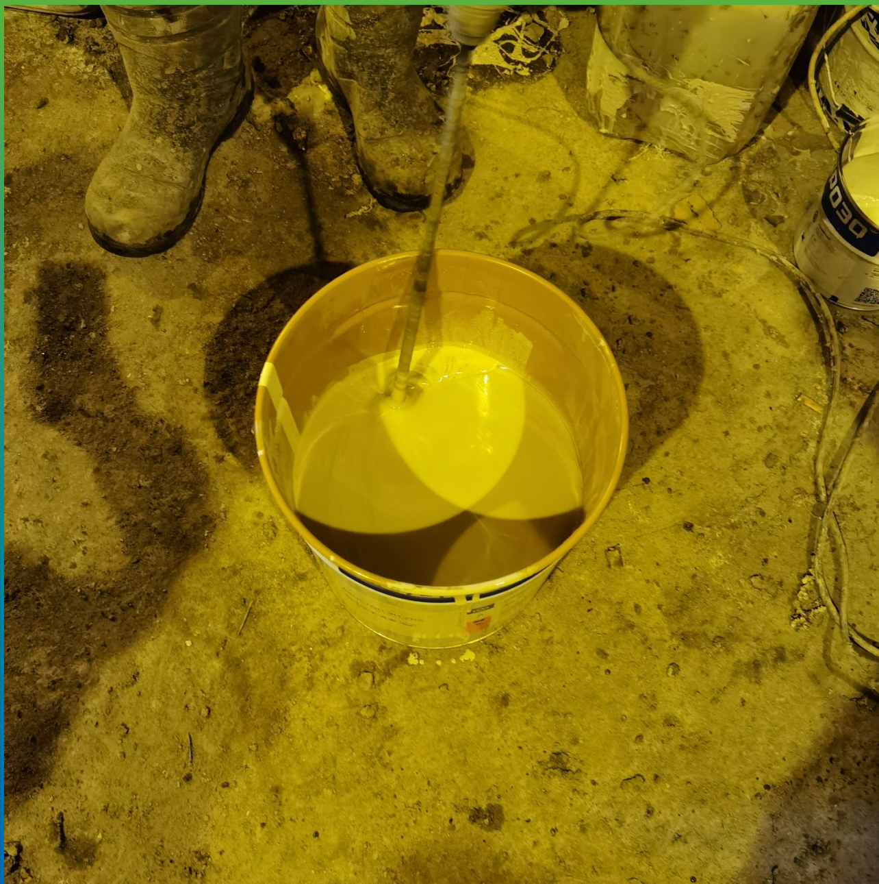
Подготовка к нанесению ДенсТоп ЭП 205
