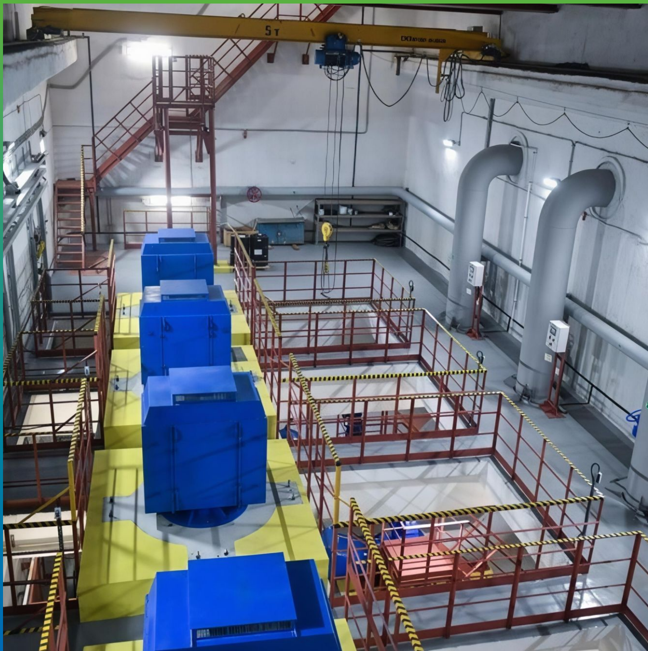
Грабельное отделение после проведения всех работ
