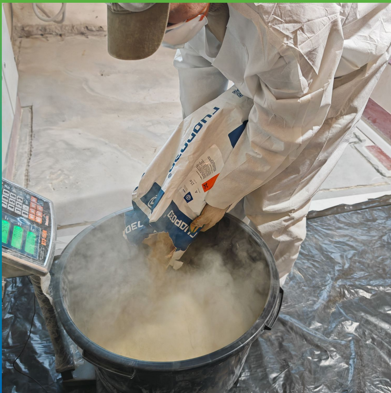
Подготовка к укладке грунта ДенТоп ПМ 601
