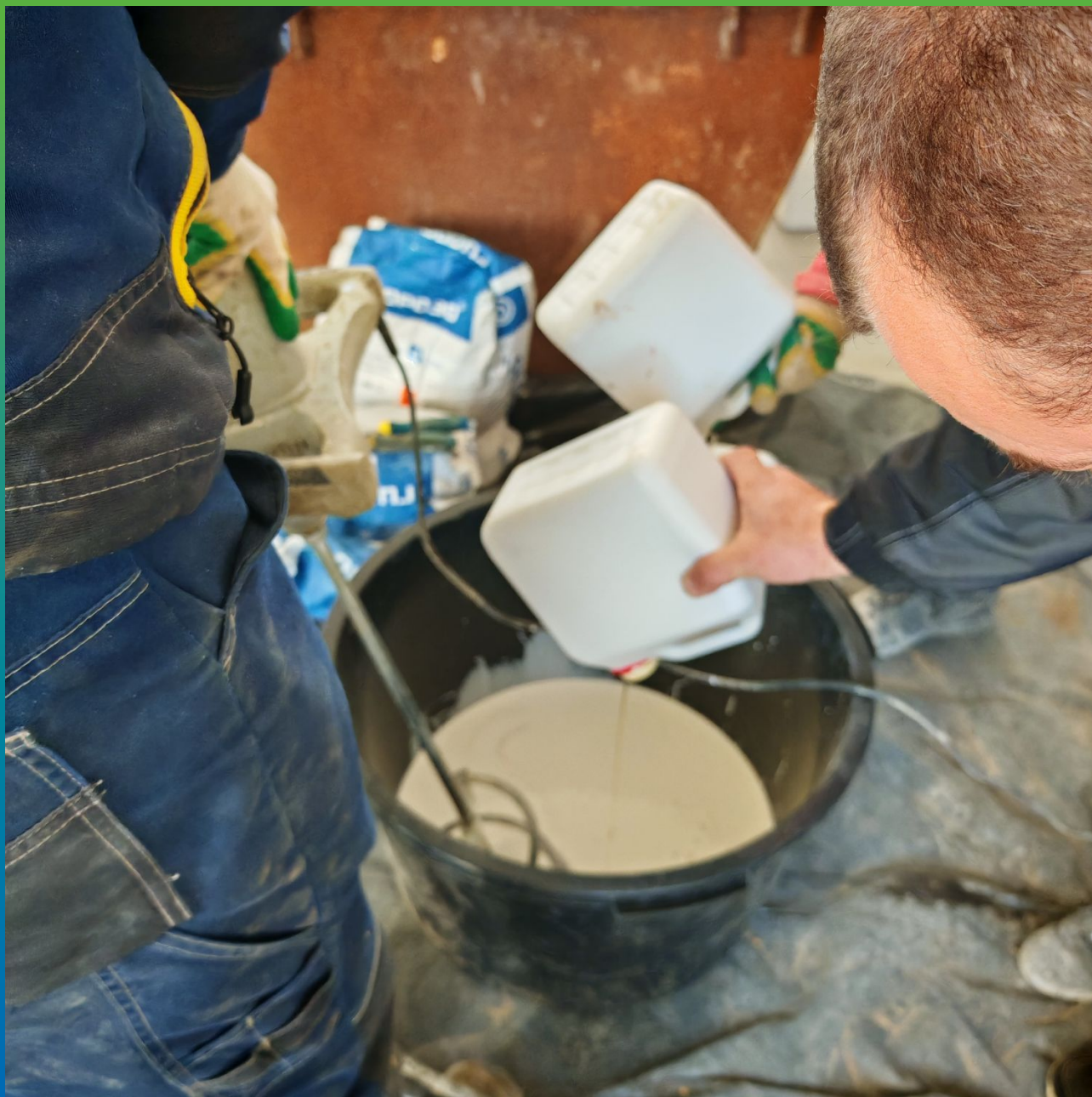
Подготовка к нанесению ДенсТоп ПМ 605 Флоу
