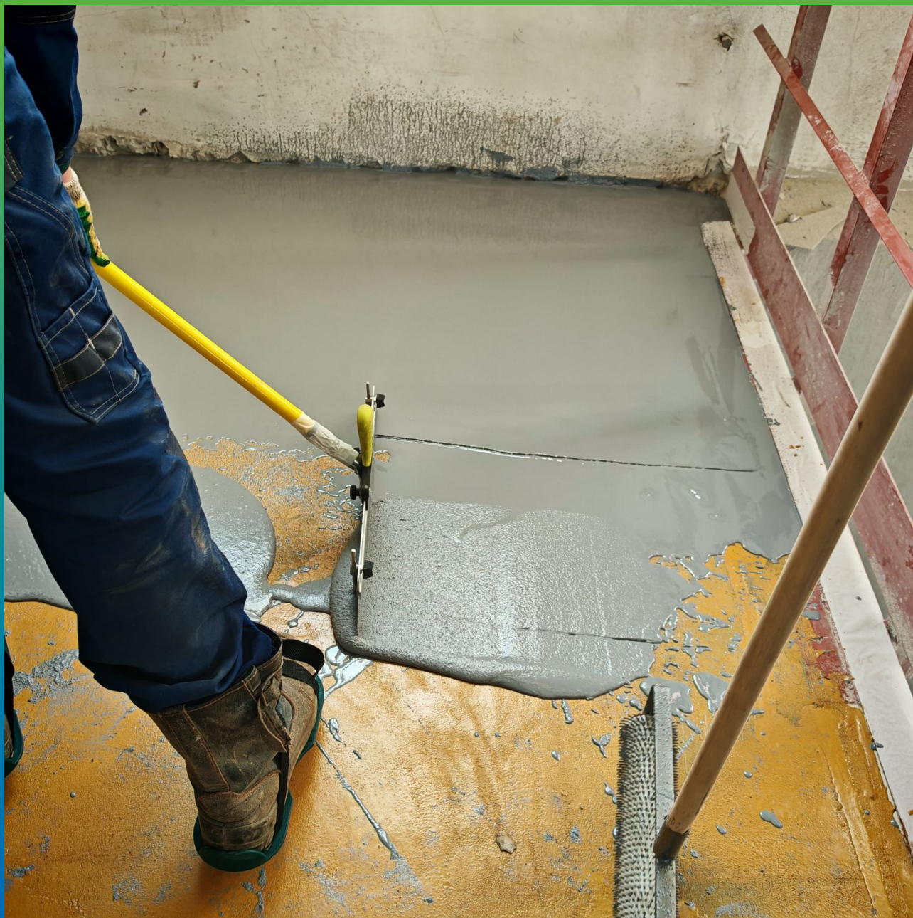
Укладка ДенсТоп ПМ 605 Флоу слоем 5 мм
