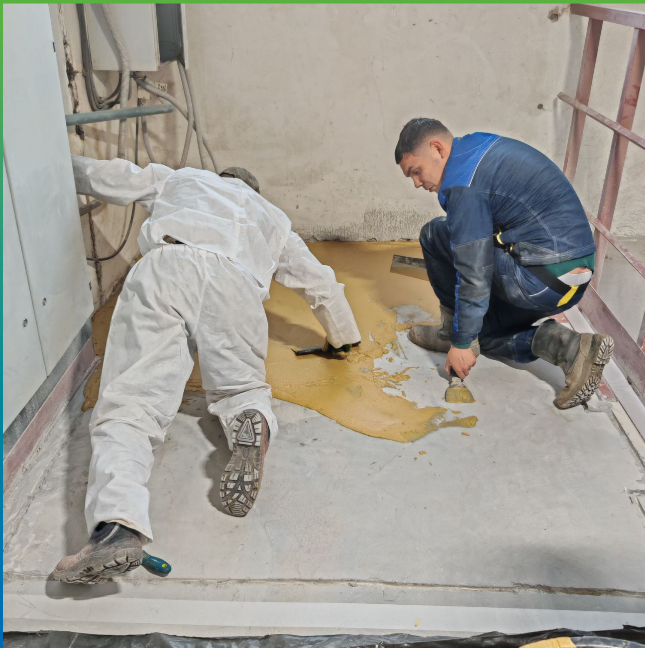
Нанесение грунтовки ДенсТоп ПМ 601 на сдир
