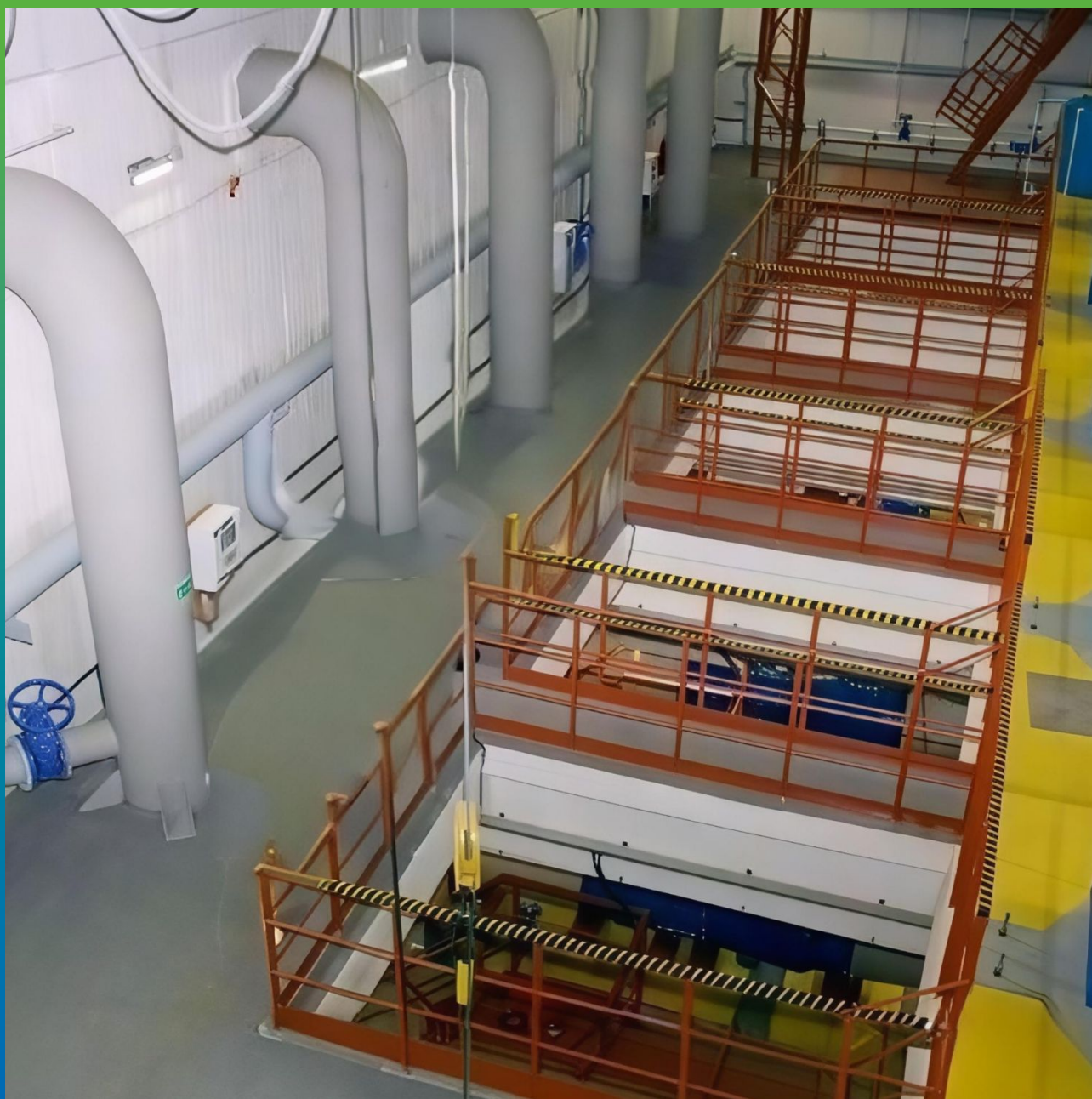
Общий вид перед приёмкой работ
