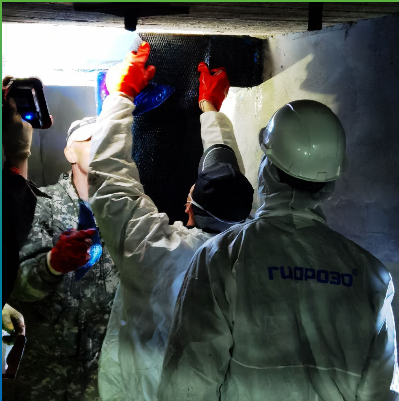
Монтаж пропитанного холста Армошел KB900 на ж/б конструкцию
