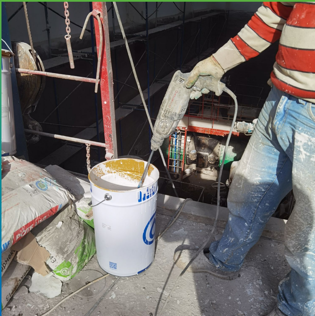
Этап № 5. Подготовка к нанесению окрасочных декоративных материалов
