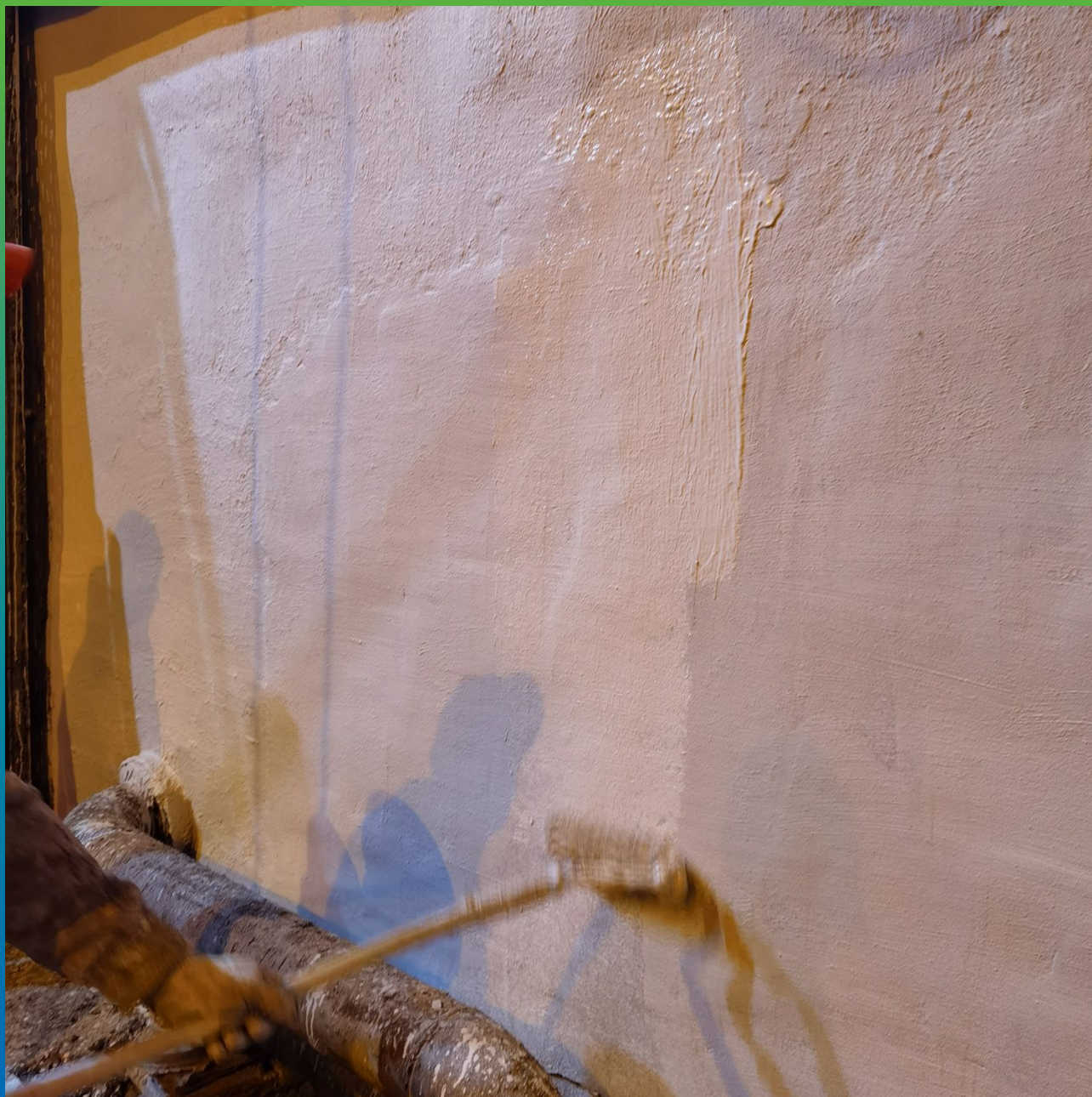
Нанесение 1 слоя ДенсТоп ЭП 205
