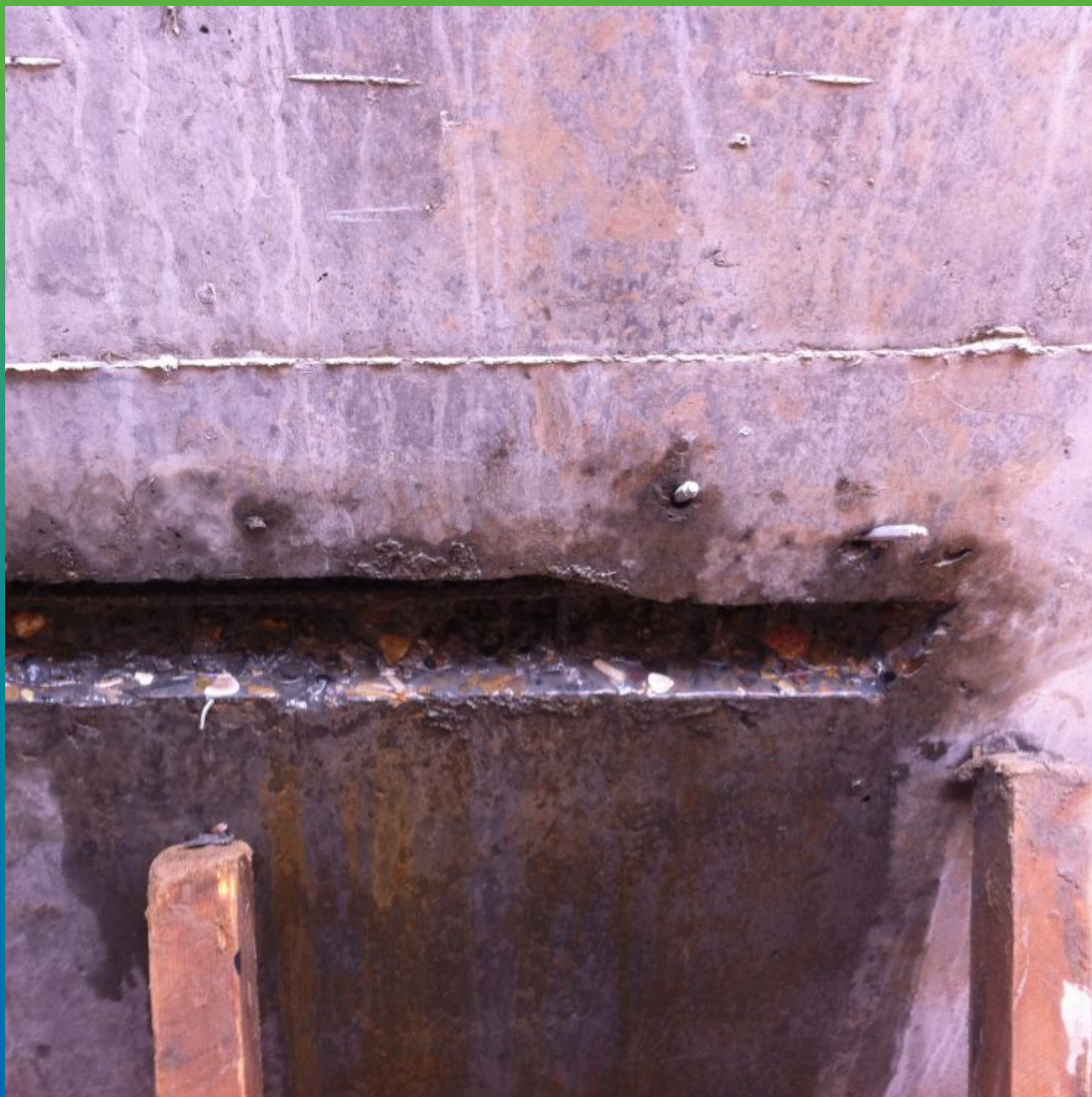
Расшивка плохо провибрированного участка и установка пакеров
