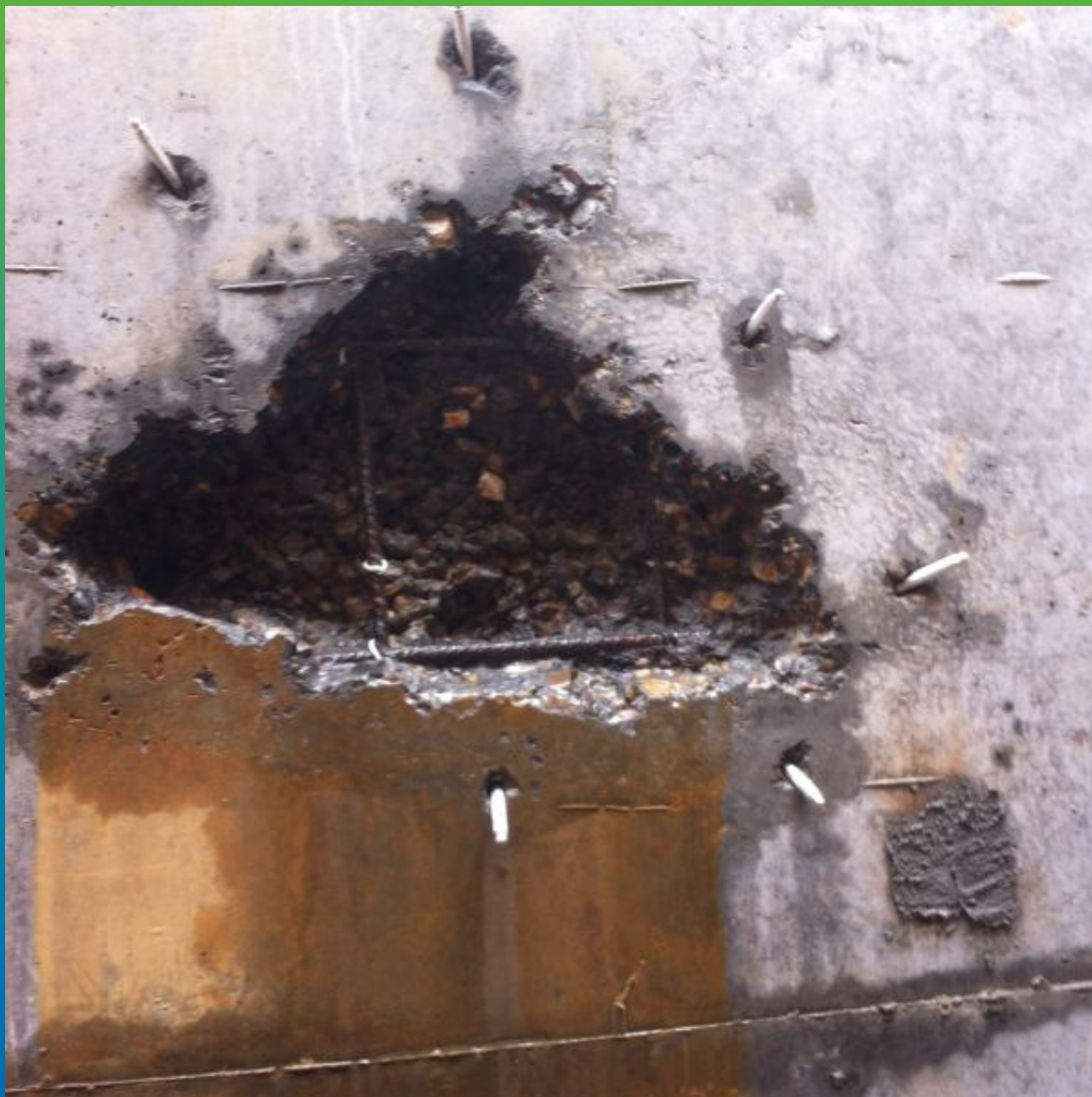
Расшивка плохо провибрированного участка и установка пакеров
