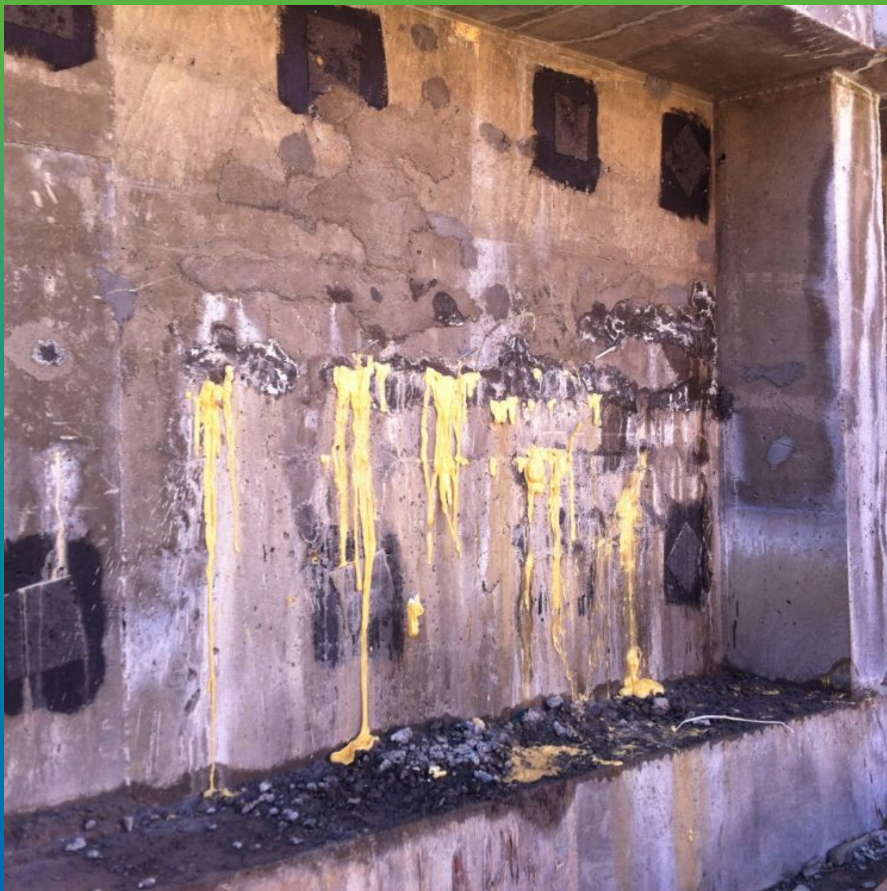
Вид стены градирни после инъектирования Витрапур Фоам Флекс
