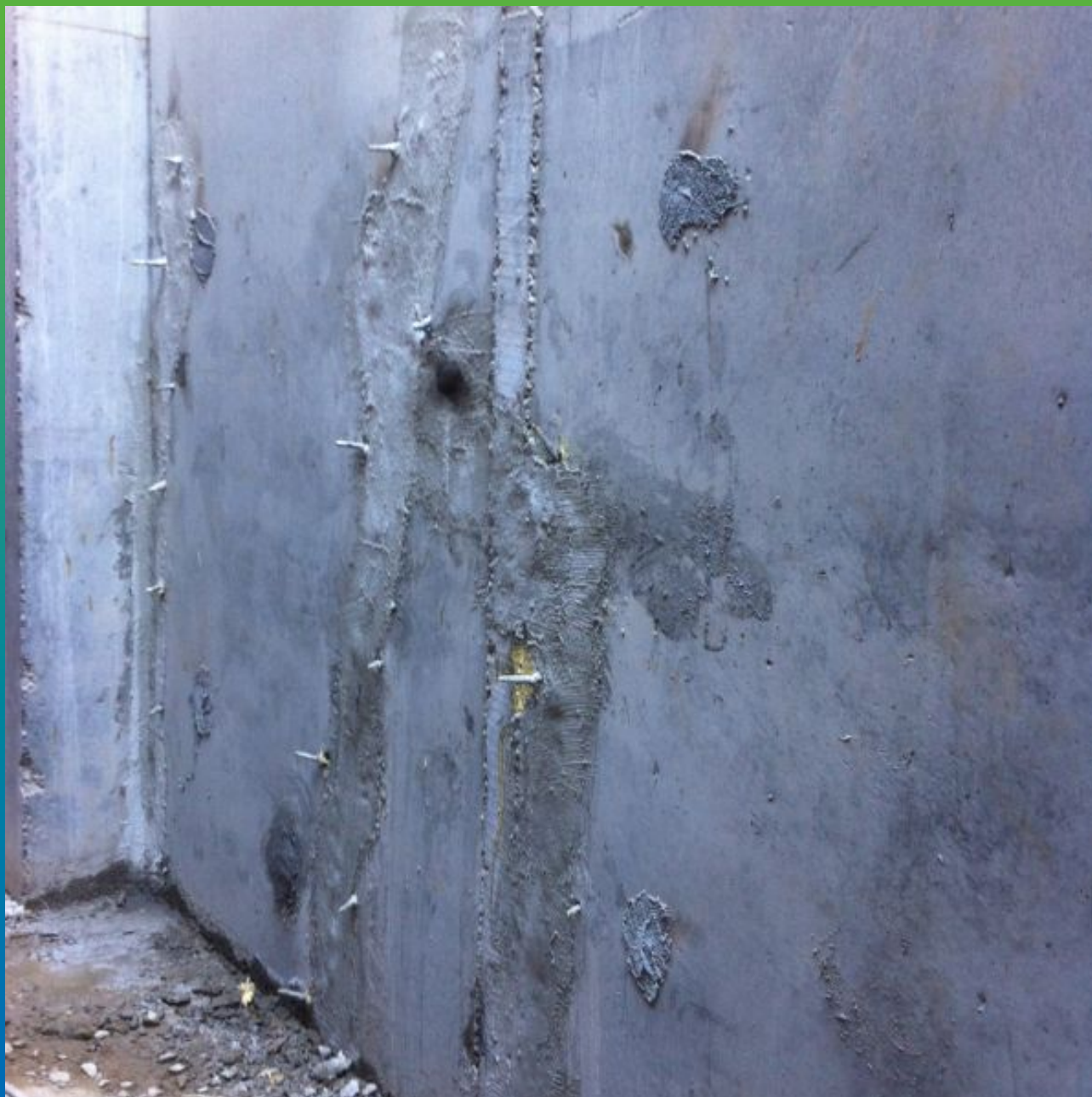
Вид трещин после инъектирования Витрапур Фоам Флекс
