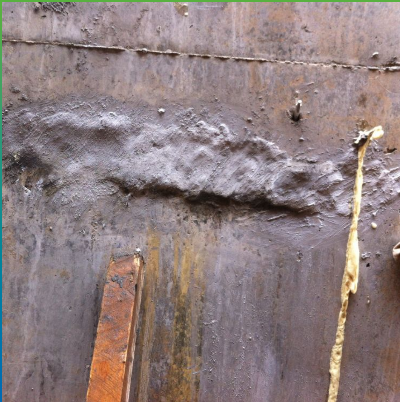
Инъектирование составом Витрапур Фоам Флекс
