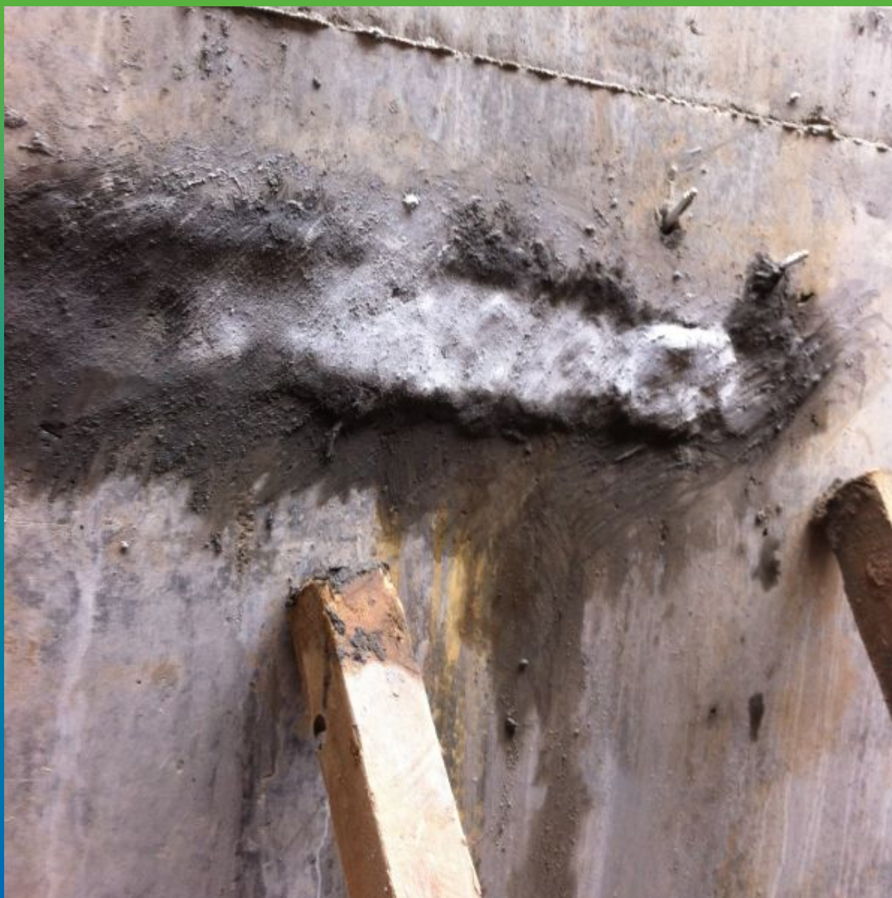
Зачеканка расшитых участков составом Максплаг
