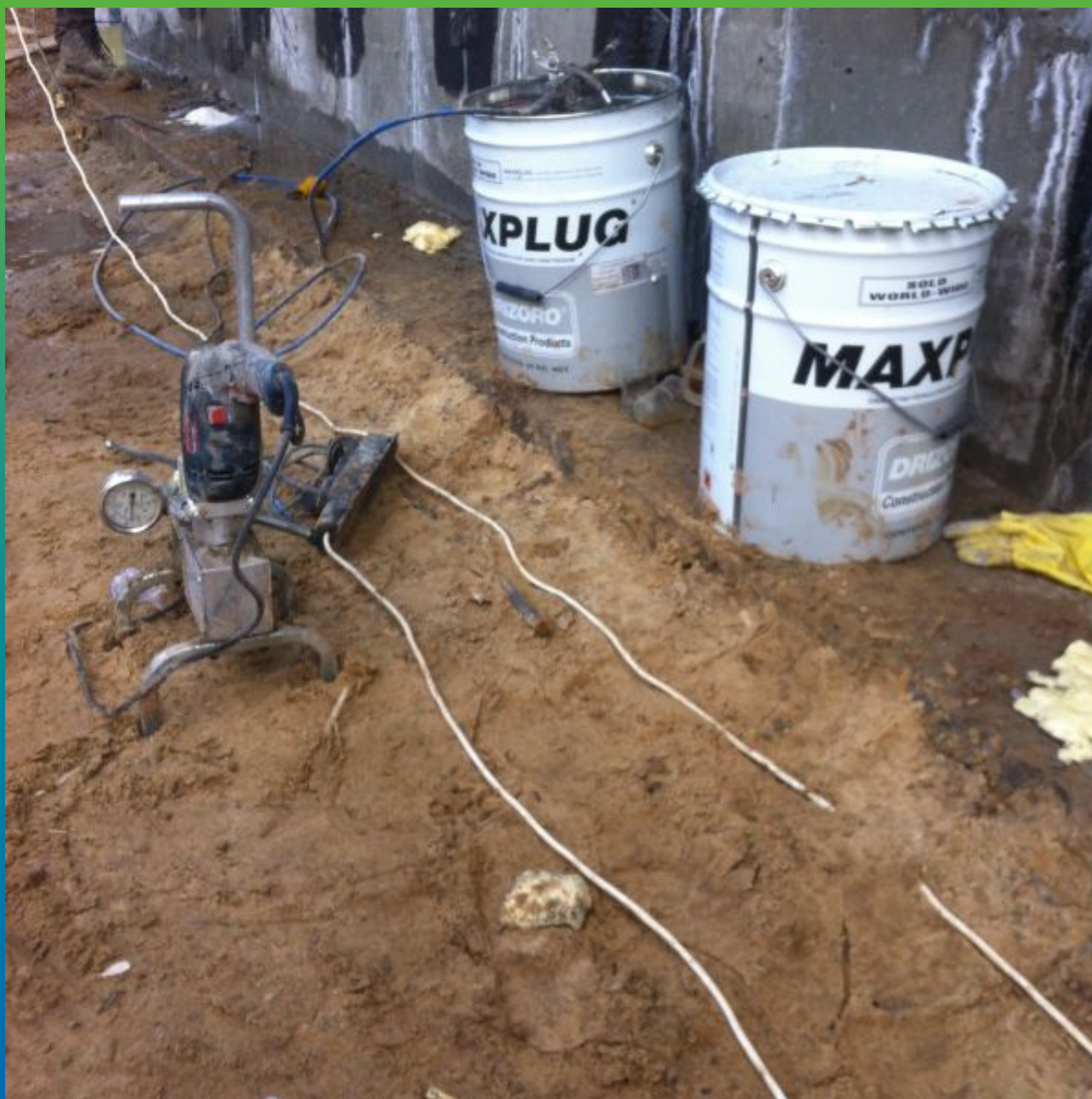
Инъектирование "Холодных швов" гидроактивным полиуретаном Манопур У
