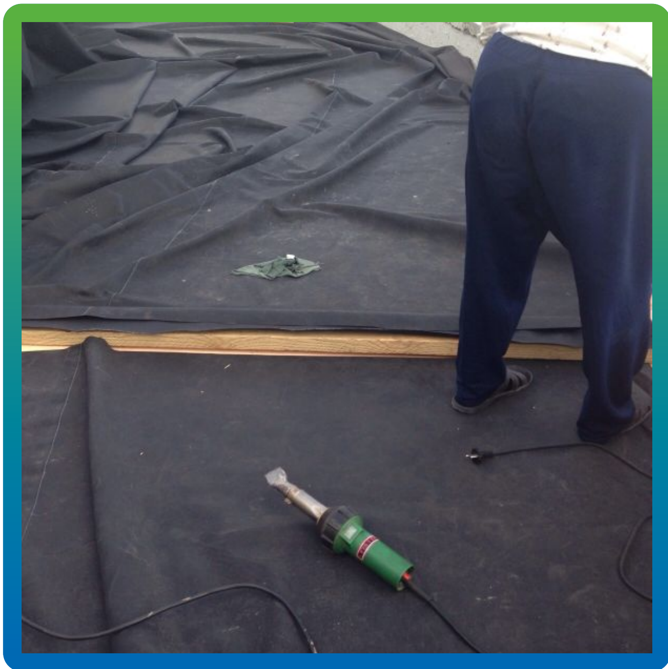
Сварка полотен между собой
