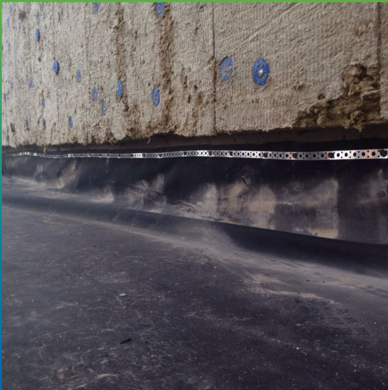
Крепление ЭПДМ мембраны к парапету
