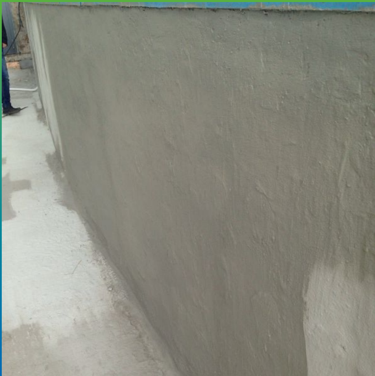
Терраса, покрытая полимерцементной гидроизоляцией Максил Флекс, по сетке, в 2 слоя
