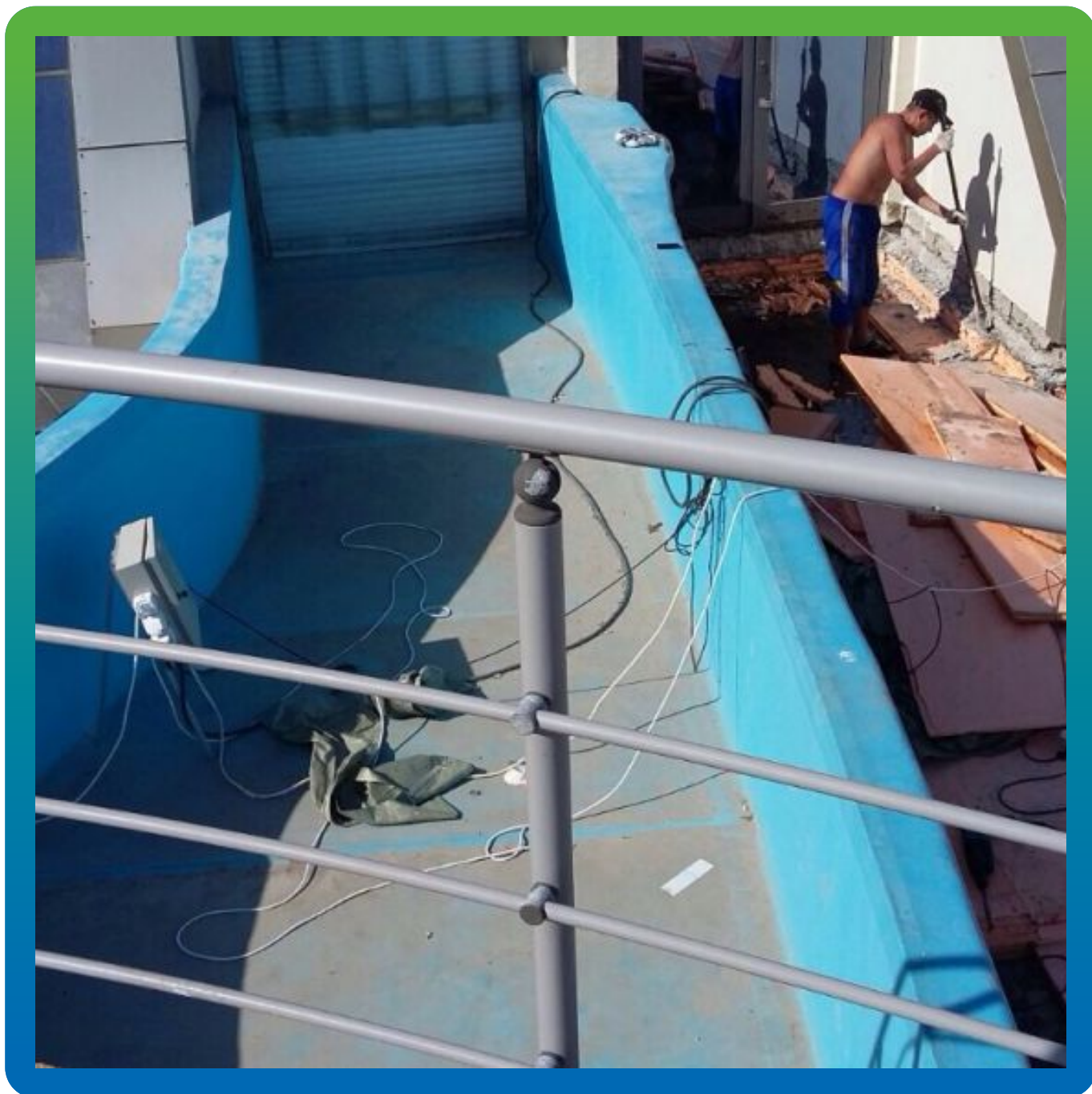
Демонтаж существующей стяжки
