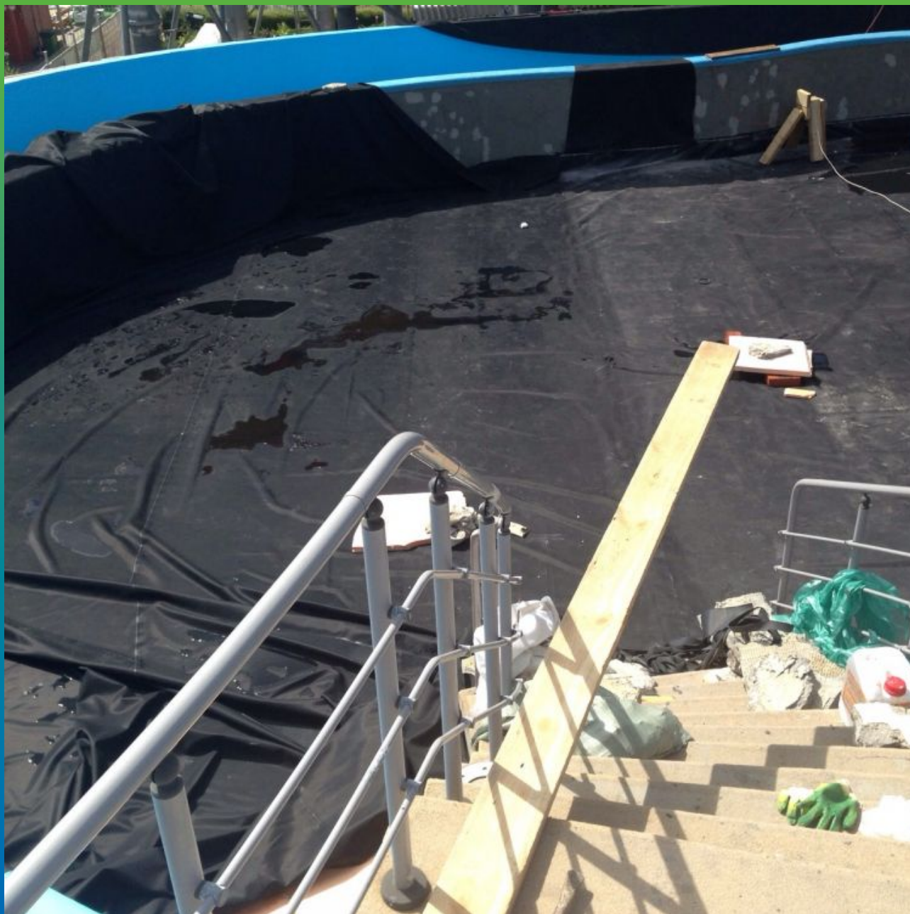
Расстилка ЭПДМ мембраны Эластосил Т
