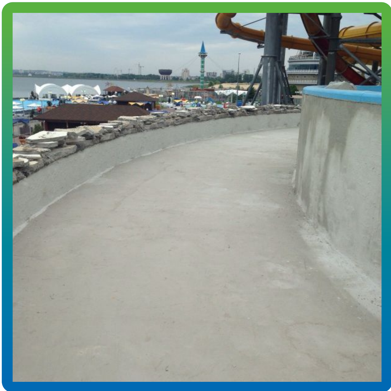
Бетонная стяжка по мембране
