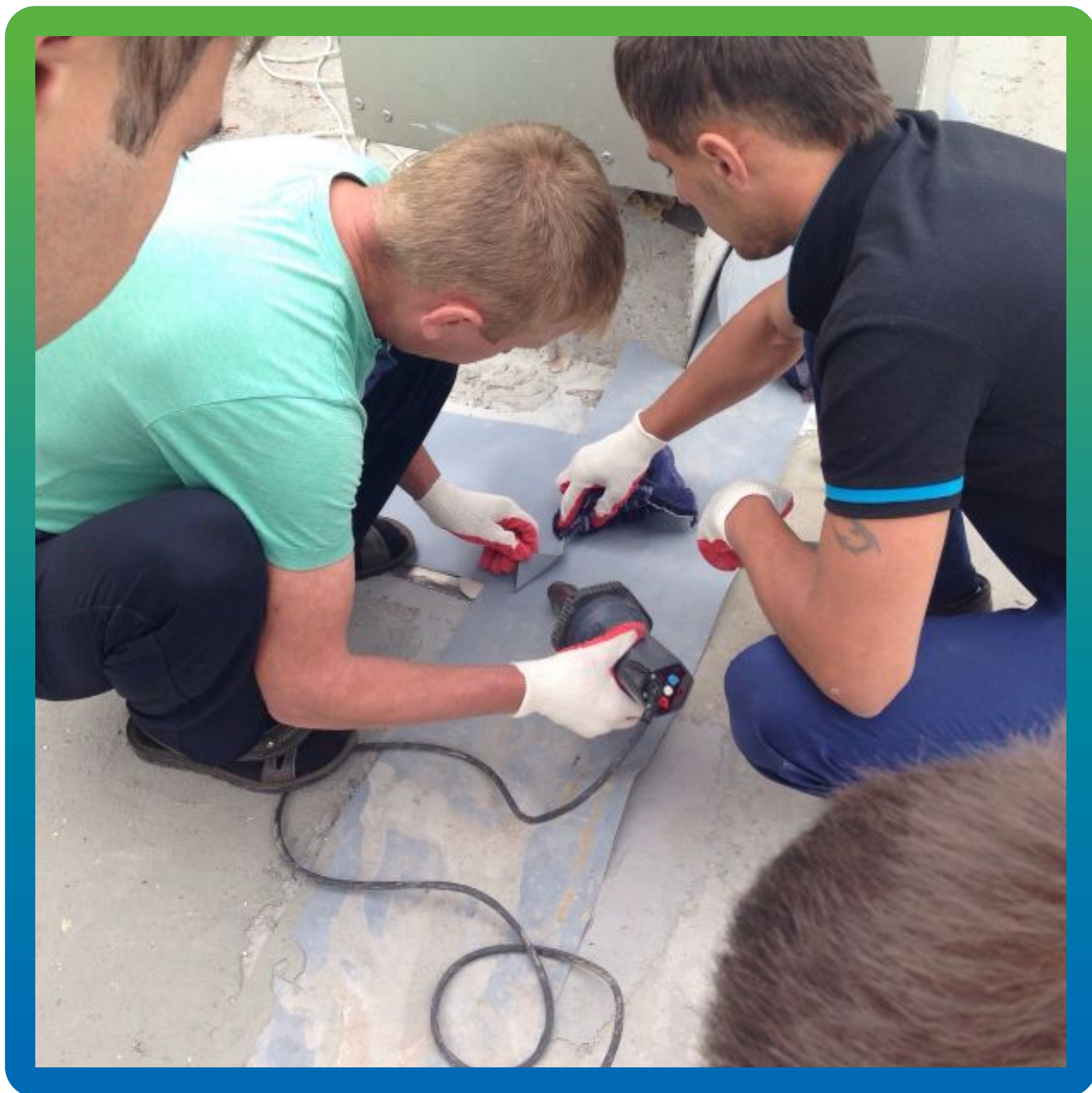
Гидроизоляция деф. шва системой Манодил Про
