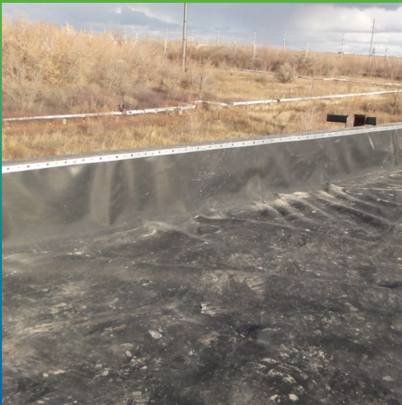
Устройство парапета
