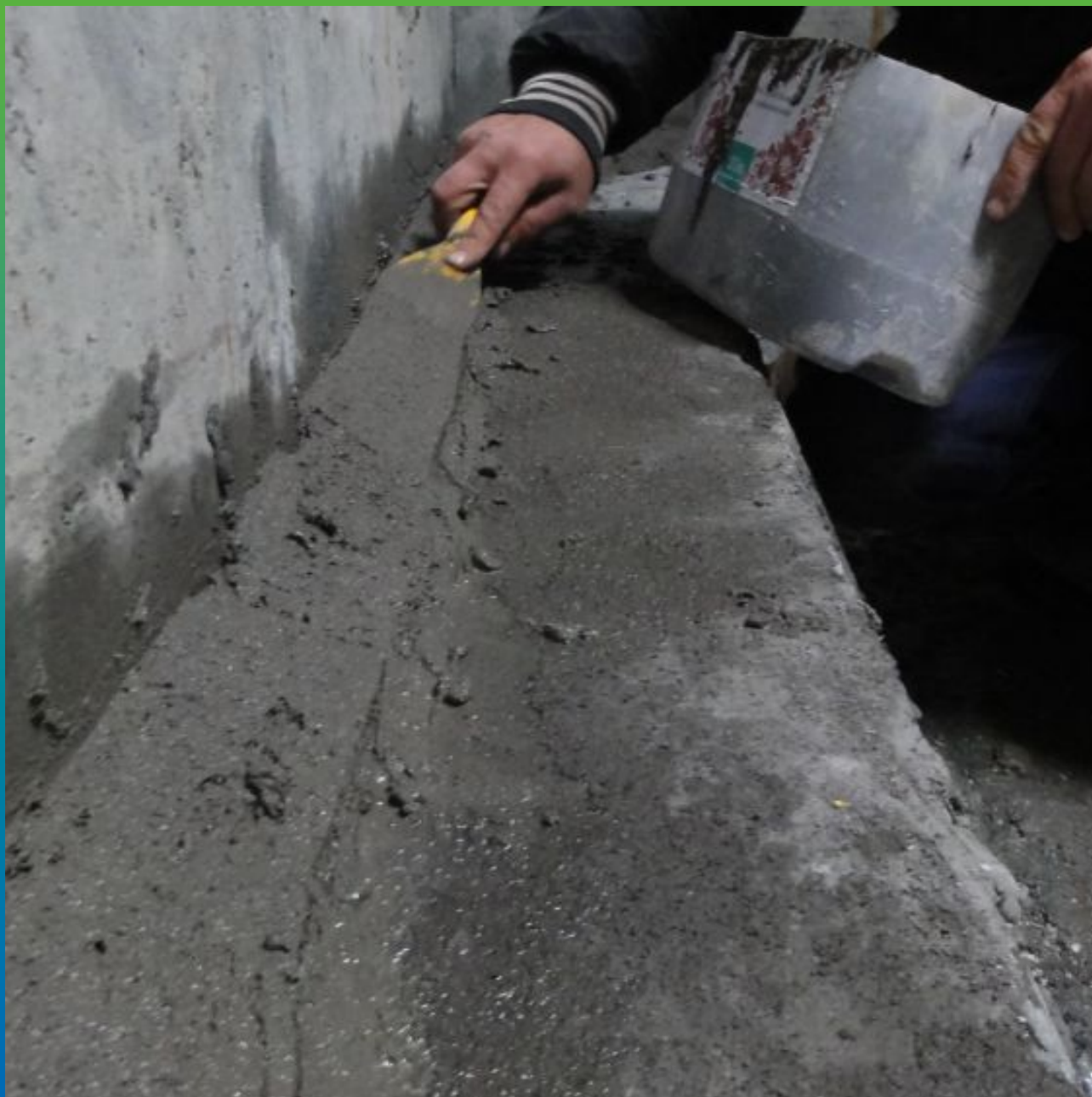
Устройство галтели с помощью Стармекс РМ 3
