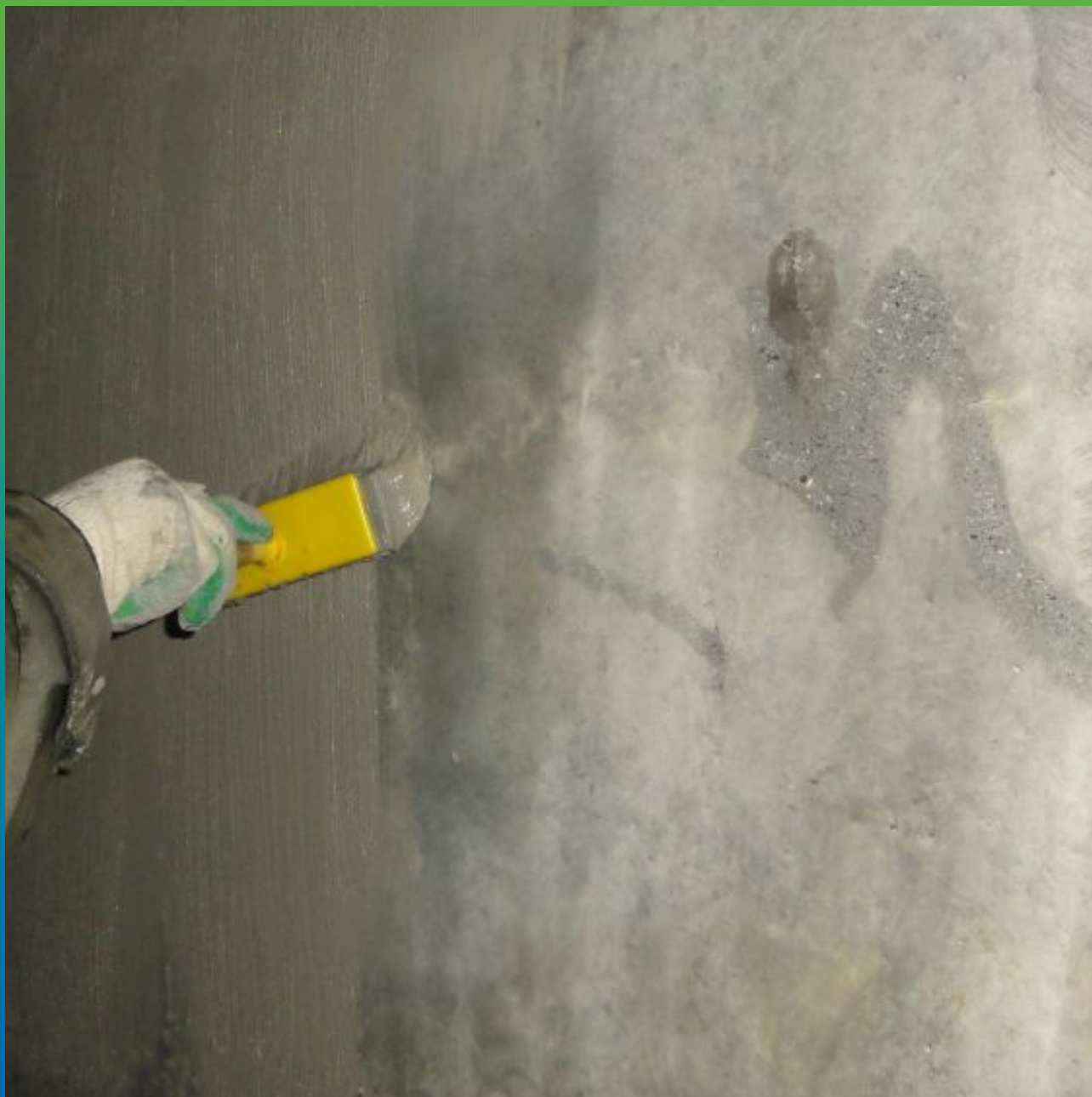
Нанесение обмазочного остатка Макссил
