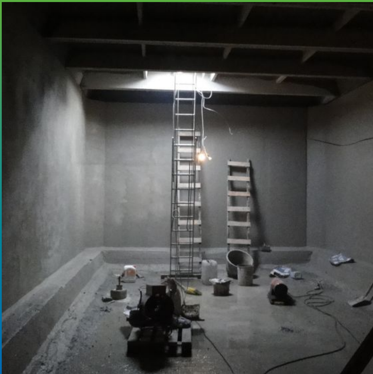
Финальный вид резервуара
