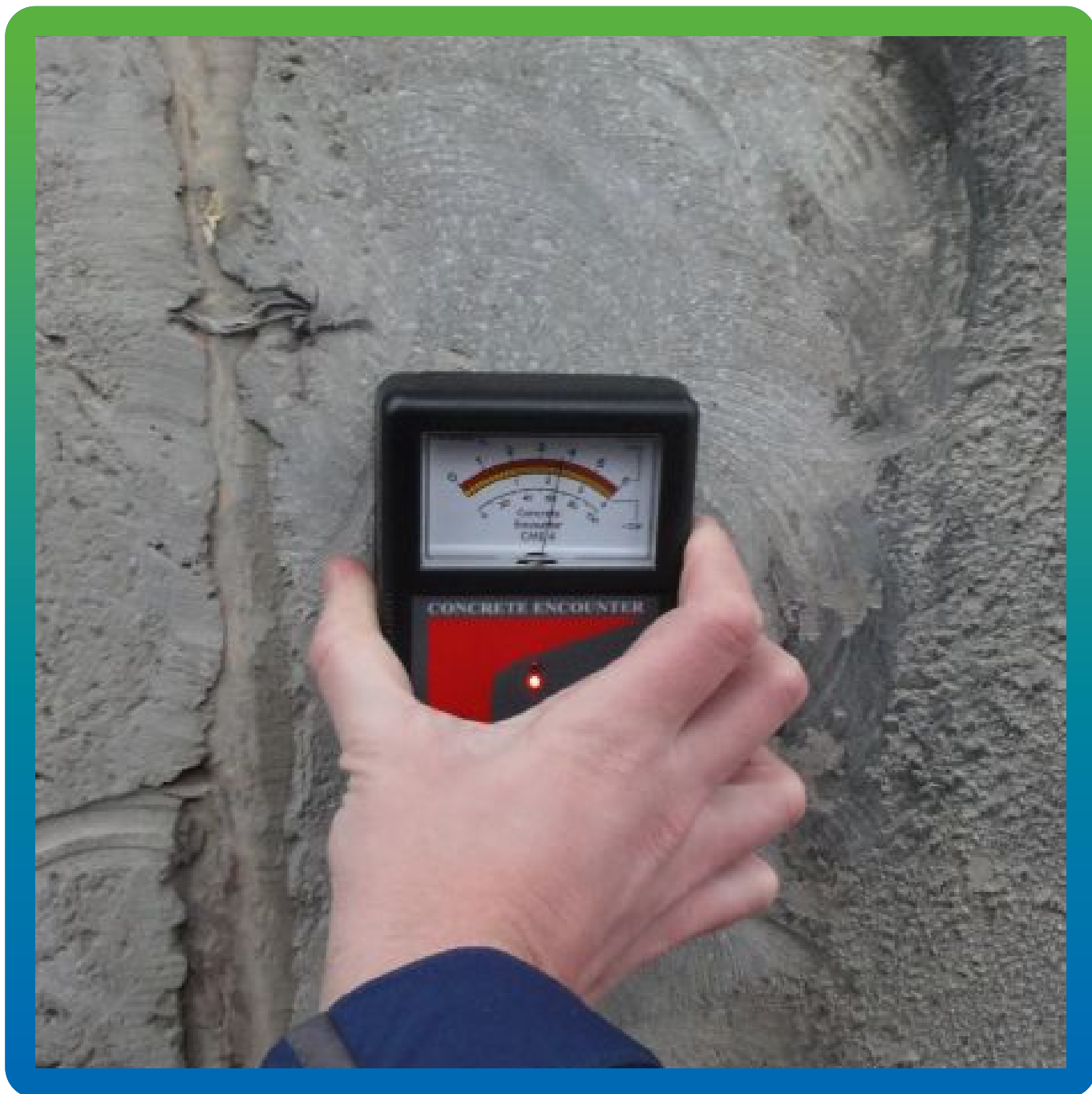
Проверка влажности основания с помощью влагомера Трамех
