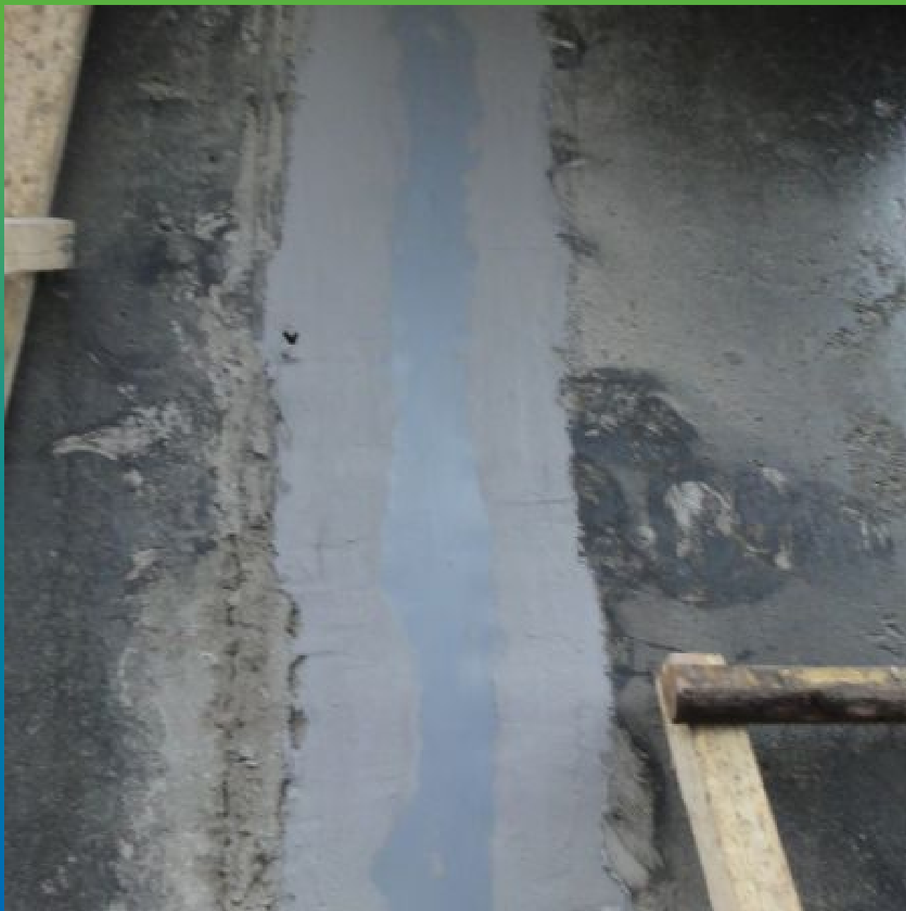
Финальный вид шва: Гидроизоляционная лента Манодил Про + Манопокс 331
