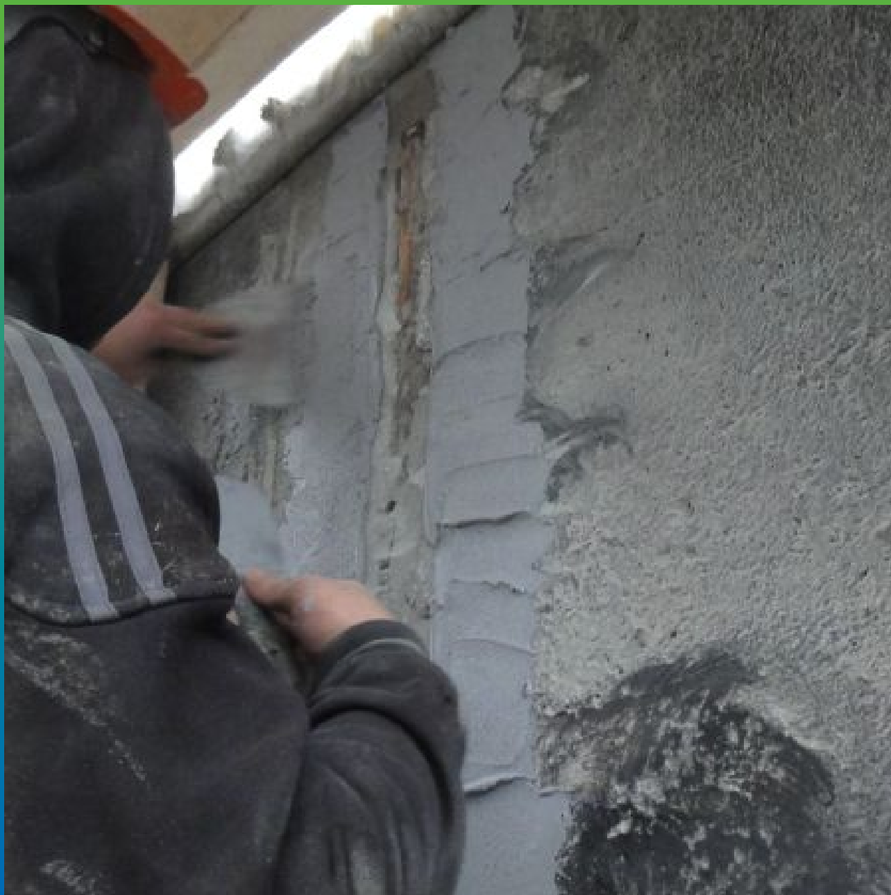
Нанесение адгезива Манопокс 331
