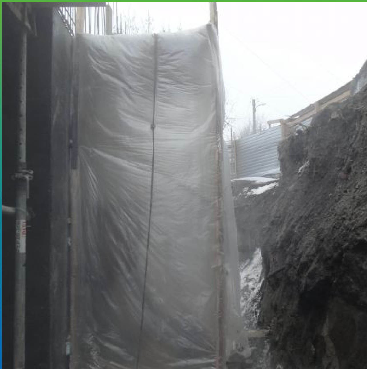
Устройство тепляка для работы в зимний период
