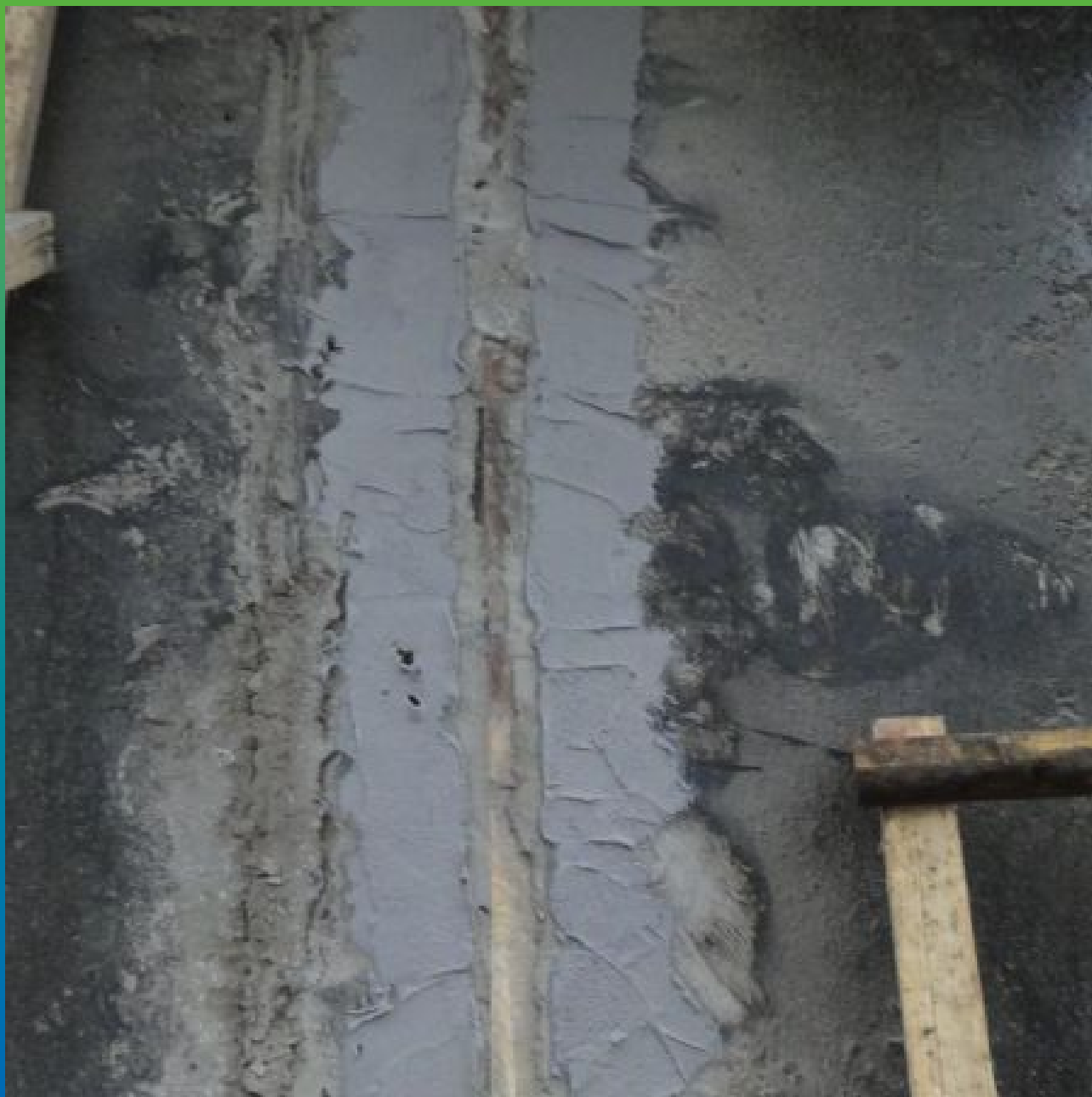
Вид рабочего/холодного шва бетонирования с нанесенным слоем адгезива Манопокс 331
