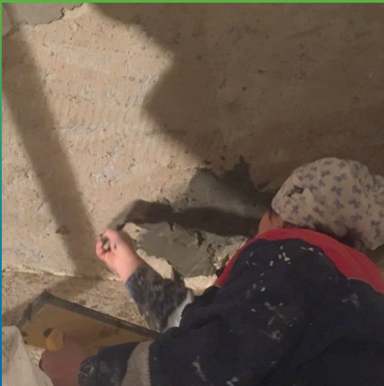
Процесс заделки каверн (сколы и дефекты ж/б) на потолке
