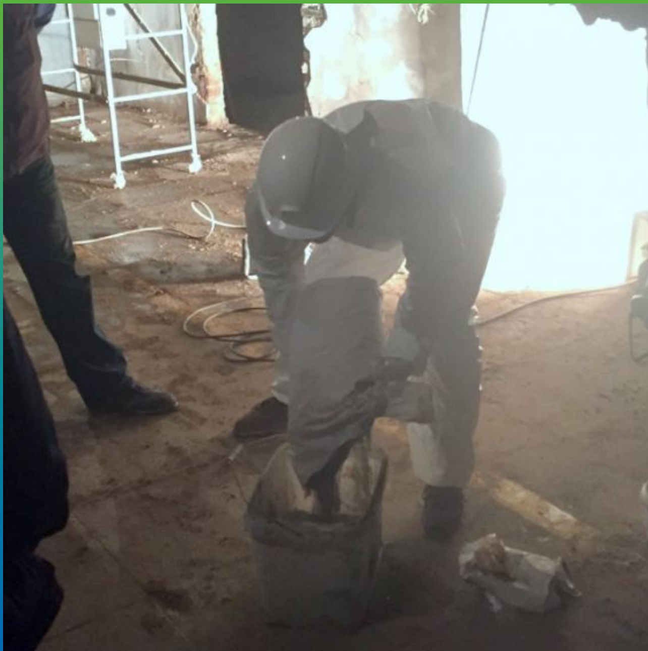
Замешивание ремонтного состава Стармекс РМ 3 с водой согласно ТО
