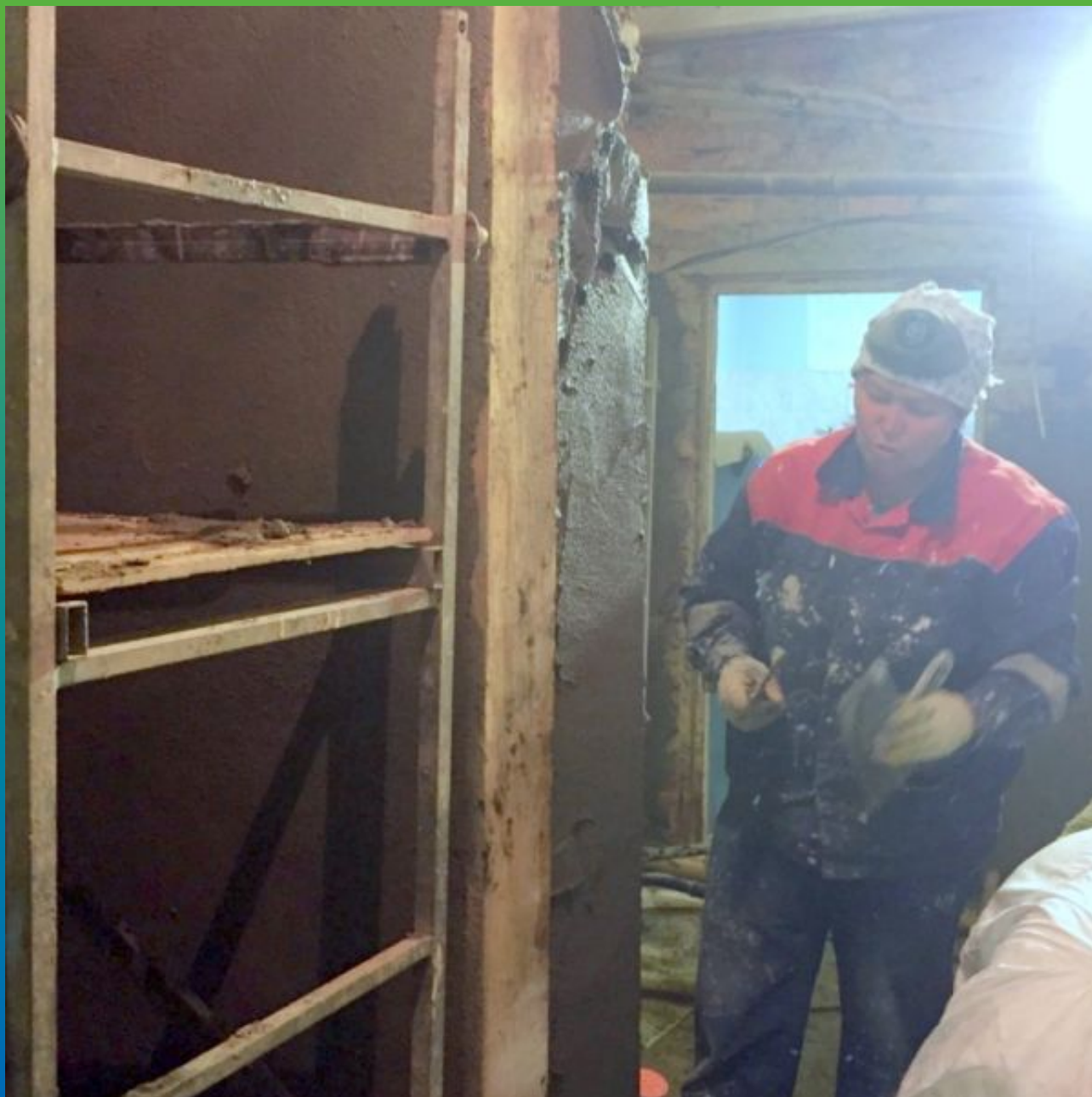
Процесс восстановления тела кирпича + набор толщины стенки
