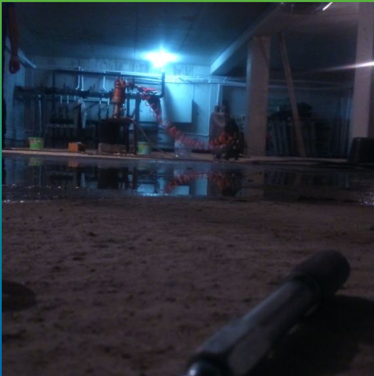
Вид объекта изнутри
