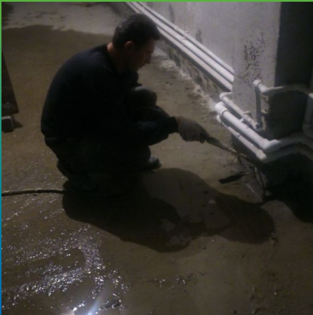
Инъектирование примыкания стена-пол
