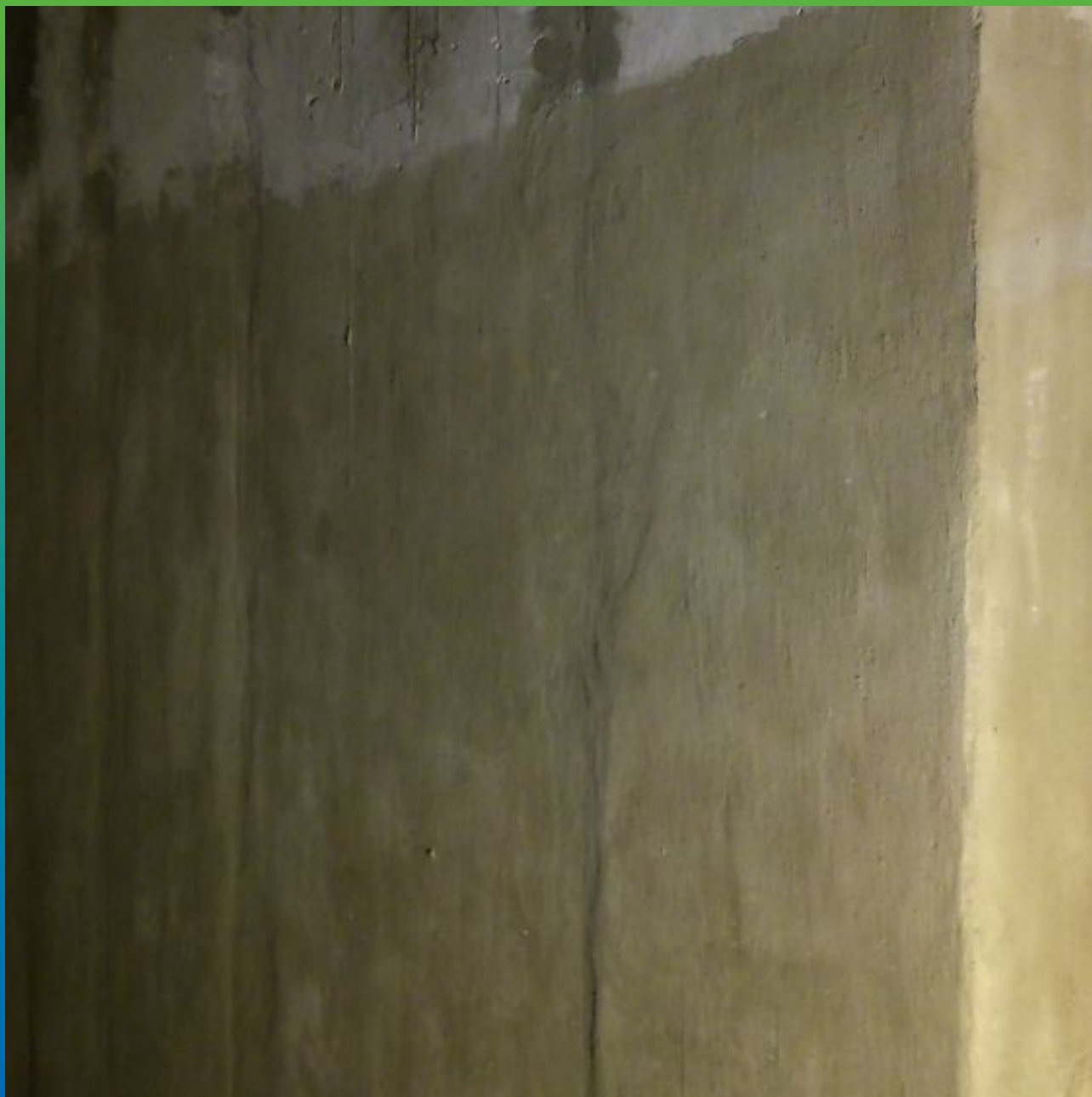
Конечный вид после нанесения Макссил Супер
