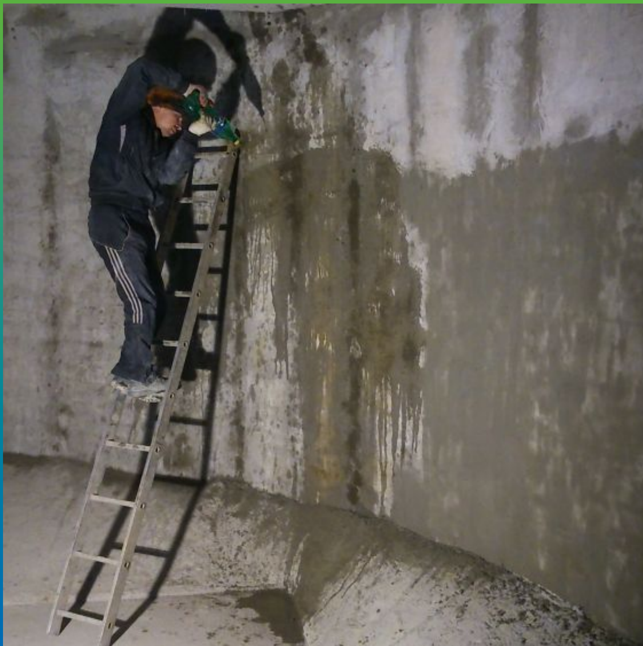
Смачивание поверхности перед нанесением Максил Супер
