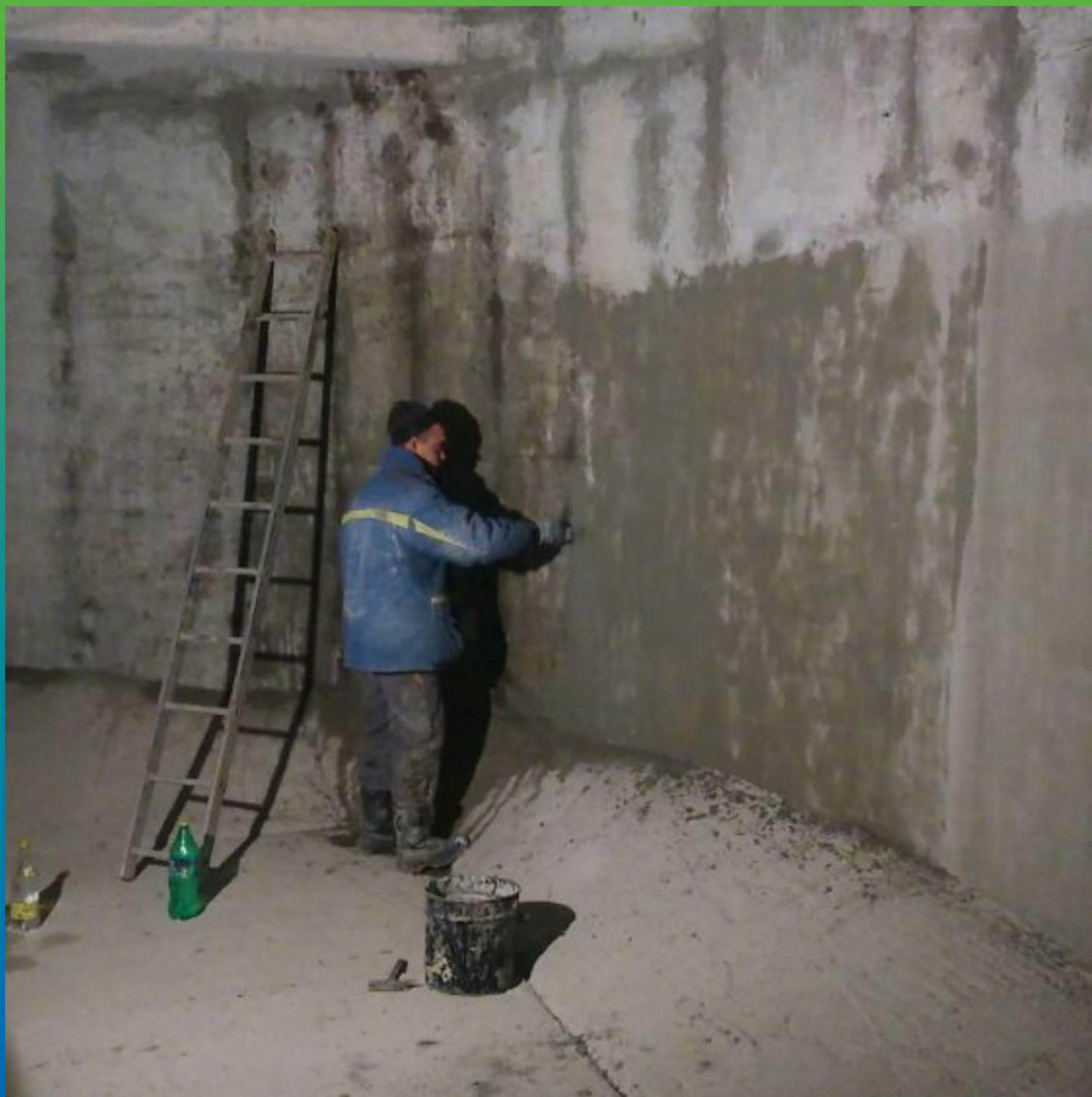
Нанесение Максил Супер
