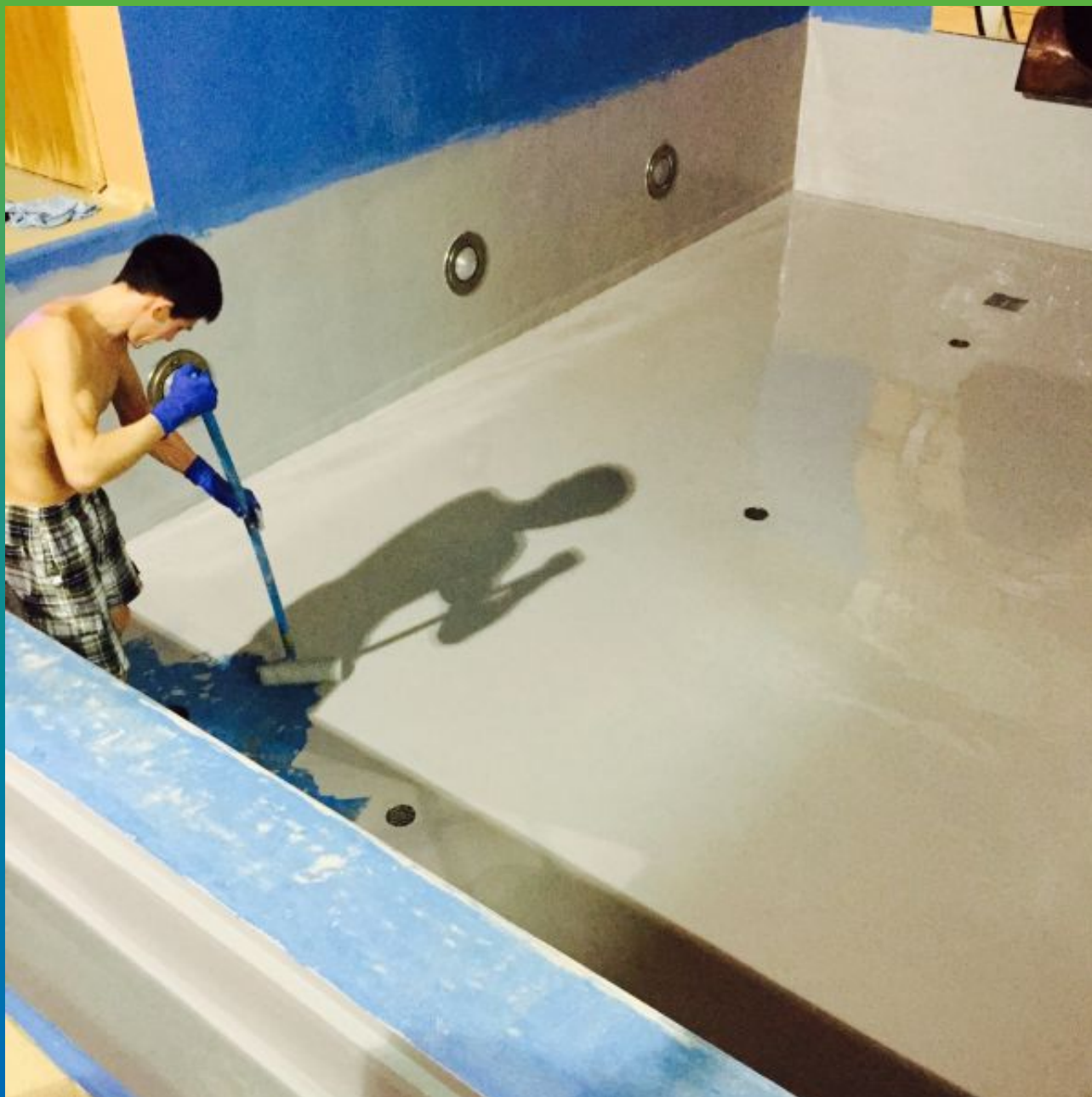
Нанесение Максэластик Пур валиком
