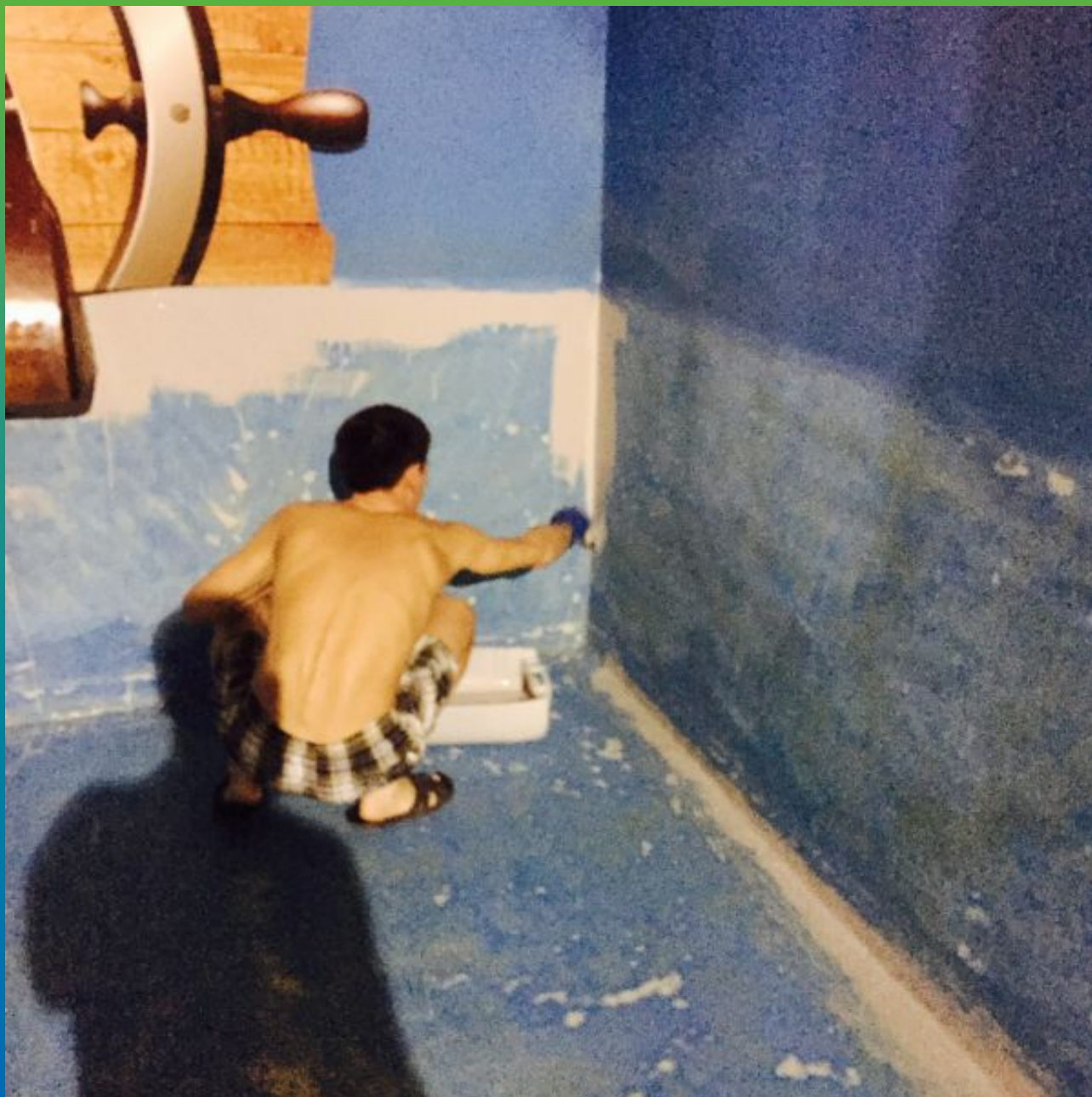
Нанесение Максэластик Пур в труднодоступных местах
