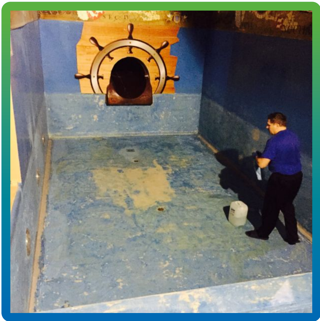
Очистка и обезжиривание поверхности бассейна
