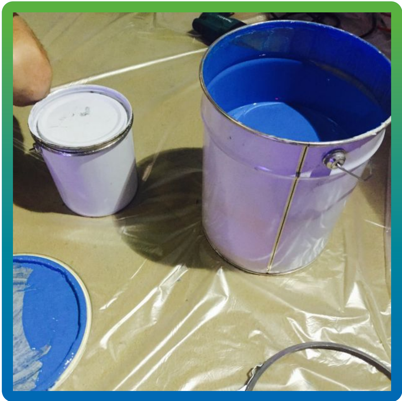
Подготовка защитного полиуретанового покрытия Денстоп ПУ 302
