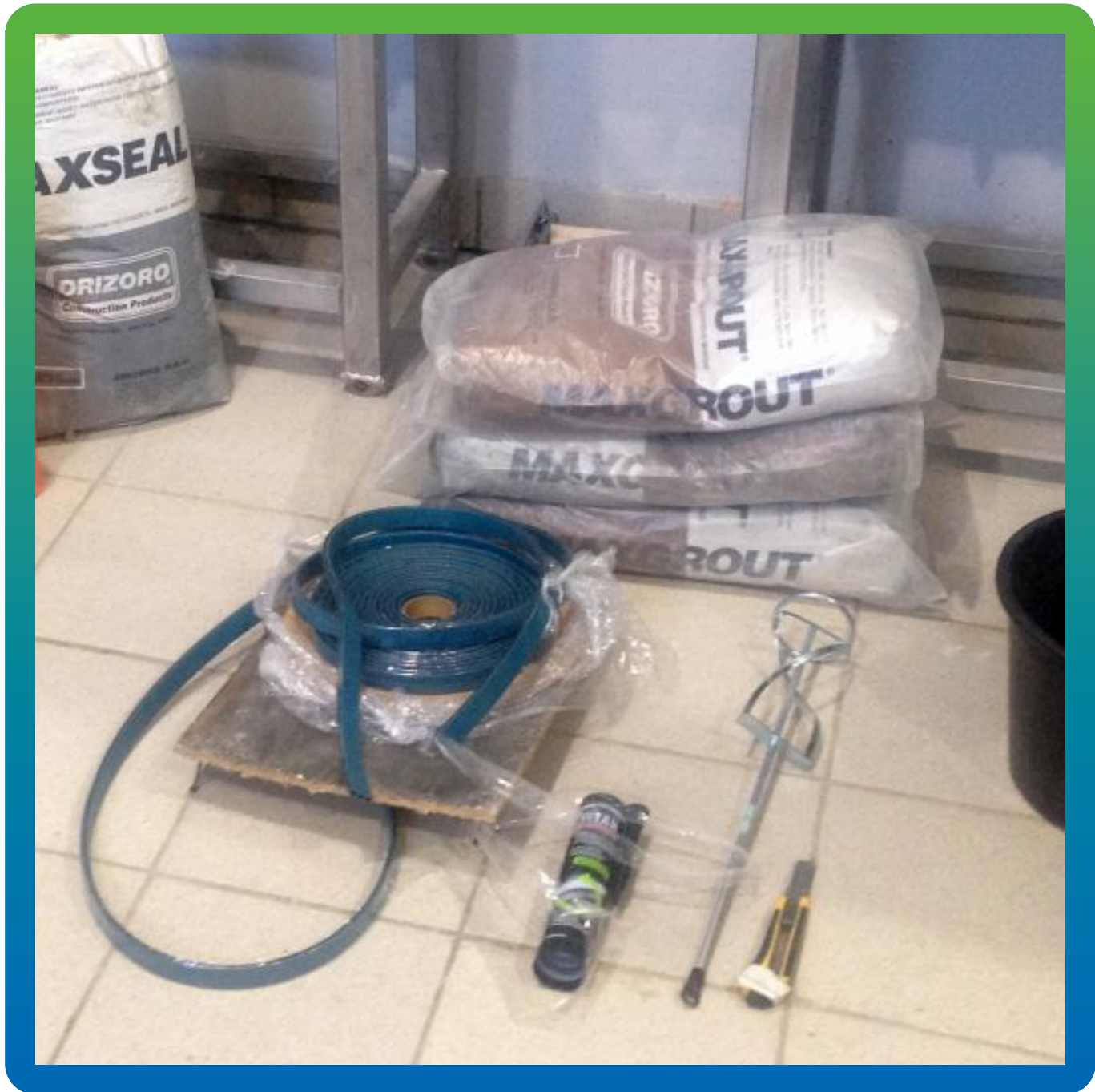
Материалы Гидрозо на объекте
