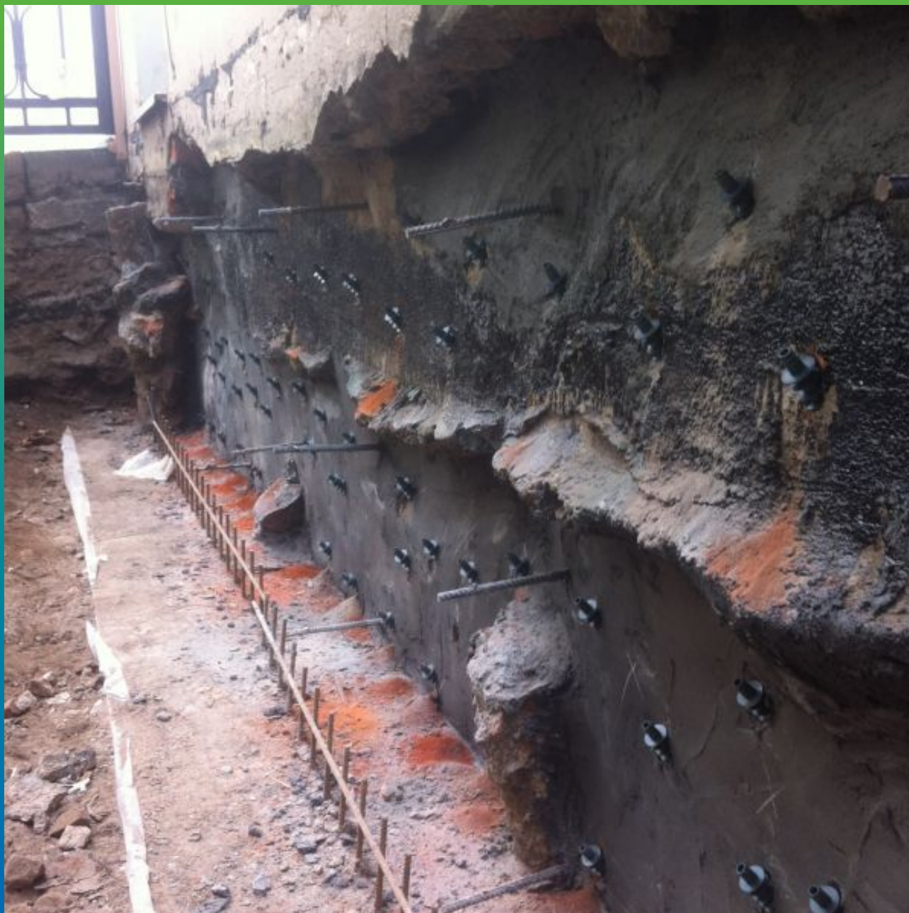
Смонтированные пакеры под усиление кирпичной кладки
