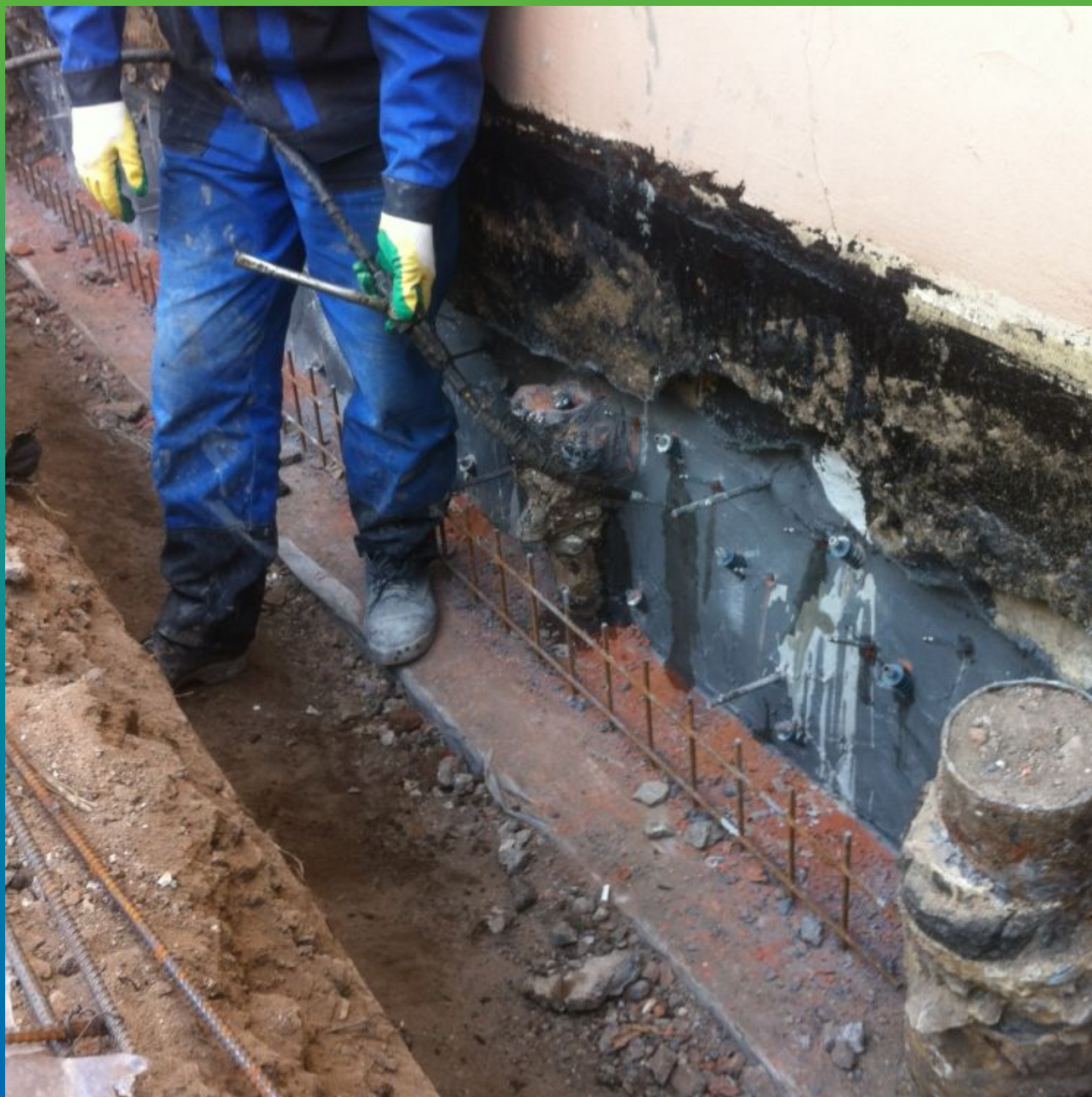
Отсечная гидроизоляция материалом Маноксан 150
