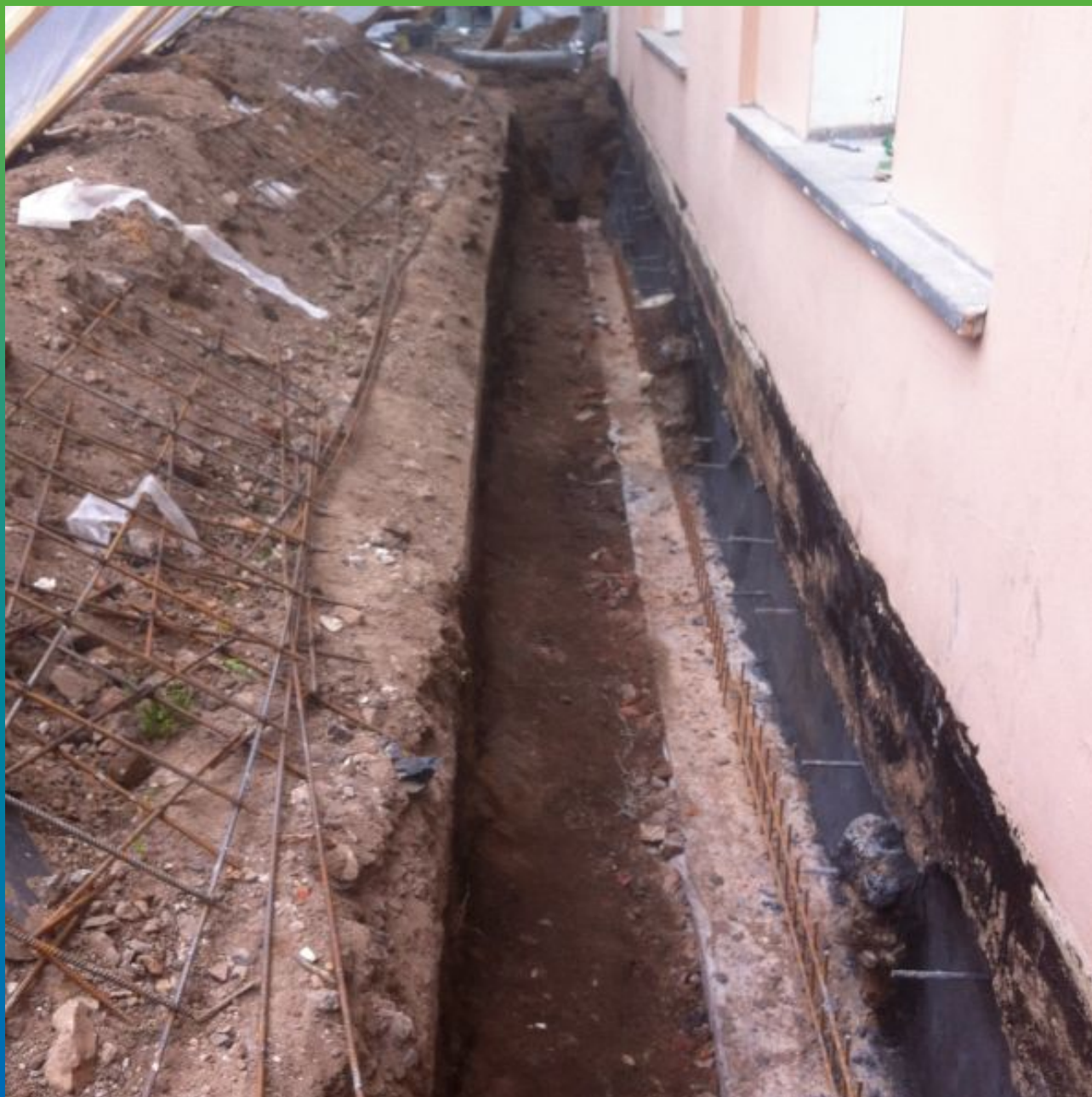
Выполненные работы по отсечной гидроизоляции
