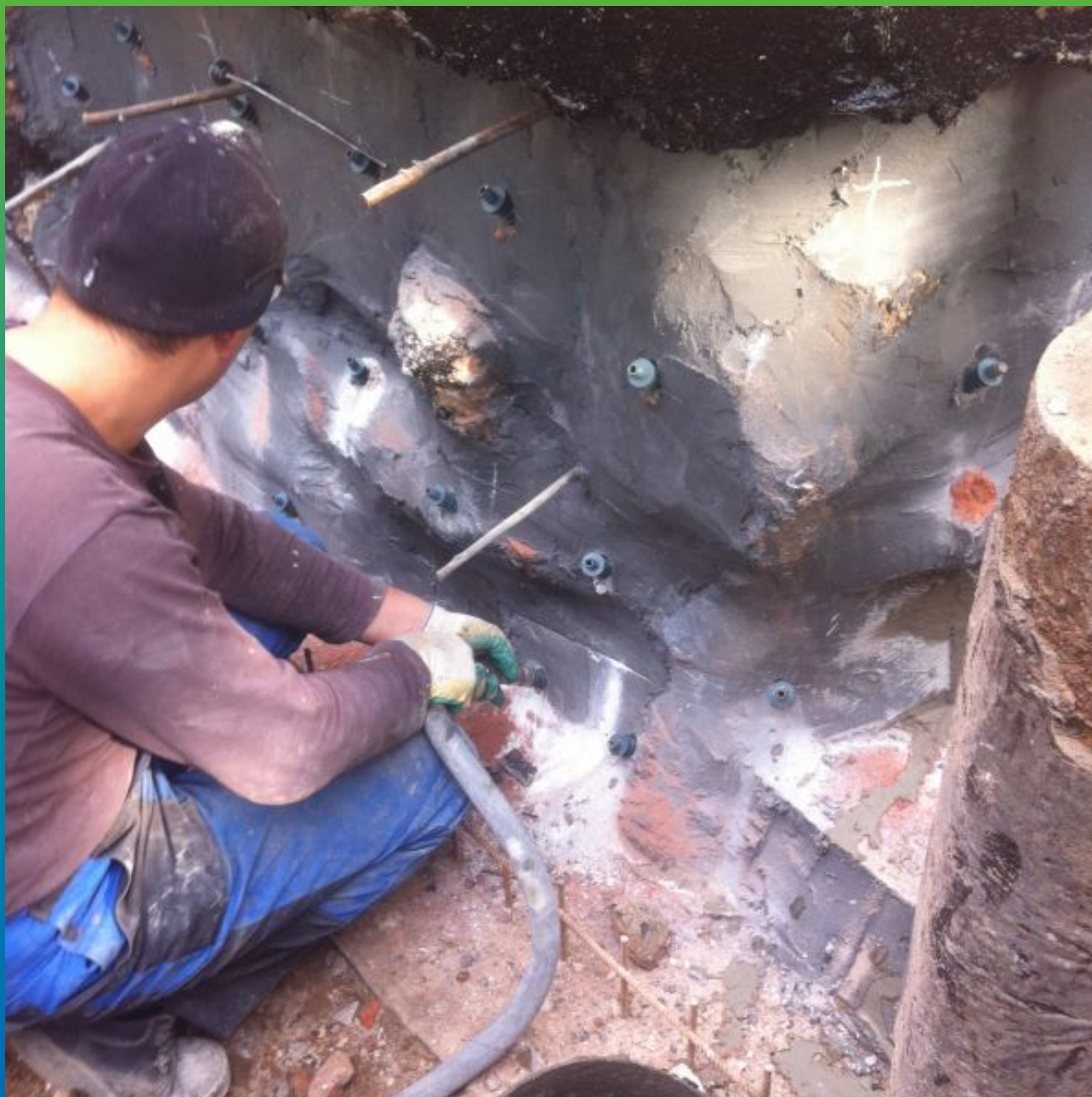
Усиление кирпичной кладки материалом Маноцем Фил
