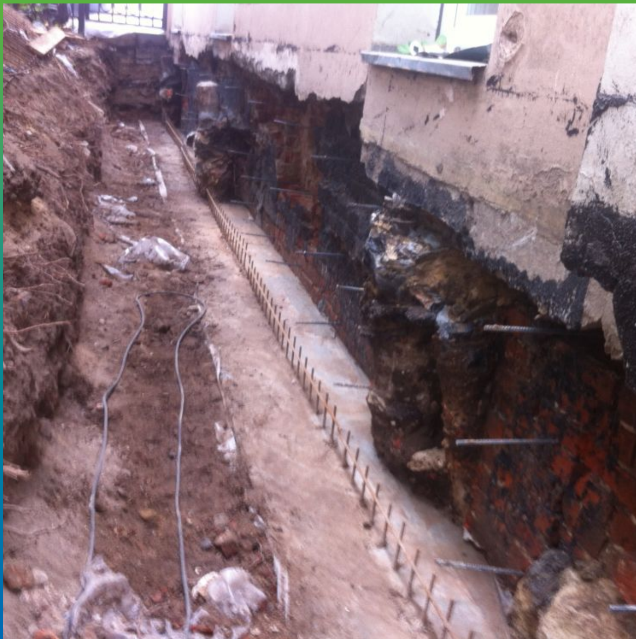
Откопка здания снаружи
