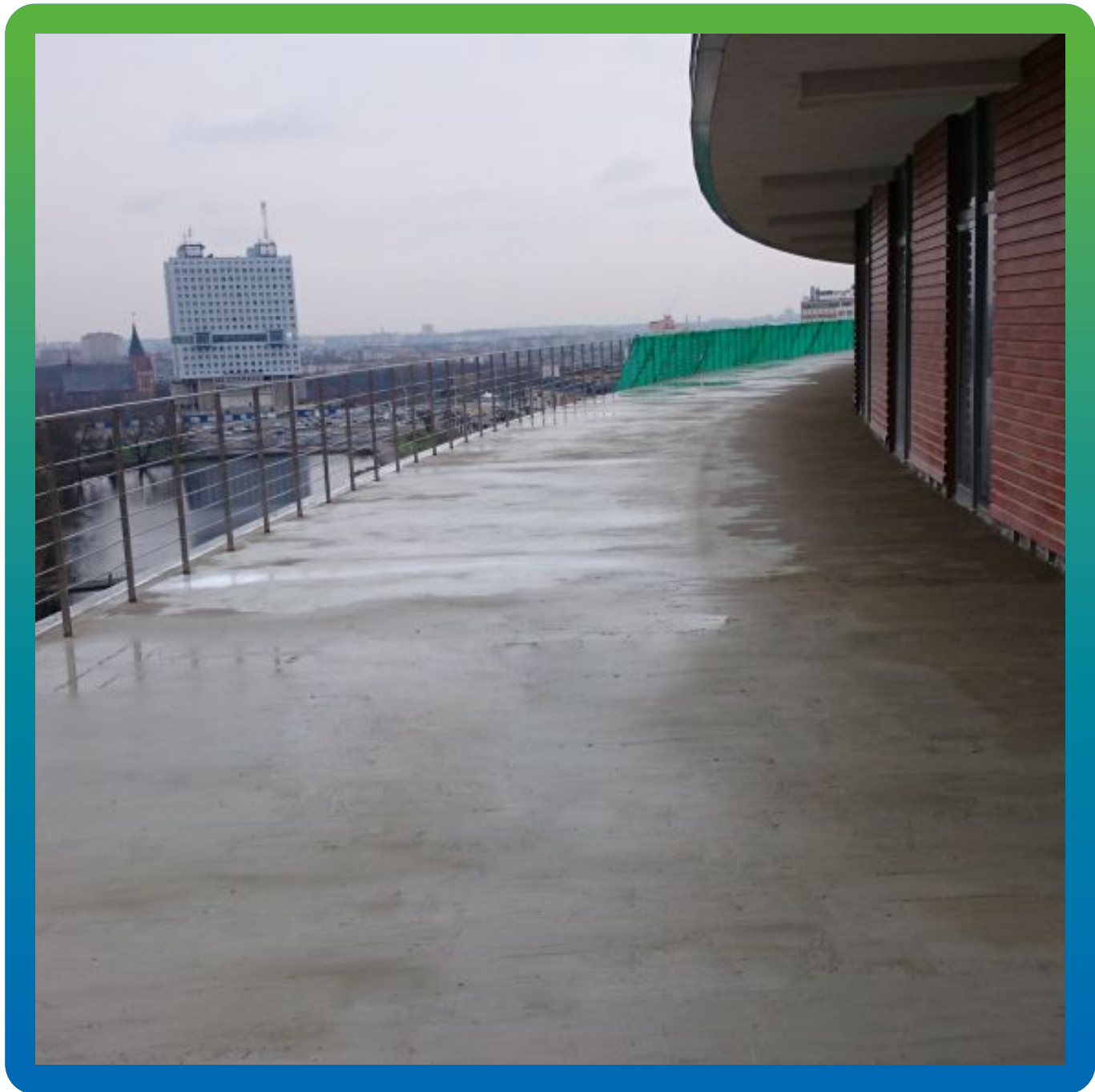
Общий вид выполненных работ.
