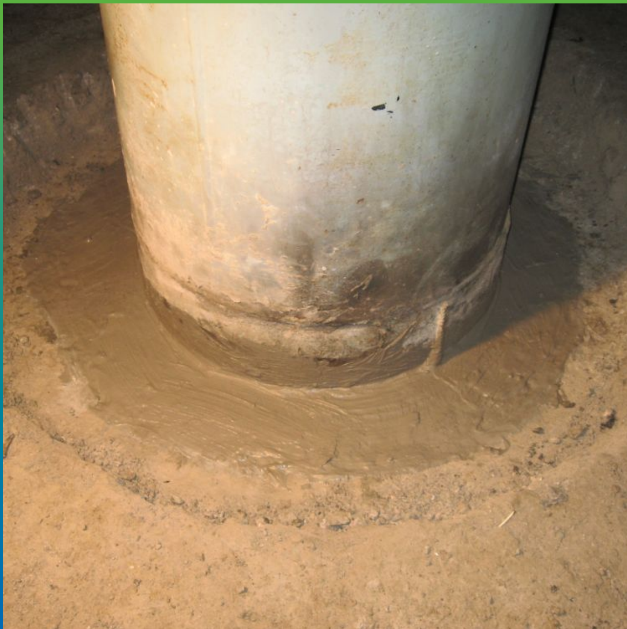
Вид на гидроизолированный ввод трубы
