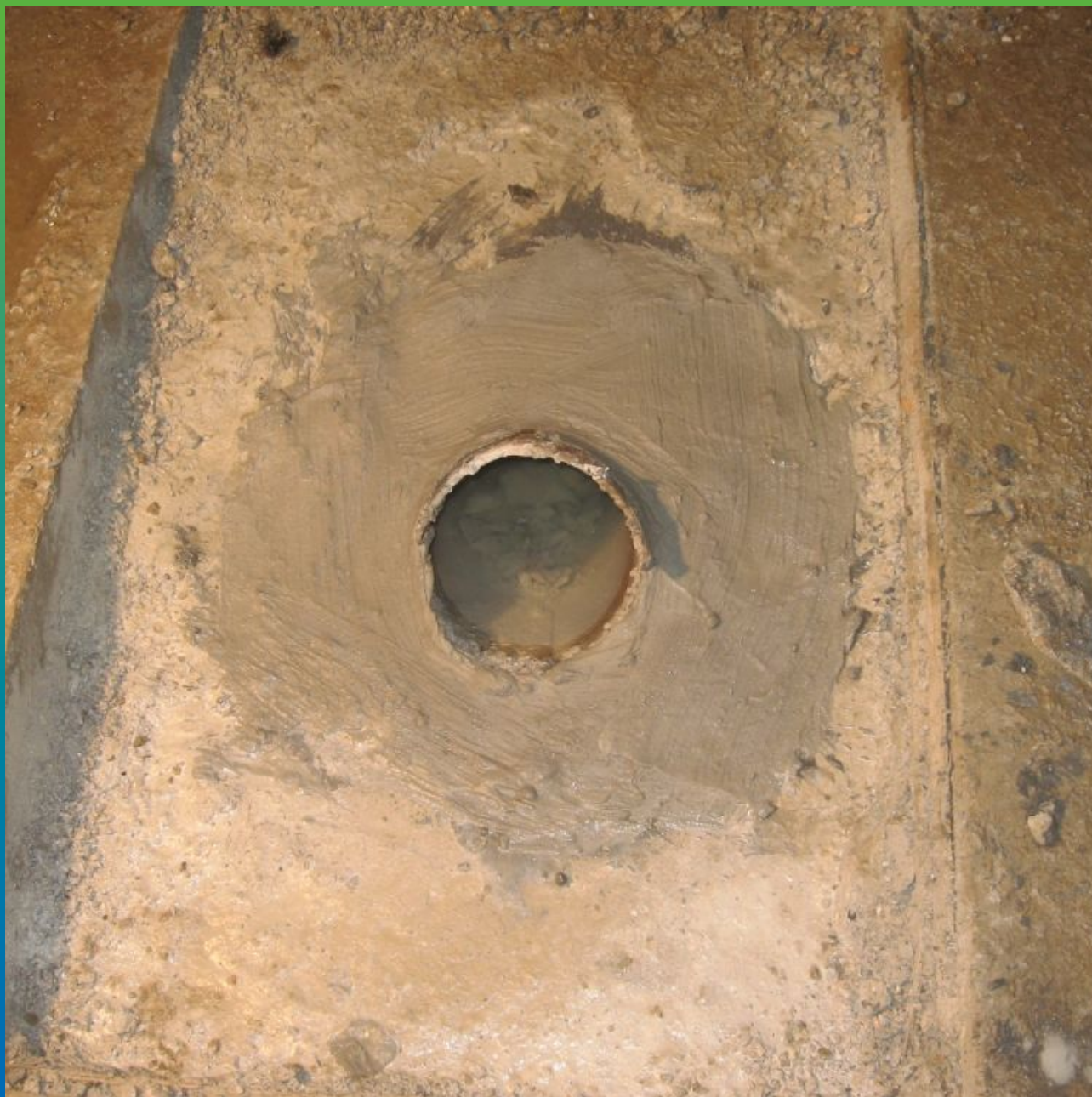
Зачеканка ввода коммуникаций ремонтным составом Максрест и нанесение эластичной гидроизоляции Макссил Флекс
