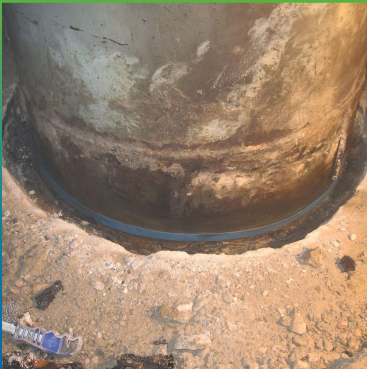
Подготовка штрабы и монтаж гидрофильного профиля Манодил Свелл вокруг трубы диаметром 500 мм
