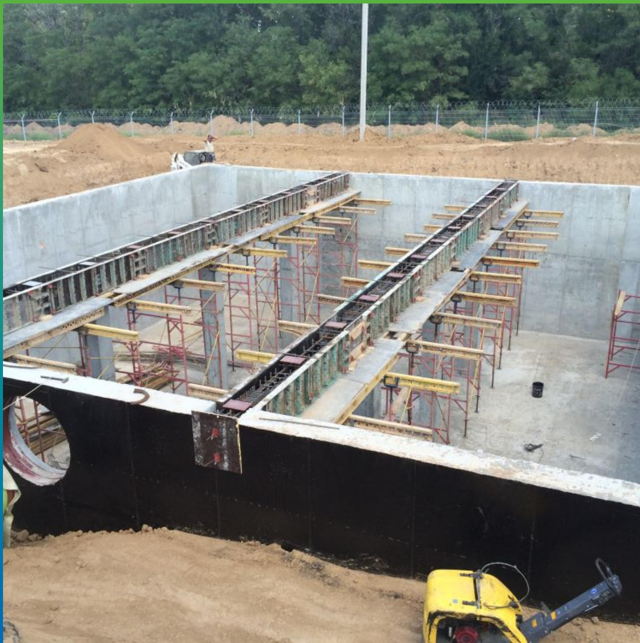
Залитый резервуар перед нанесением гидроизоляционного покрытия Максил Супер
