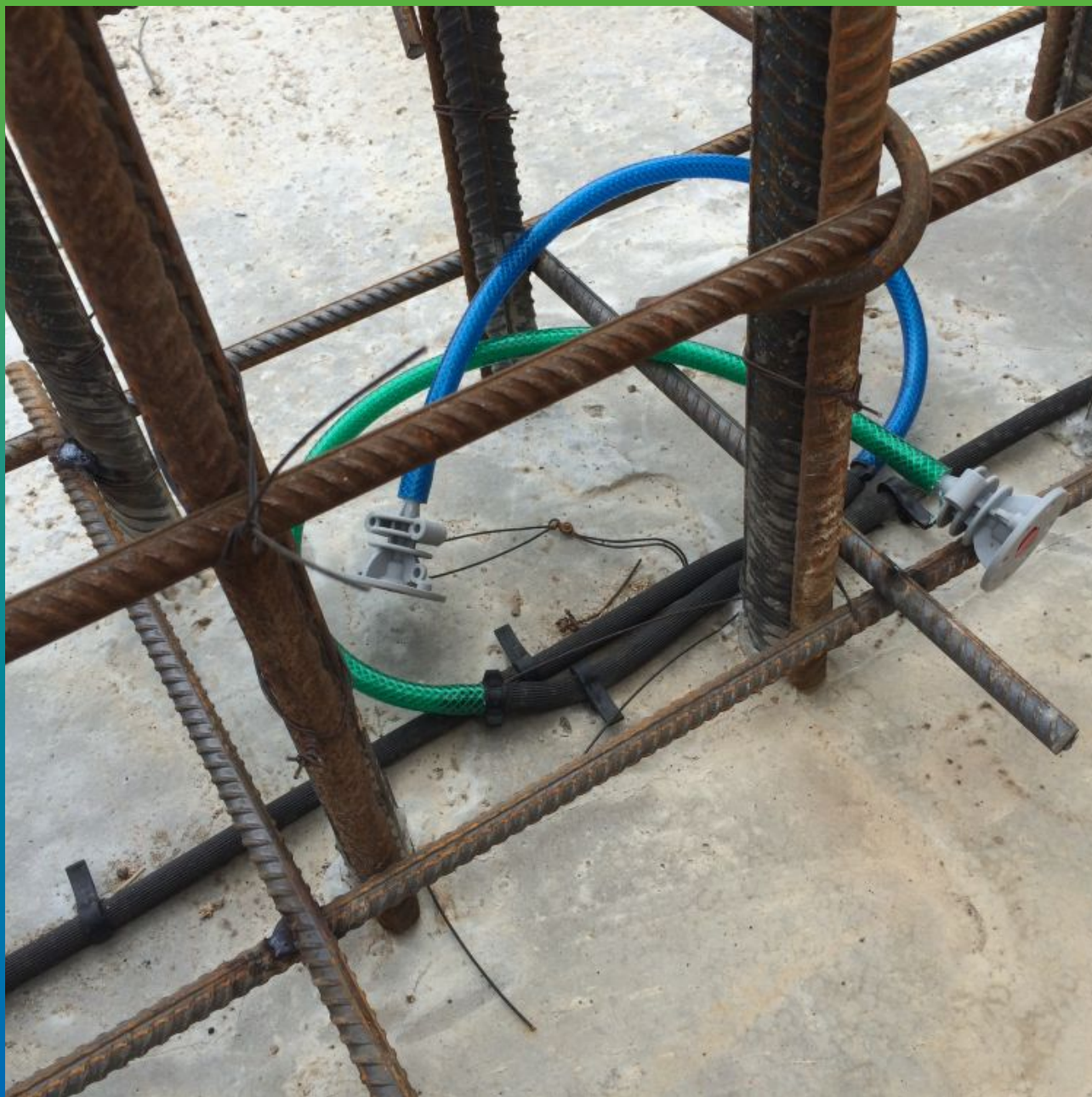
Смонтированная система Инжпайп Т
