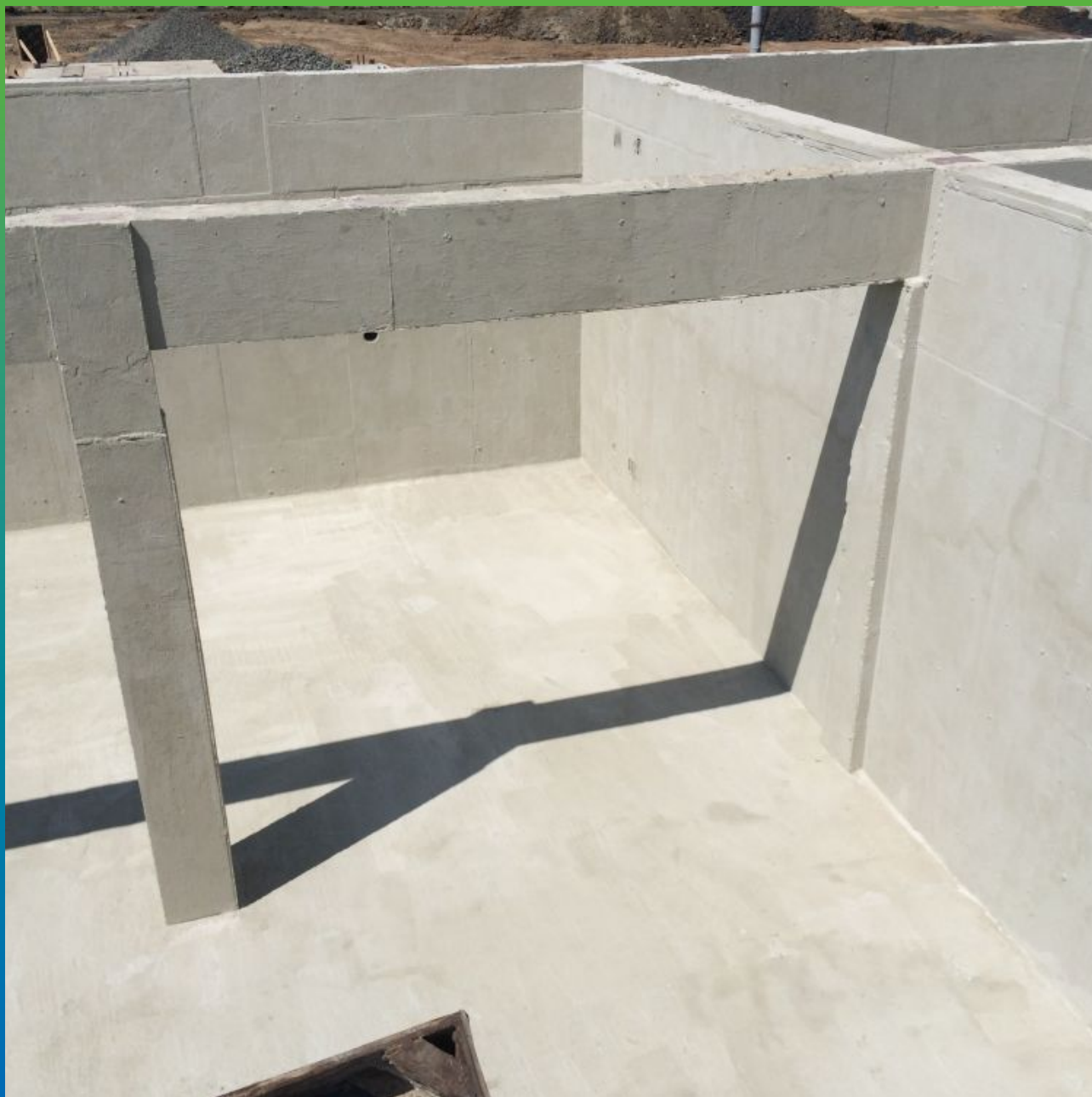
Резервуар после нанесения гидроизоляционного покрытия Максил Супер
