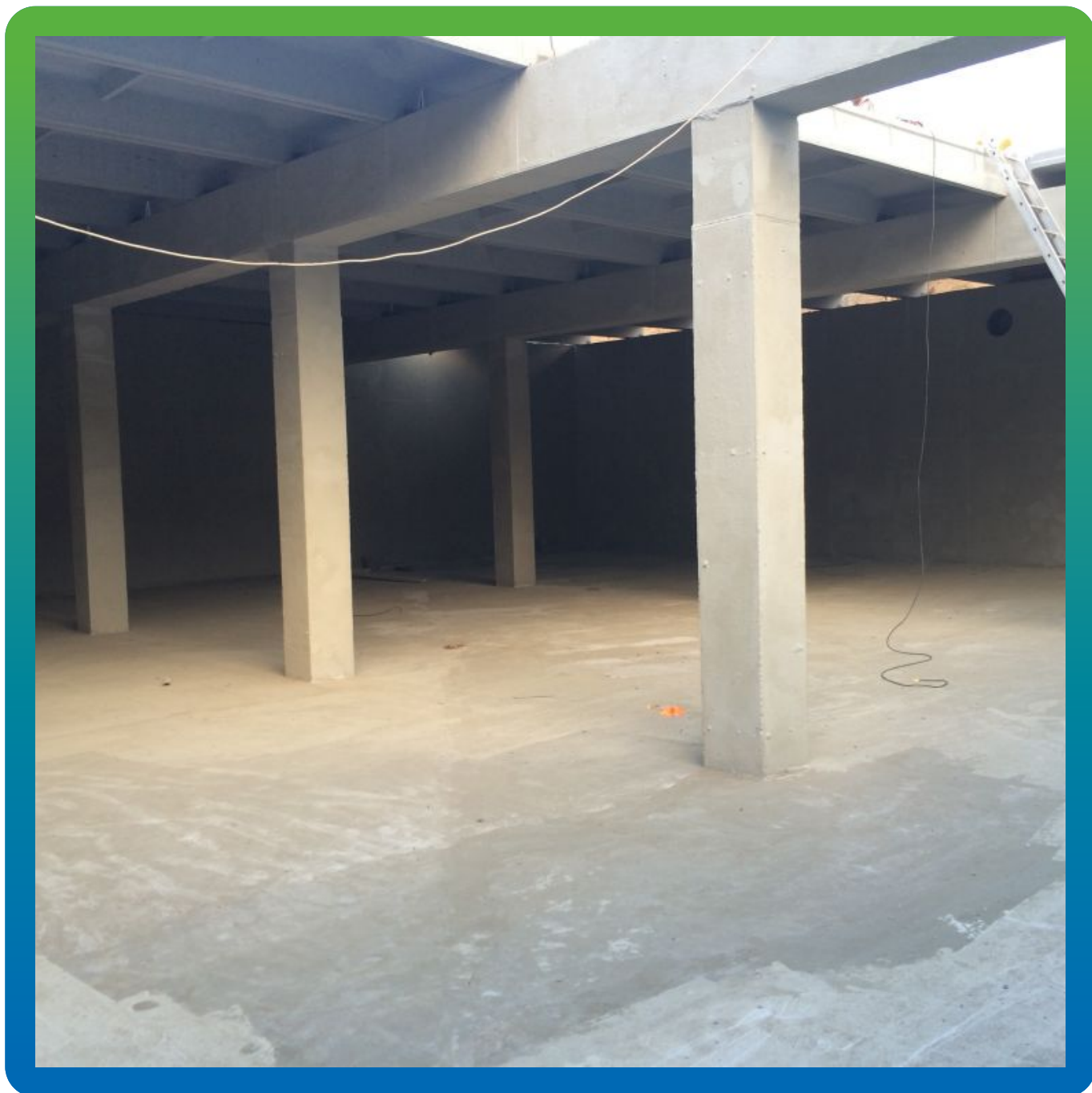
Резервуар после нанесения гидроизоляционного покрытия Максил Супер
