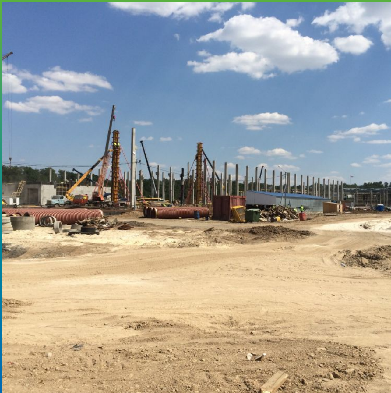
Общий вид строительной площадки завода ТЕХНО
