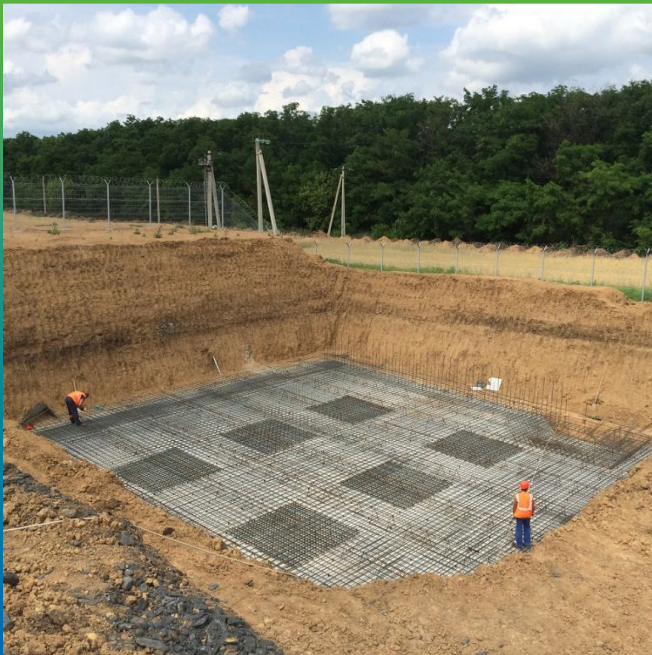
Бетонная подготовка РЧВ № 1 1000 м 3
