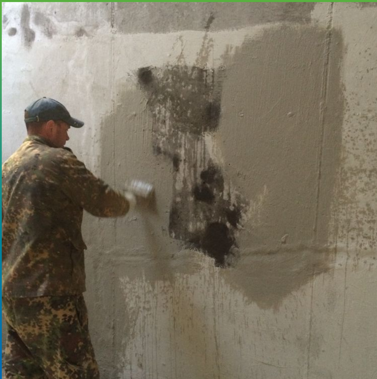
Гидроизоляция стен резервуара изнутри покрытием Максил Супер
