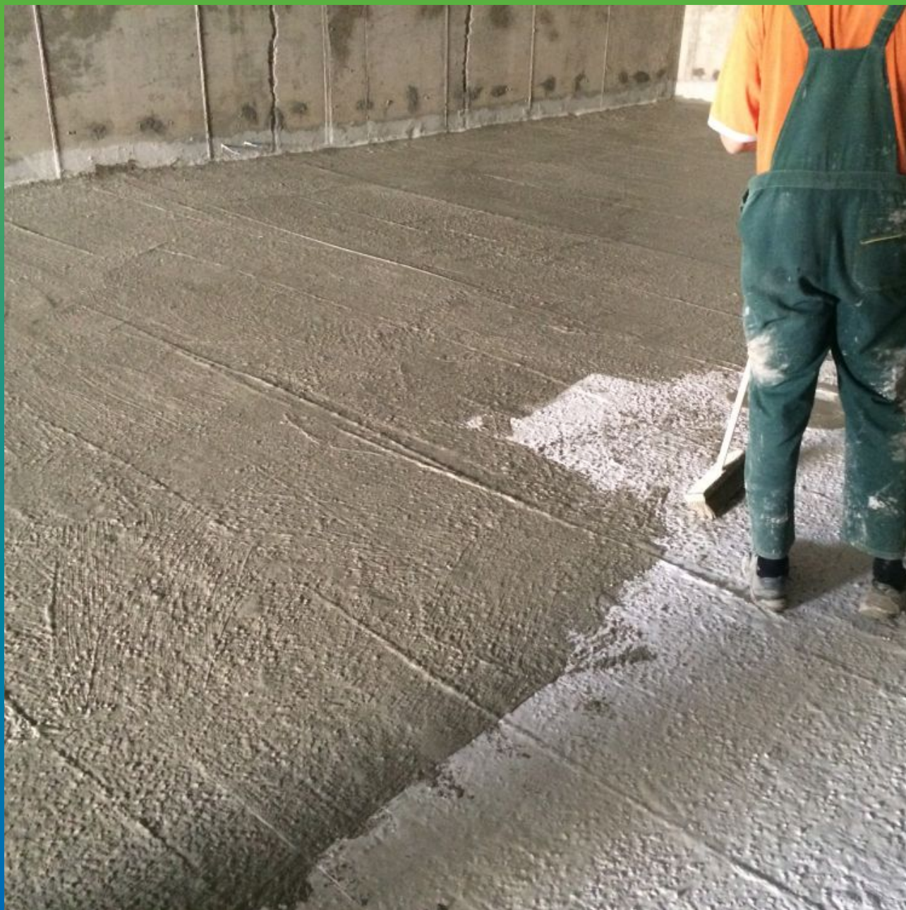
Нанесение гидроизоляционного покрытия Максил Супер на днище резервуара
