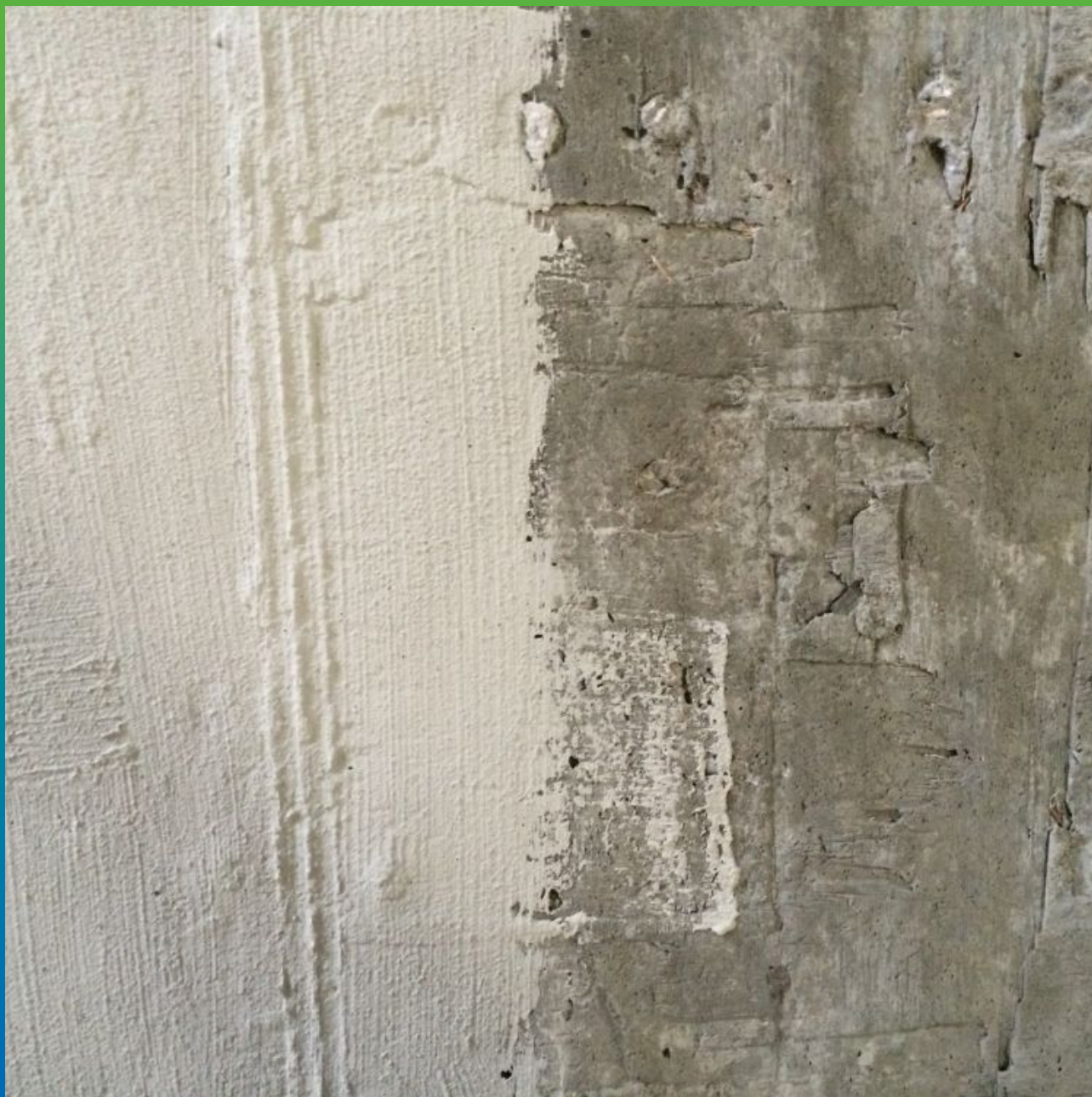
Бетон, обработанный первым слоем гидроизоляционного покрытия Максил Супер
