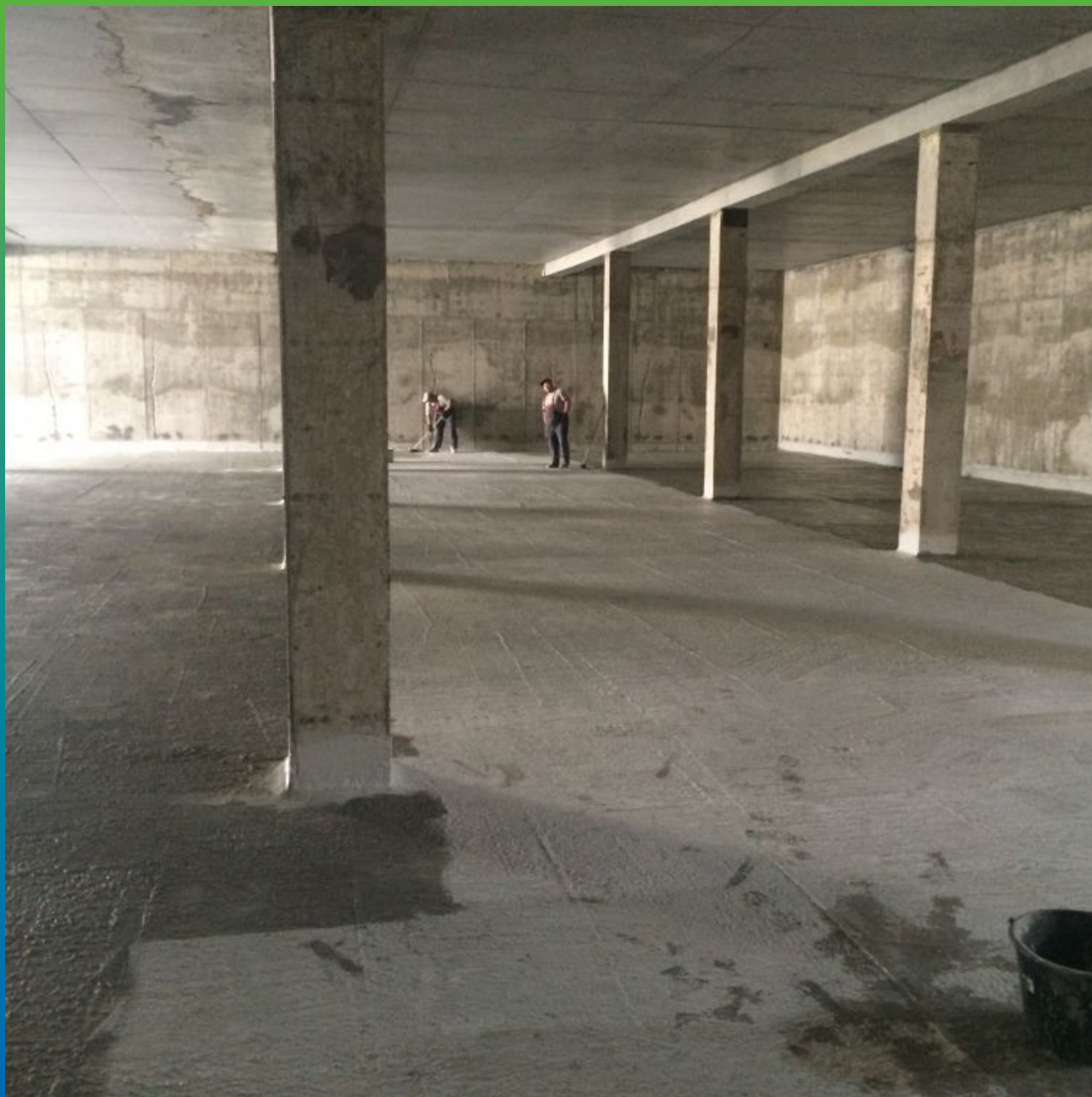
Общий вид внутри резервуара в процессе нанесения гидроизоляции на днище
