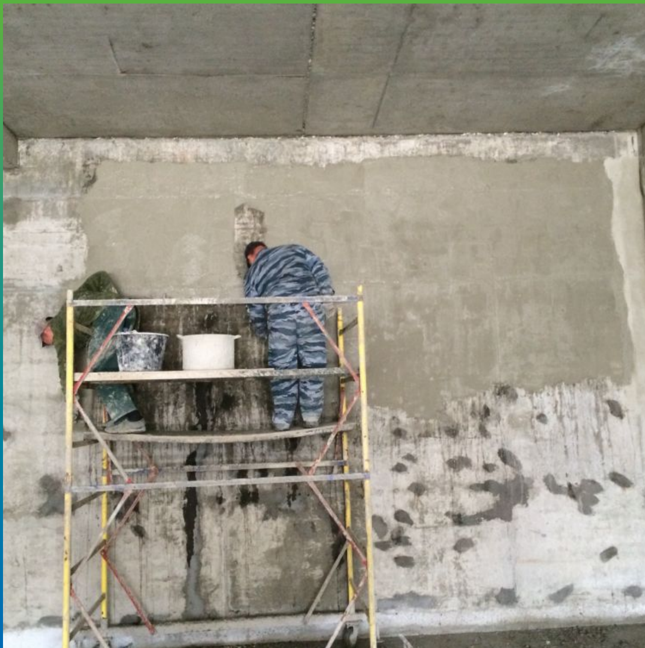
Нанесение на стены покрытия Максил Супер
