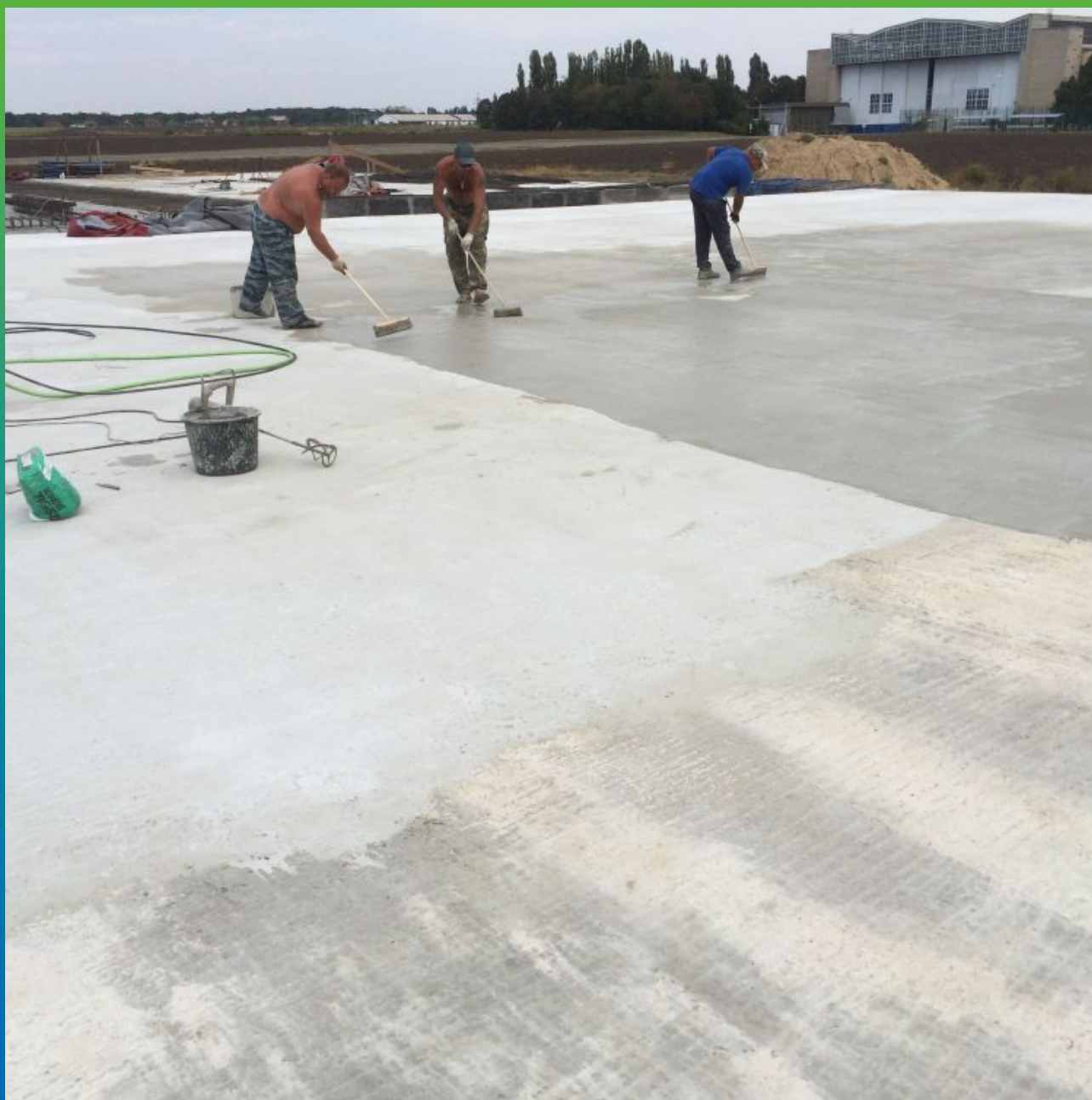
Нанесение гидроизоляционного покрытия Максил Супер на кровлю резервуара
