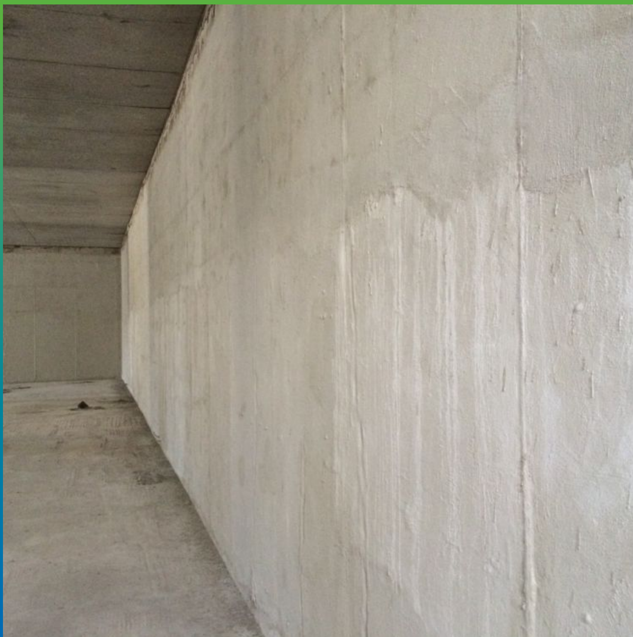
Стена резервуара, покрытая гидроизоляционным составом Максил Супер
