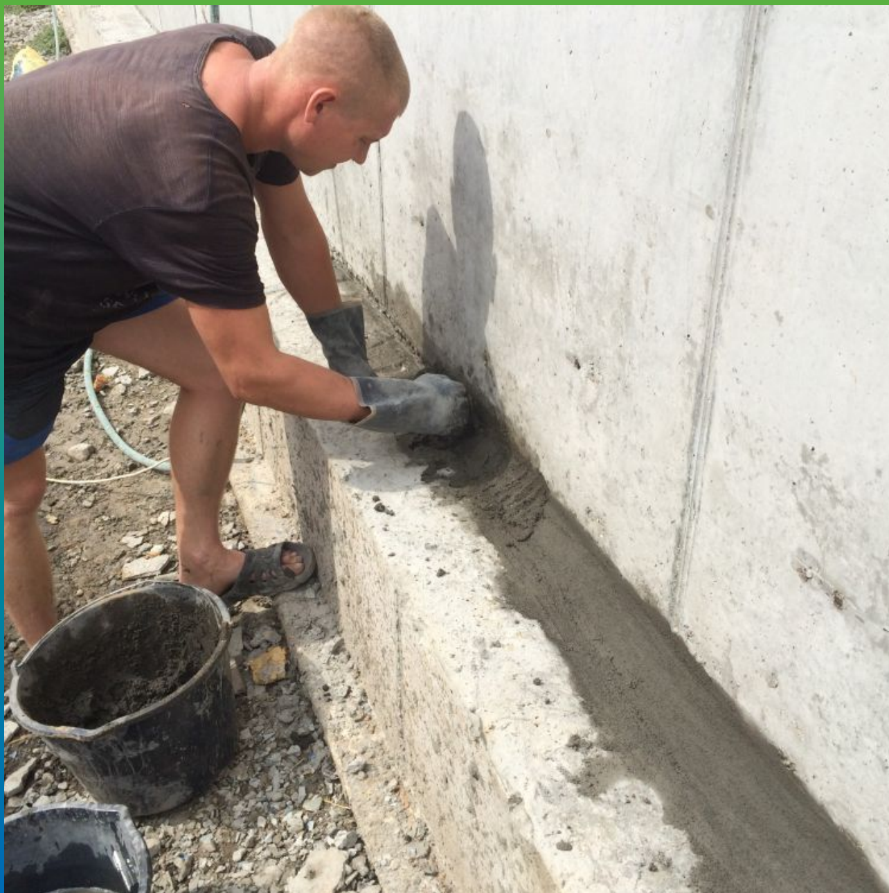
Процесс заделки шва бетонирования снаружи ремонтным составом Макрест
