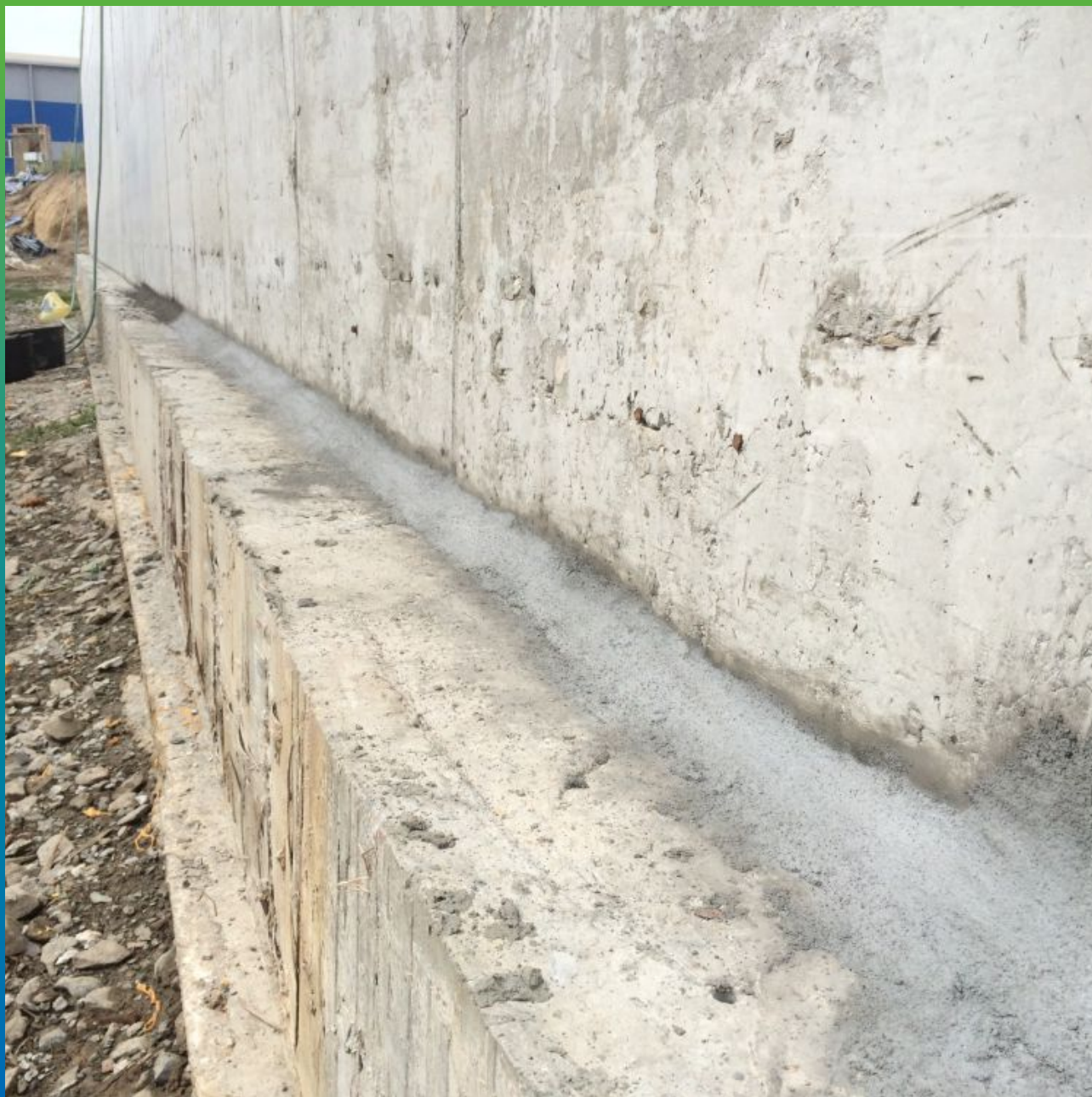
Чеканка шва бетонирования снаружи ремонтным составом Максрест
