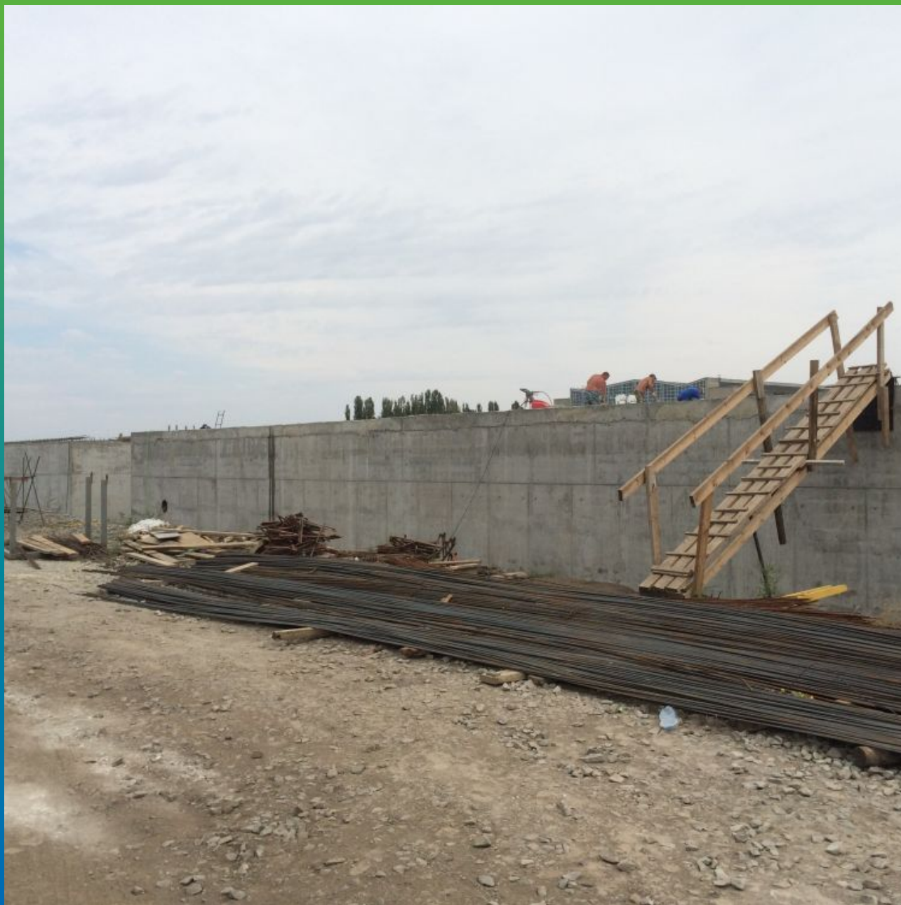
Вид резервуаров до начала работ
