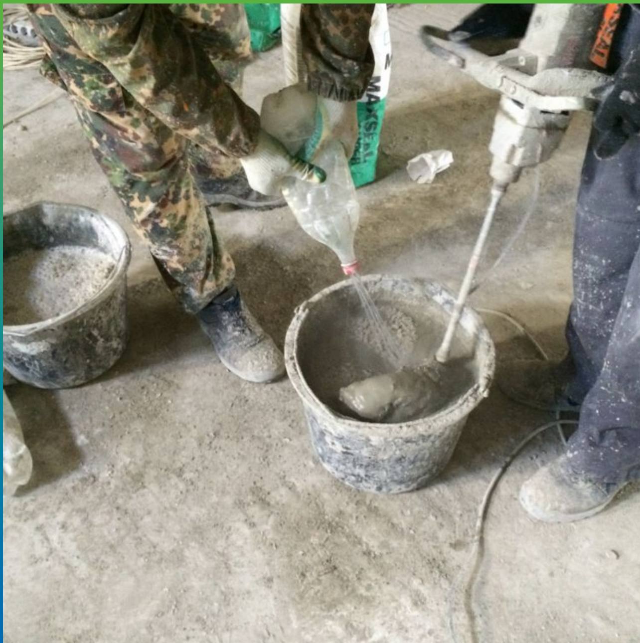
Замешивание состава Макссил Супер перед нанесением
