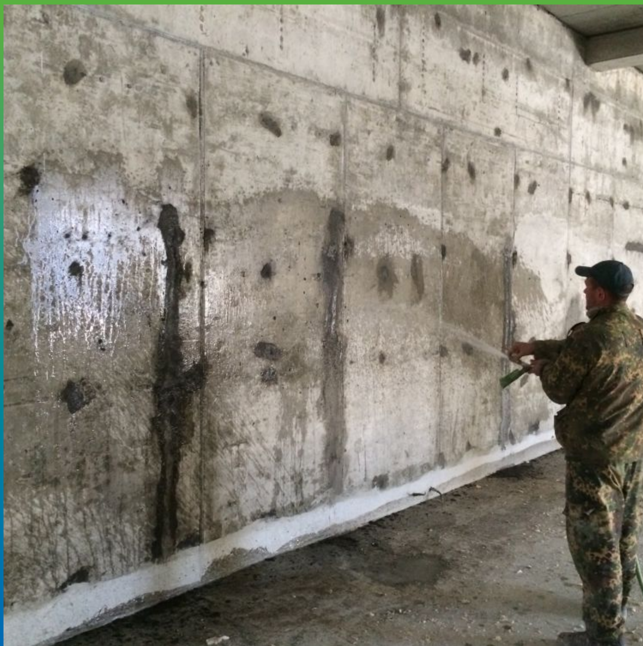
Смачивание поверхности бетона перед нанесением покрытия Макссил Супер
