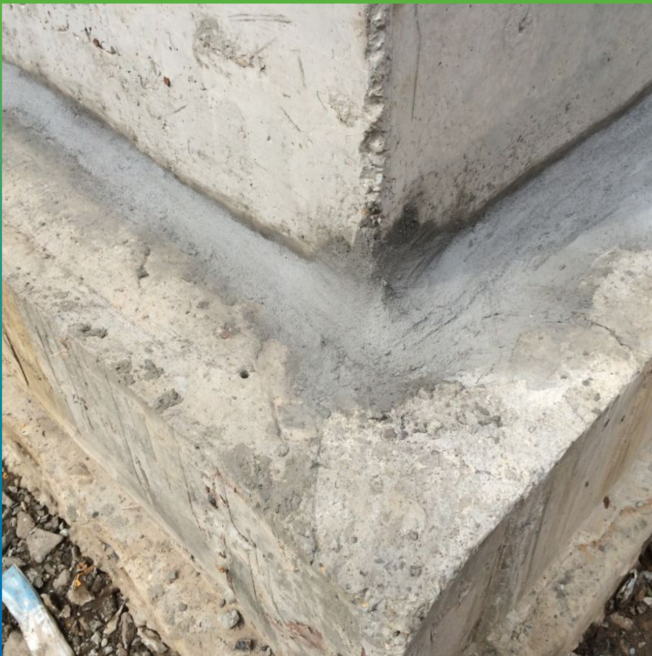
Чеканка шва бетонирования снаружи ремонтным составом Максрест
