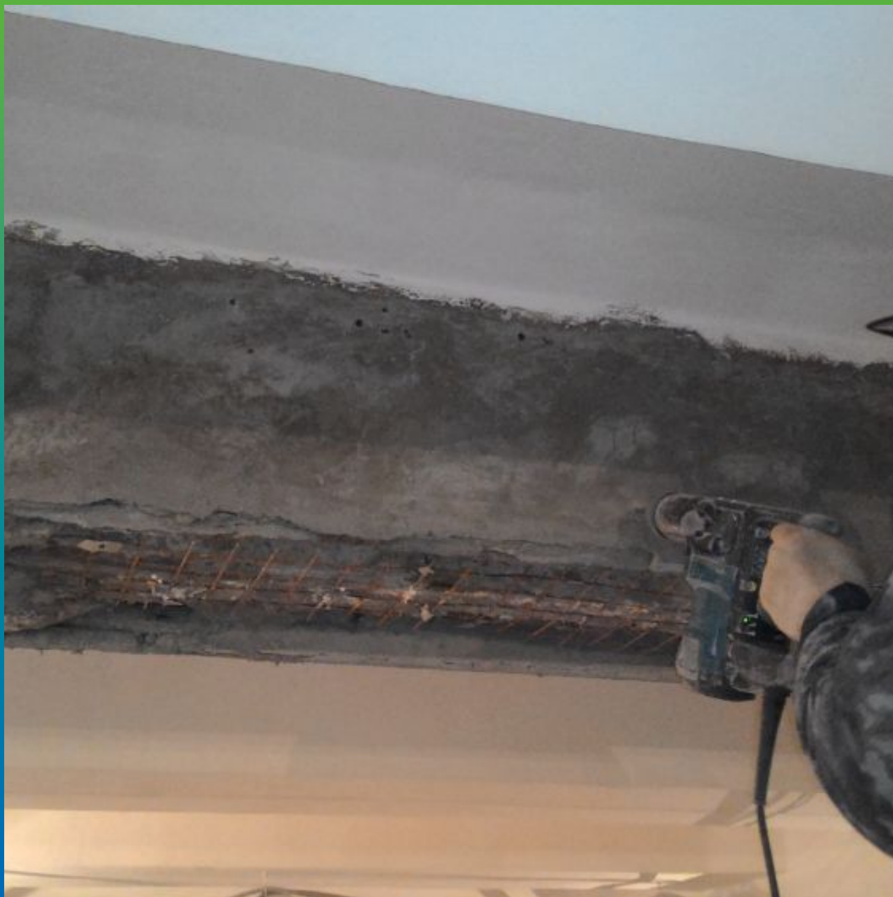
Сверление отверстий в ригеле под инъекционные пакера.
