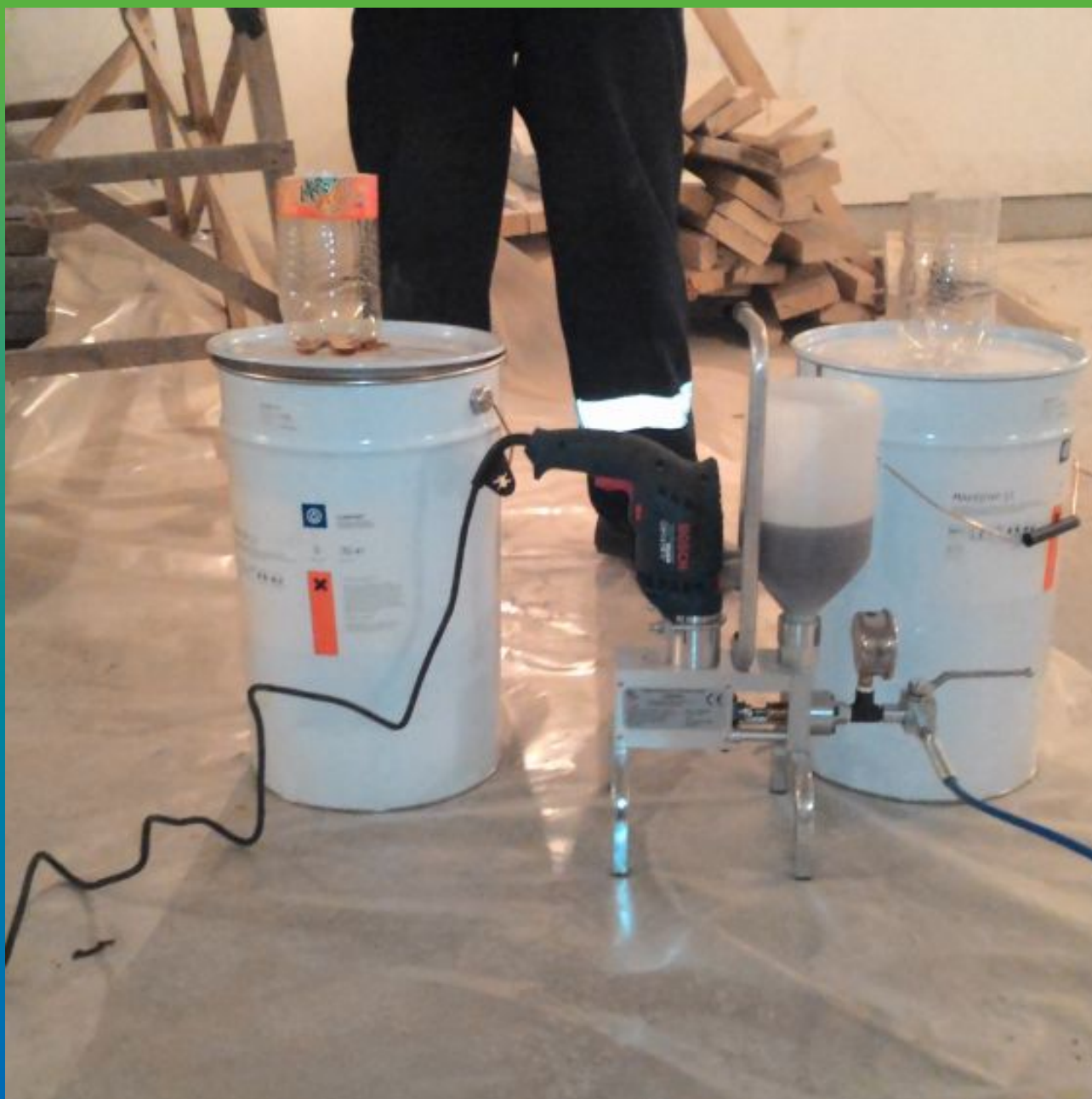
Инъектирование пены Манопур 15.
