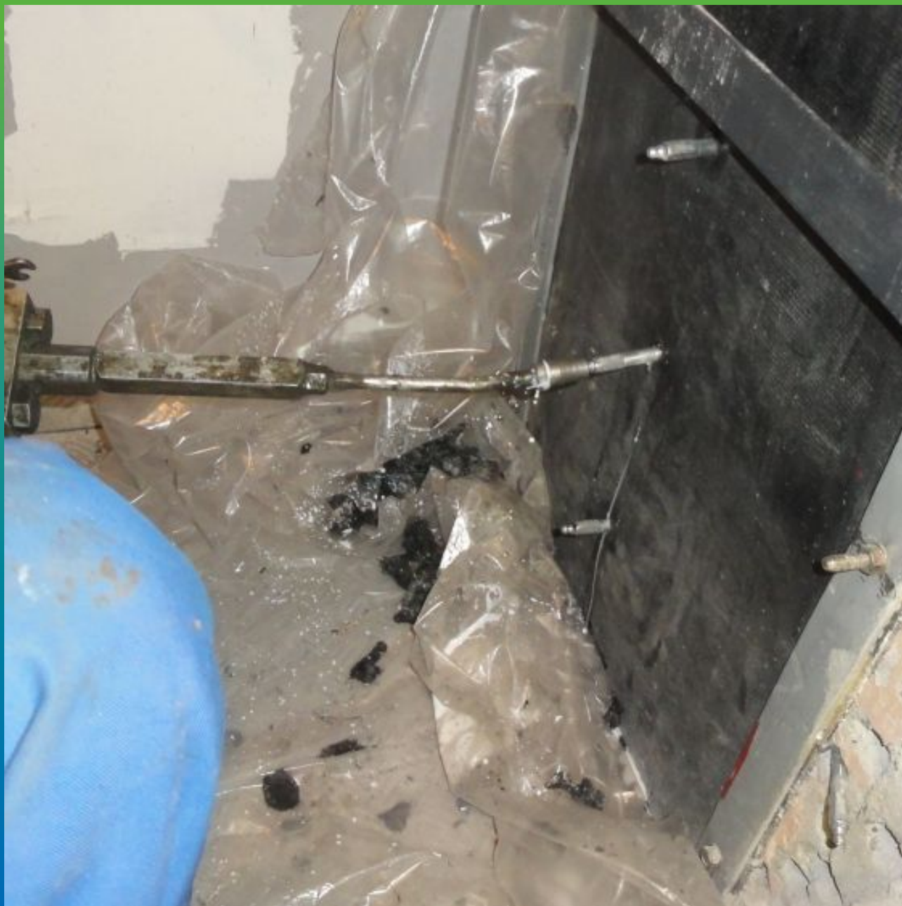
Процесс инъектирования акриллатного геля в деформационный шов
