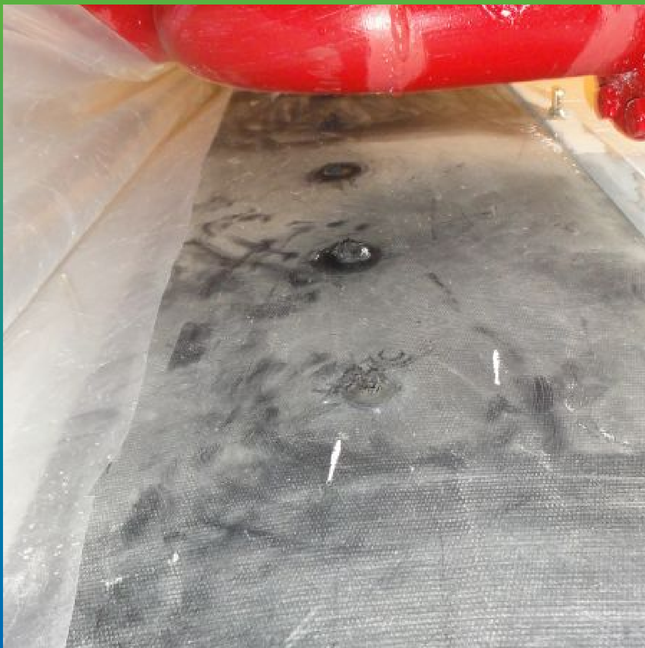
Отверстия под инъекционные пакера
