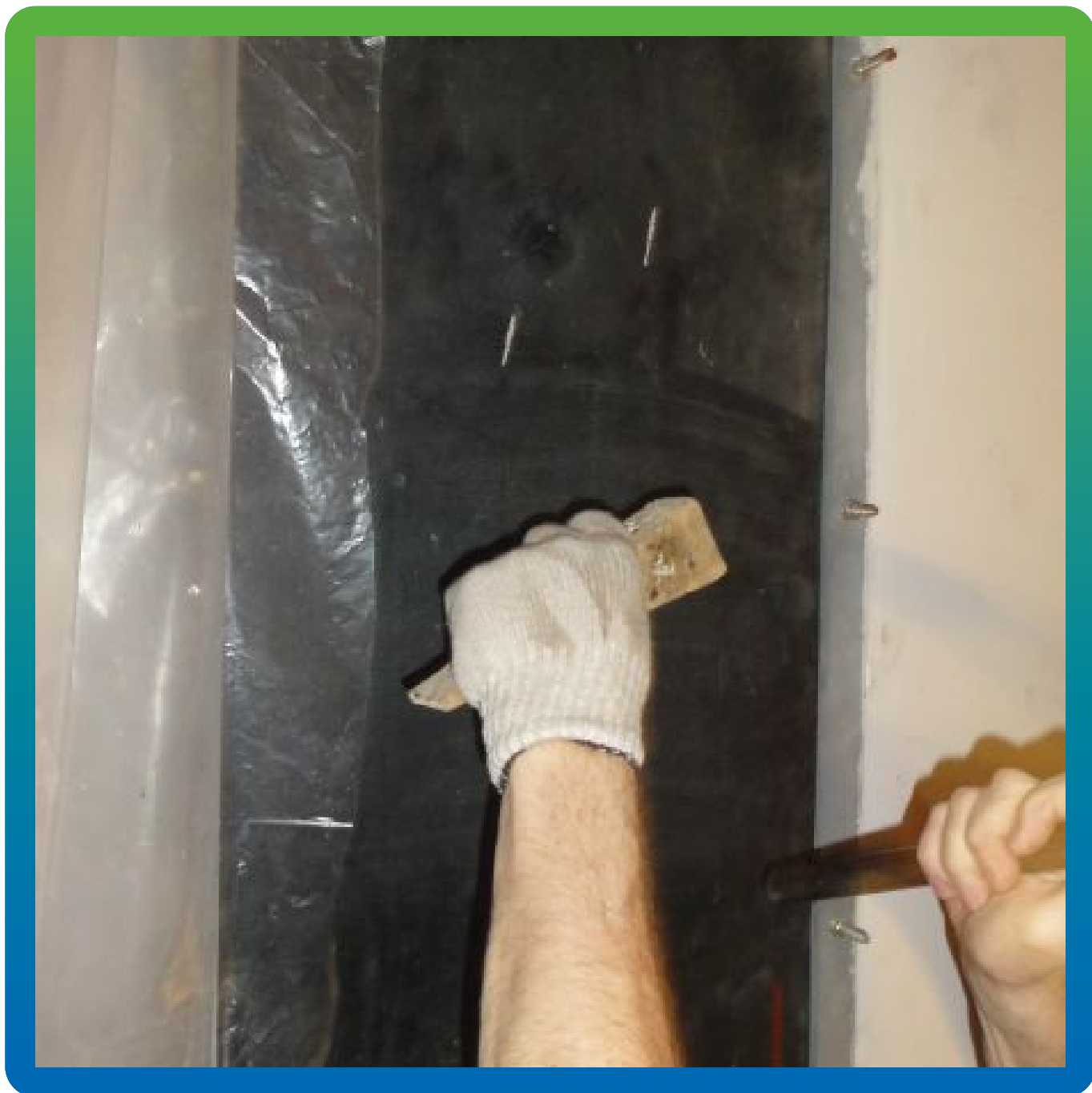
Установка инъекционных пакеров БМ 1133
