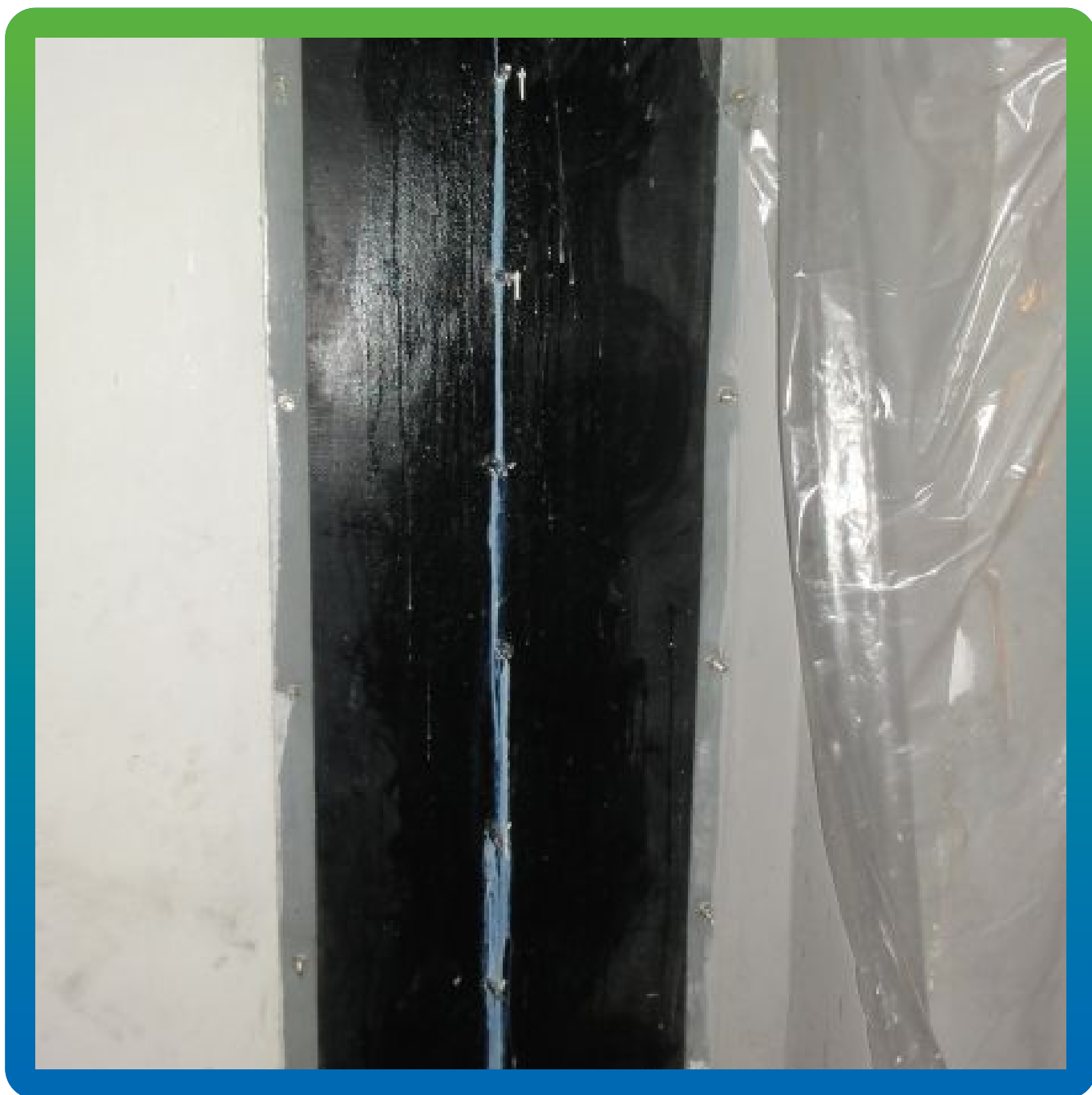
Вид проинъектированного шва
