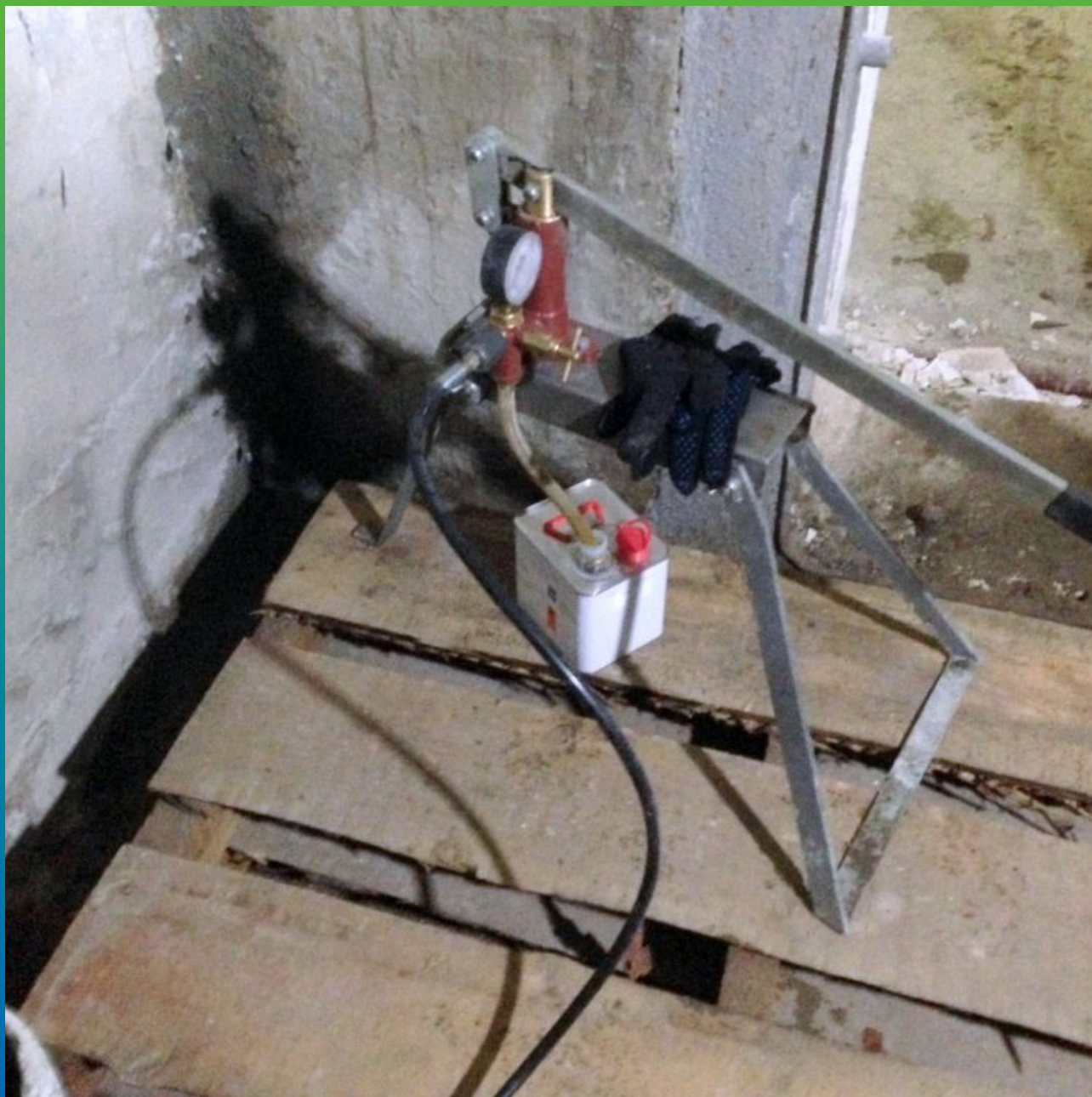
Подготовка оборудования для инъецирования.
