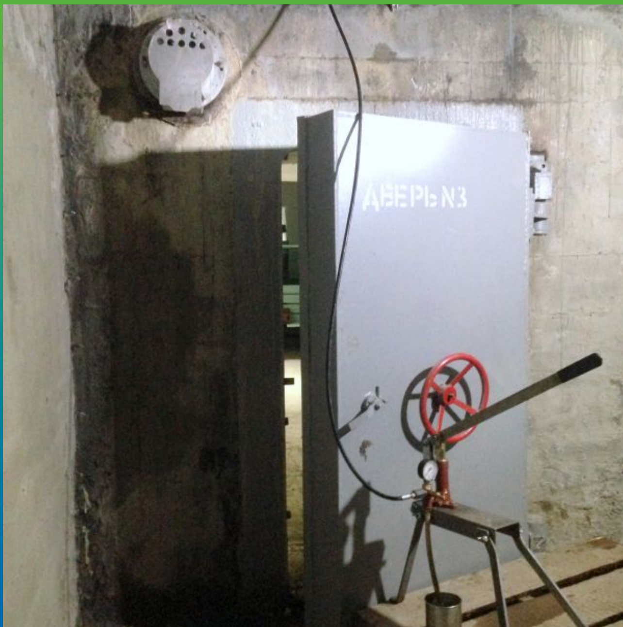
2 Стадия. Процесс инъектирования не вспенивающегося полиуретана Манопур 143.
