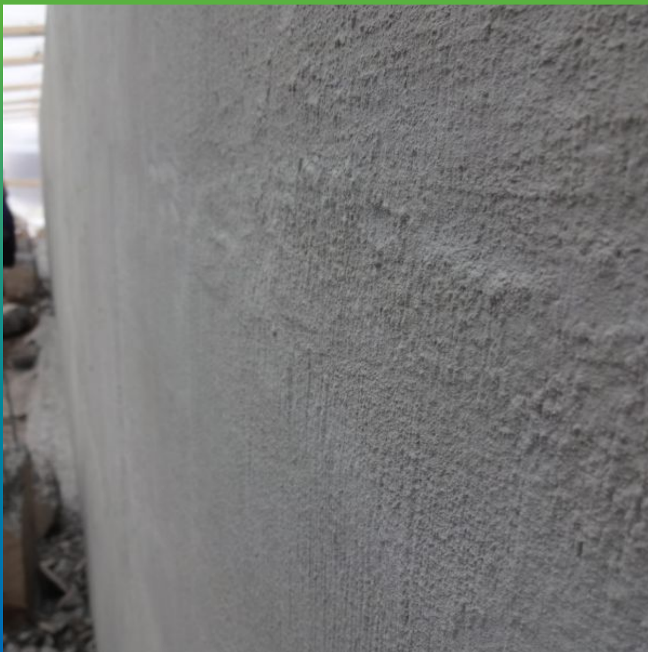
Гидроизоляция конструкции эластичным Материалом Максил Флекс
