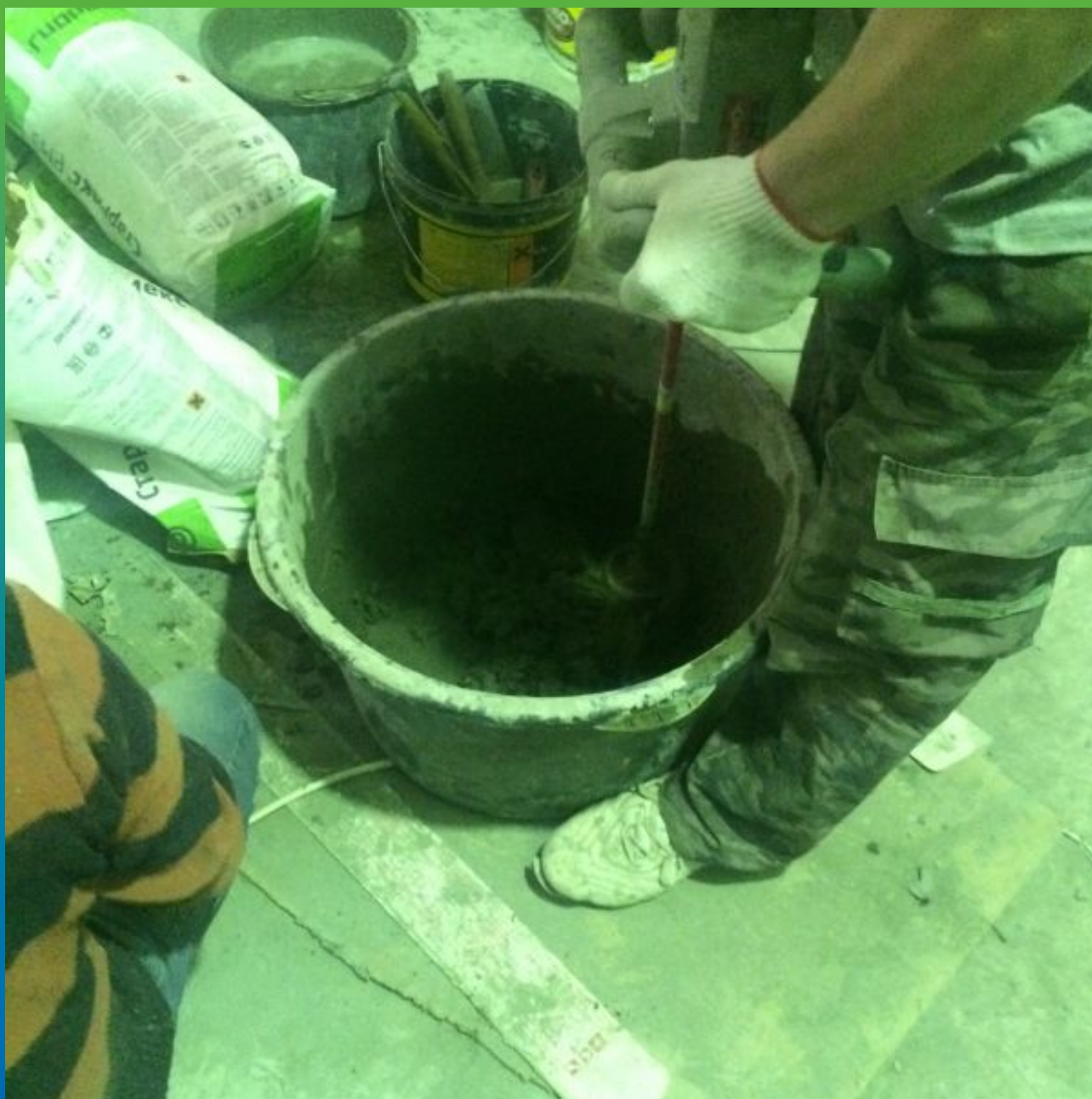
Приготовление ремонтного состава Стармекс РМЗ
