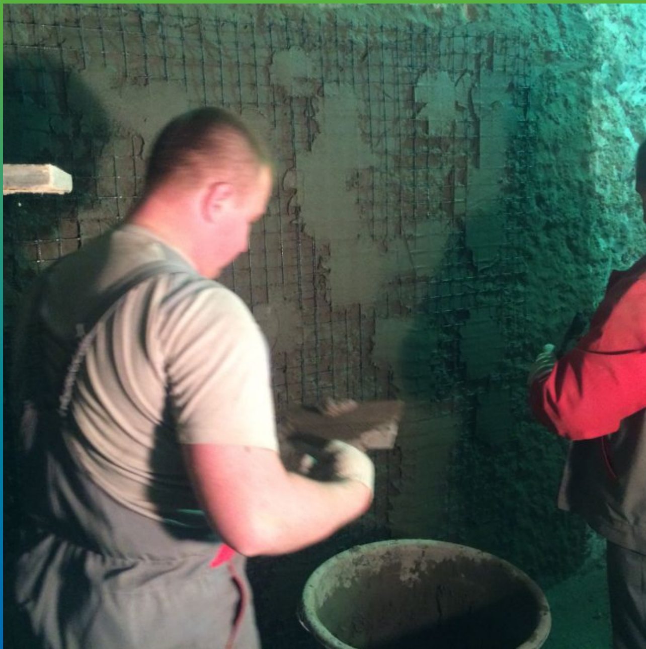
Нанесение ремонтного состава Стармекс РМЗ
