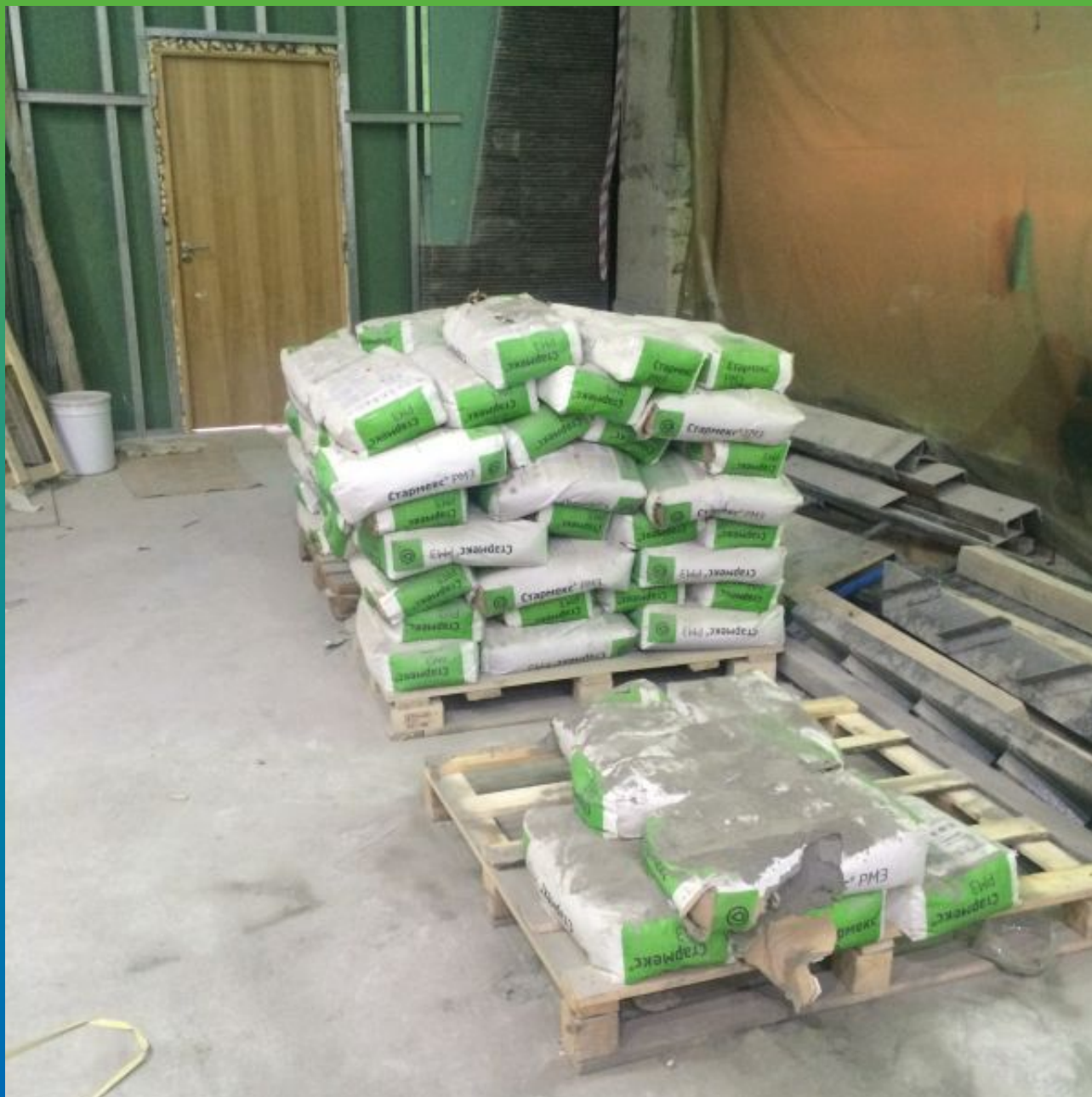
Материал Стармекс РМЗ на объекте
