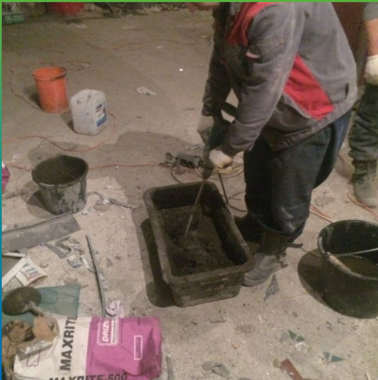
Приготовление ремонтного состава Максрайт 500
