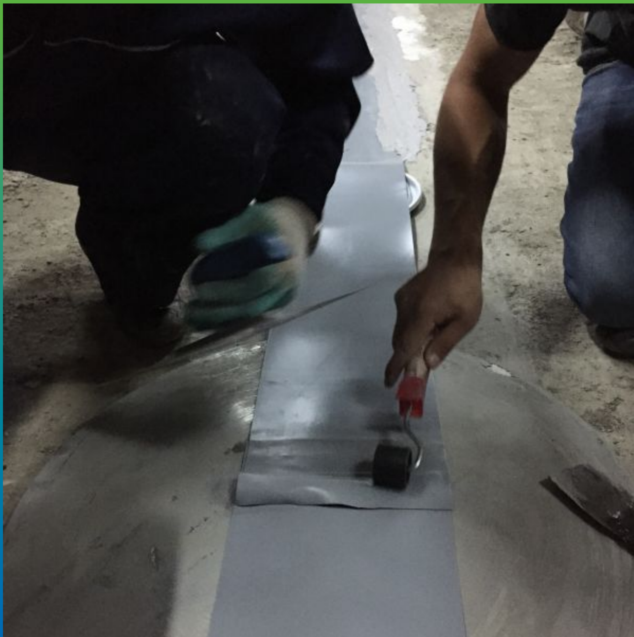
Монтаж ленты Манодил Про (сварка концов между собой)
