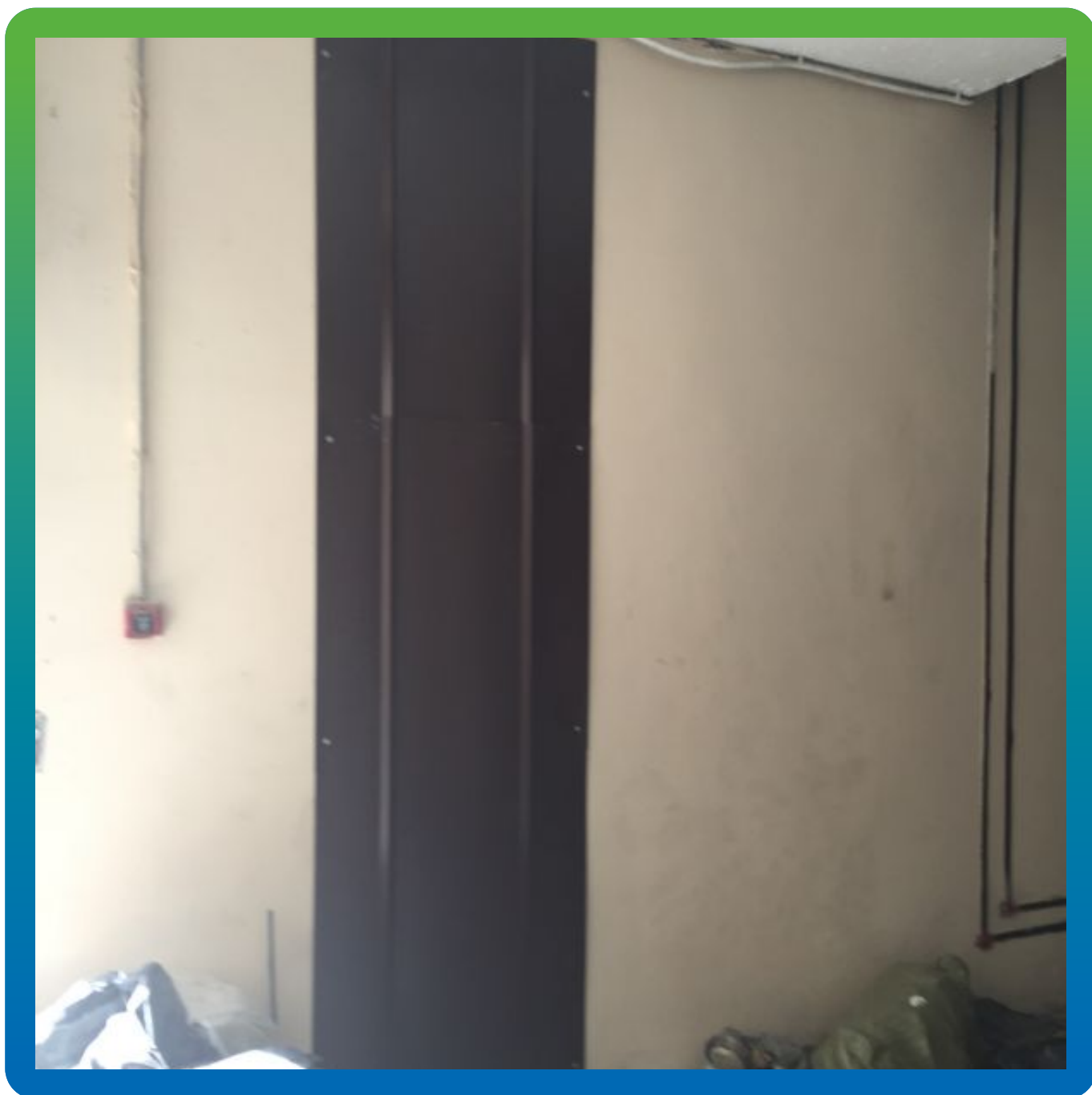
Окончательный вид шва
