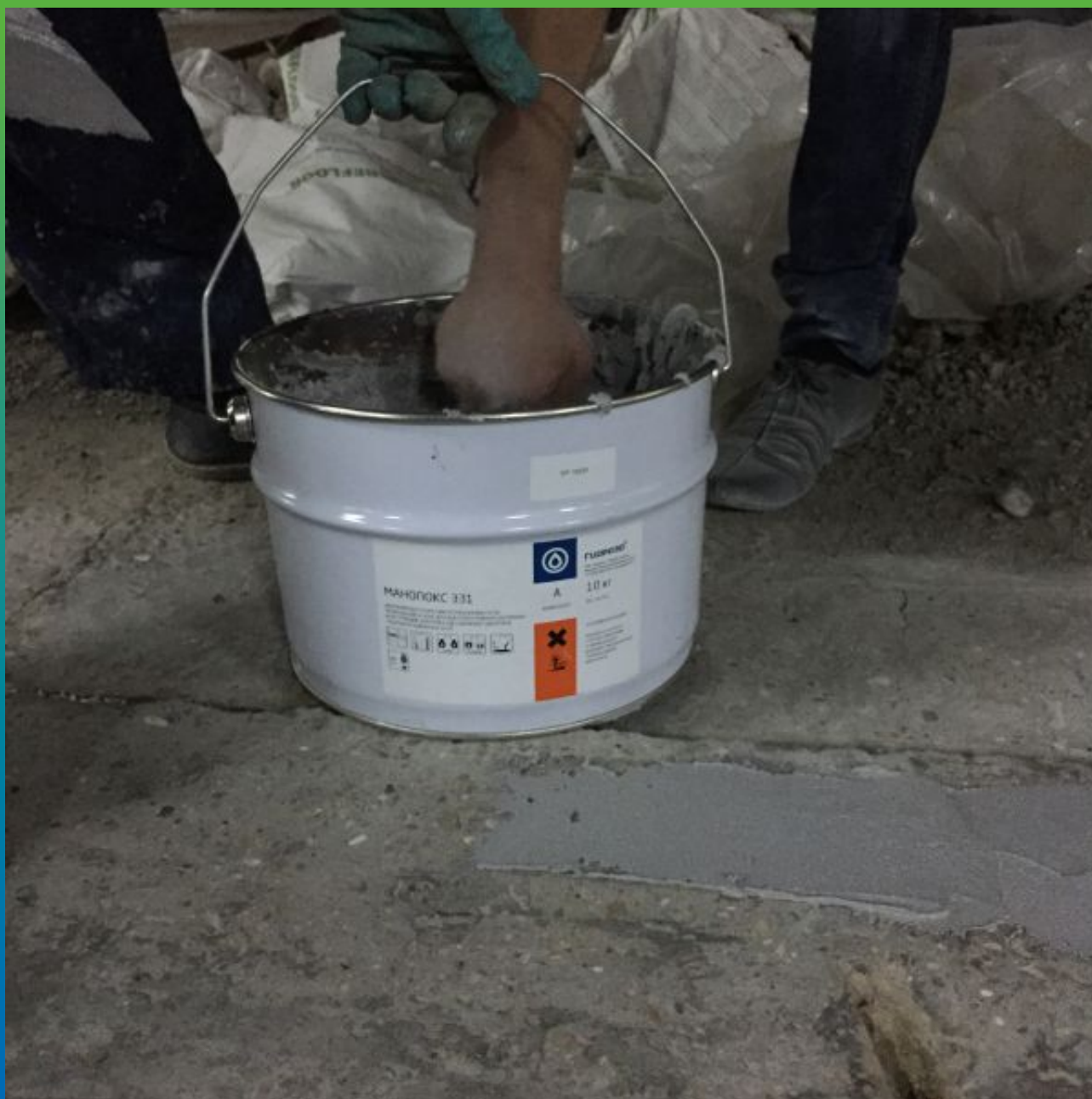
Нанесение основного слоя Манопокс 331
