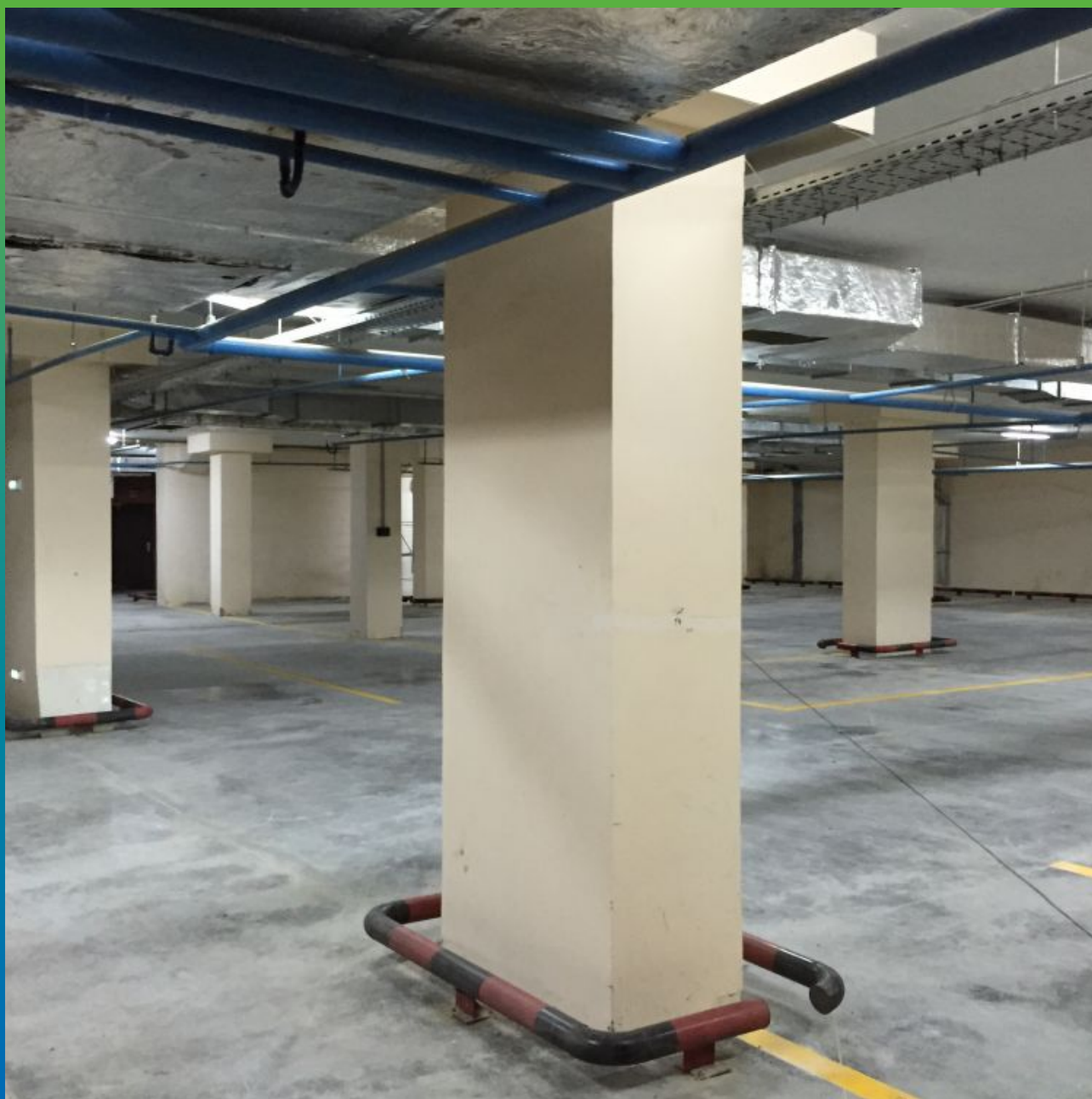
Окончательный вид парковки
