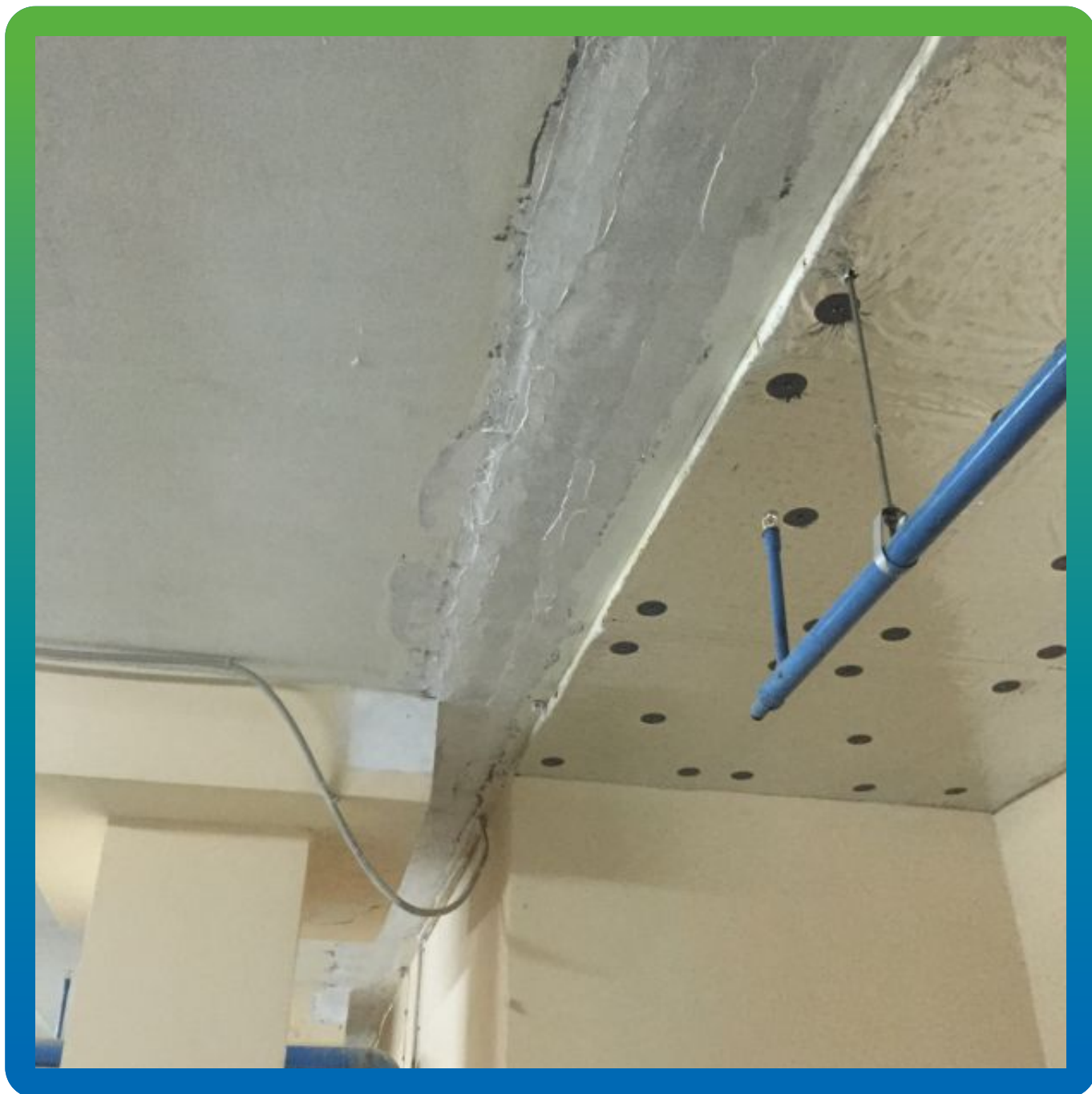
Окончательный вид шва
