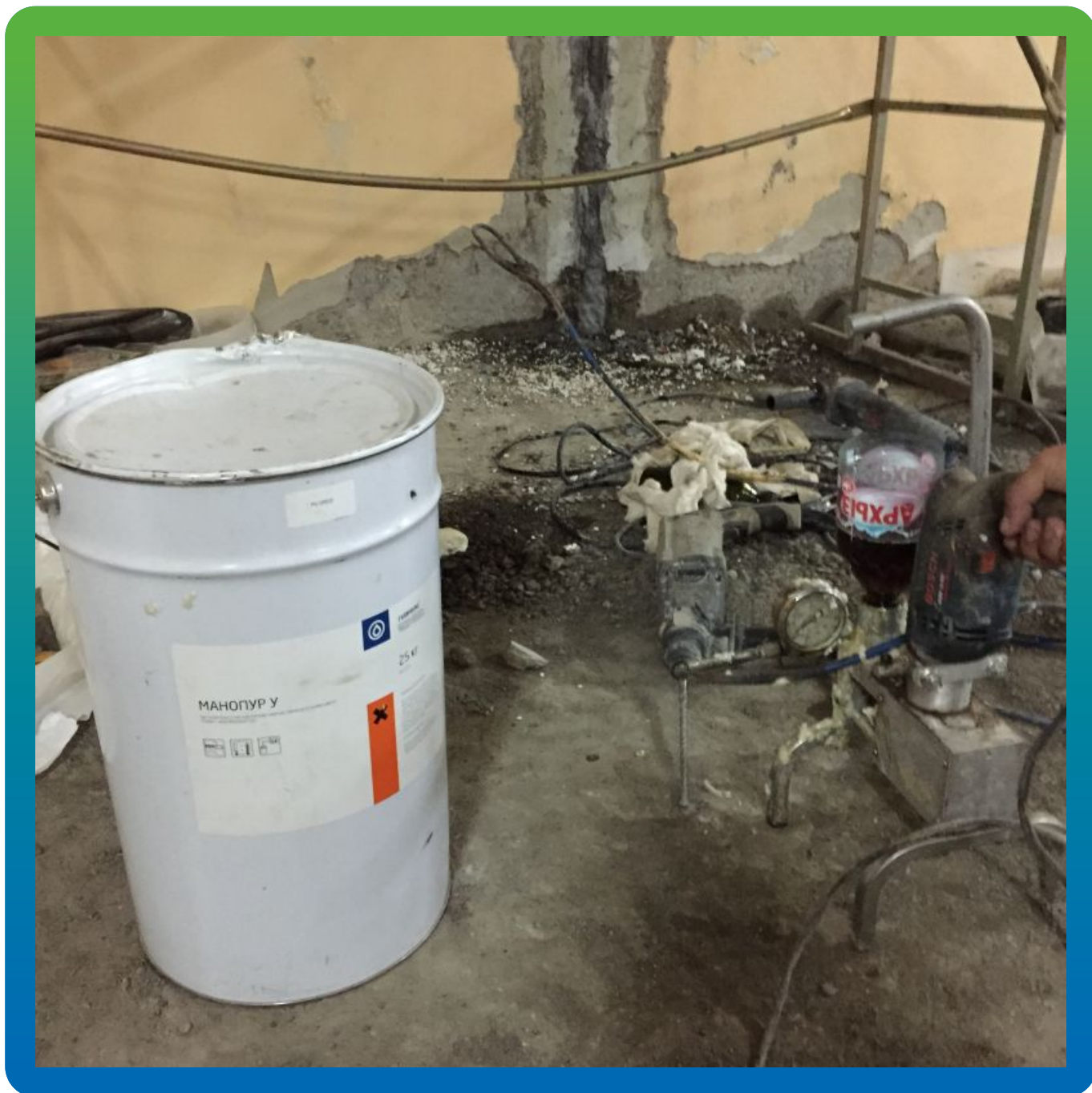
Инъектирование шва гидроактивной смолой Манопур У
