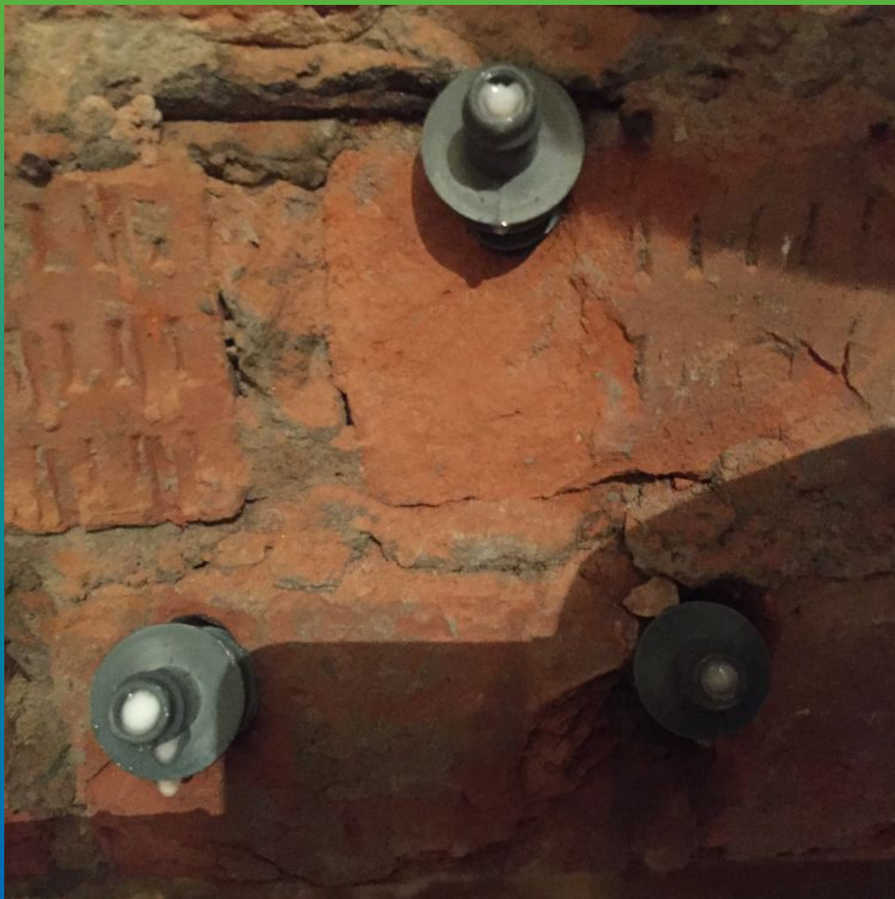
Отверстия, прокаченные Манокрил Гель В-Р
