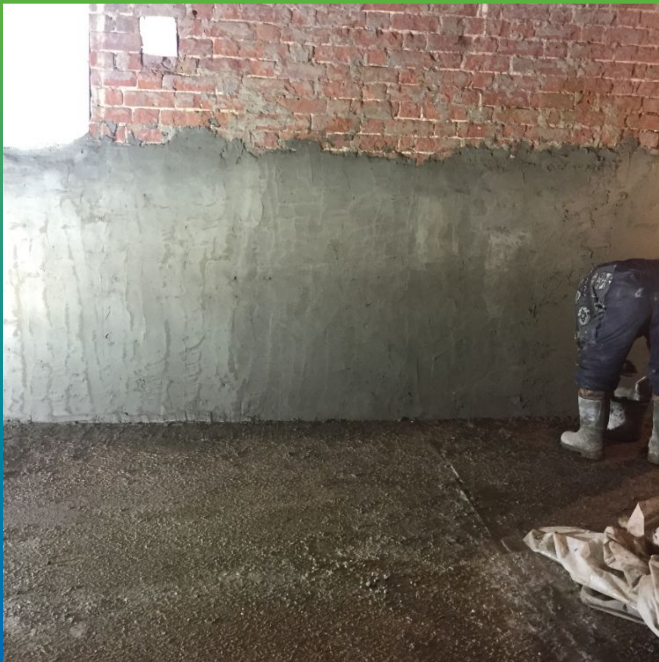
Оштукатуривание поверхности после прокачки Манокрил гель В
