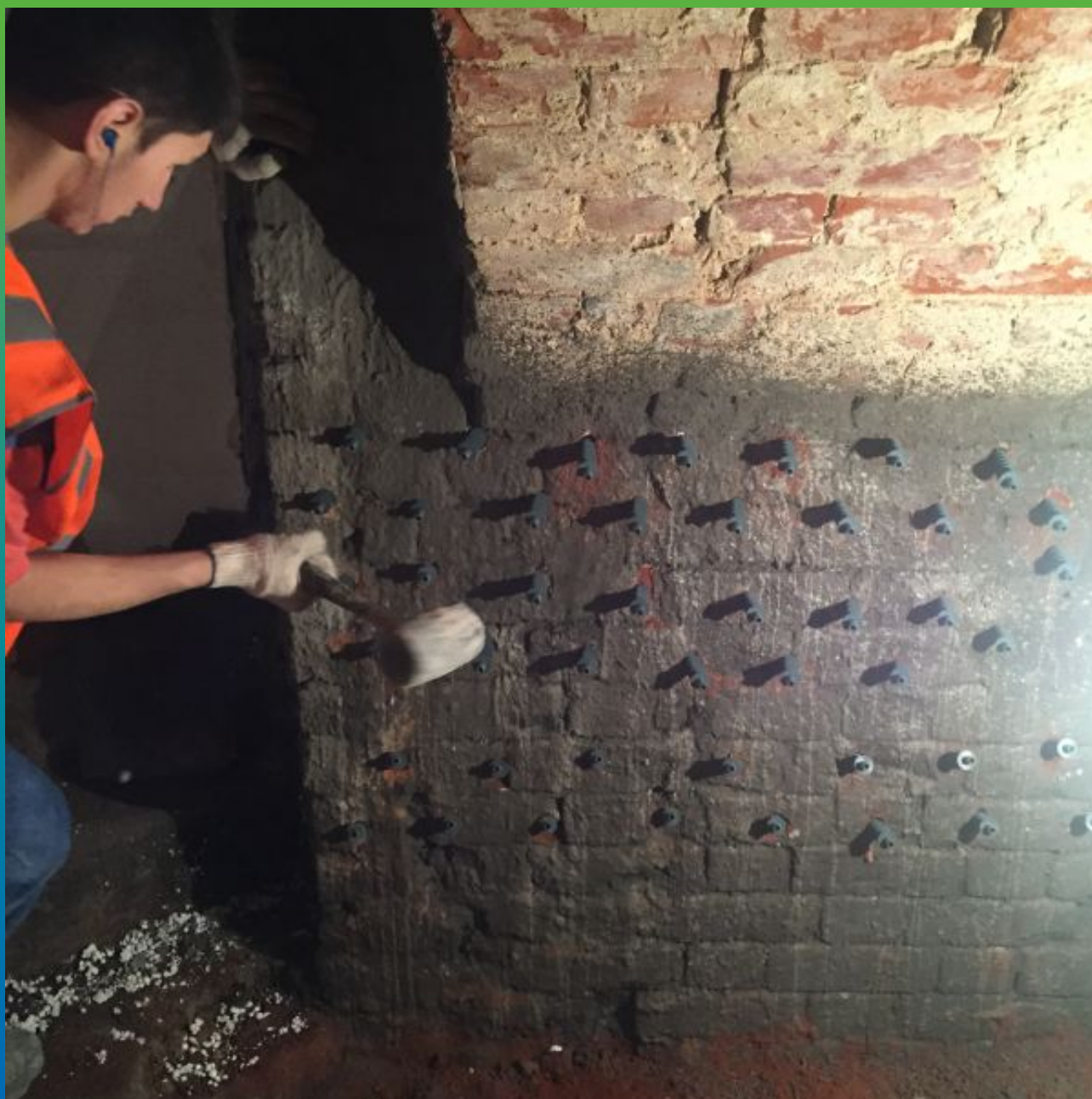
Монтаж пакеров БМ 2830
