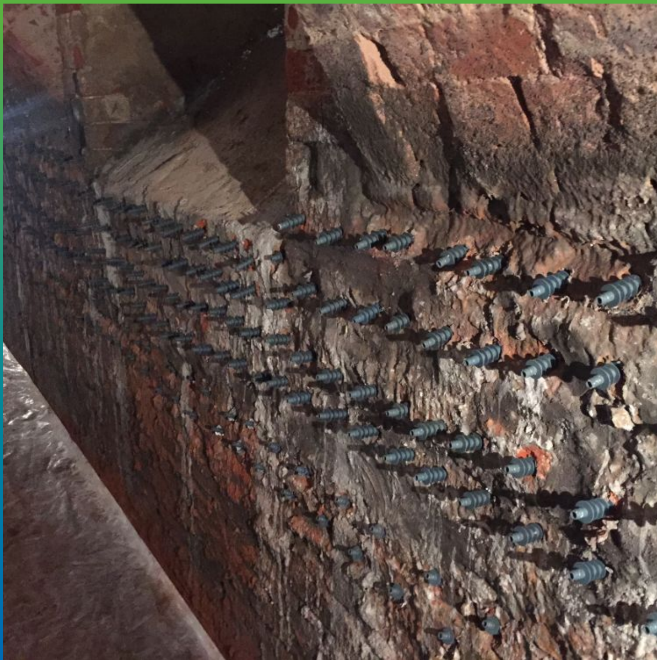
Подготовленная к инъектированию стена
