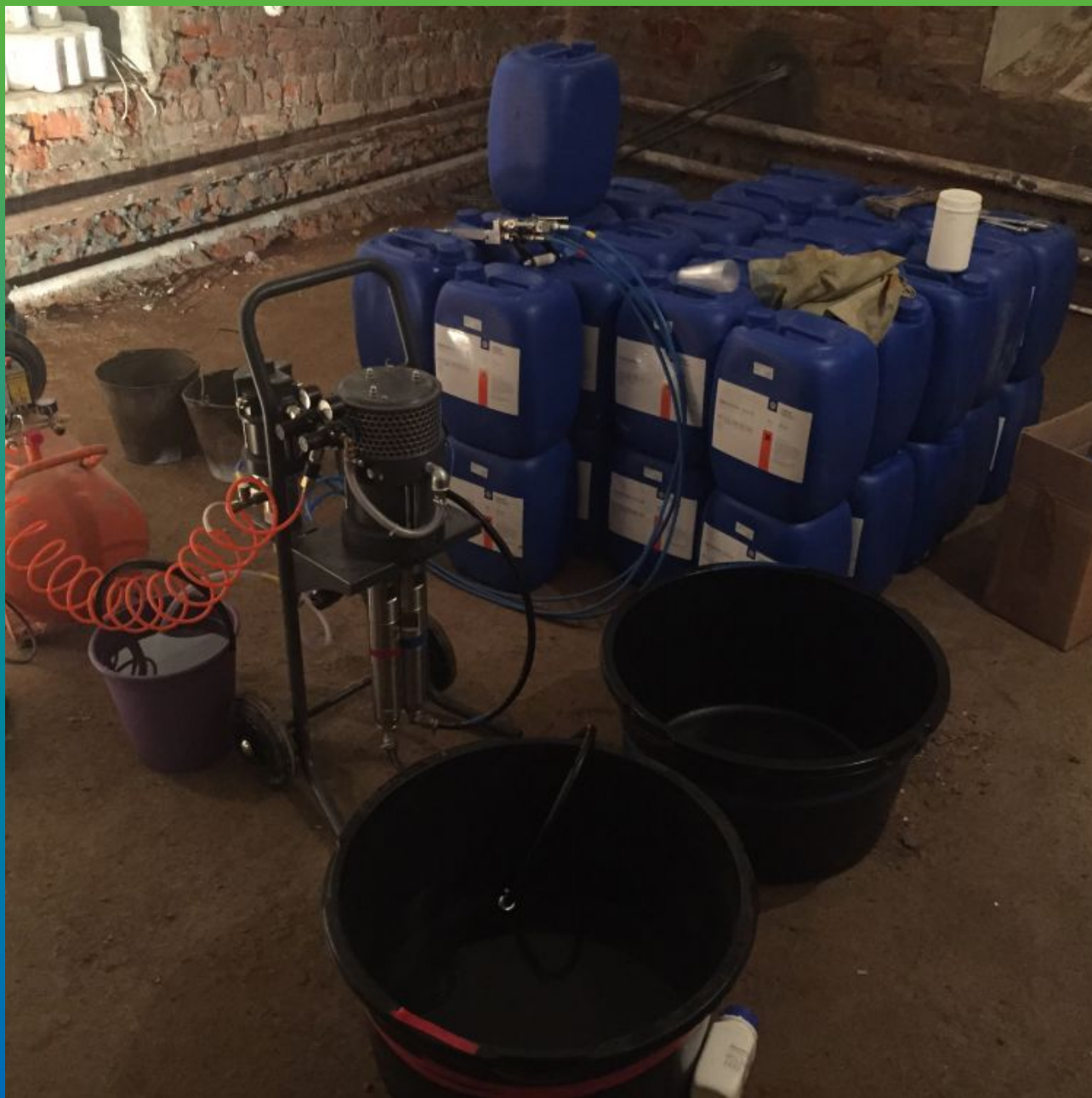
Подготовка насоса БМ 1425 и материала Манокрил Гель В-Р
