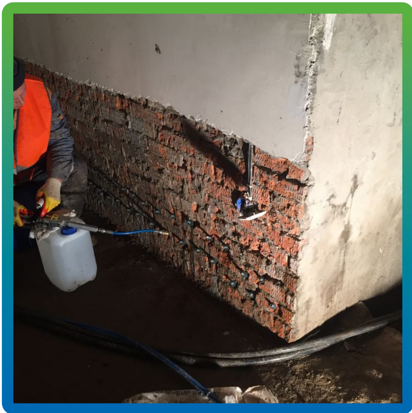
Инъектирование геля Манокрил Гель В
