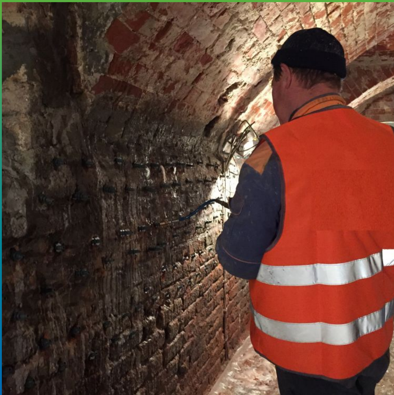
Инъектирование геля Манокрил Гель В
