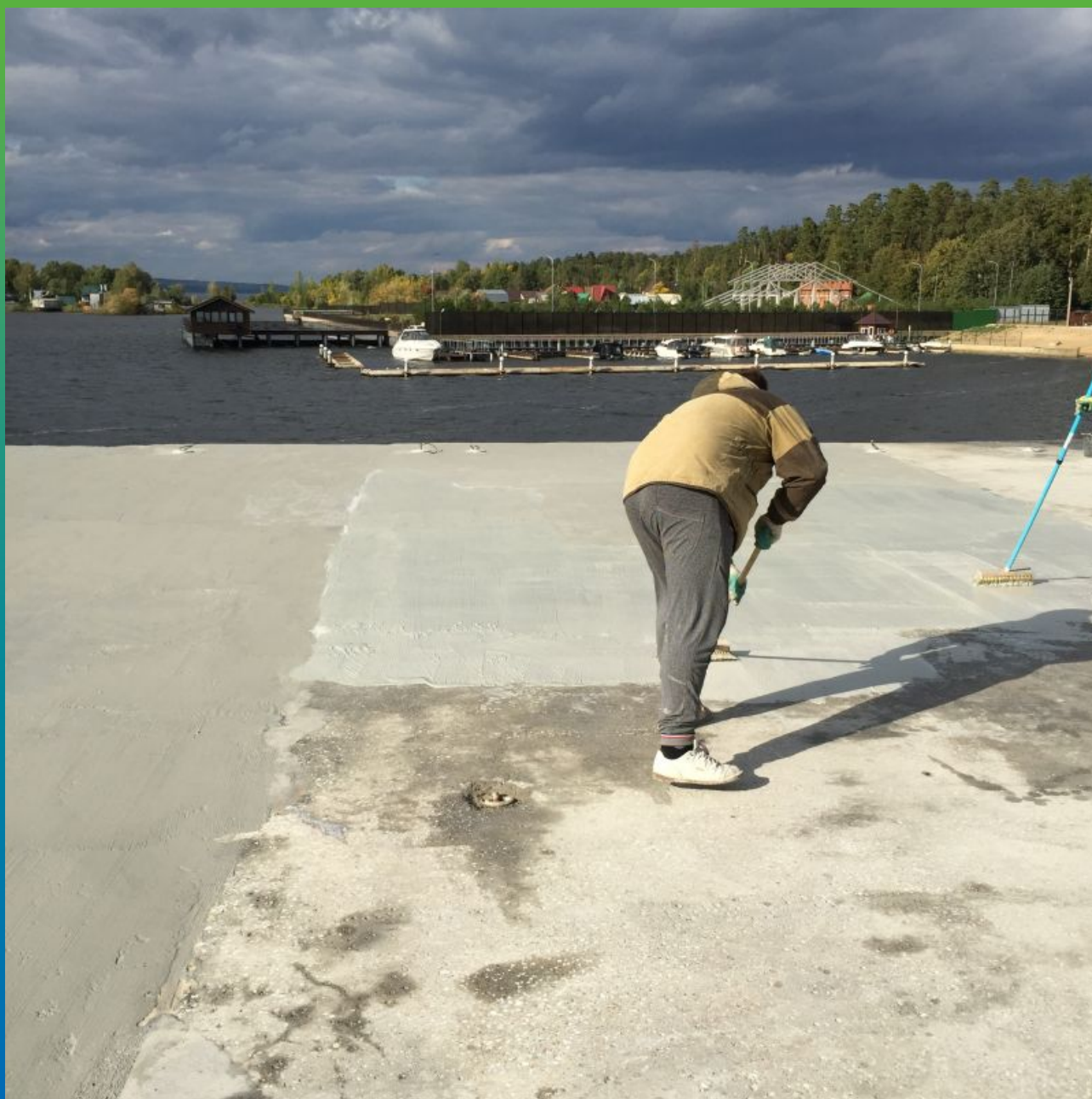
Нанесение первого слоя Максил Флекс
