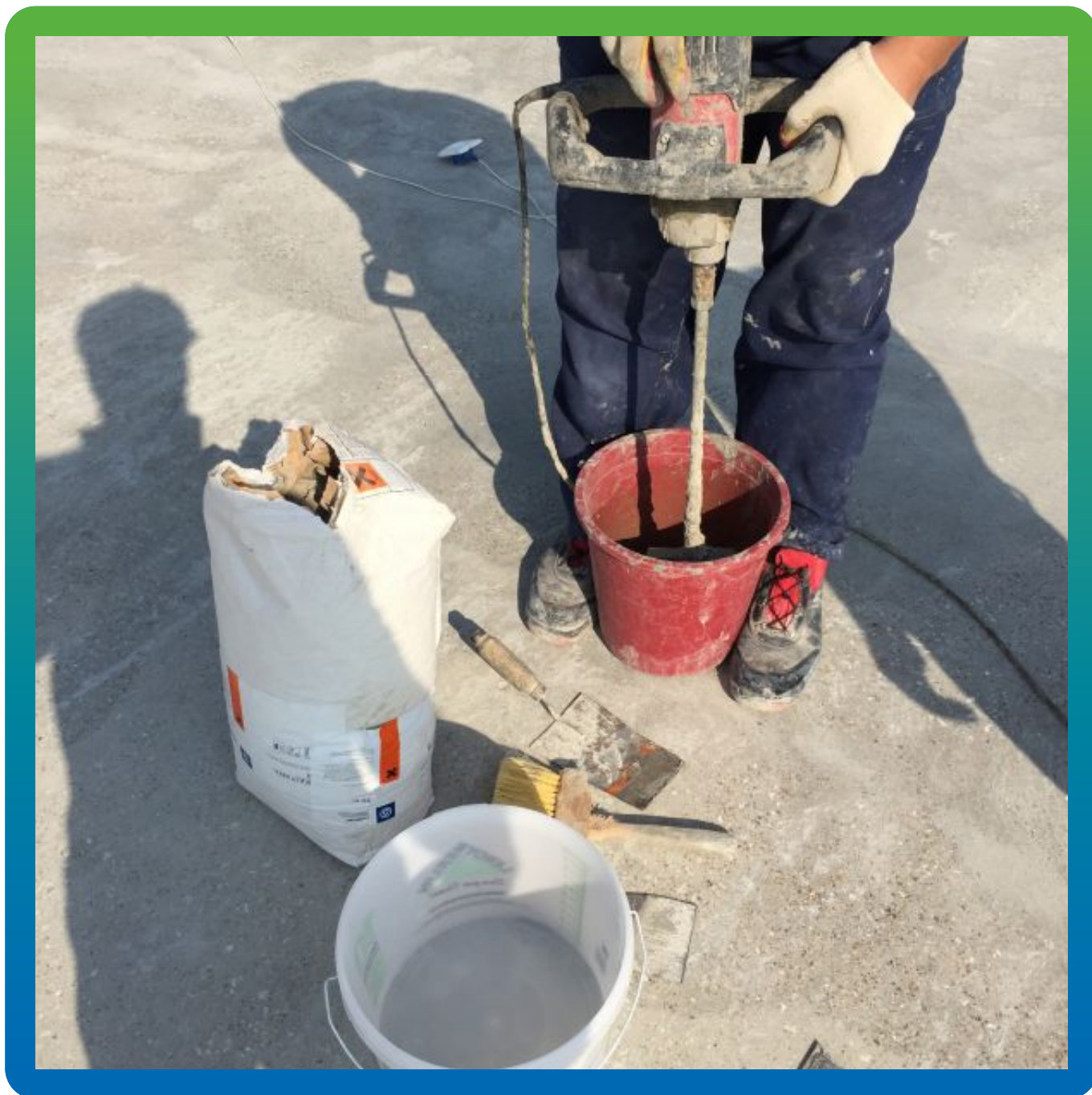
Приготовление состава Стармекс РМЗ для устранения дефектов основания
