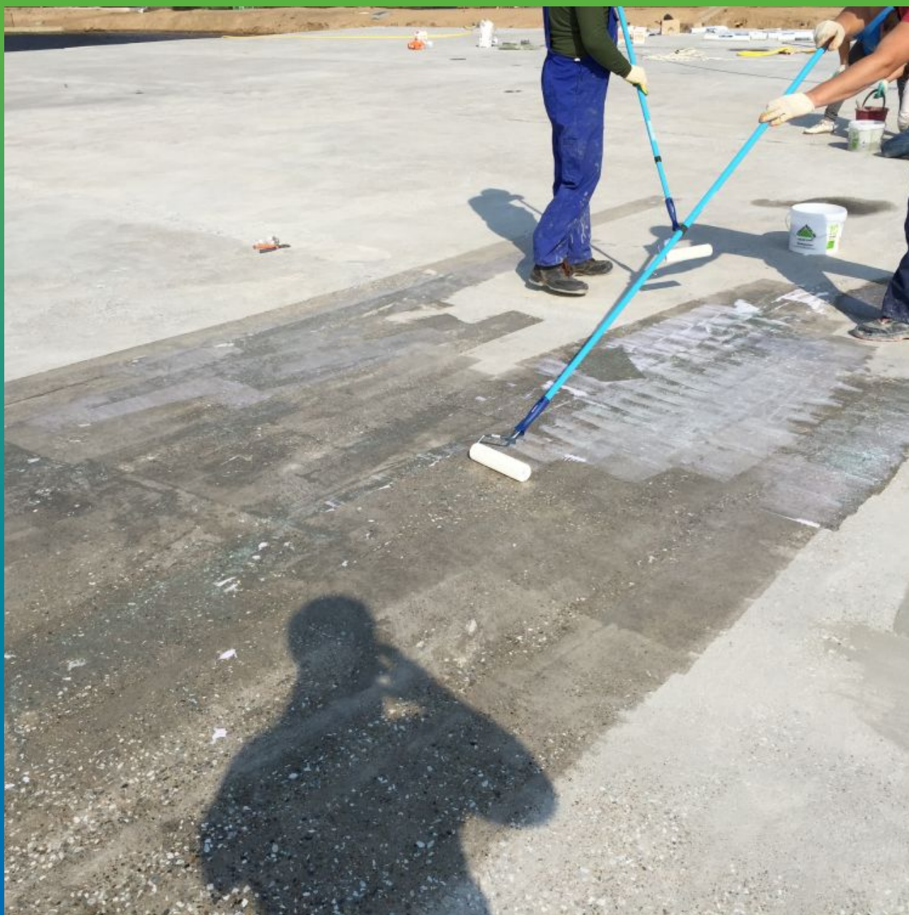
Грунтование поверхности
