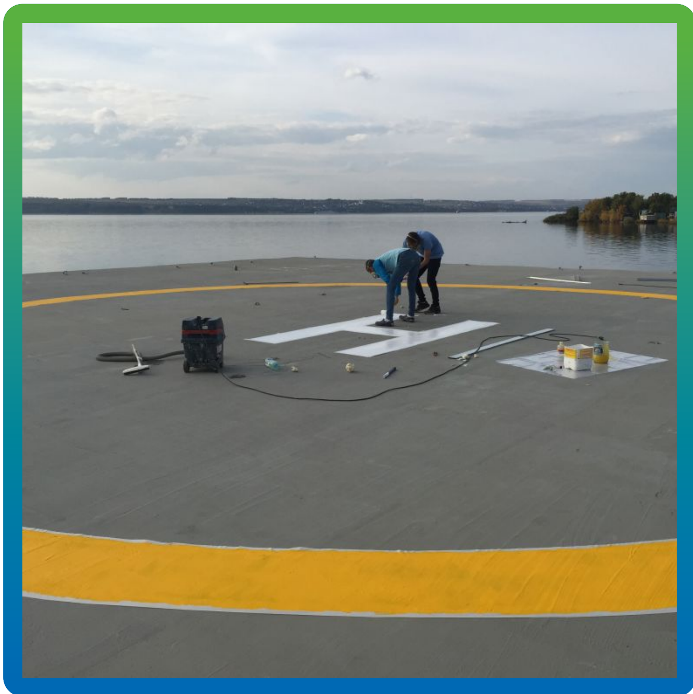
Нанесение разметки
