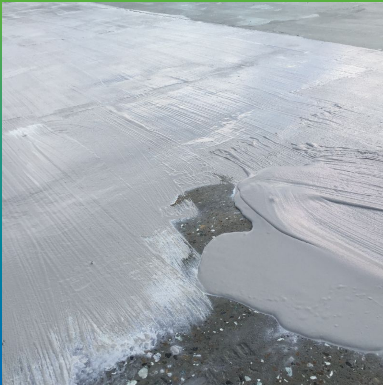
Нанесение первого слоя Максил Флекс
