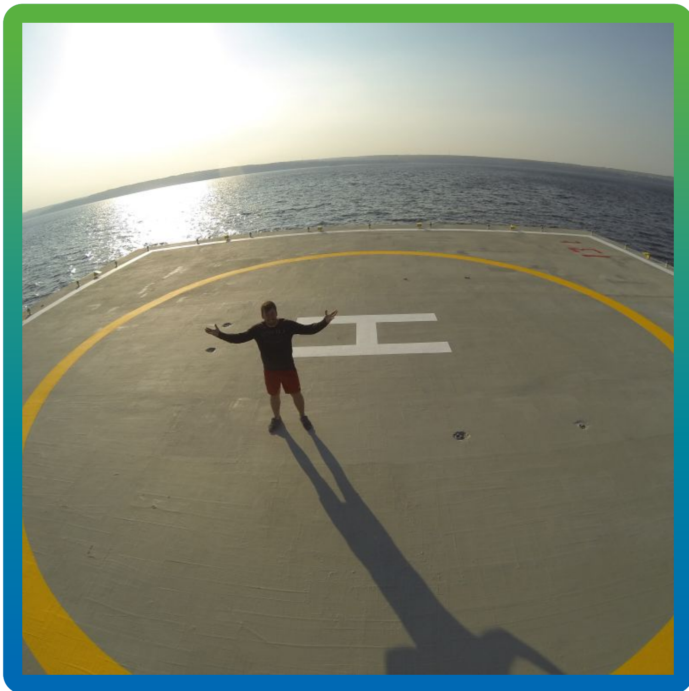
Конечный вид вертолетной площадки
