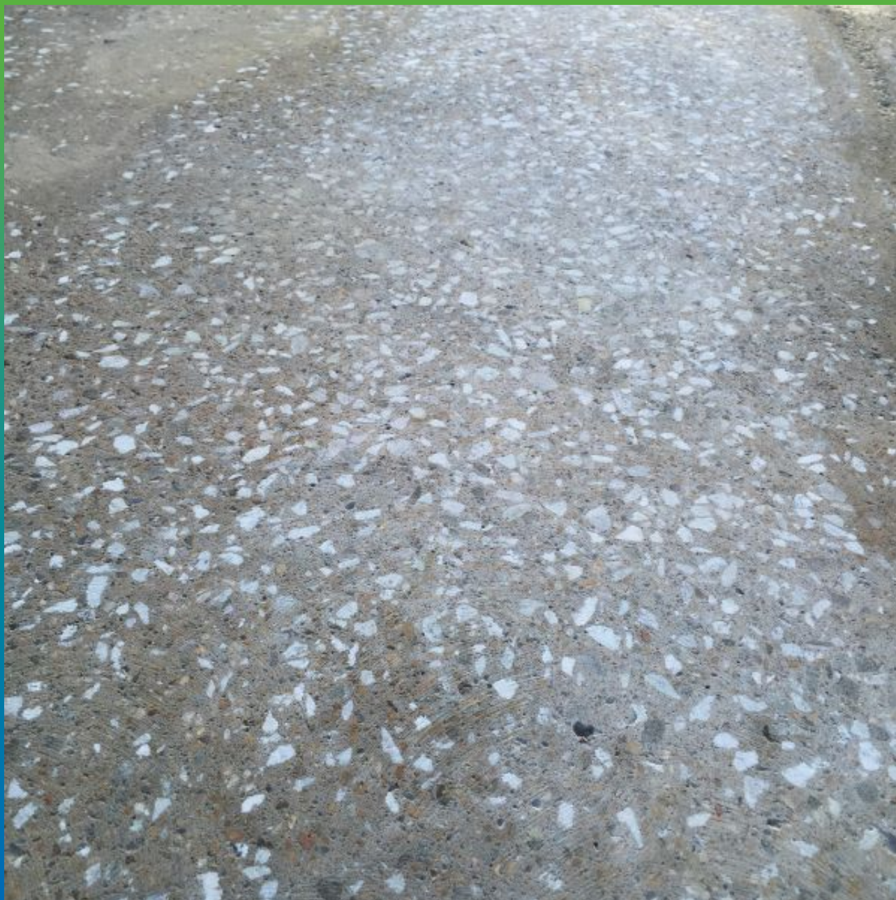
Вид отшлифованной и вымытой ж/б поверхности
