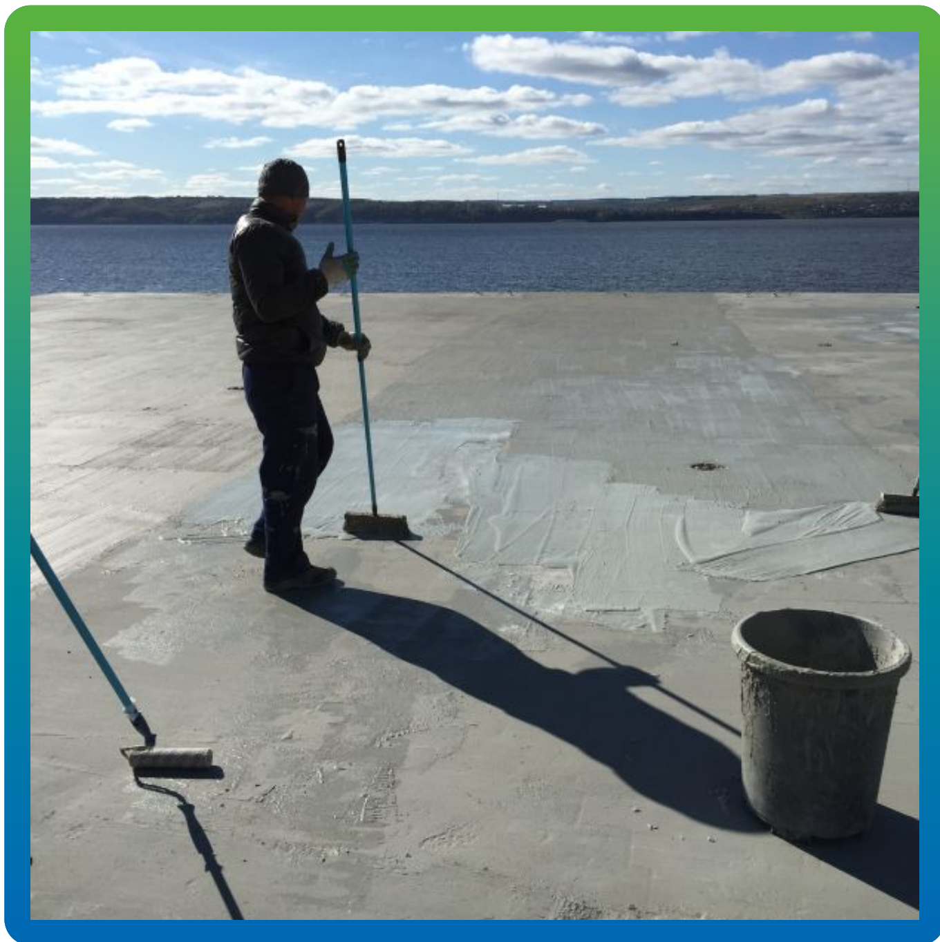
Нанесение второго слоя Максил Флекс
