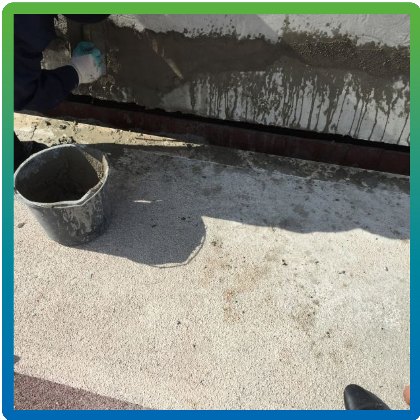
Устранение дефектов основания составом Стармекс РМЗ
