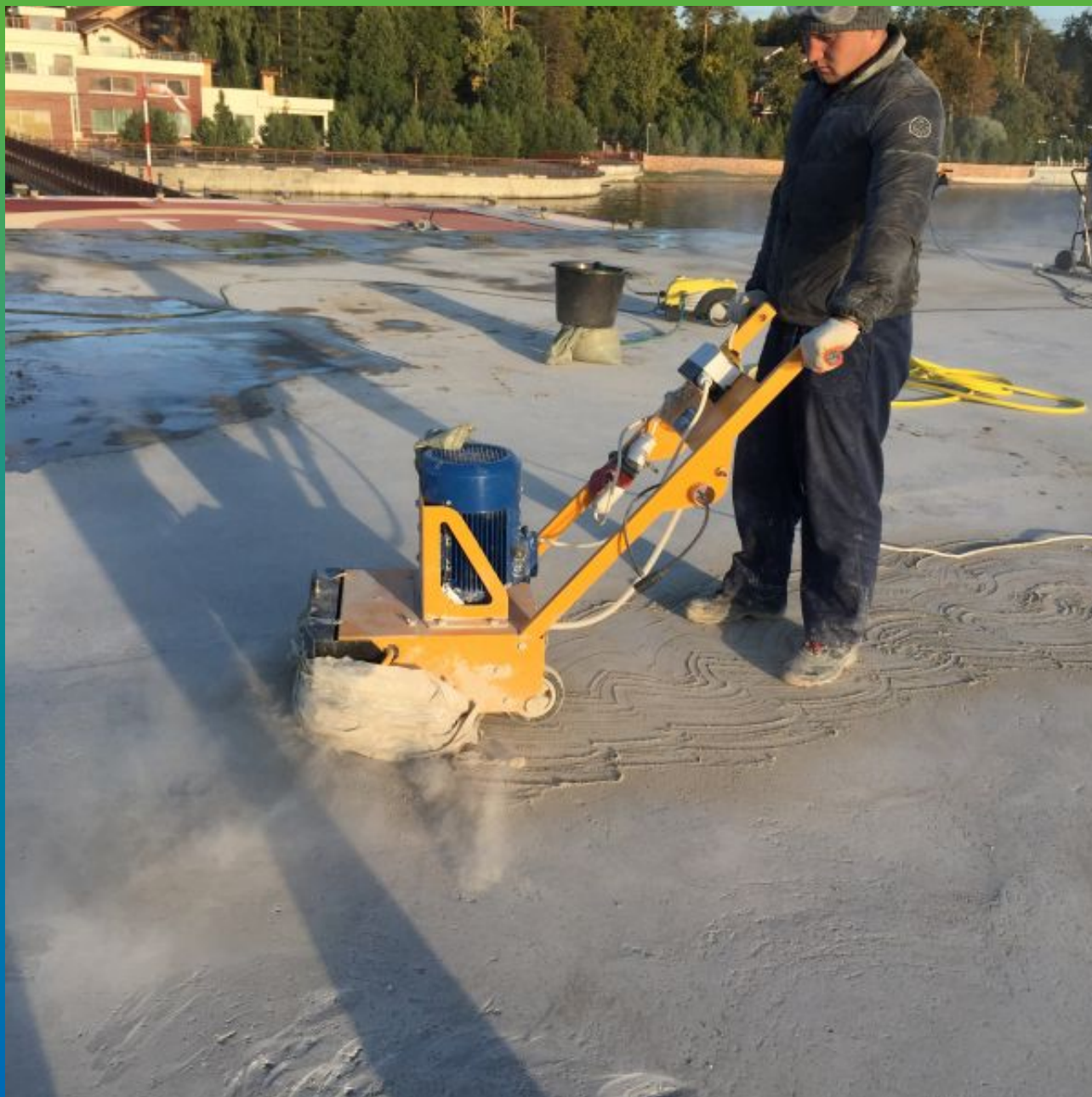
Шлифовка поверхности перед нанесением материала Макссил Флекс
