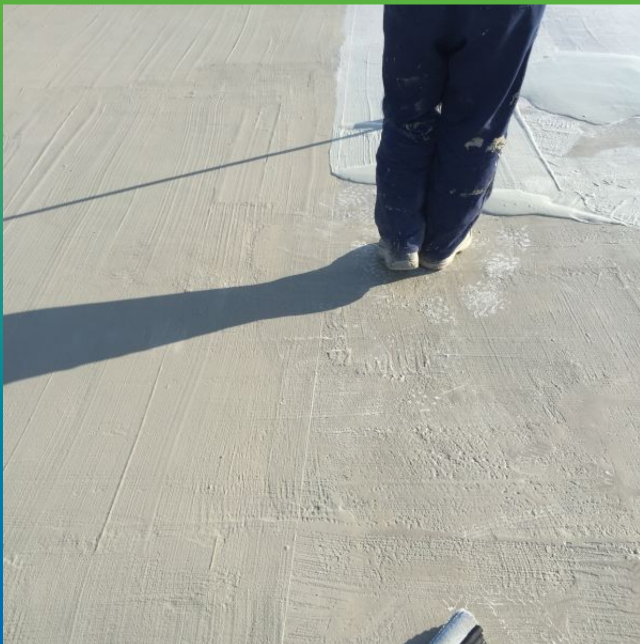
Нанесение третьего слоя максил Флекс
