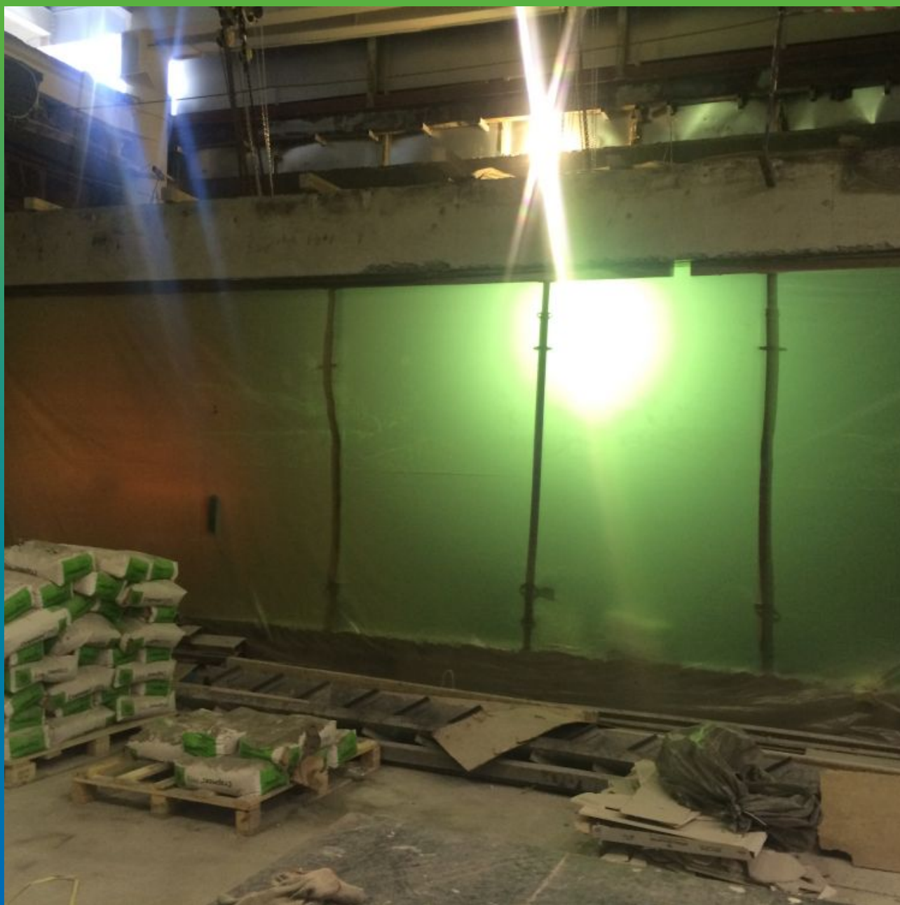
Общий вид аквариума в процессе работ
