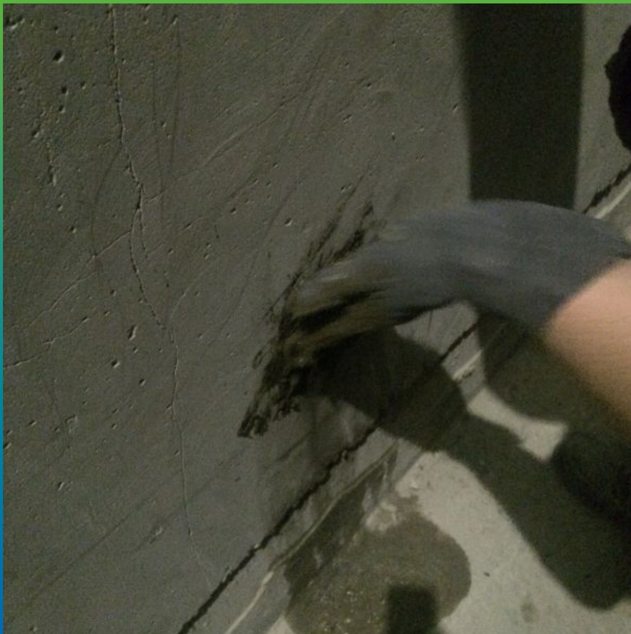
Заделка отверстия от опалубки вручную
