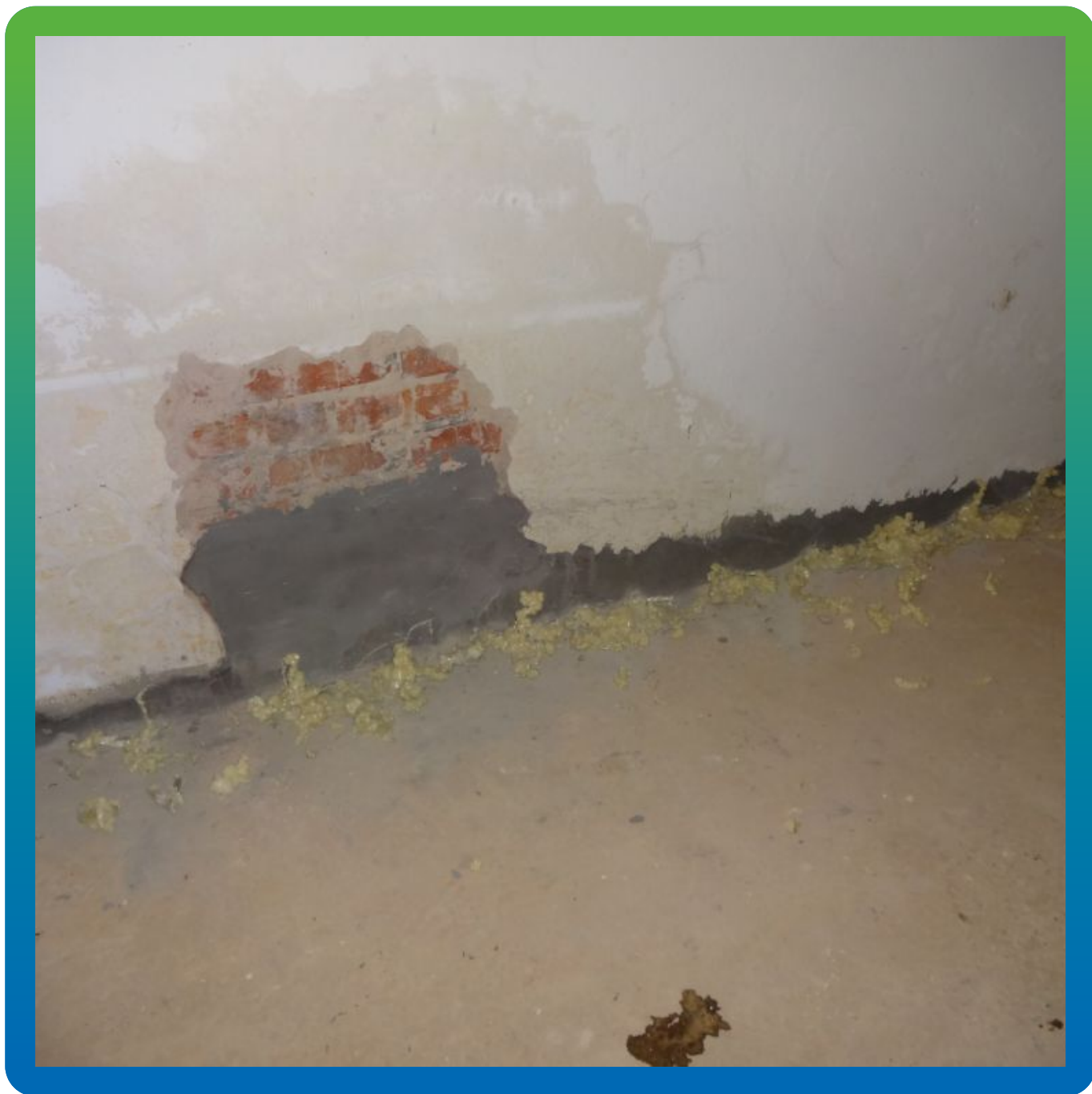
Устранение протечек вспенивающимся ПУ Манопур У
