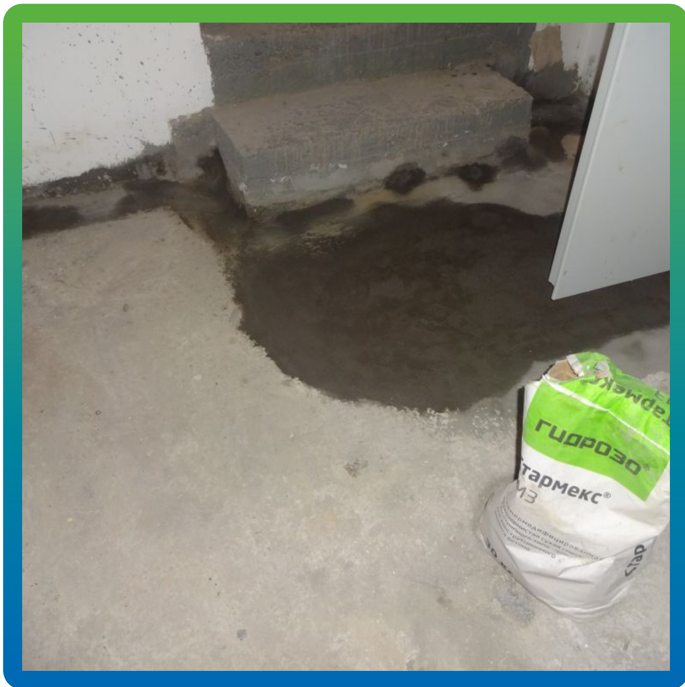
Ремонт швов составом Стармекс М3
