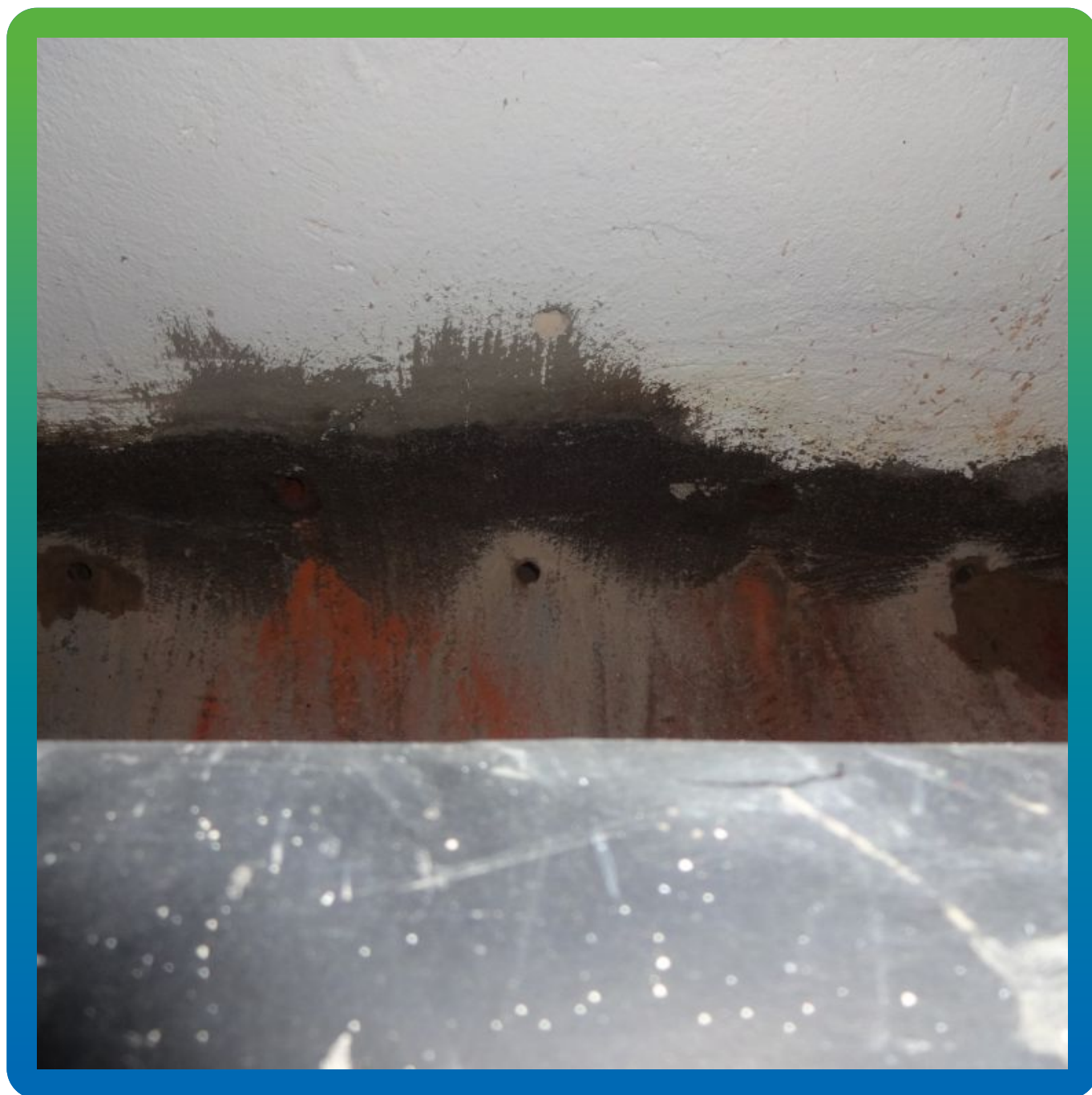
Установка пакеров БМ 1100 в пробуренные шпуры
