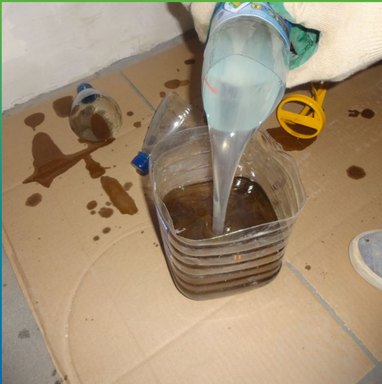
Затворение А+В компонентов м/у собой не вспенивающегося ПУ Манопур 143
