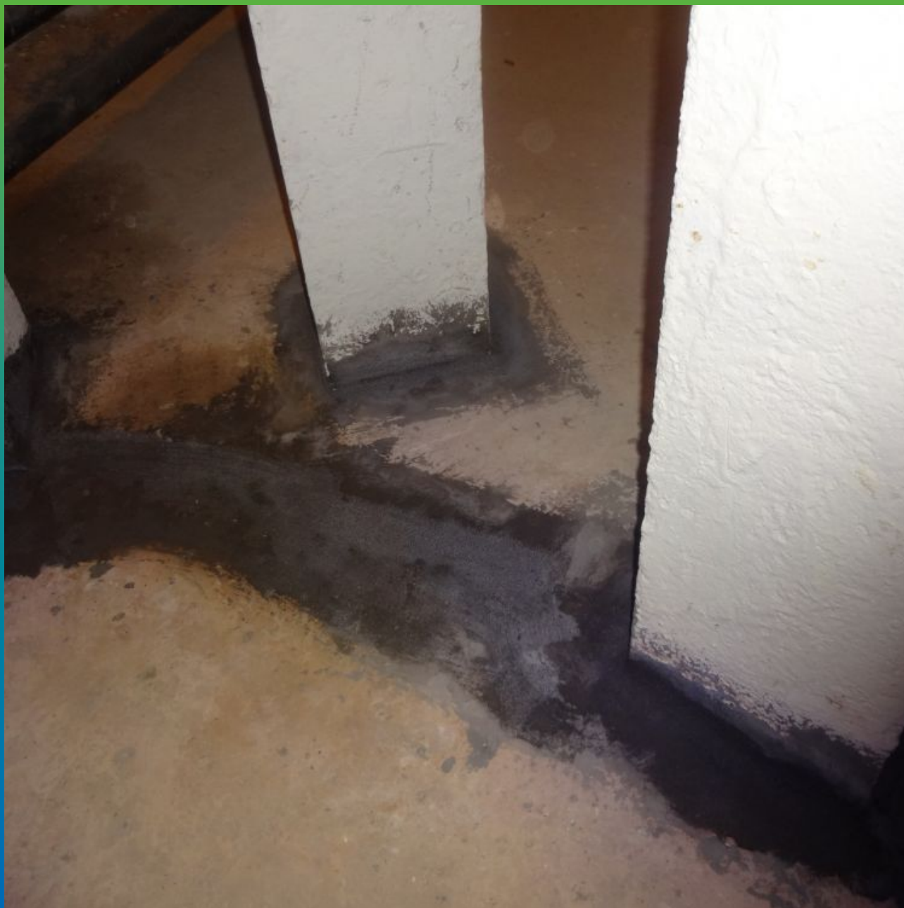
Ремонт швов составом Стармекс РМЗ
