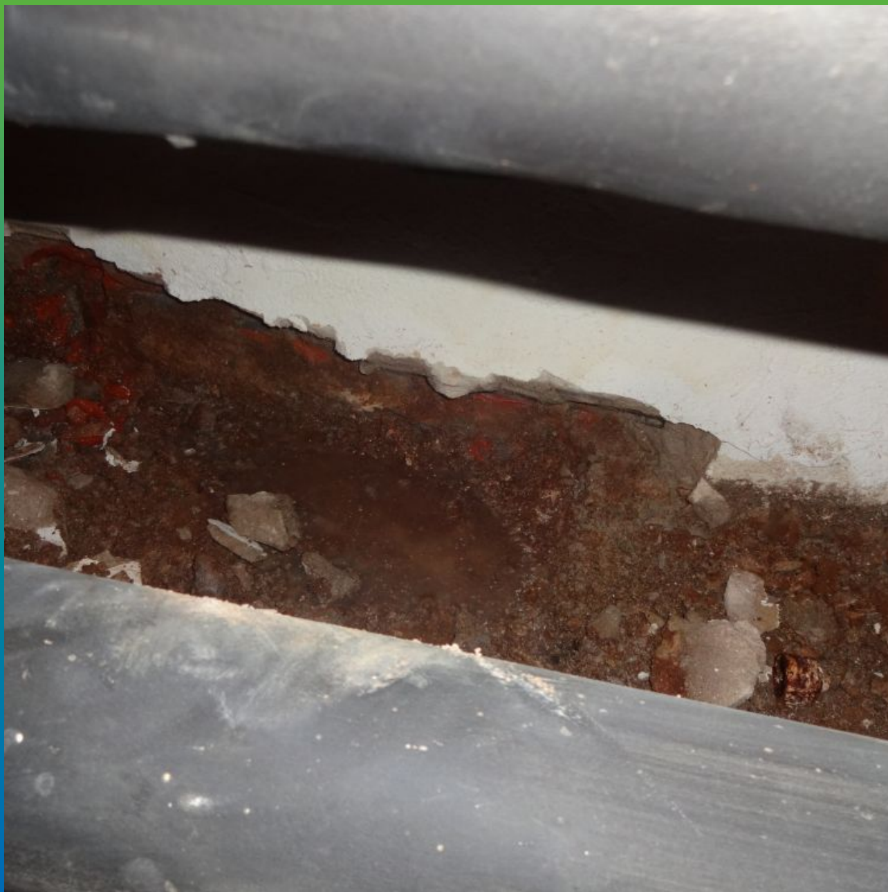
Расшивка примыканий стена - пол
