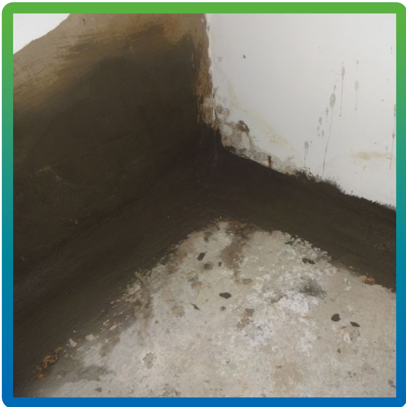
Ремонт швов составом Стармекс РМЗ
