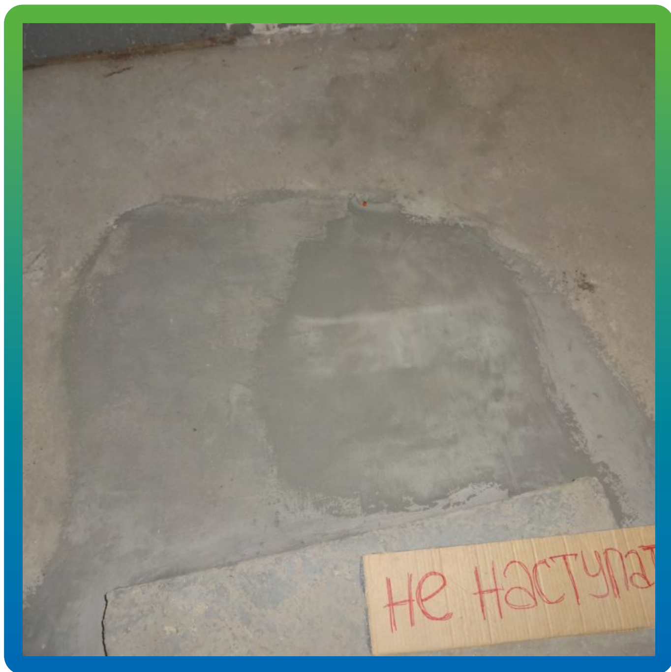
Вид объекта после проведения гидроизоляционных работ
