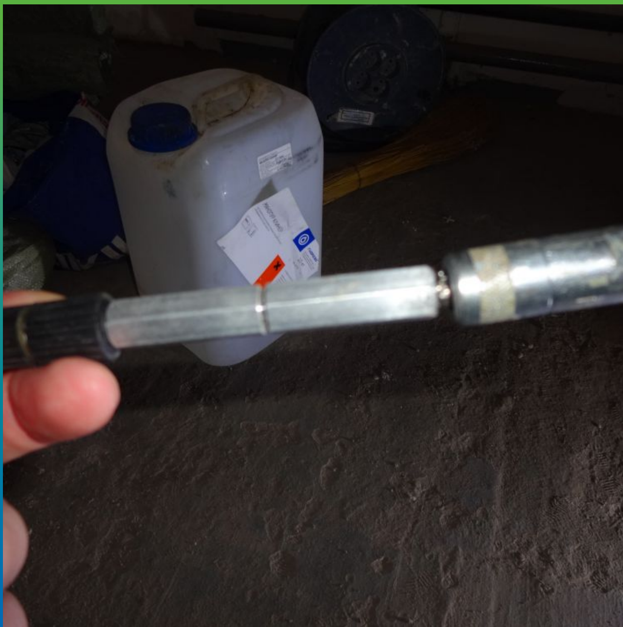
Установка пакеров БМ 1100 в пробуренные шпуры
