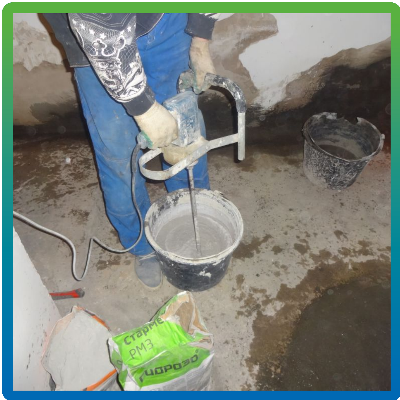
Затворение с водой ремонтного состава Стармекс РМЗ
