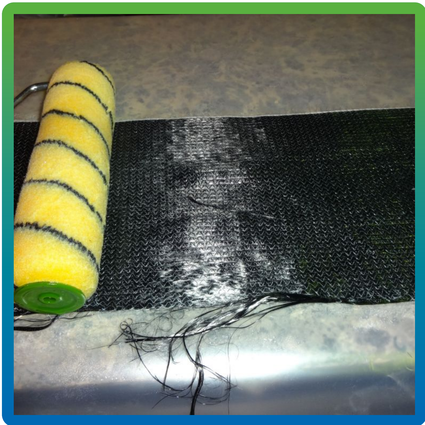
Пропитка углеродного холста эпоксидным составом Манопокс 372
