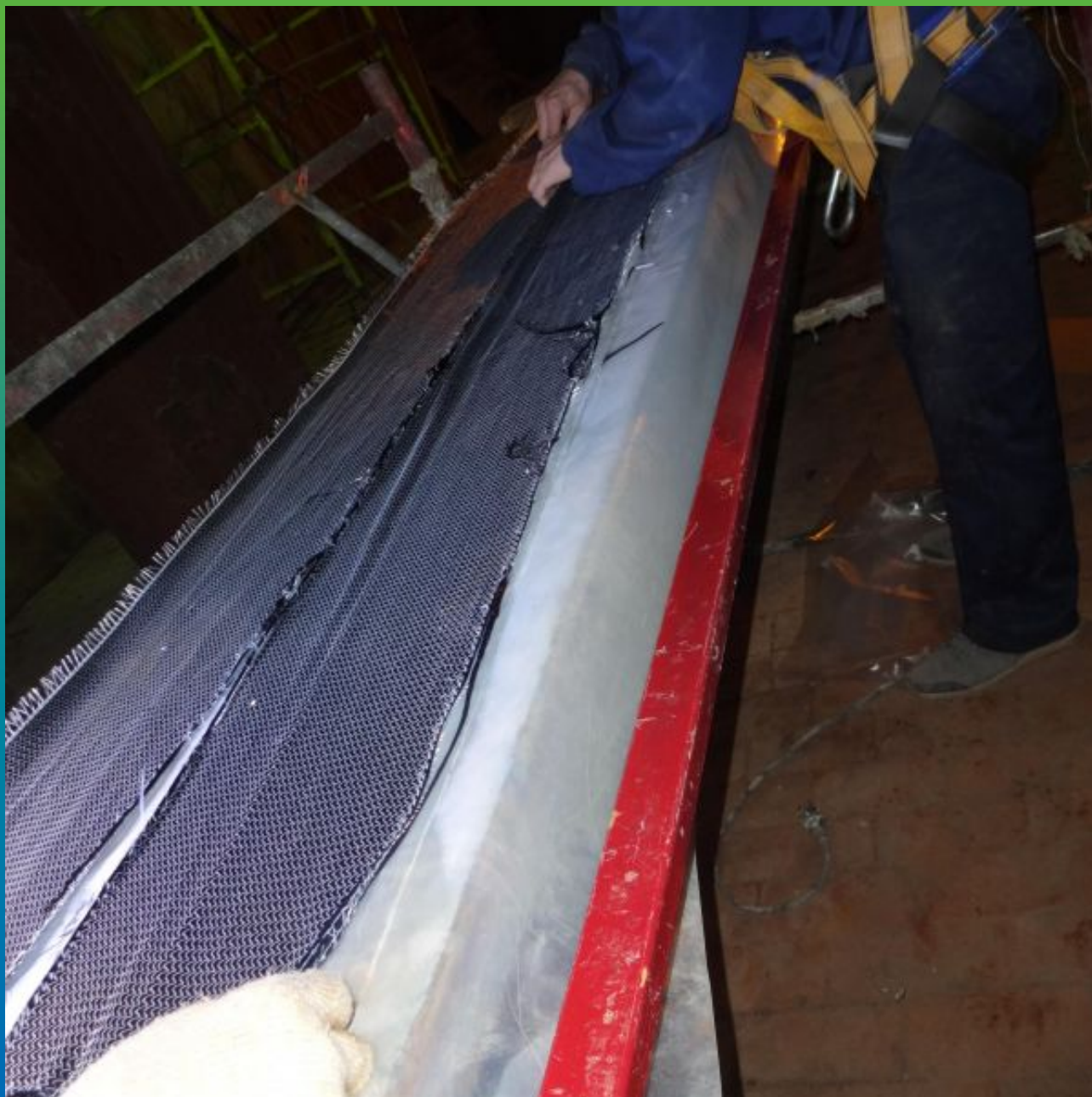
Раскрой по размерам углеродного композиционного материала Армошел 500
