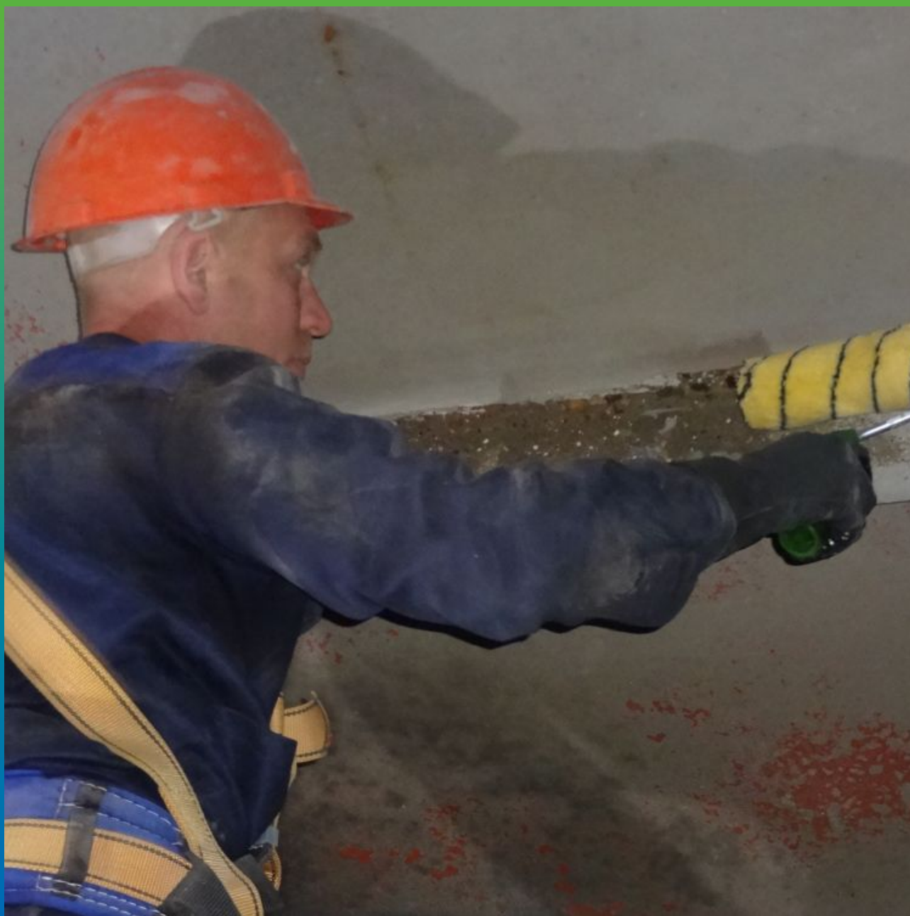
Грунтование поверхности эпоксидным составом Манопокс 372
