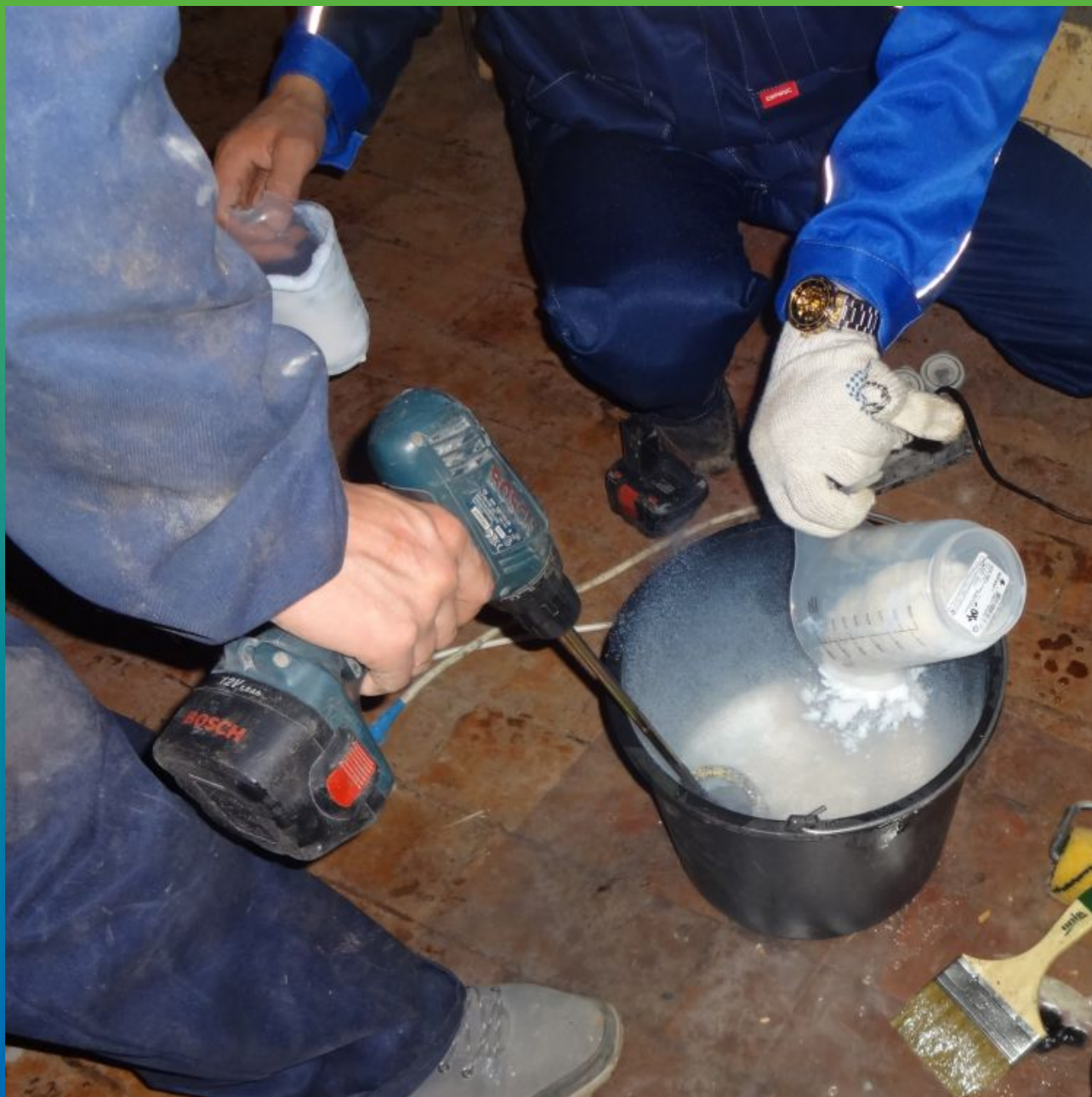
Загущение составом Манопокс Тикс эпоксидного клея Манопокс 372
