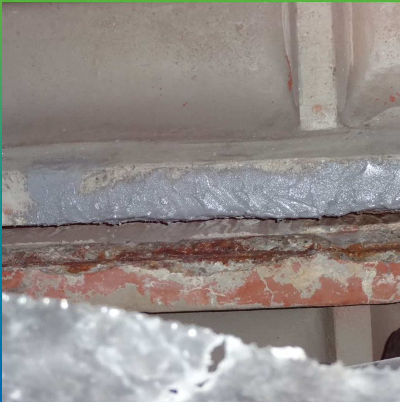
Ремонт дефектов поверхности тиксотропным ремонтным эпоксидным составом Манопокс 331
