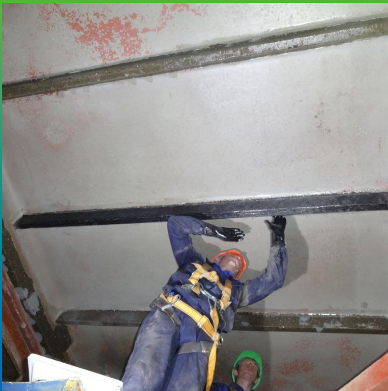
Разглаживание поверхности после монтажа углеродного холста Армошел КВ 500
