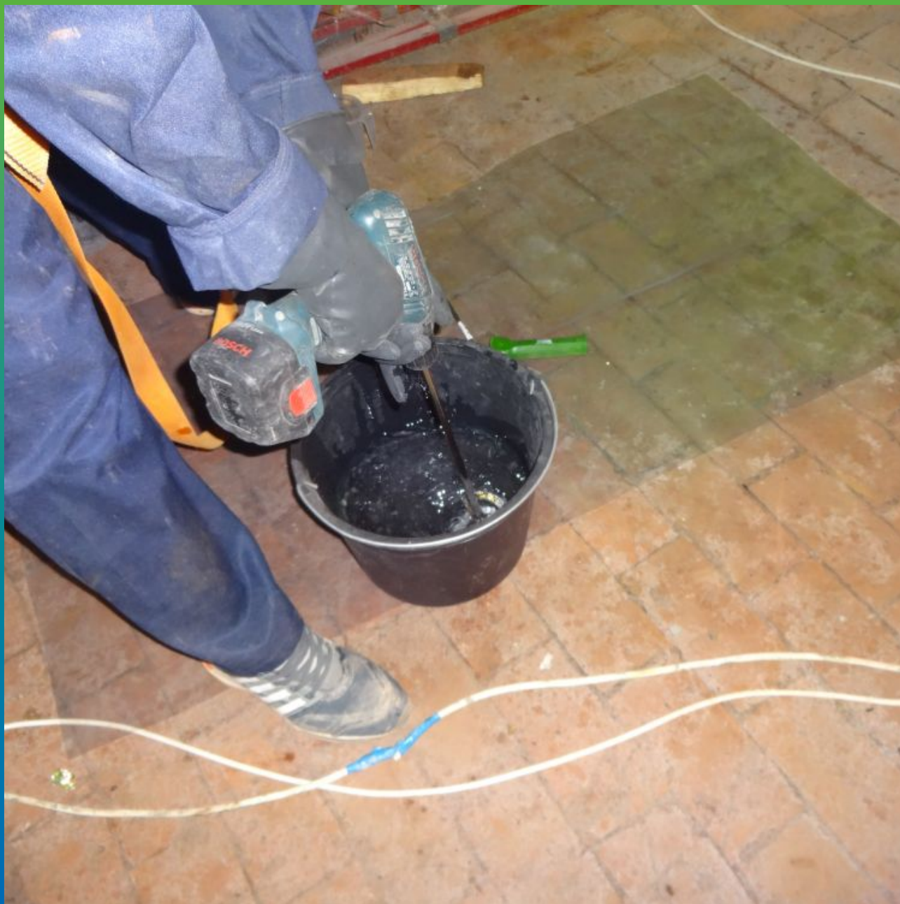
Затворение А+В компонентов эпоксидного состава Манопокс 372
