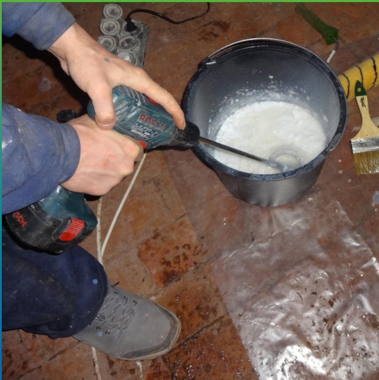
Загущение составом Манопокс Тикс эпоксидного клея Манопокс 372
