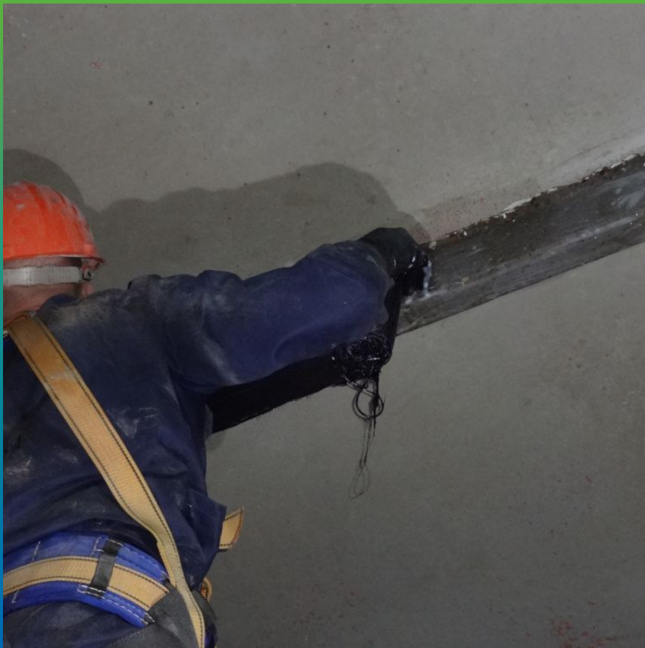
Монтаж углеводного холста Армошел КВ 500 на поверхность
