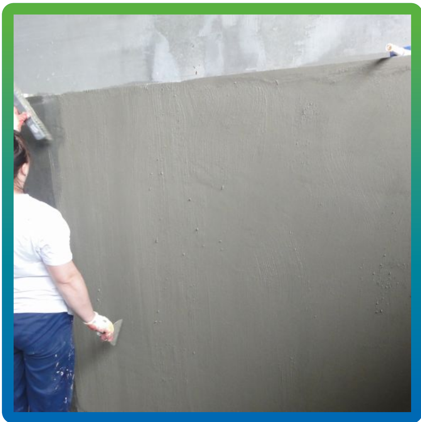
Нанесение состава Максил
