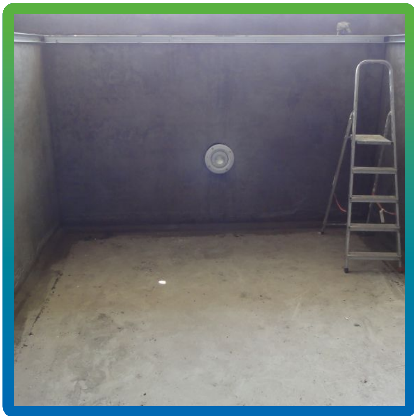
Вид подготовленной поверхности
